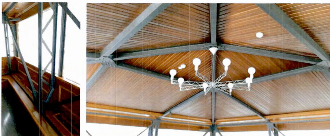
8, 9. Металлический клепаный каркас
