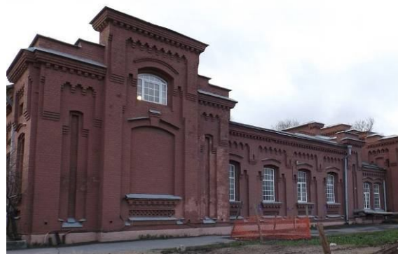
Северный фасад северо-восточного корпуса
