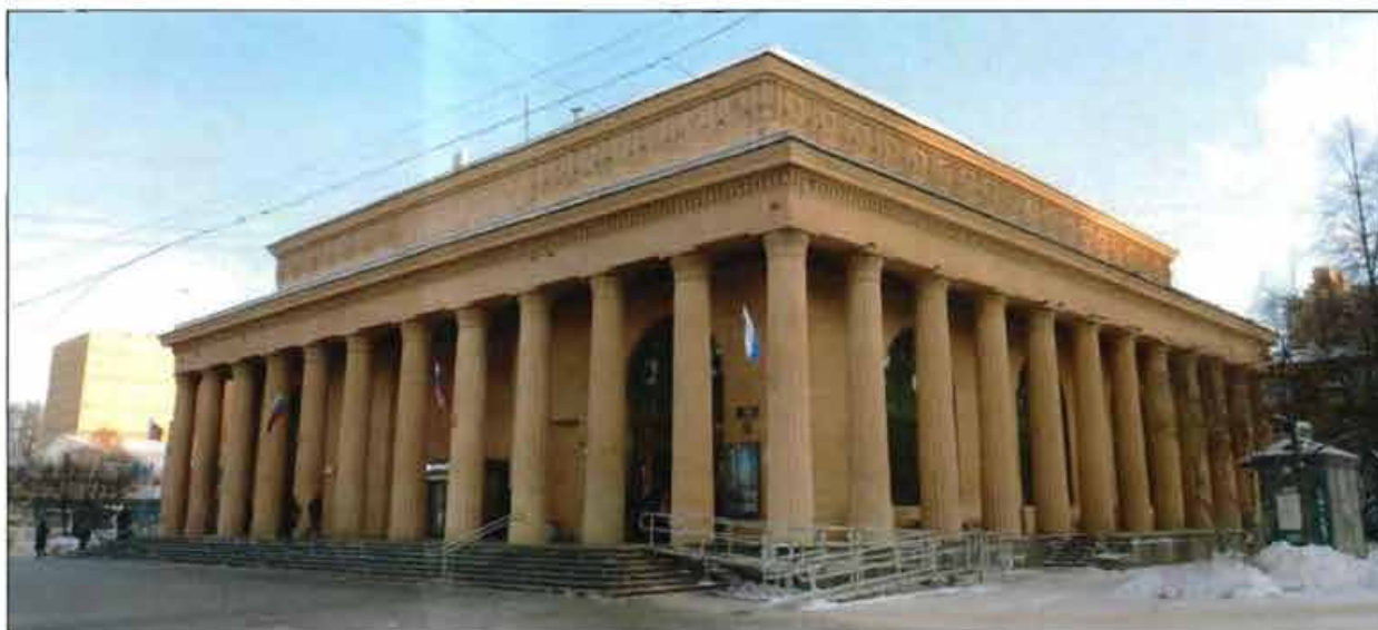
1. Объект культурного наследия. Западный и южный фасады. Вид с юго-запада. Фотофиксация от 10.12.2021.
