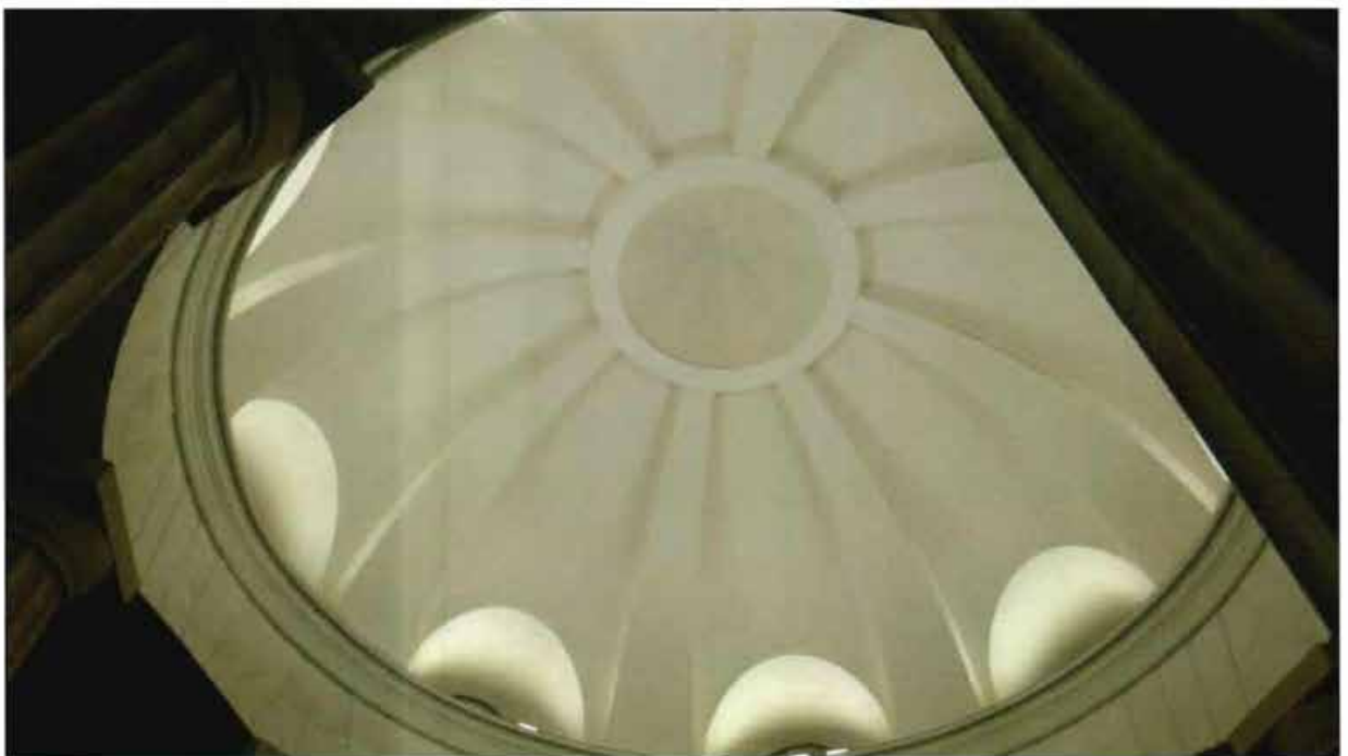
7. Купол над двусветным кассовым залом (пом. 1-Н (2)). Фотофиксация от 23.07.2021.
