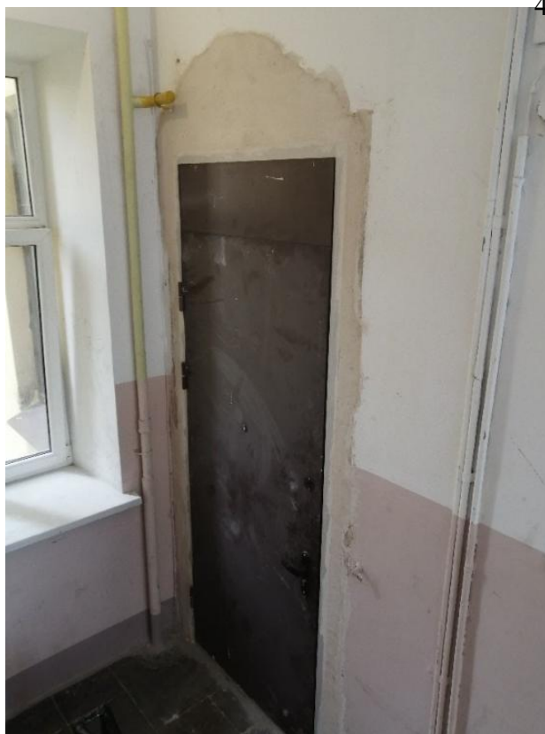
Фото 19. Входное дверное заполнение квартиры №10, вид со стороны лестничной клетки
