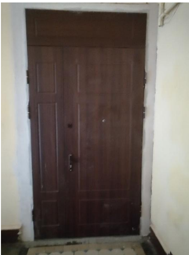
Фото 18. Входное дверное заполнение квартиры №10, вид со стороны лестничной клетки
