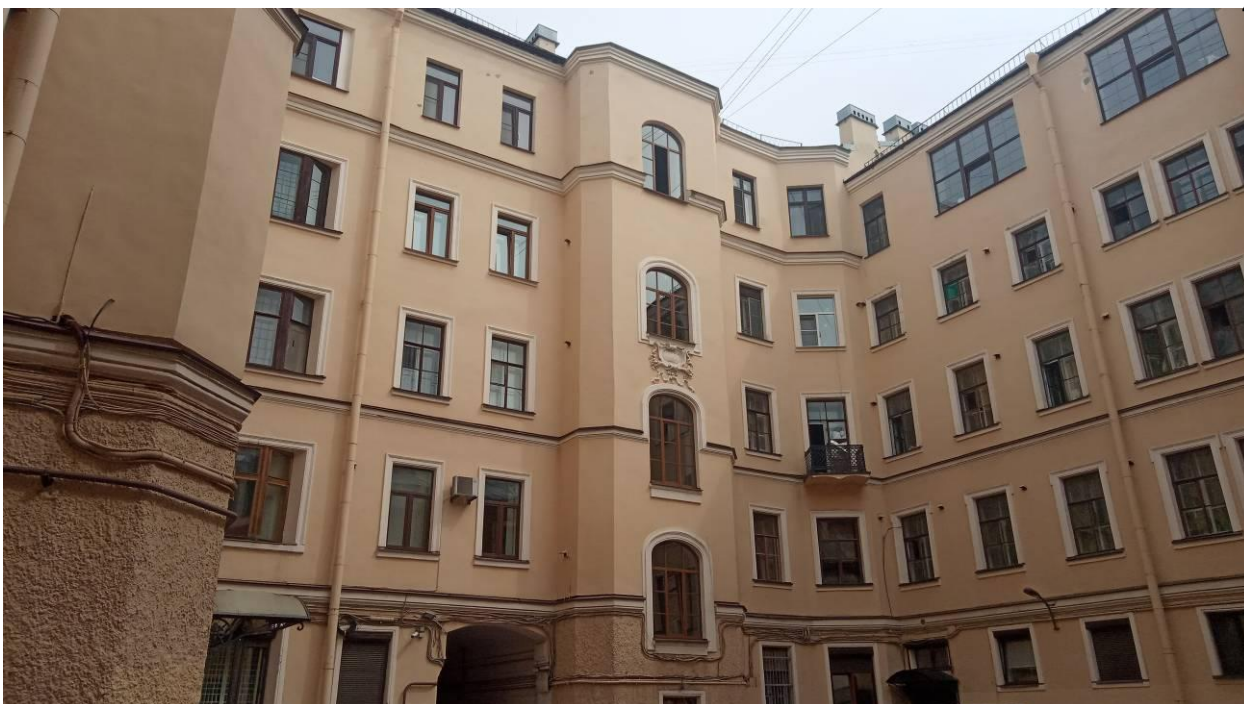
Фото 7. Фрагмент дворового фасада объекта культурного наследия регионального значения «Собственный дом архитектора Л.Н. Бенуа»
