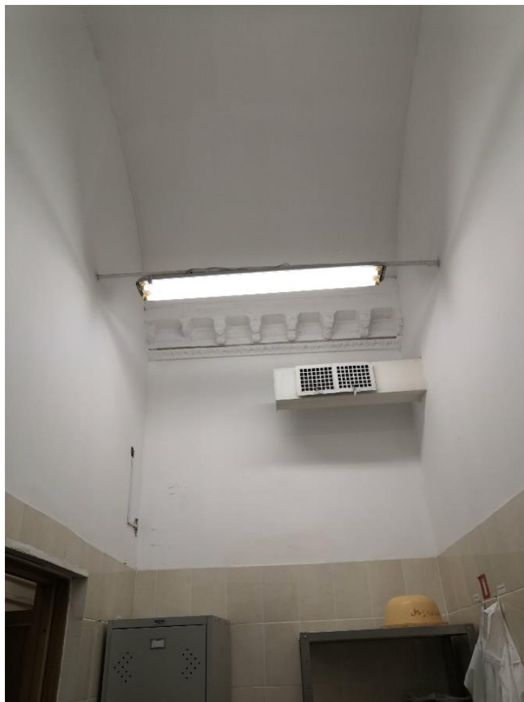
33. Объект культурного наследия федерального значения «Дом Демидова П.Г.», входящий в состав объекта культурного наследия федерального значения «Усадьба Демидовых», по адресу: г. Санкт-Петербург, пер. Гривцова, д. 5, лит. А (Гривцова пер., 1). Помещение 8-Н. В процессе эксплуатации в ряде помещений выполнена перепланировка с устройством перегородок и перебивкой отделки сводов помещений.
