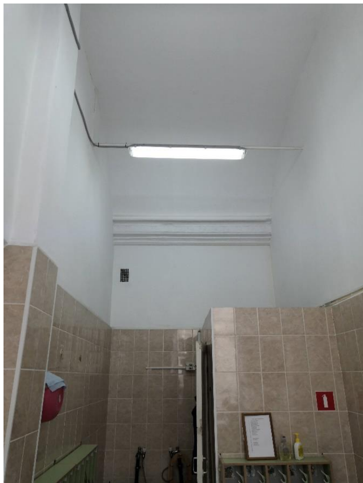
37. Объект культурного наследия федерального значения «Дом Демидова П.Г.», входящий в состав объекта культурного наследия федерального значения «Усадьба Демидовых», по адресу: г. Санкт-Петербург, пер. Гривцова, д. 5, лит. А (Гривцова пер., 1). Помещение 8-Н. В ряде помещений, в процессе эксплуатации выполнена перепланировка с устройством перегородок.
