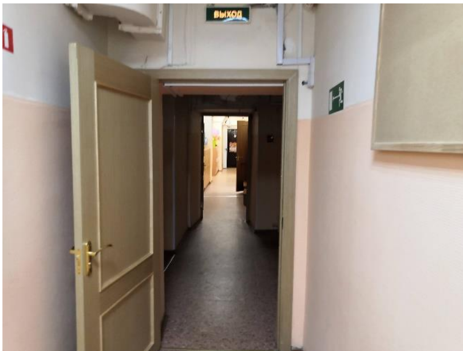
13. Объект культурного наследия федерального значения «Дом Демидова П.Г.», входящий в состав объекта культурного наследия федерального значения «Усадьба Демидовых», по адресу: г. Санкт-Петербург, пер. Гривцова, д. 5, лит. А (Гривцова пер., 1). Помещение 8-Н. Общий вид коридора.
