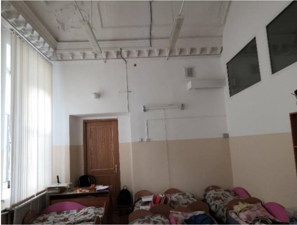
22. Объект культурного наследия федерального значения «Дом Демидова П.Г.», входящий в состав объекта культурного наследия федерального значения «Усадьба Демидовых», по адресу: г. Санкт-Петербург, пер. Гривцова, д. 5, лит. А (Гривцова пер., 1). Помещение 8-Н (помещение №16, общий вид). В ряде помещений отделка сводов включает штукатурный и лепной декор.
