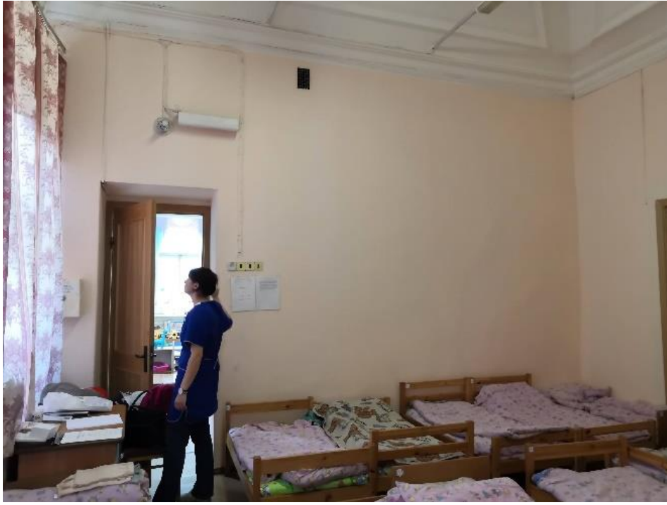
16. Объект культурного наследия федерального значения «Дом Демидова П.Г.», входящий в состав объекта культурного наследия федерального значения «Усадьба Демидовых», по адресу: г. Санкт-Петербург, пер. Гривцова, д. 5, лит. А (Гривцова пер., 1). Помещение 8-Н (помещение № 9, общий вид).
