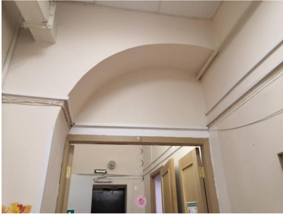
34. Объект культурного наследия федерального значения «Дом Демидова П.Г.», входящий в состав объекта культурного наследия федерального значения «Усадьба Демидовых», по адресу: г. Санкт-Петербург, пер. Гривцова, д. 5, лит. А (Гривцова пер., 1). Помещение 8-Н. В процессе эксплуатации в ряде помещений выполнена перепланировка с устройством перегородок и перебивкой отделки сводов помещений.
