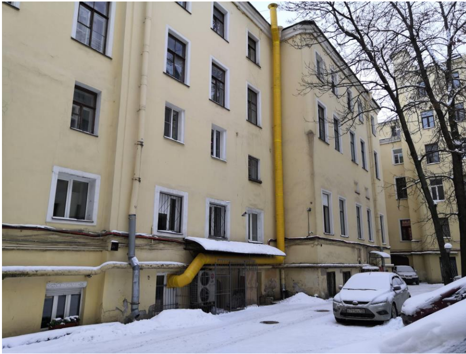
5. Объект культурного наследия федерального значения «Дом Демидова П.Г.», входящий в состав объекта культурного наследия федерального значения «Усадьба Демидовых», по адресу: г. Санкт-Петербург, пер. Гривцова, д. 5, лит. А (Гривцова пер., 1). Дворовый фасад.
