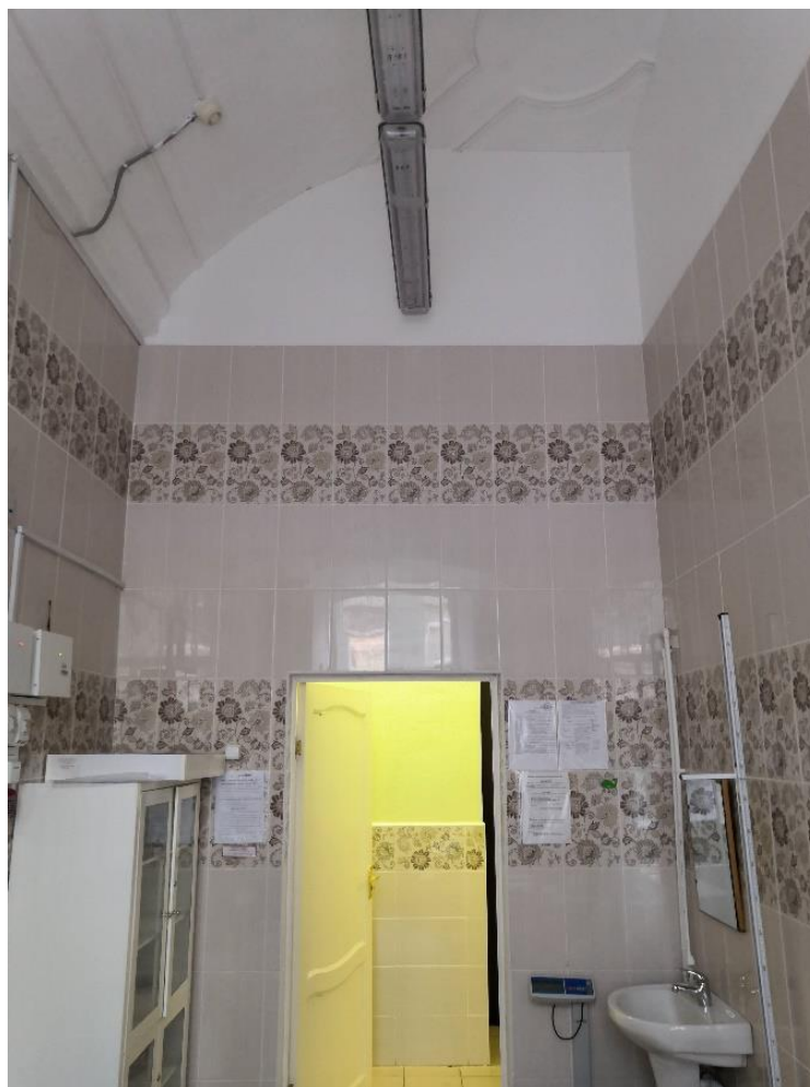
32. Объект культурного наследия федерального значения «Дом Демидова П.Г.», входящий в состав объекта культурного наследия федерального значения «Усадьба Демидовых», по адресу: г. Санкт-Петербург, пер. Гривцова, д. 5, лит. А (Гривцова пер., 1). Помещение 8-Н. В процессе эксплуатации в ряде помещений выполнена перепланировка с устройством перегородок и перебивкой отделки сводов помещений.
