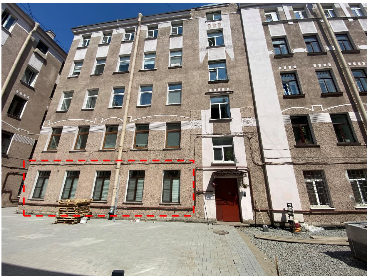
Фото 4. Фрагмент северо-восточного дворового фасада. Оконные проемы в границах квартиры № 31.
