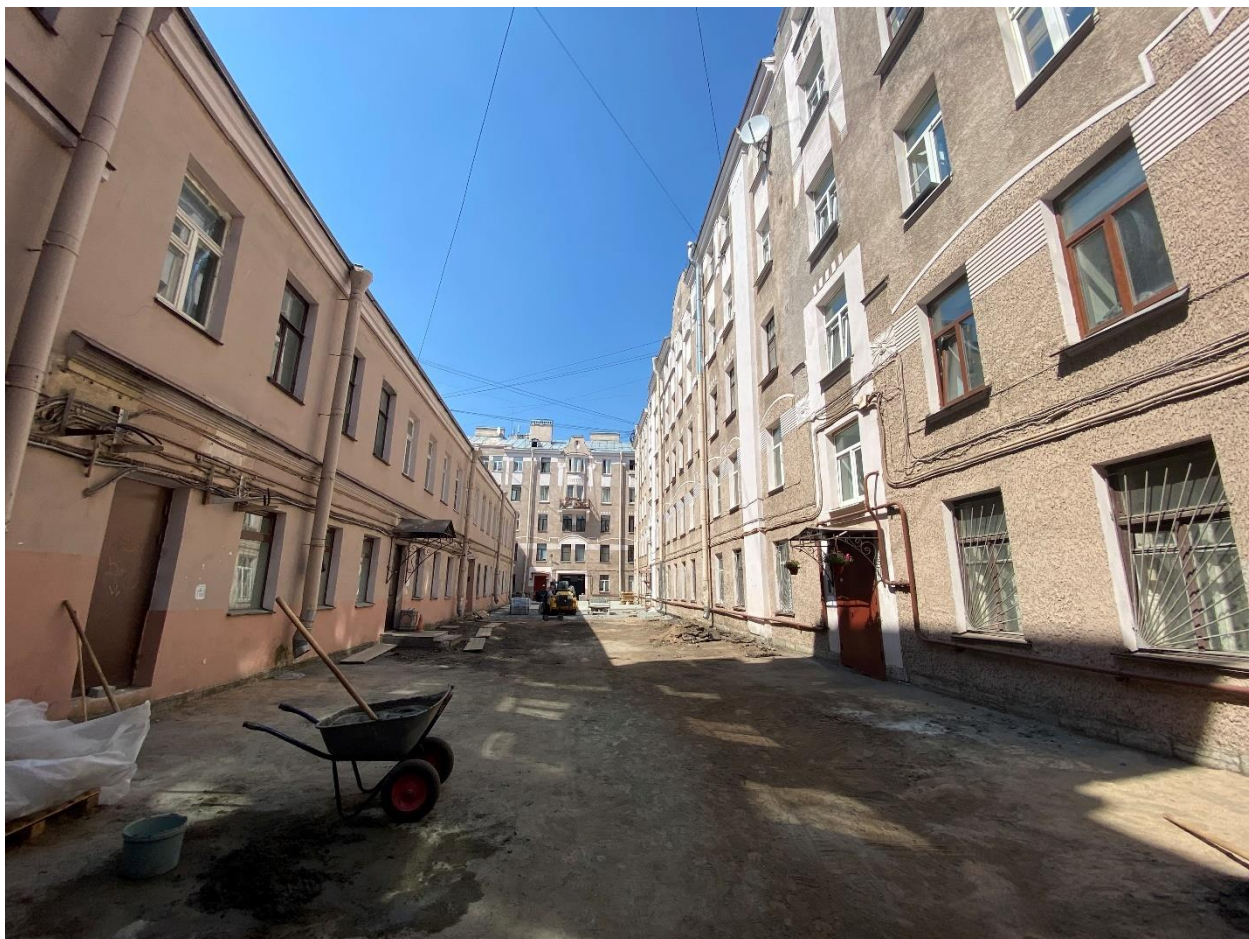
Фото 3. Северо-западный и северо-восточный дворовые фасады.
