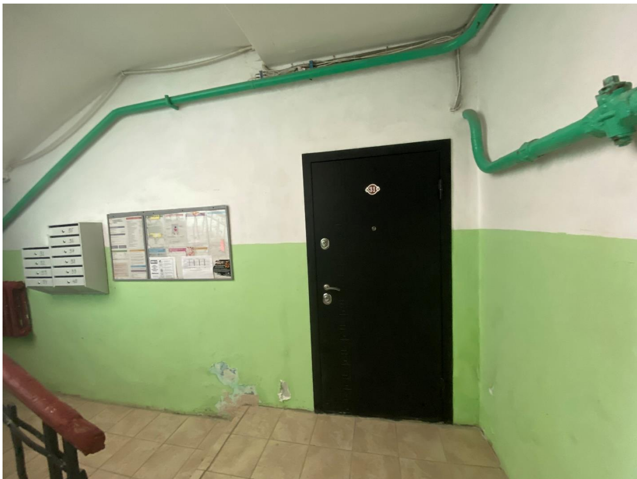
Фото 5. Вход в квартиру № 31 с общедомовой лестничной клетки.
