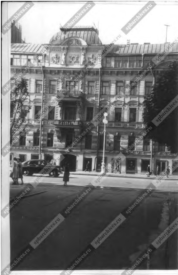
Илл. 47. Вид на дом №63 по Невскому проспекту со стороны улицы Маяковского. 1950 г. ЦГАКФФД СПб Ар 169610
