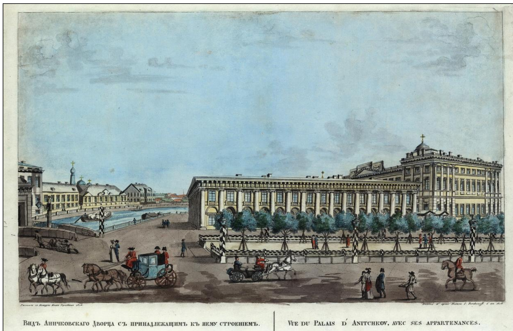
Илл. 23. Вид Аничковскаго дворца съ принадлежащимъ к нему строениемъ. Середина XIX в. Альбом «Виды С.-Петербурга и пригородов». Изд. И. Фельтена в Санкт-Петербурге.
