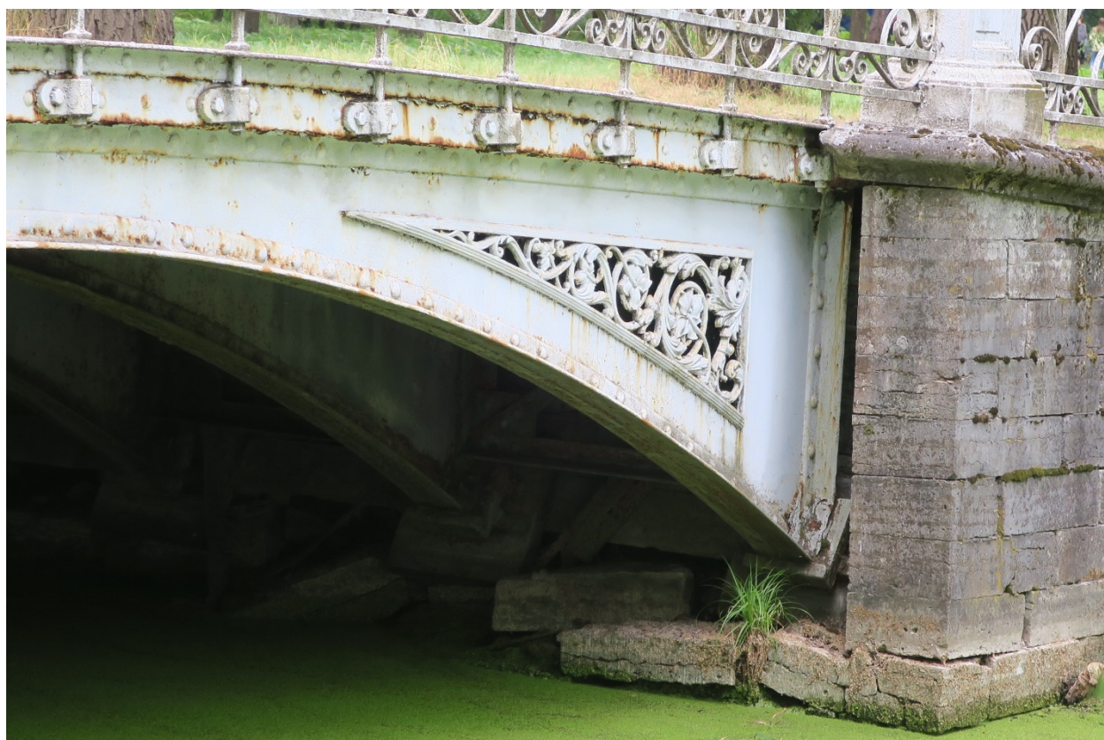
4. Низовой фасад объекта культурного наследия федерального значения «Мост Металлический», расположенного по адресу: Санкт-Петербург, г. Пушкин, Александровский парк, литера БА. Фрагмент. 01.07.2021
