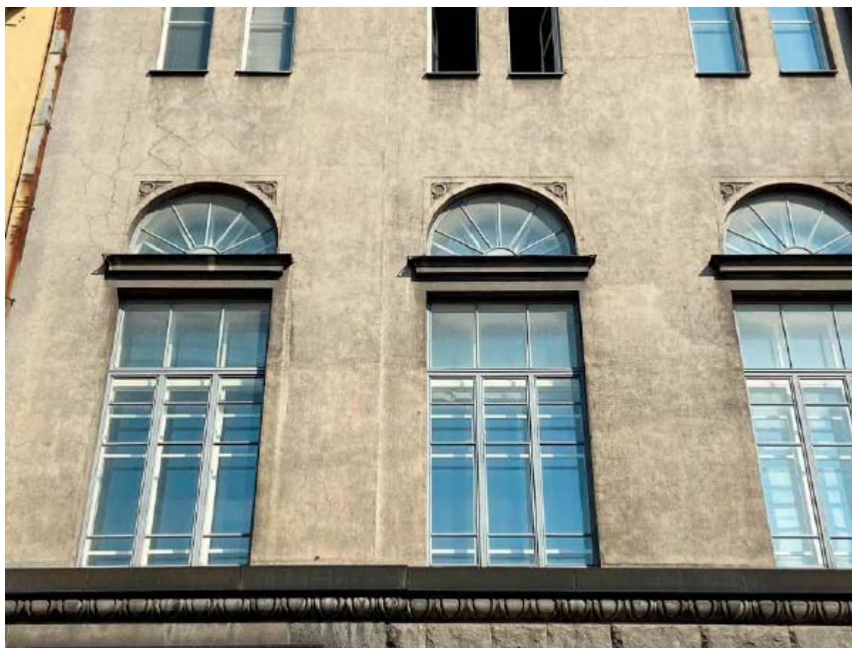
3. Юго-восточный лицевой фасад по улице Почтамтской объекта культурного наследия регионального значения «Здание Управления городского телефона и телеграфа», расположенного по адресу: г. Санкт-Петербург, Почтамтская ул., 15, литера Б. Фрагмент. 15.08.2021.
