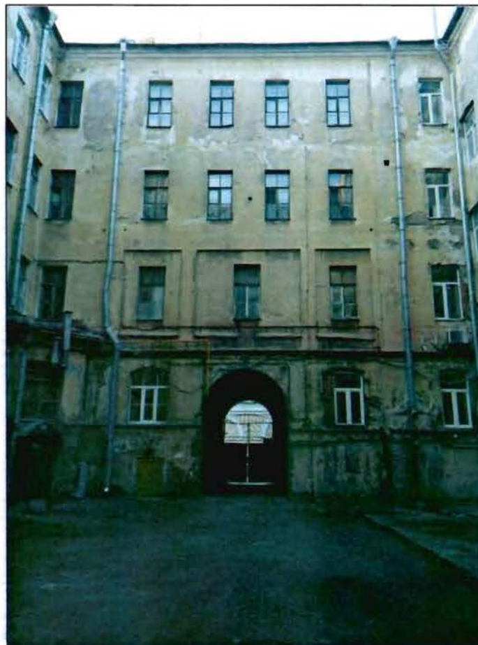
6. Северный дворовый фасад корпуса по ул. Якубовича.
