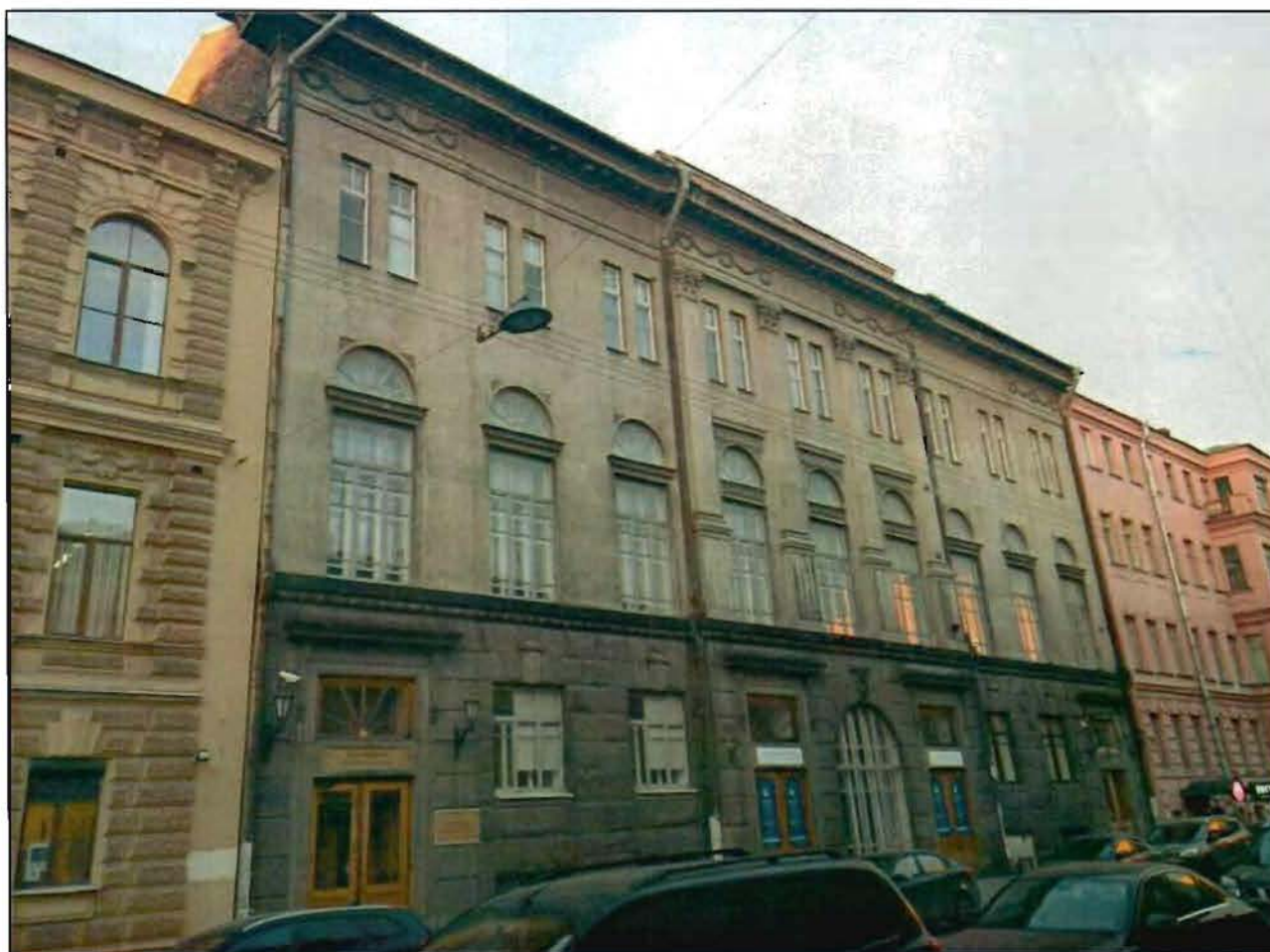
1. Общий вид с юга (лицевой фасад по ул. Почтамтской).
