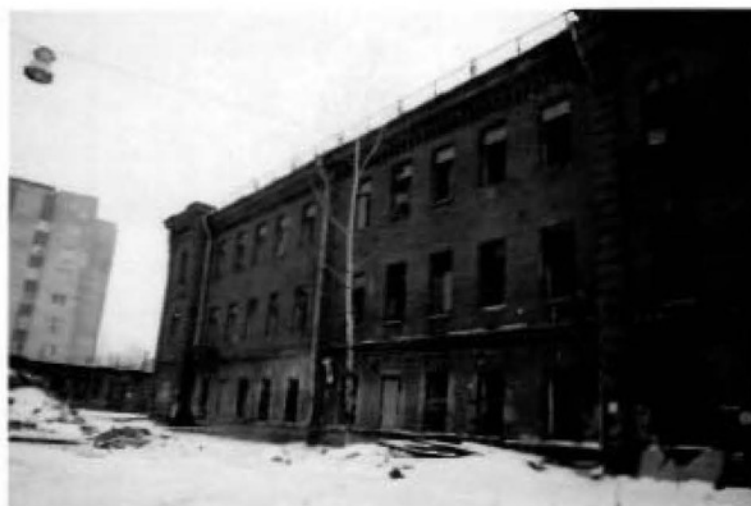
4. (Фрагмент восточного фасада)
