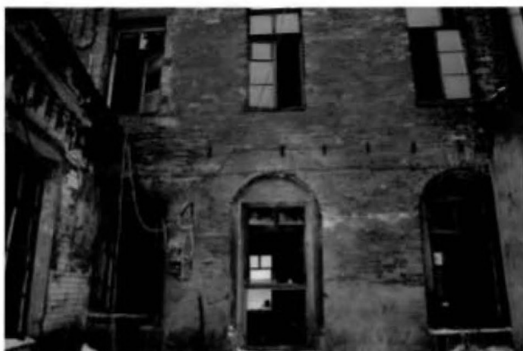
4. (Фрагмент южного фасада)
