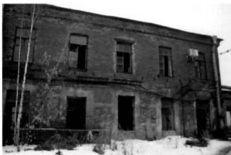
3. (Фрагмент южного фасада)
