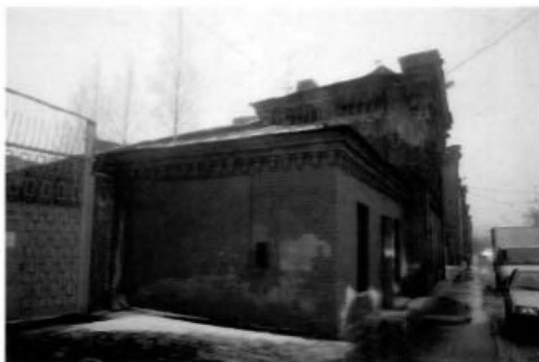
2. (Фрагмент северного фасада)
