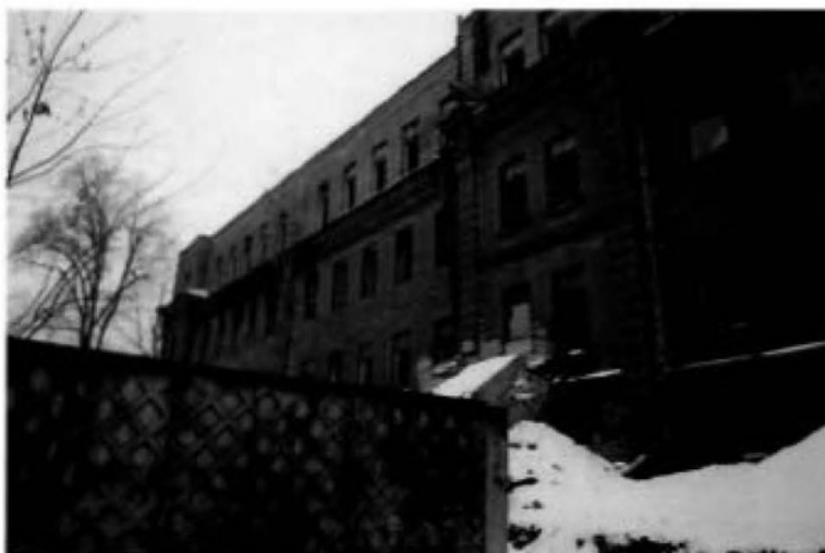
4. (Фрагмент восточного фасада)
