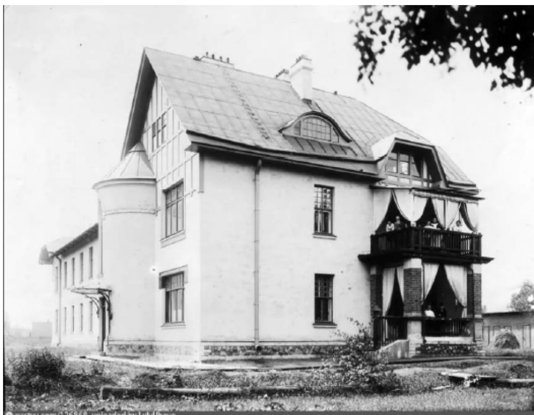
Жилой дом Главного гидрографического управления, 1914 г. Построен по проекту гр. инженера Николая Иустиновича Малеина (1881-?) в 1913-14 гг. Источник Retro View of Mankind's Habitat. [Электронный ресурс]. Режим доступа: https://www.pastvu.com
