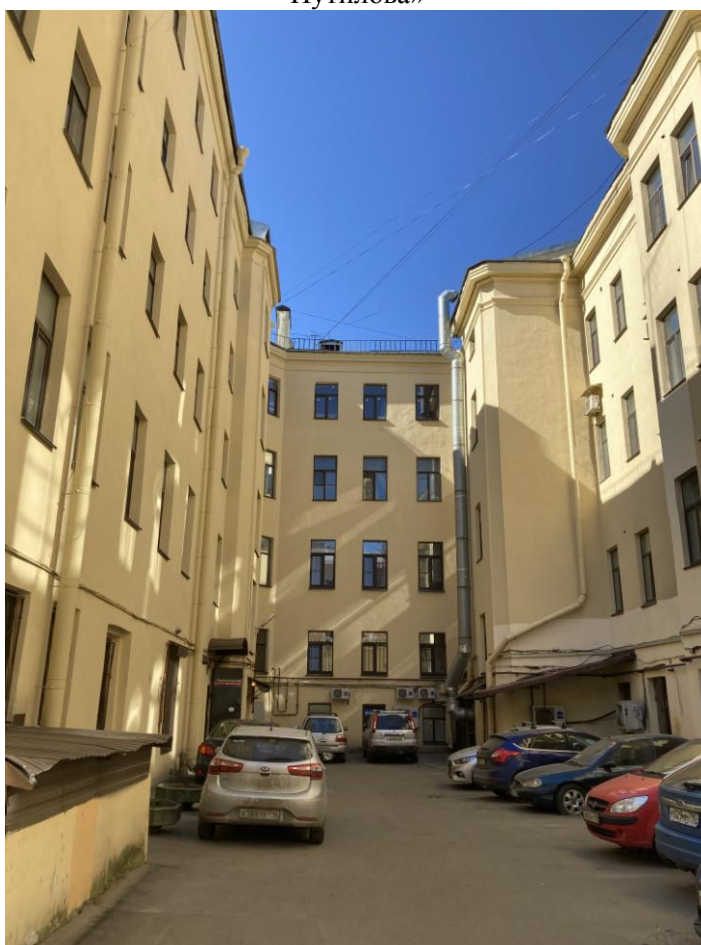
Фото 6. Фрагмент дворового фасада выявленного объекта культурного наследия «Дом К.И. Путилова»
