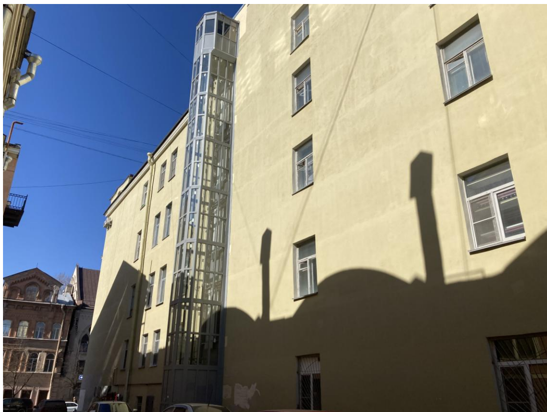
Фото 5. Фрагмент дворового фасада выявленного объекта культурного наследия «Дом К.И. Путилова»
