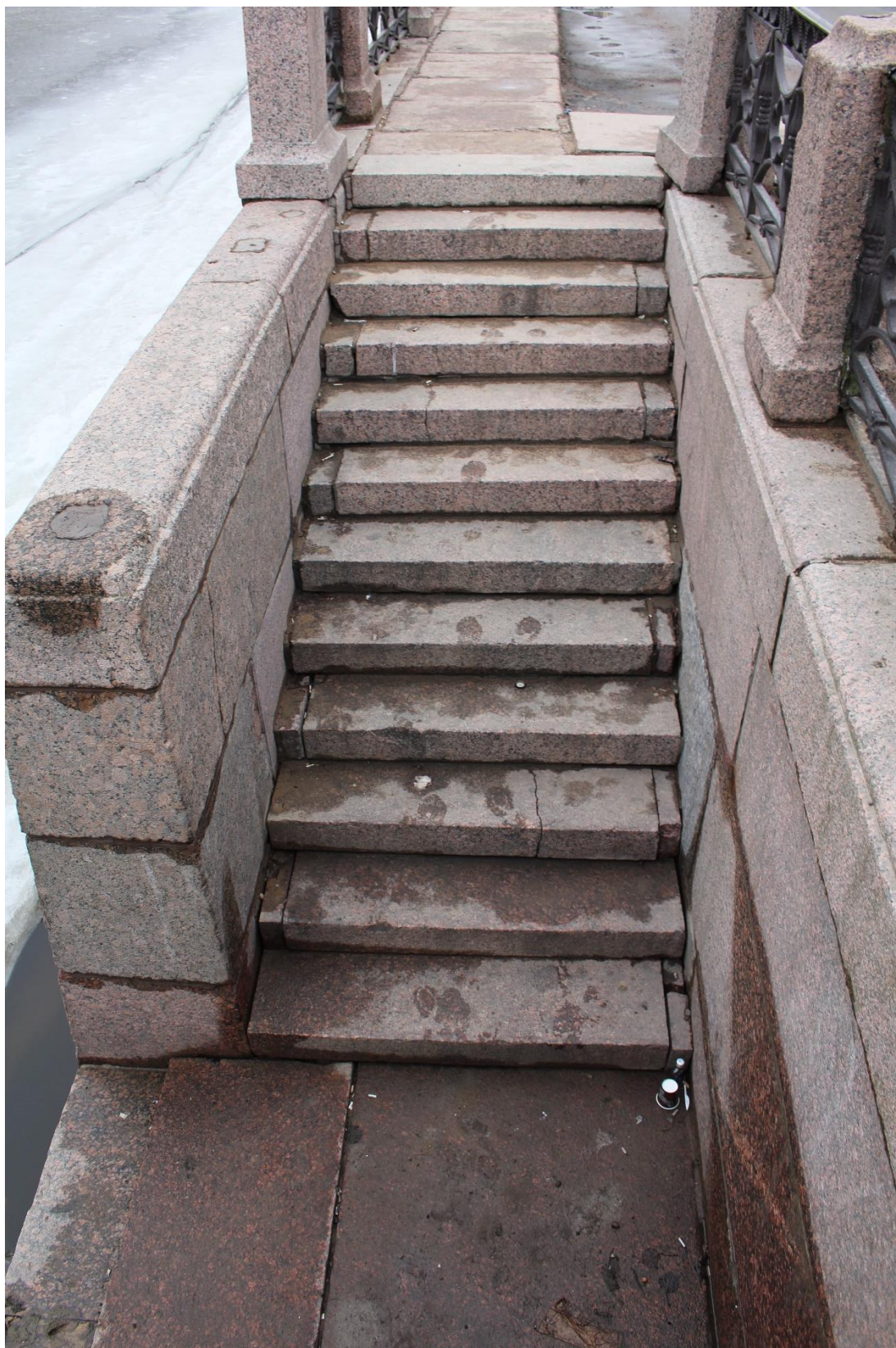
Фото 4. Вид на лестничный марш и нижнюю площадку спуска № 11 объекта культурного наследия федерального значения «Набережные со спусками» на участке набережной реки Мойки «Зеленый мост - Красный мост» литера Б.
