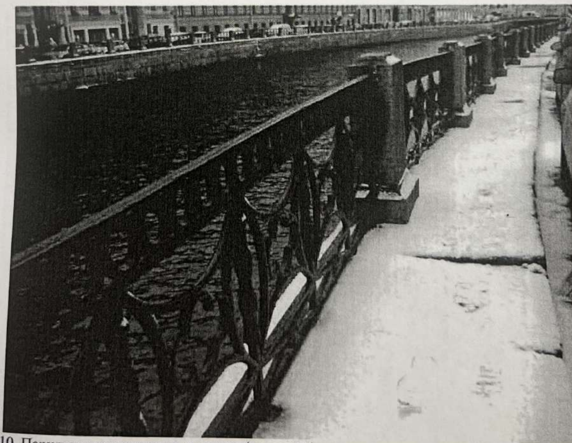
10. Перильное ограждение, тротуар (правый берег, на участке между Певческим и Полицейским (Зелёным, Народным) мостами)
