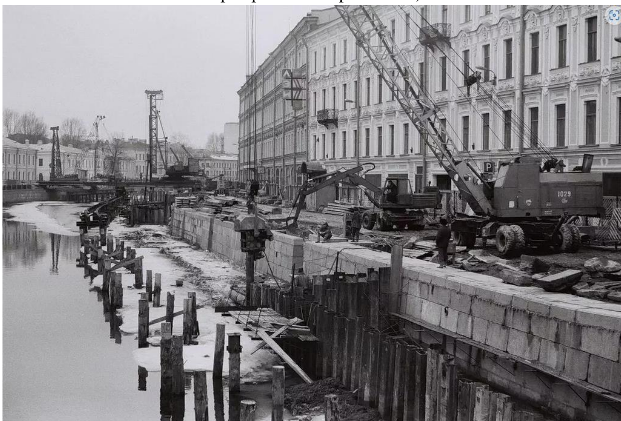
Илл. 18. Ремонт набережной реки Мойки. 1988 г. (источник: https://pastvu.com/p/129828 ).
