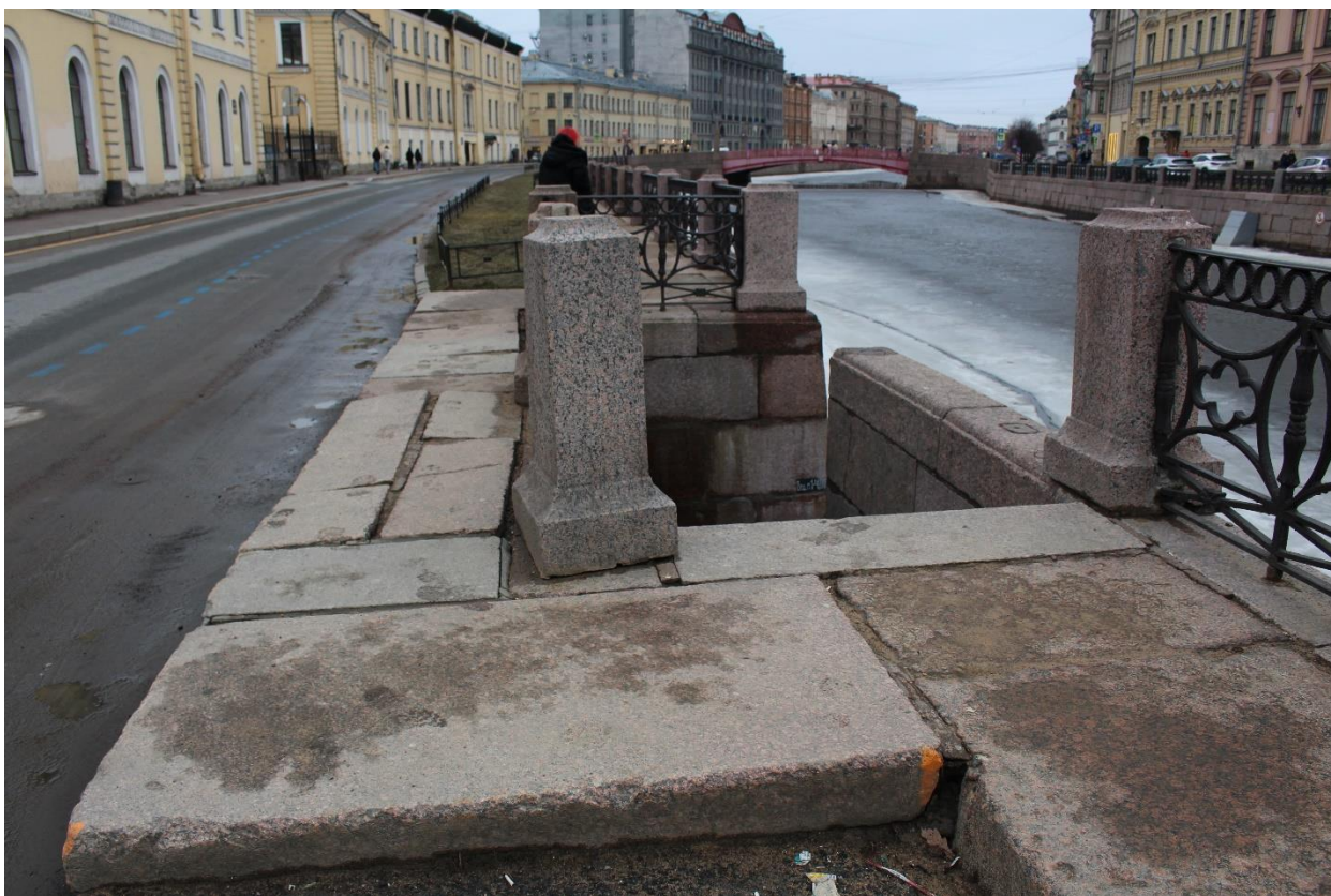
Фото 5. Вид на тротуар из гранитных плит и ограждение спуска № 11 объекта культурного наследия федерального значения «Набережные со спусками» на участке набережной реки Мойки «Зеленый мост - Красный мост» литера Б.
