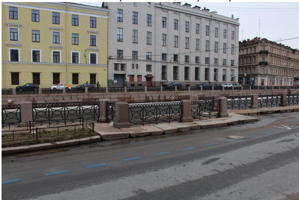
Фото 2. Вид на спуск № 11 объекта культурного наследия федерального значения «Набережные со спусками» на участке набережной реки Мойки «Зеленый мост - Красный мост», литера Б с юга.
