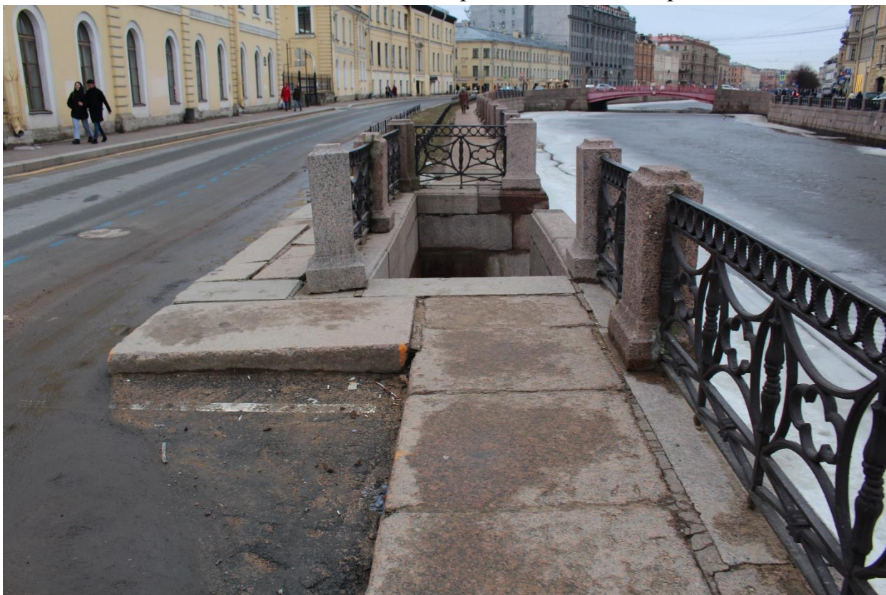
Фото 8. Вид на спуск № 11 объекта культурного наследия федерального значения «Набережные со спусками» на участке набережной реки Мойки «Зеленый мост - Красный мост», литера Б с северо-востока.
