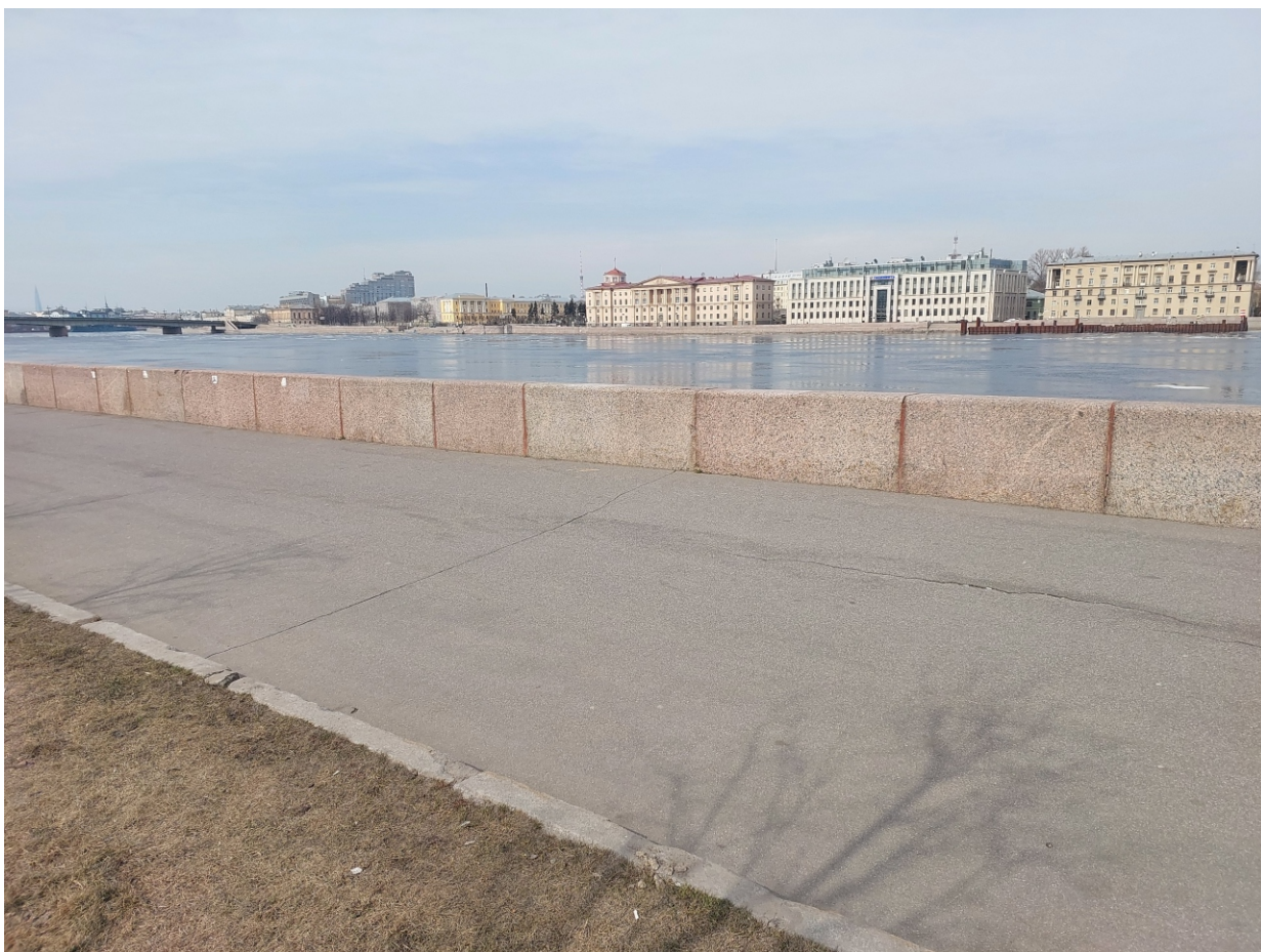
Точка фотофиксации 5. Общий вид на участок работ с ЮВ.
