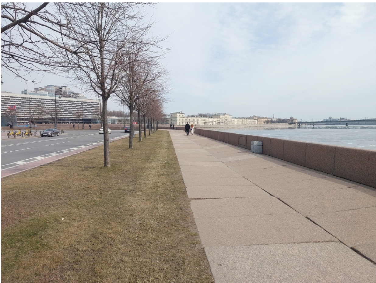
Точка фотофиксации 11. Общий вид территории участка проведения работ с ЮЗ.
