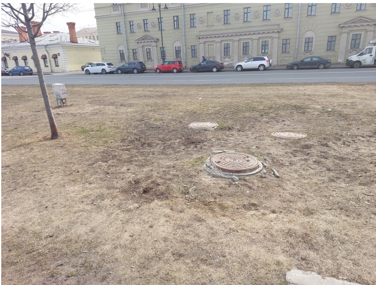
Точка фотофиксации 2. Общий вид на участок работ с С3. Существующие подземные коммуникации.
