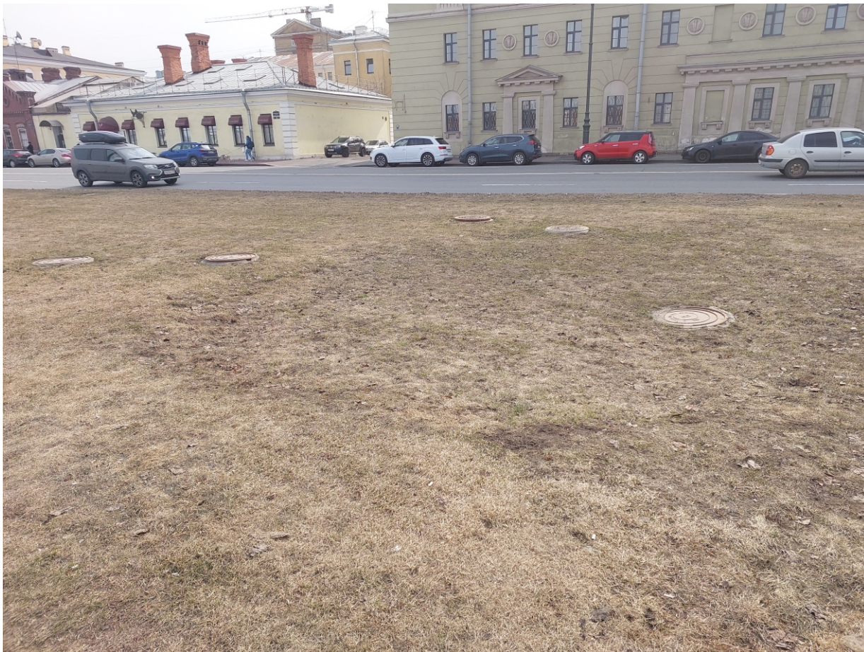
Точка фотофиксации 3. Общий вид на участок работ с СЗ. Существующие подземные коммуникации.
