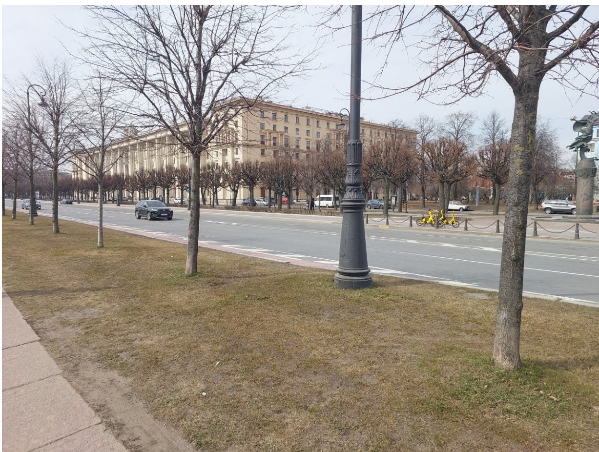
Точка фотофиксации 10. Общий вид окружающей территории участка проведения работ с В.
