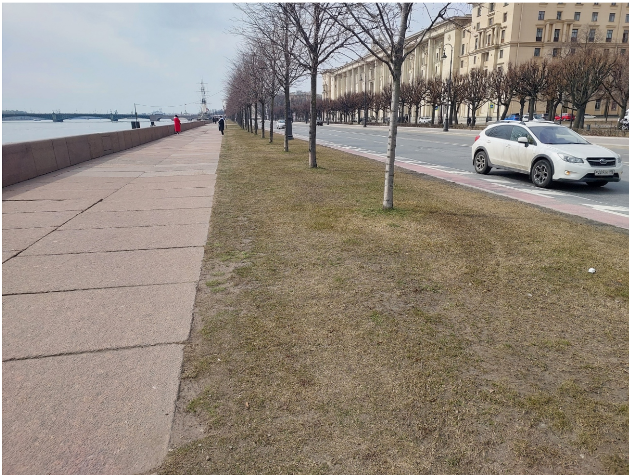
Точка фотофиксации 9. Общий вид на участок проведения работ с СВ.
