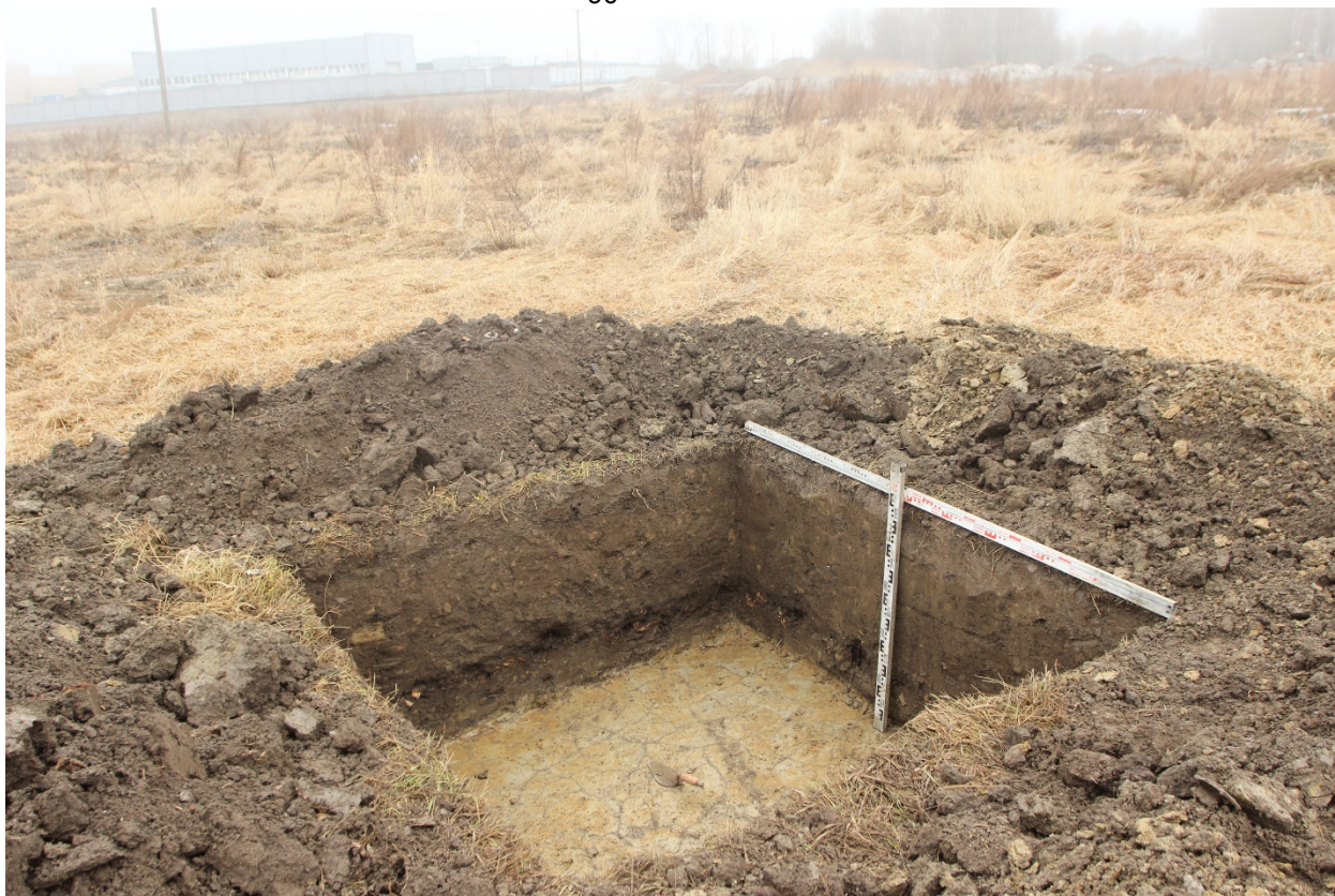
Рис. 32. Шушары, КН:78:42:1850206:7744-2023. Шурф 1, фиксация по уровню материковой поверхности, вид на северо-запад.
