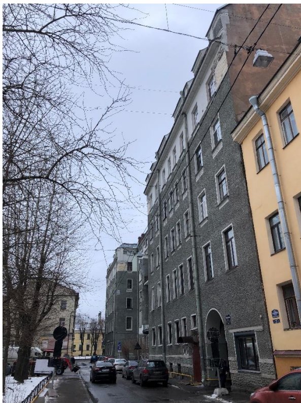
Фото 4. Вид на фасад исследуемого дома по Большому Казачьему пер.
