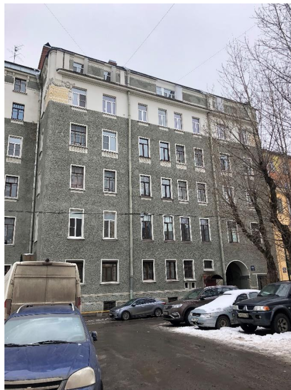
Фото 5. Вид на фрагмент фасада исследуемого дома по Большому Казачьему пер.
