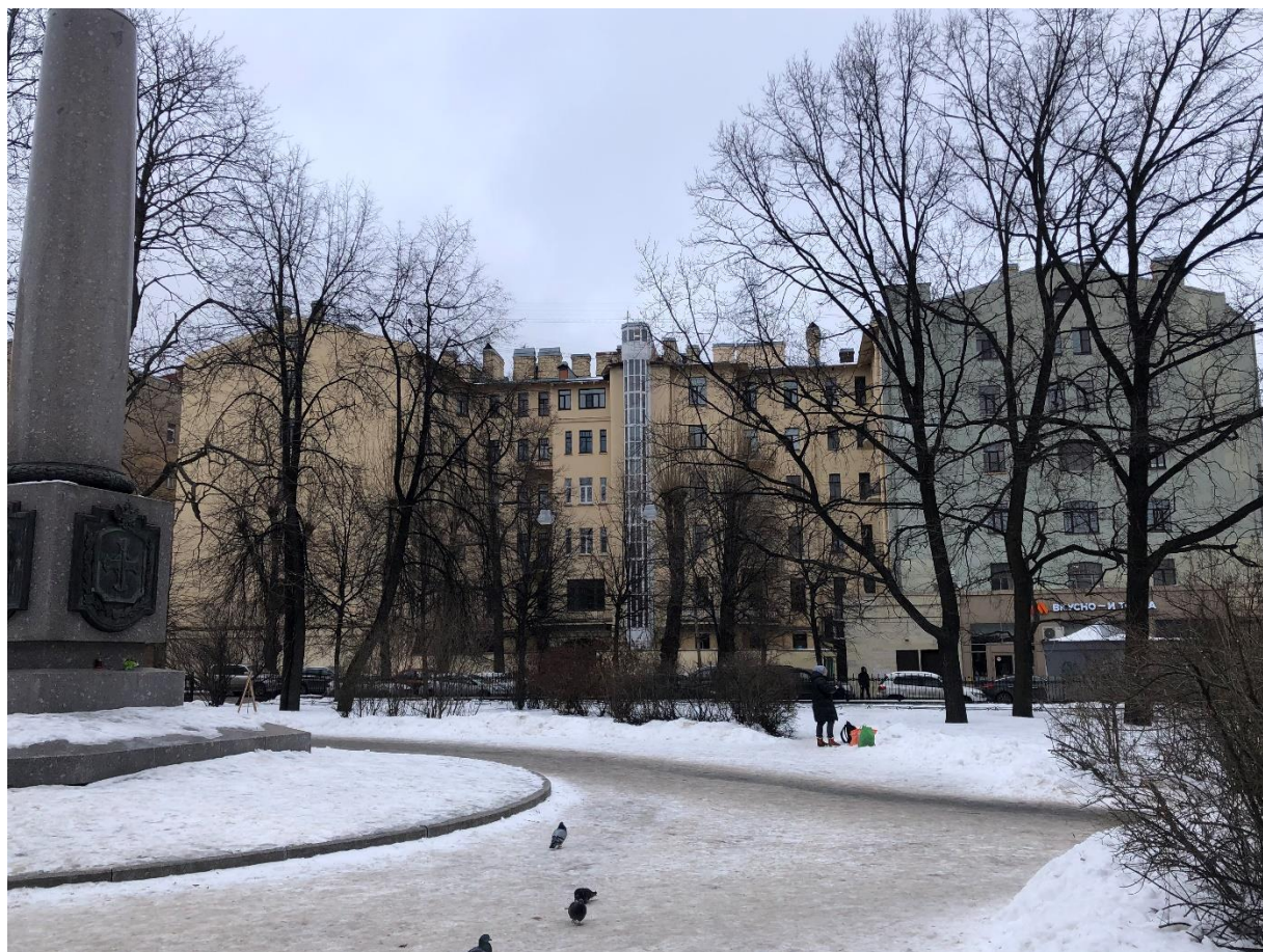
Фото 8. Вид на дворовый фасад дома № 45 по Загородному пр.
