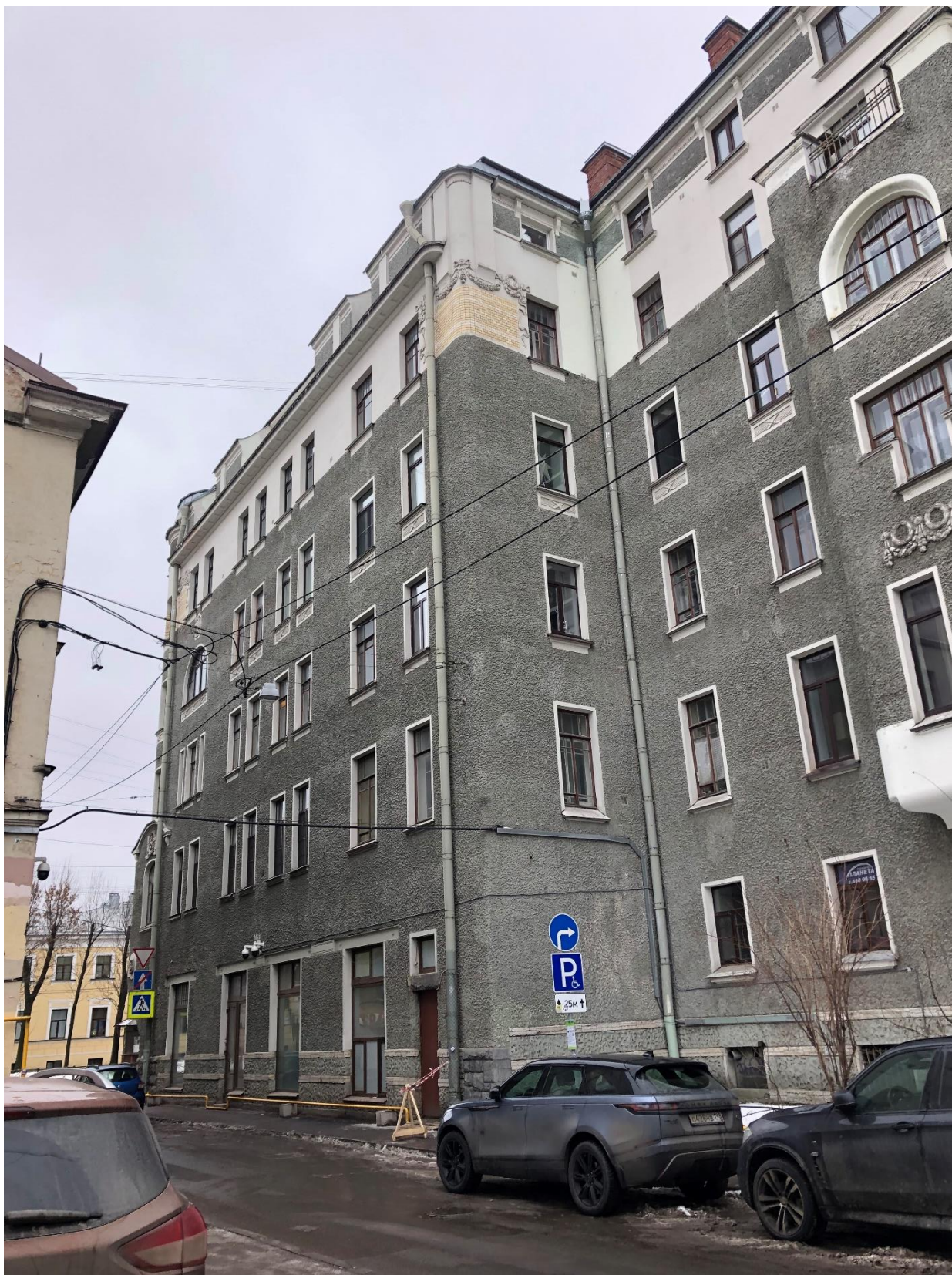
Фото 7. Вид на фрагмент фасада исследуемого дома по Большому Казачьему пер.
