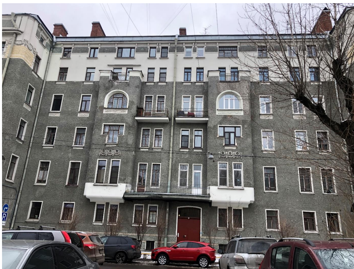
Фото 6. Вид на фрагмент фасада исследуемого дома по Большому Казачьему пер.
