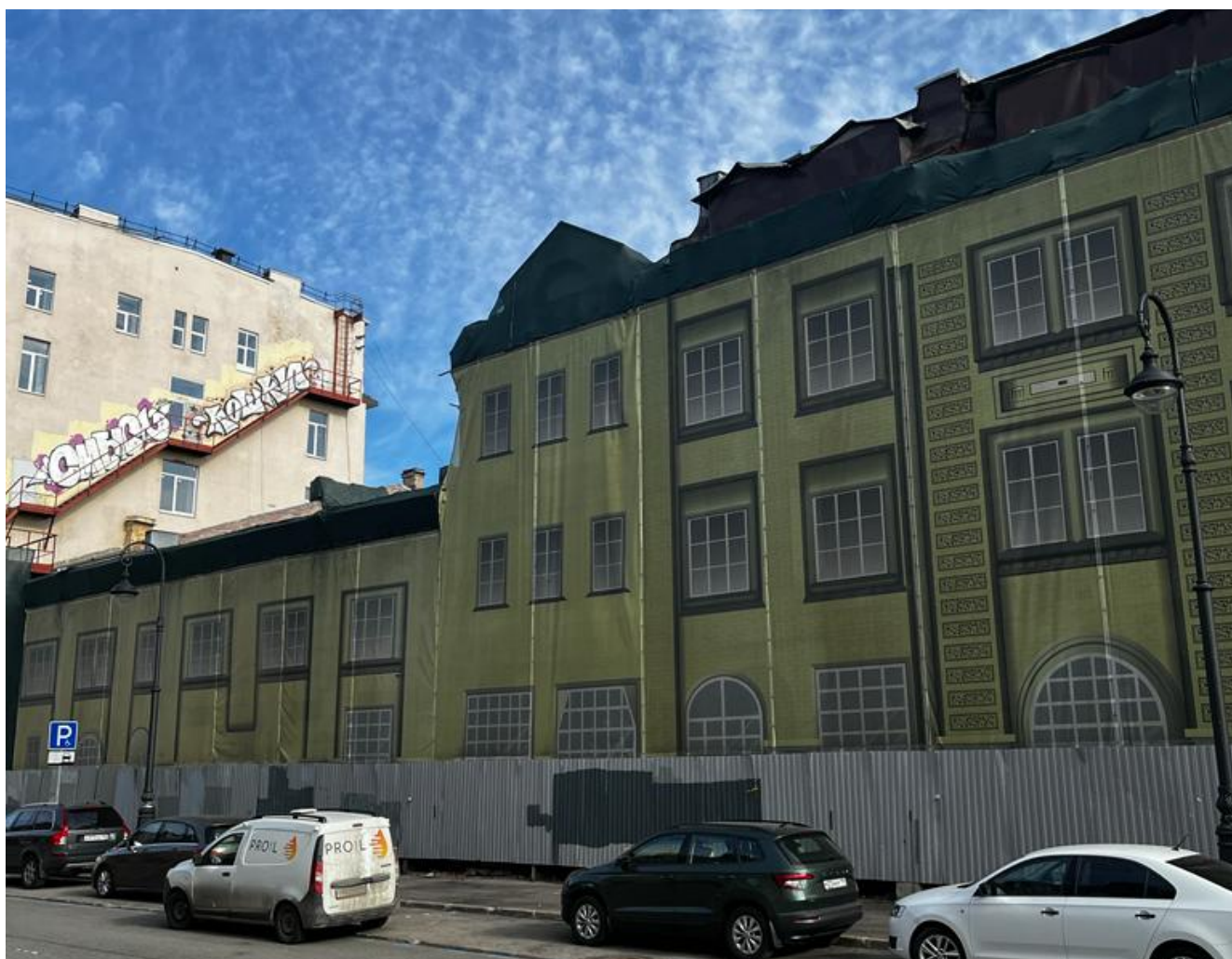
Фото №2. Объект культурного наследия регионального значения «Сельдяной ряд Никольского рынка», северный фасад, по Щепяному переулку.
