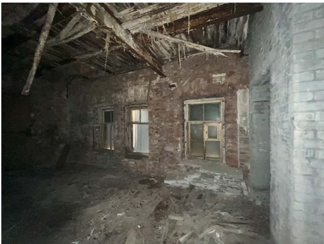
Фото №26. Объект культурного наследия регионального значения «Сельдяной ряд Никольского рынка», помещения второго этажа.
