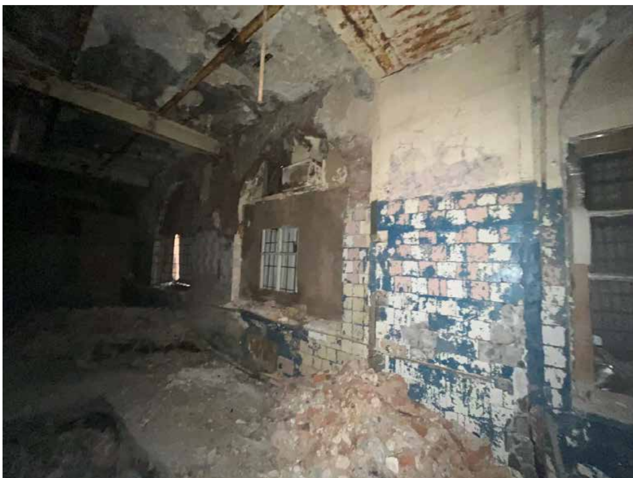
Фото №21. Объект культурного наследия регионального значения «Сельдяной ряд Никольского рынка», подвал, пом. 5-Н (5).
