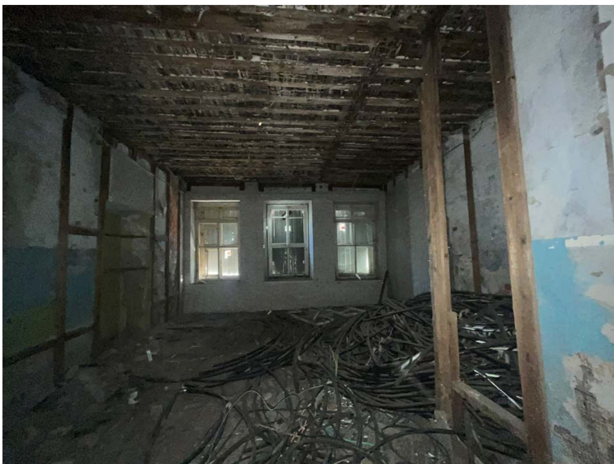
Фото №34. Объект культурного наследия регионального значения «Сельдяной ряд Никольского рынка», помещения второго этажа.
