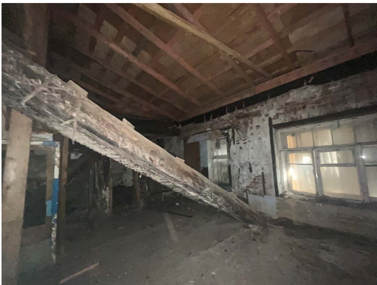
Фото №35. Объект культурного наследия регионального значения «Сельдяной ряд Никольского рынка», помещения второго этажа.
