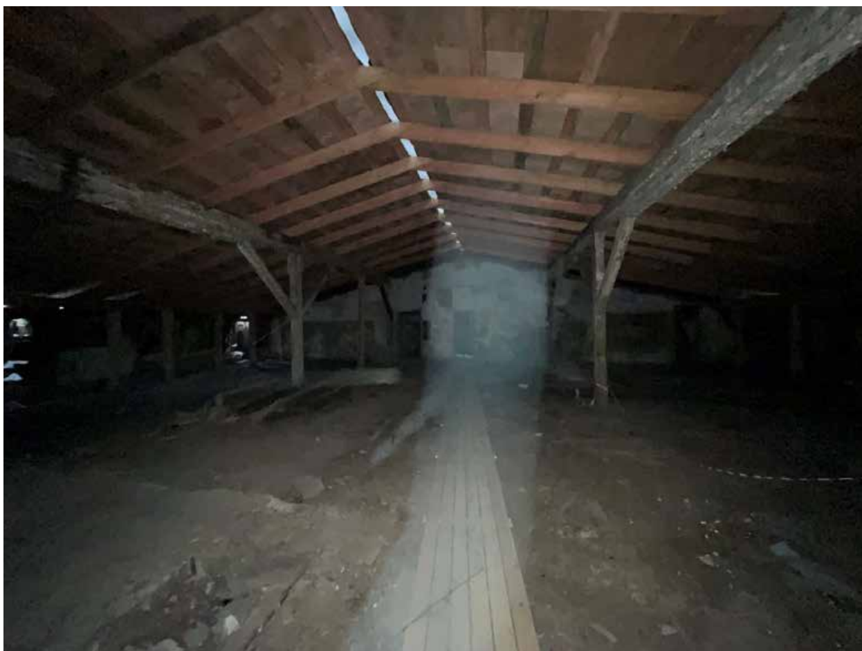
Фото №50. Объект культурного наследия регионального значения «Сельдяной ряд Никольского рынка», помещения мансарды.
