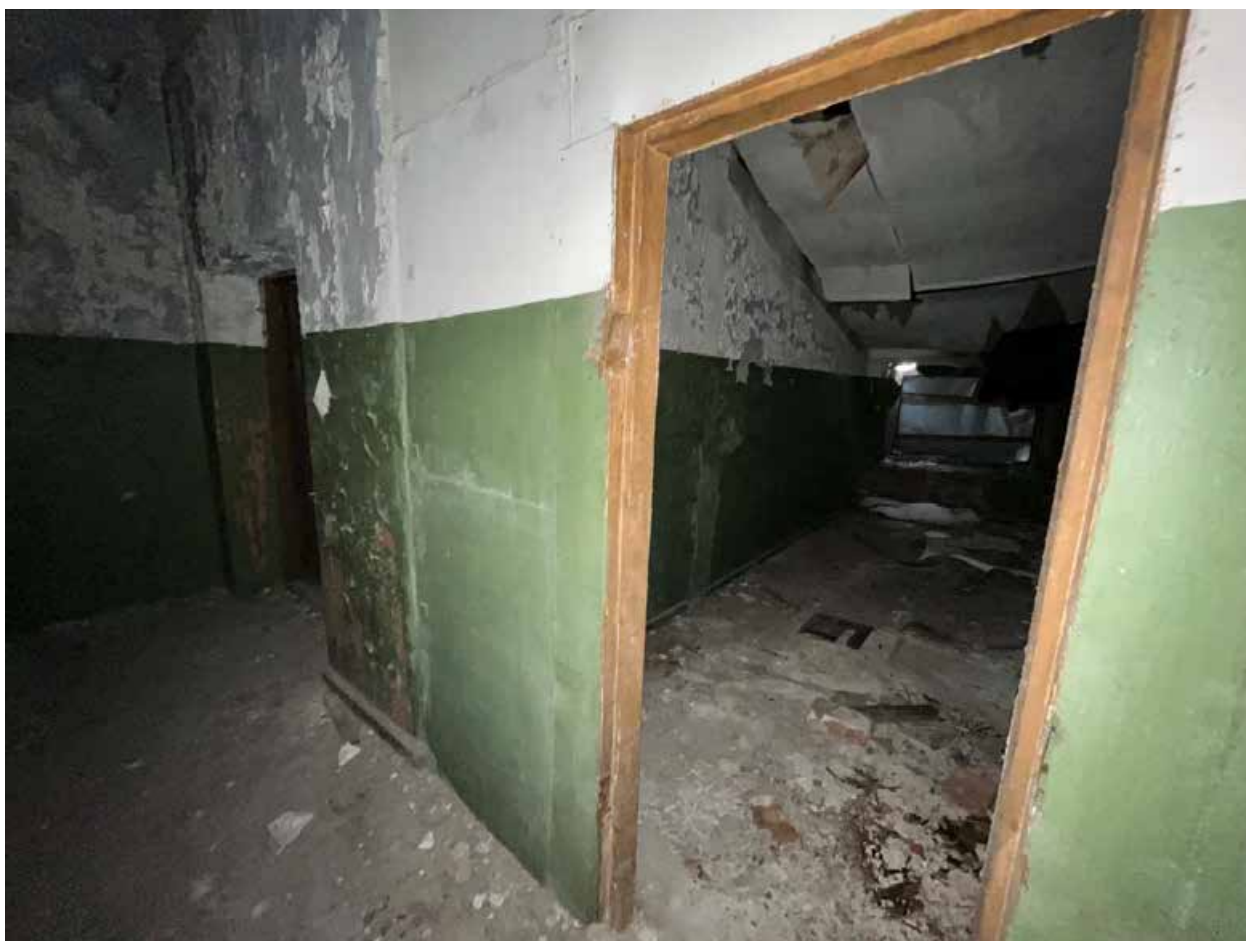
Фото №51. Объект культурного наследия регионального значения «Сельдяной ряд Никольского рынка», помещения мансарды.
