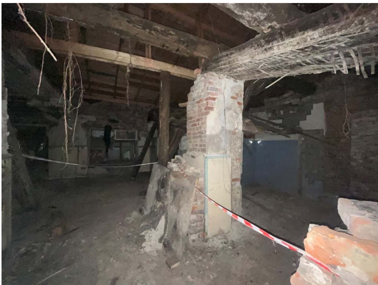
Фото №36. Объект культурного наследия регионального значения «Сельдяной ряд Никольского рынка», помещения второго этажа.
