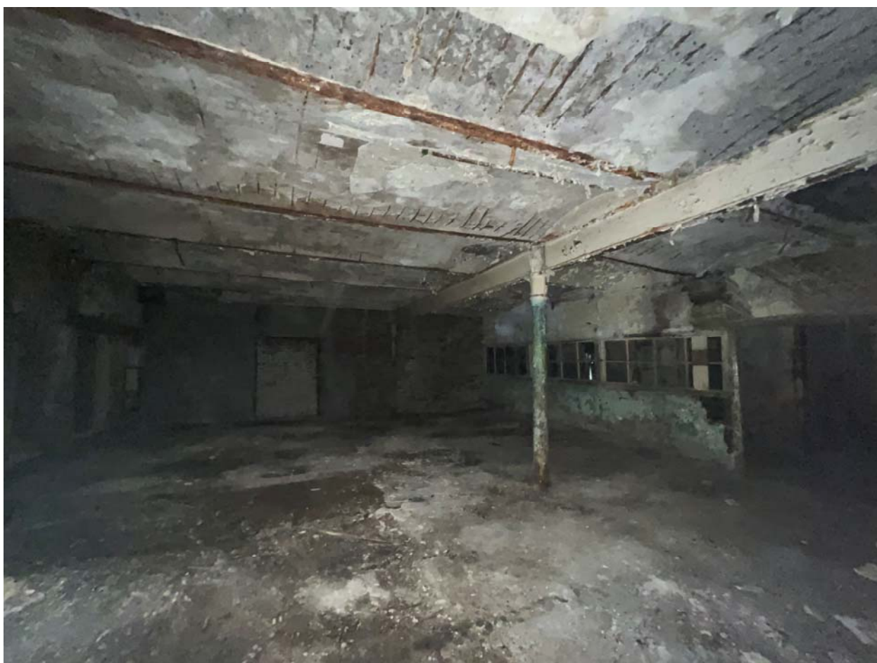
Фото №27. Объект культурного наследия регионального значения «Сельдяной ряд Никольского рынка», помещения второго этажа.
