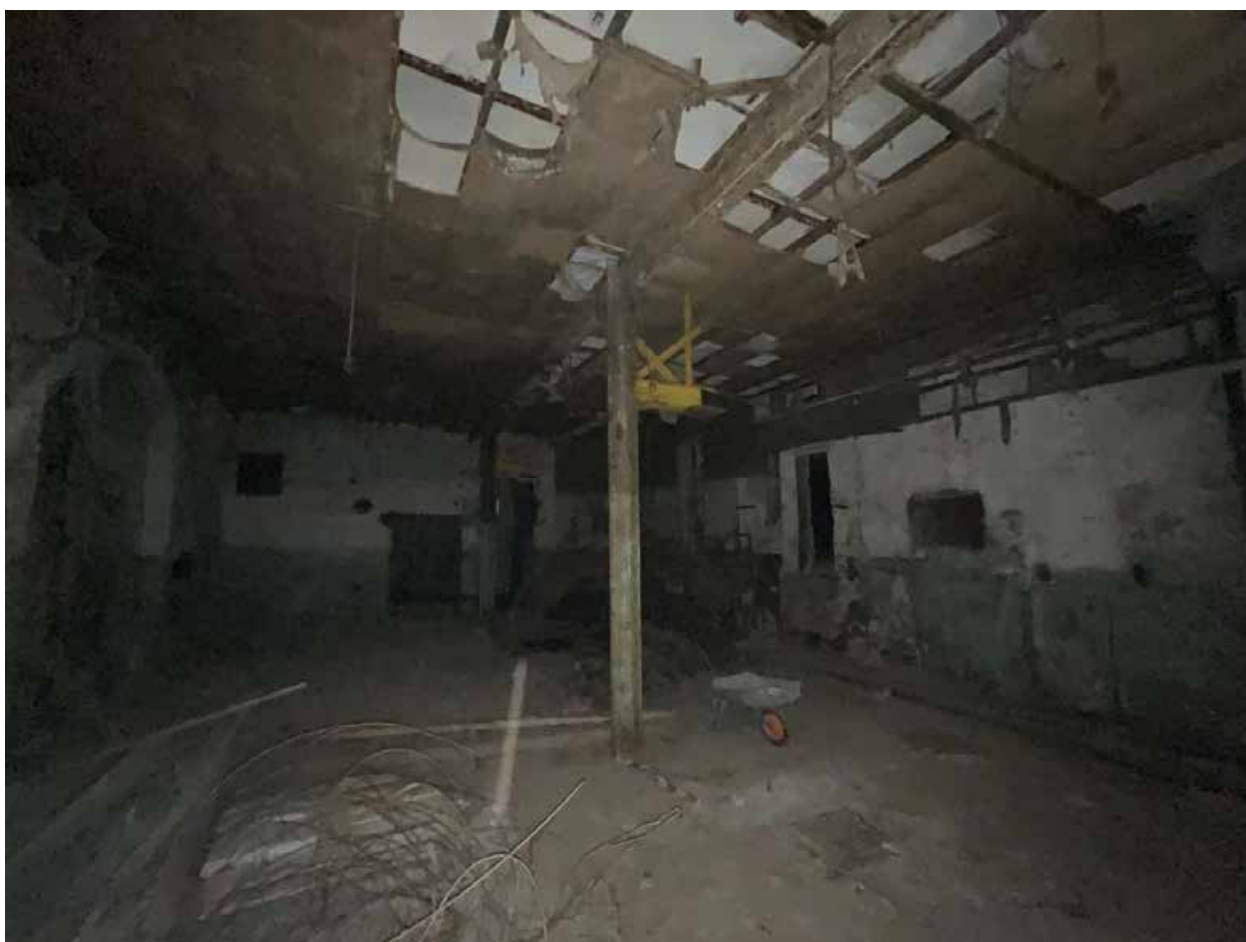
Фото №10. Объект культурного наследия регионального значения «Сельдяной ряд Никольского рынка», подвал, пом. 2-Н (6).
