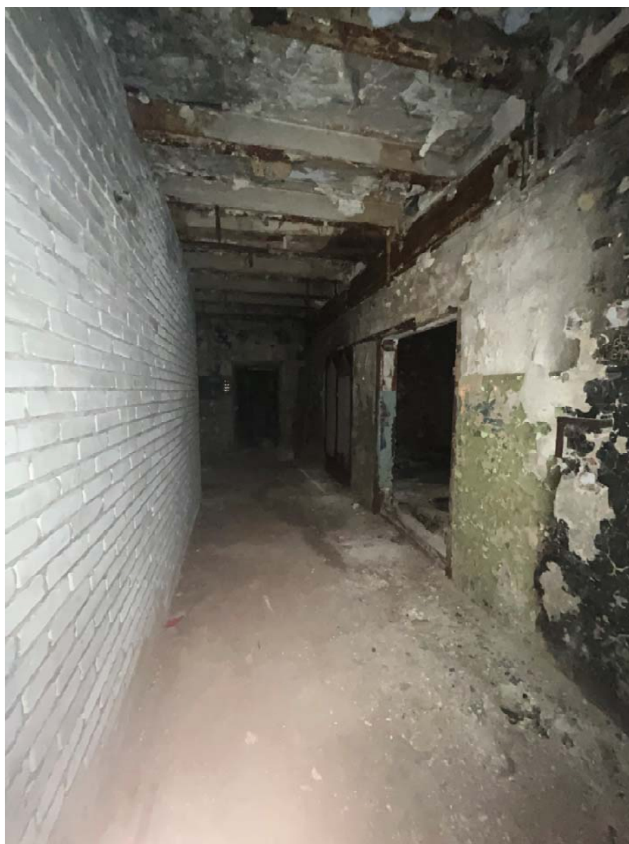
Фото №16. Объект культурного наследия регионального значения «Сельдяной ряд Никольского рынка», подвал, пом. 5-Н (3).
