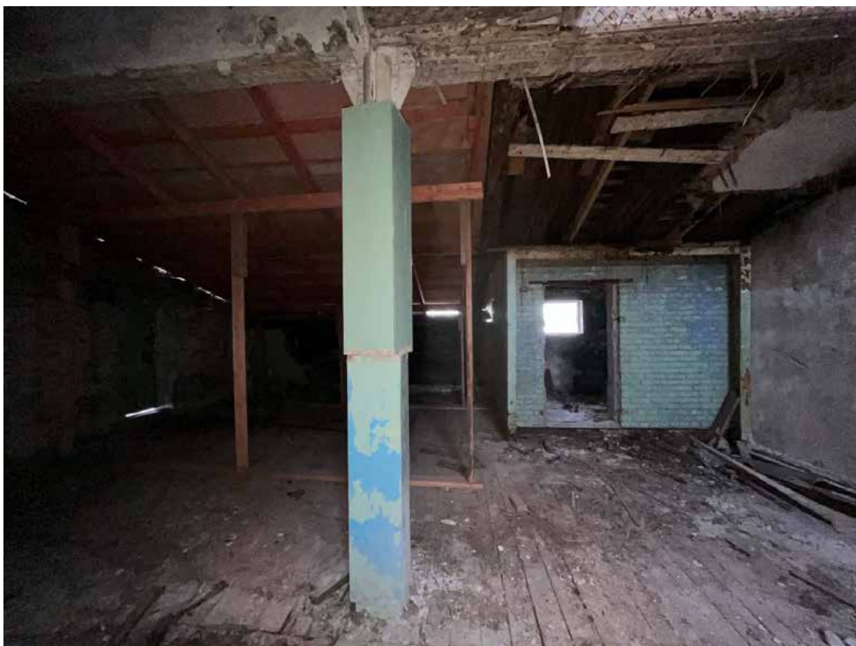
Фото №47. Объект культурного наследия регионального значения «Сельдяной ряд Никольского рынка», помещения мансарды.
