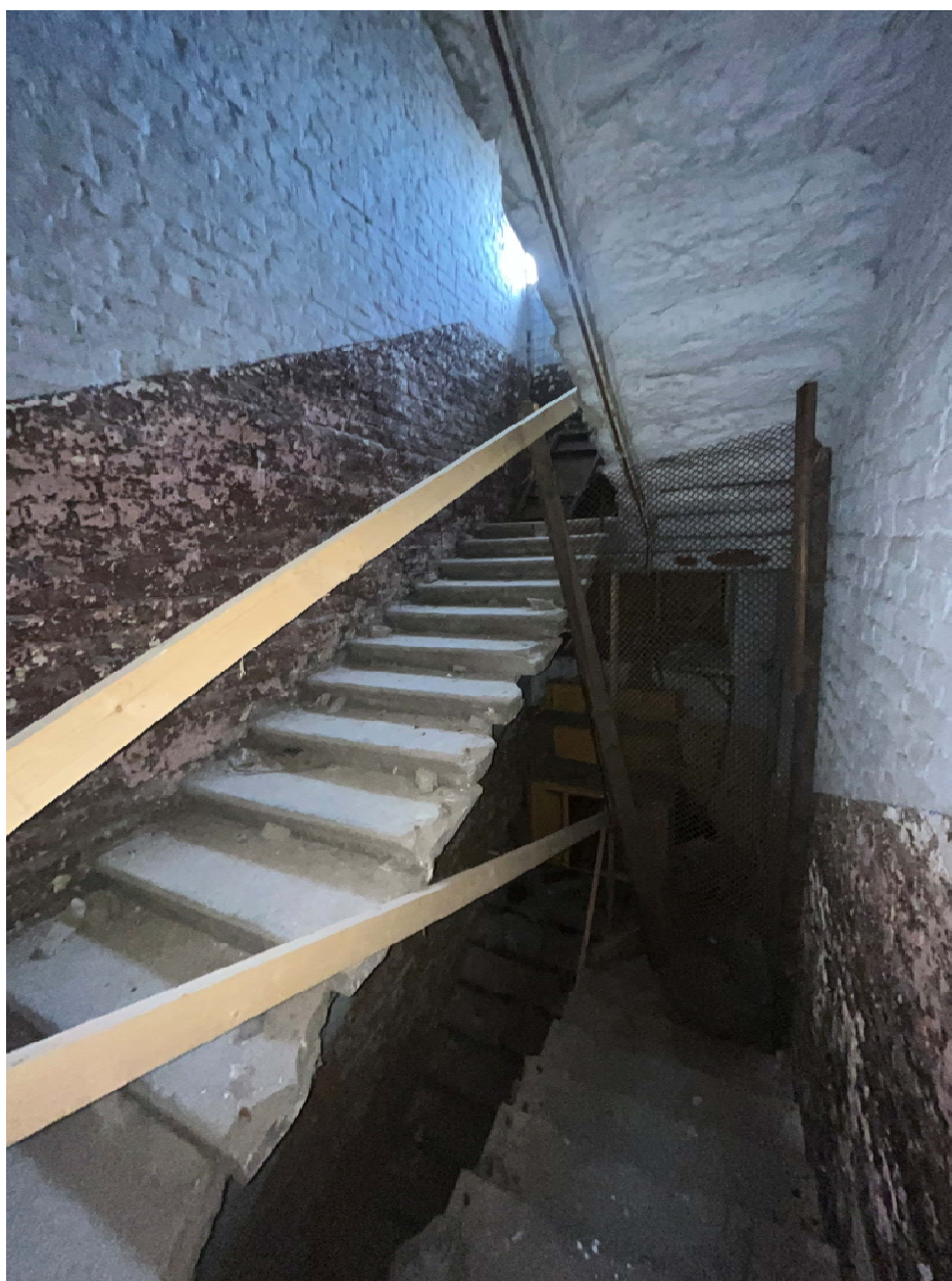
Фото №33. Объект культурного наследия регионального значения «Сельдяной ряд Никольского рынка», помещения второго этажа.
