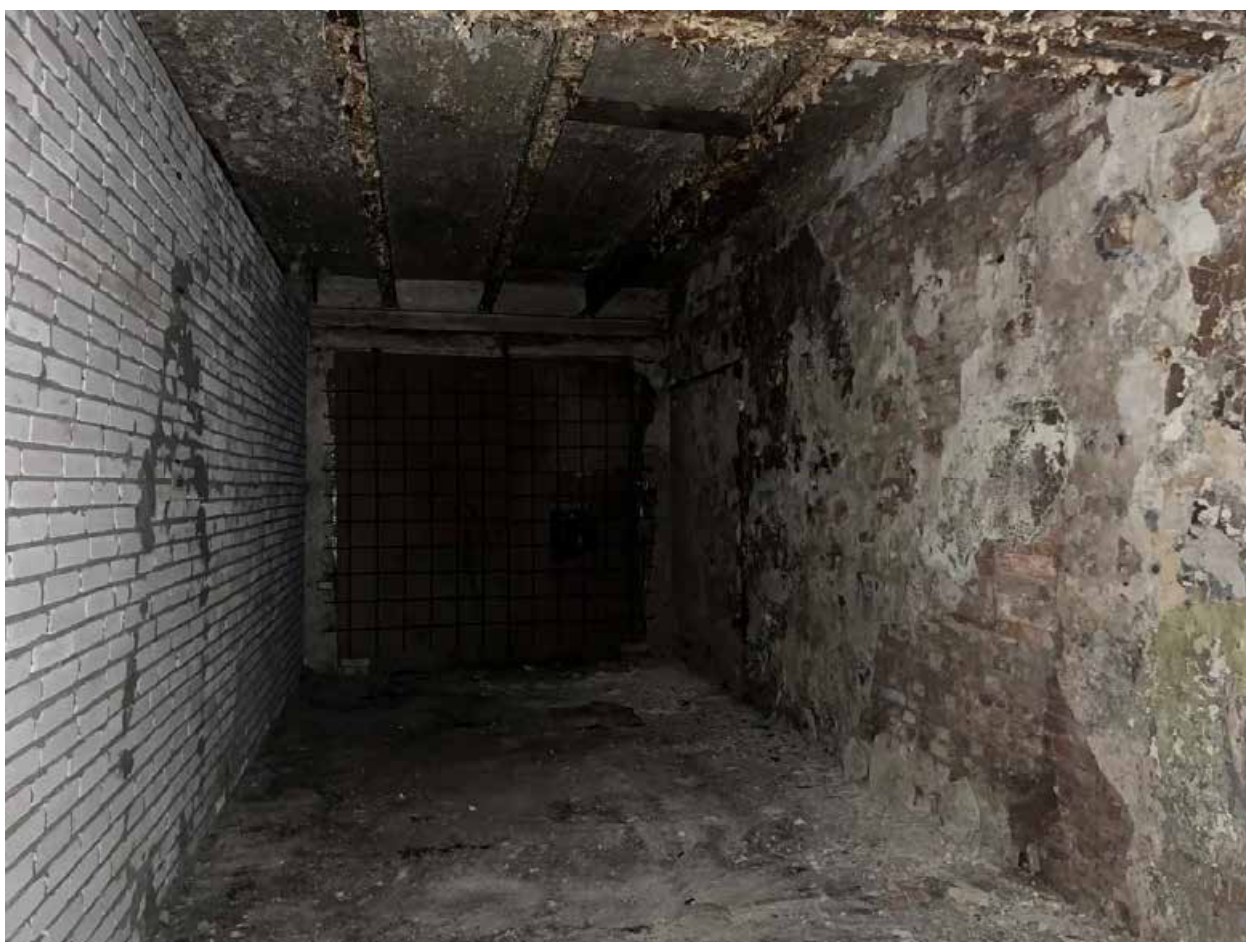
Фото №18. Объект культурного наследия регионального значения «Сельдяной ряд Никольского рынка», подвал, пом. 5-Н (6).
