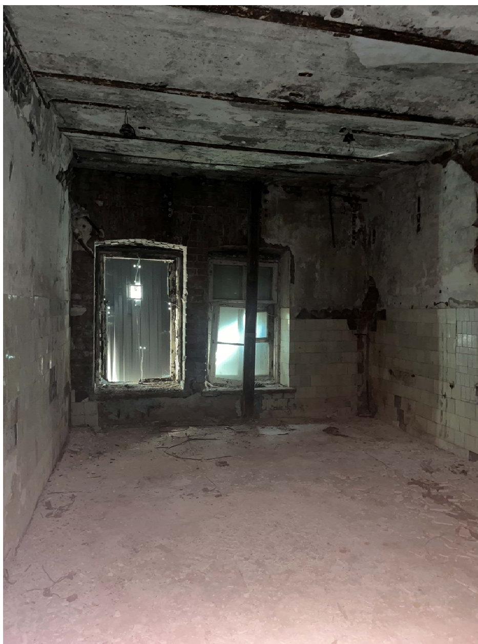
Фото №29. Объект культурного наследия регионального значения «Сельдяной ряд Никольского рынка», помещения второго этажа.
