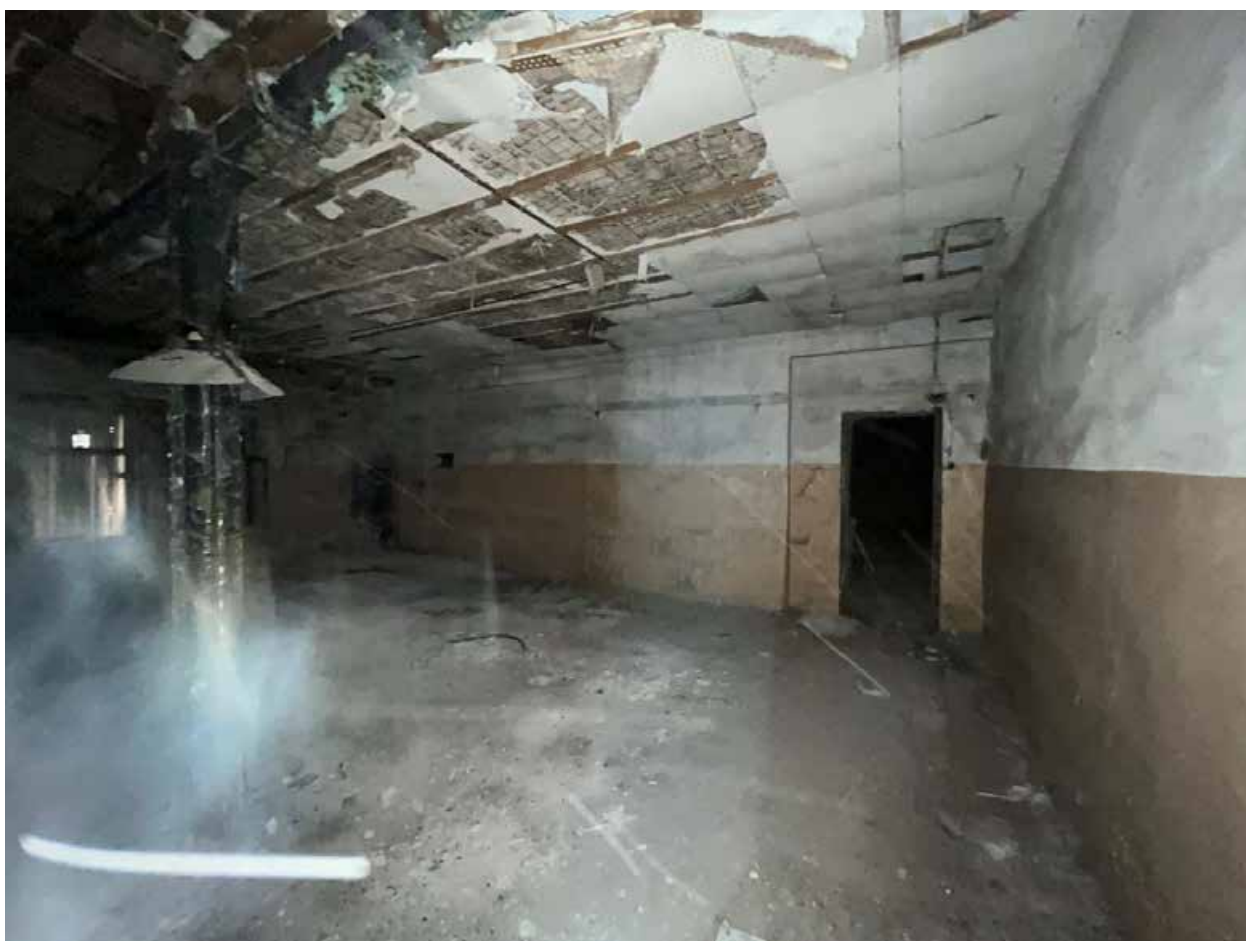
Фото №44. Объект культурного наследия регионального значения «Сельдяной ряд Никольского рынка», помещения третьего этажа.
