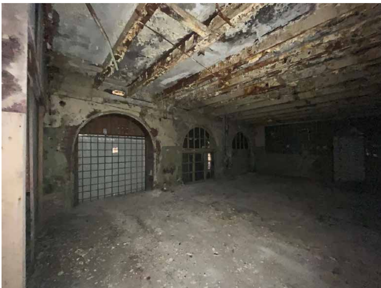
Фото №12. Объект культурного наследия регионального значения «Сельдяной ряд Никольского рынка», подвал, пом. 5-Н.
