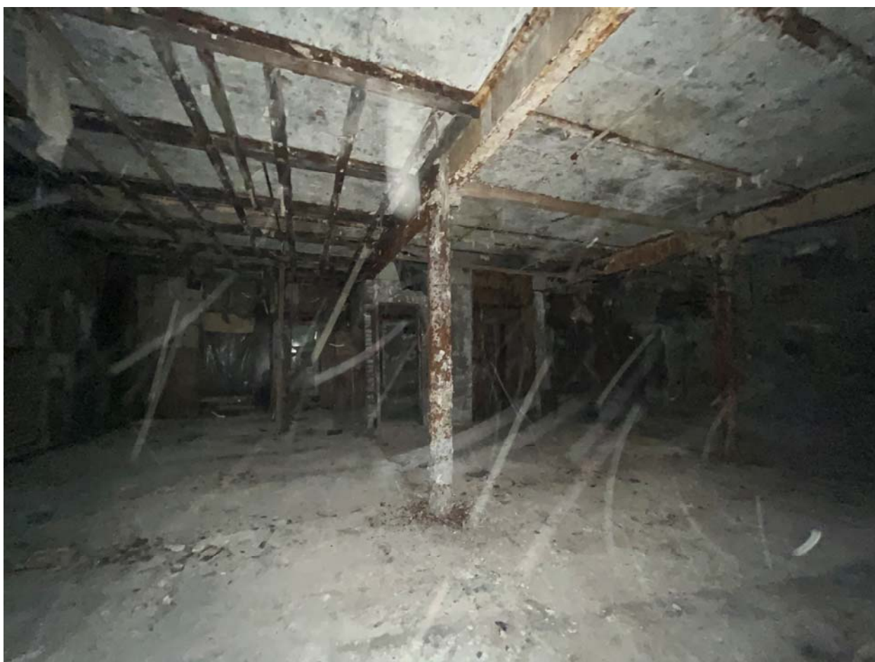
Фото №30. Объект культурного наследия регионального значения «Сельдяной ряд Никольского рынка», помещения второго этажа.
