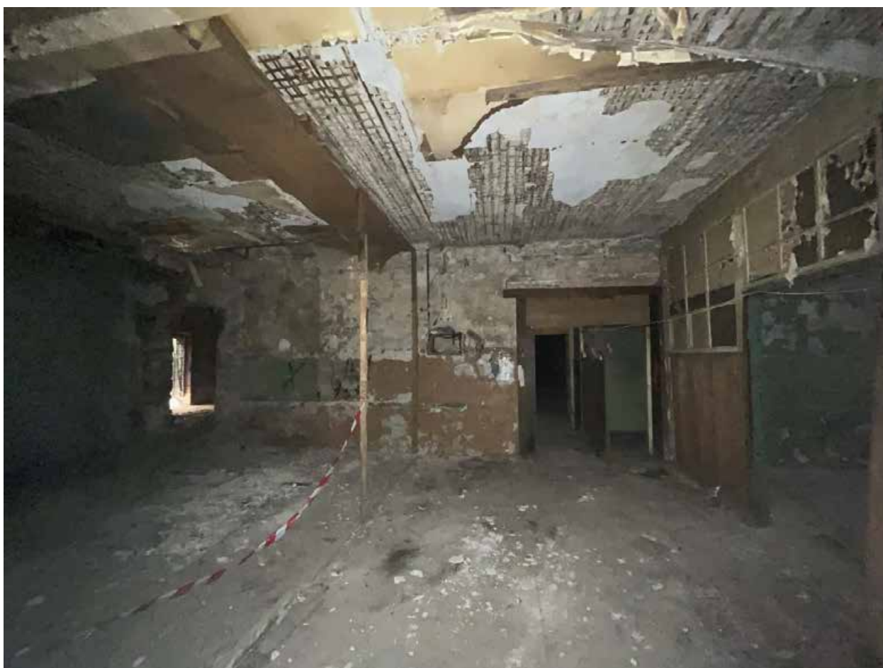
Фото №24. Объект культурного наследия регионального значения «Сельдяной ряд Никольского рынка», помещения второго этажа.
