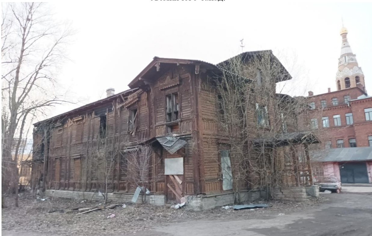
14. Вид на объект выявленный объект культурного наследия «Жилой дом (деревянный, двухэтажный)», набережная Обводного канала, дом 116, корпус 2, литера А. Направление съемки северо-запад.
