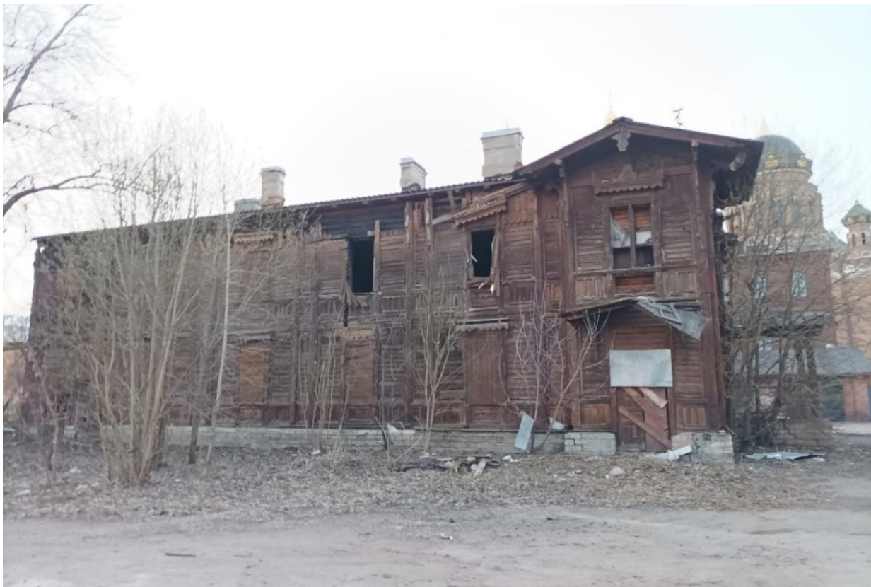
15. Вид на объект выявленный объект культурного наследия «Жилой дом (деревянный, двухэтажный)», набережная Обводного канала, дом 116, корпус 2, литера А. Направление съемки север.
