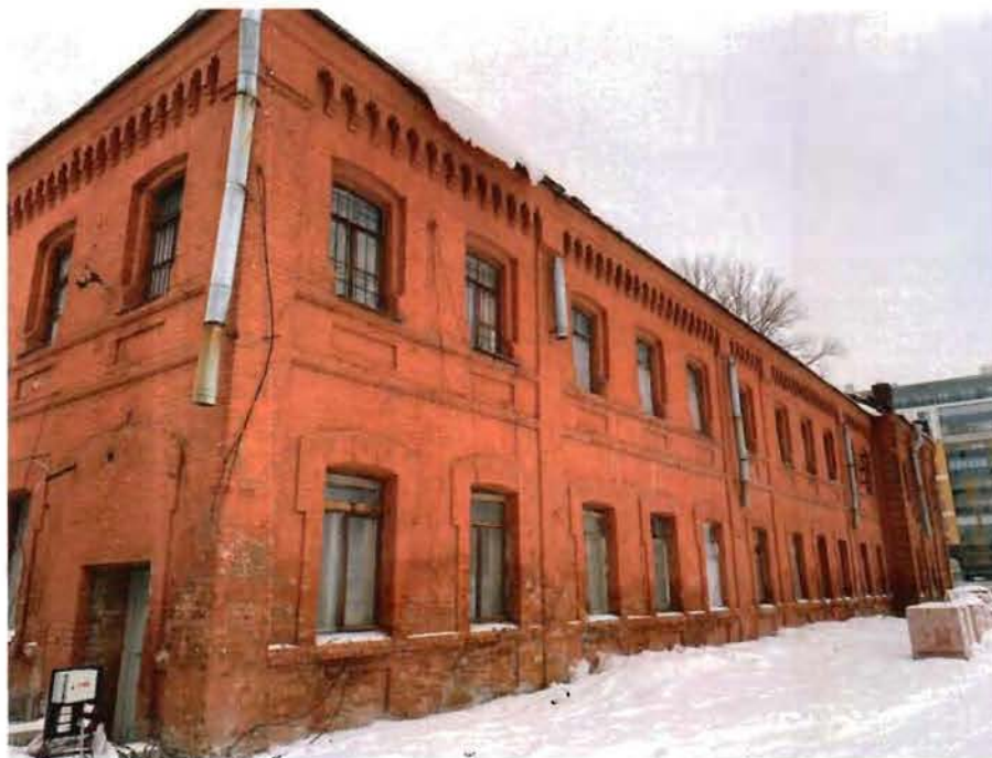
1. Общий вид на объект культурного наследия.
