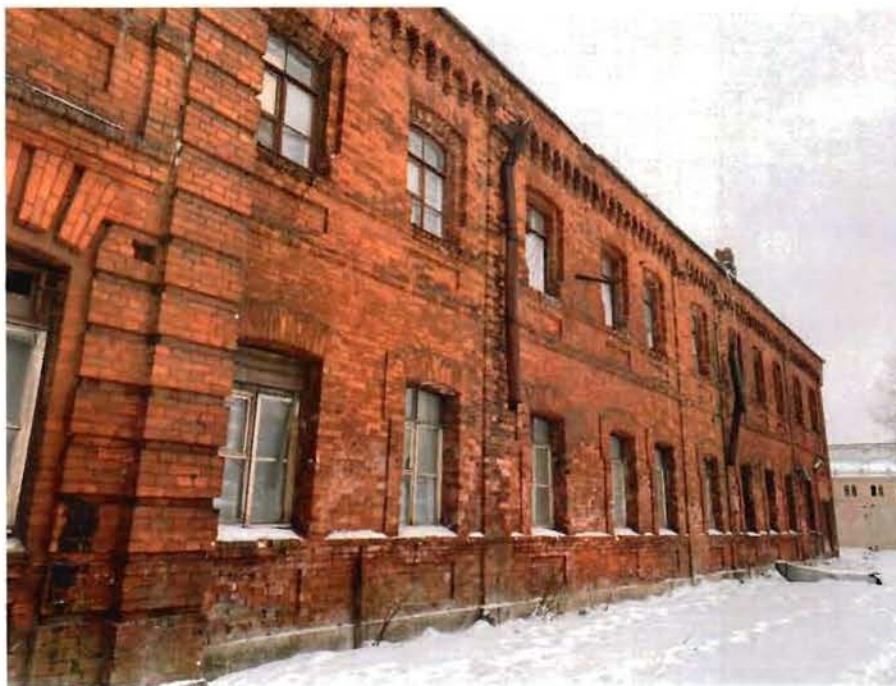
2. Общий вид на объект культурного наследия.
