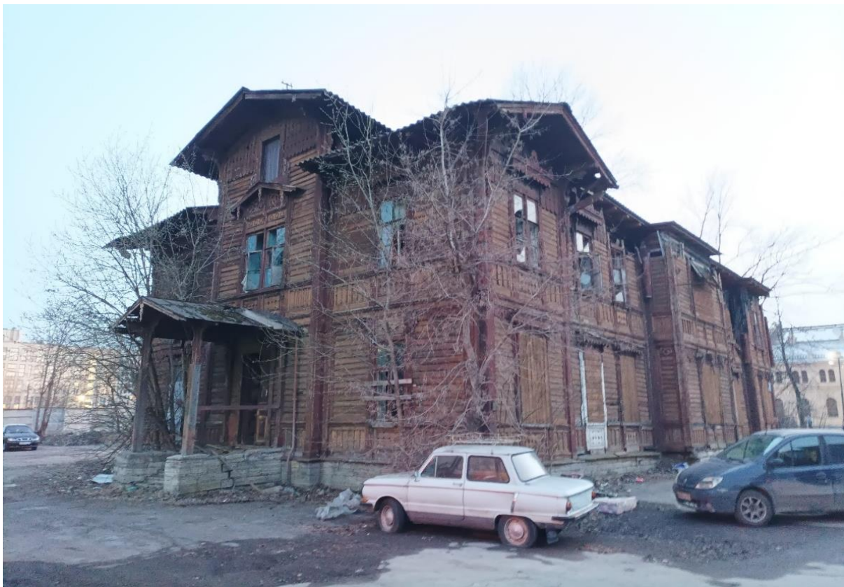
13. Вид на объект выявленный объект культурного наследия «Жилой дом (деревянный, двухэтажный)», набережная Обводного канала, дом 116, корпус 2, литера А. Направление съемки юго-запад.
