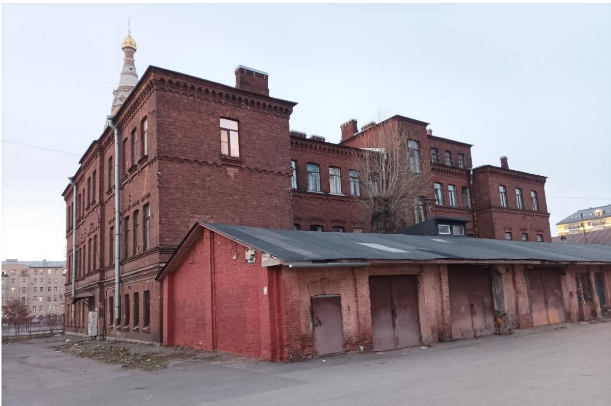
11. Вид на объект выявленный объект культурного наследия «Служебное здание», наб. Обводного канала, дом 116а, литера А. Направление съемки северо-восток.
