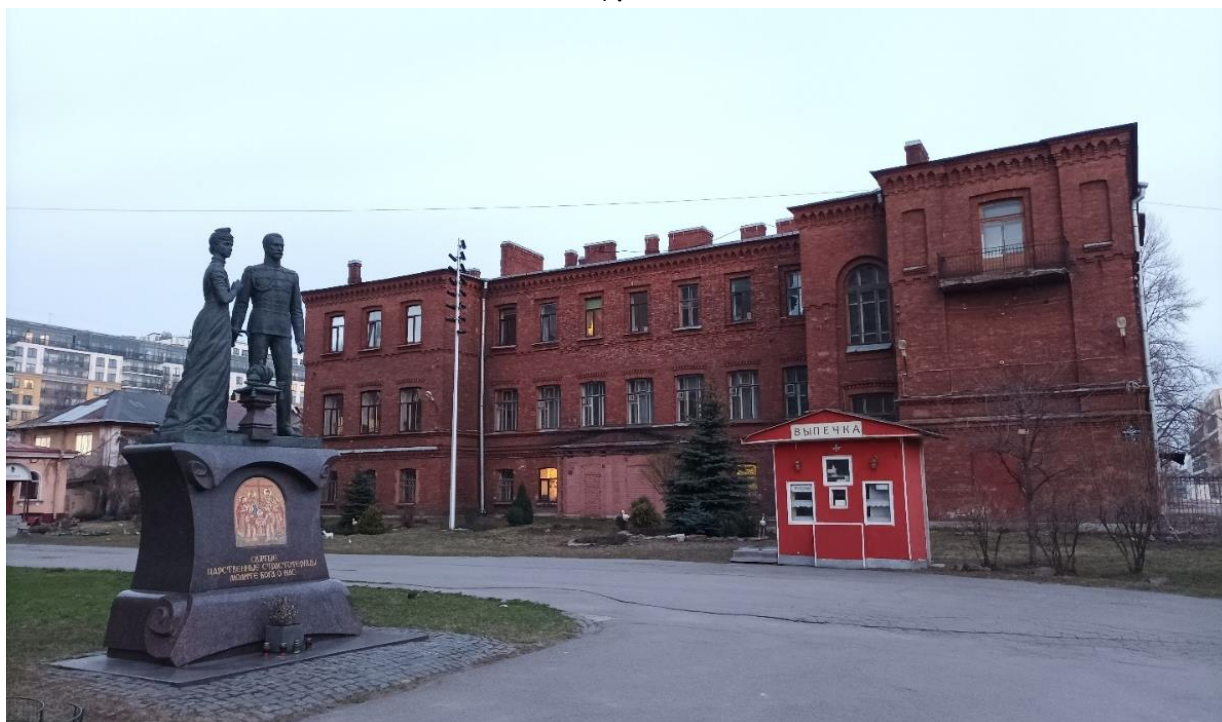
8. Вид на объект выявленный объект культурного наследия «Служебное здание», наб. Обводного канала, дом 116а, литера А. Направление съемки юг.
