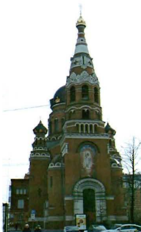
Фото № 4. Западный фасад.
