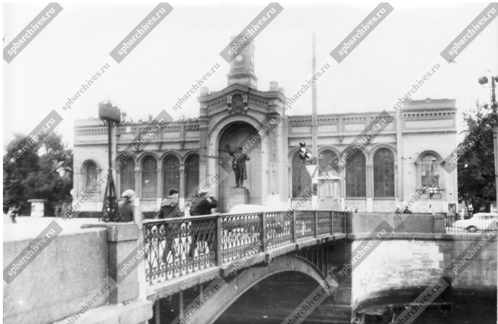
Илл.11. Вид от Варшавского моста на здание Варшавского вокзала. Архитектор П.О. Сальманович, 1858-1859 гг., инженер Ю. Фляша. сентябрь 1979 г. Автор неизвестен. Направление съемки юг. // ЦГАКФФД СПб. Фотодокумент Ар 212557
