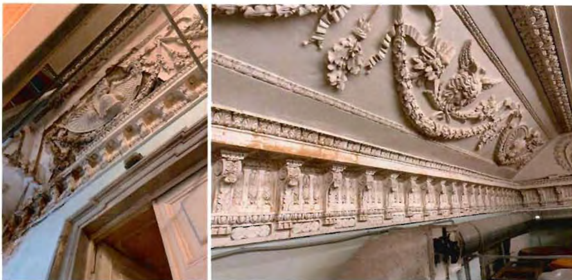
72, 73. Помещения 1 этажа (пом. 1Н (90, 105)) (фотографии от 12.05.2022).
