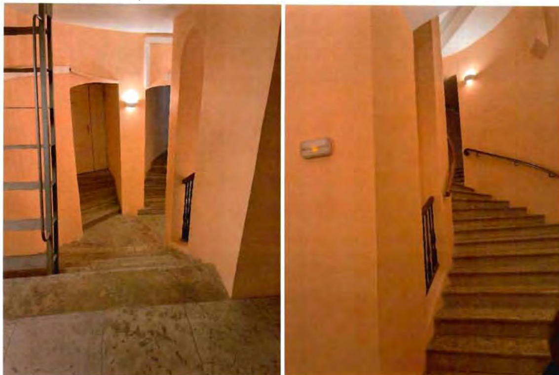
117, 118. Лестницы в северо-западной части объекта культурного наследия (фотографии от 26.05.2022).
