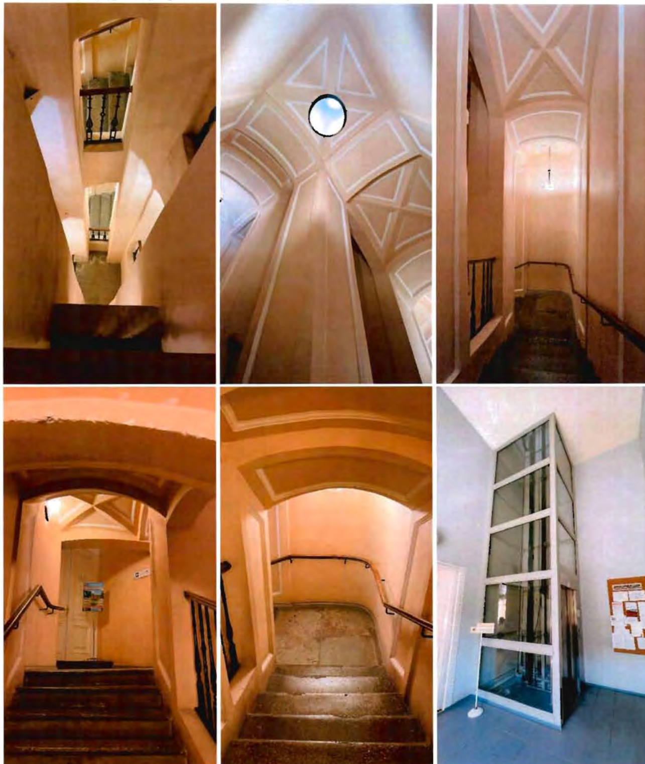
121, 122, 123, 124, 125, 126. Лестница в западной части объекта культурного наследия и лифт в пом. 1Н (30) (фотографии от 16.06.2022).
