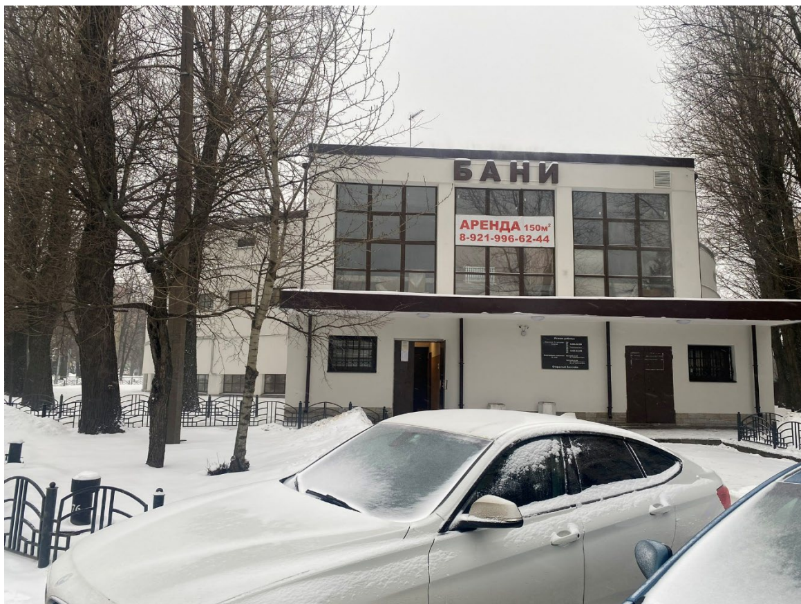
1. Вид с западной стороны на объект культурного наследия регионального значения «Круглая баня»;
