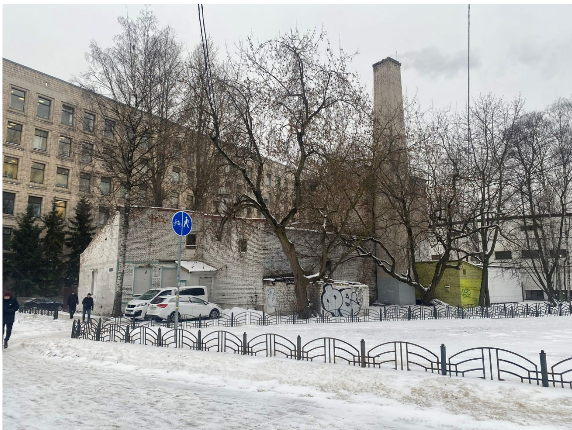
9. Вид на котельную с северной стороны, на территории объекта культурного наследия регионального значения «Круглая баня»;
