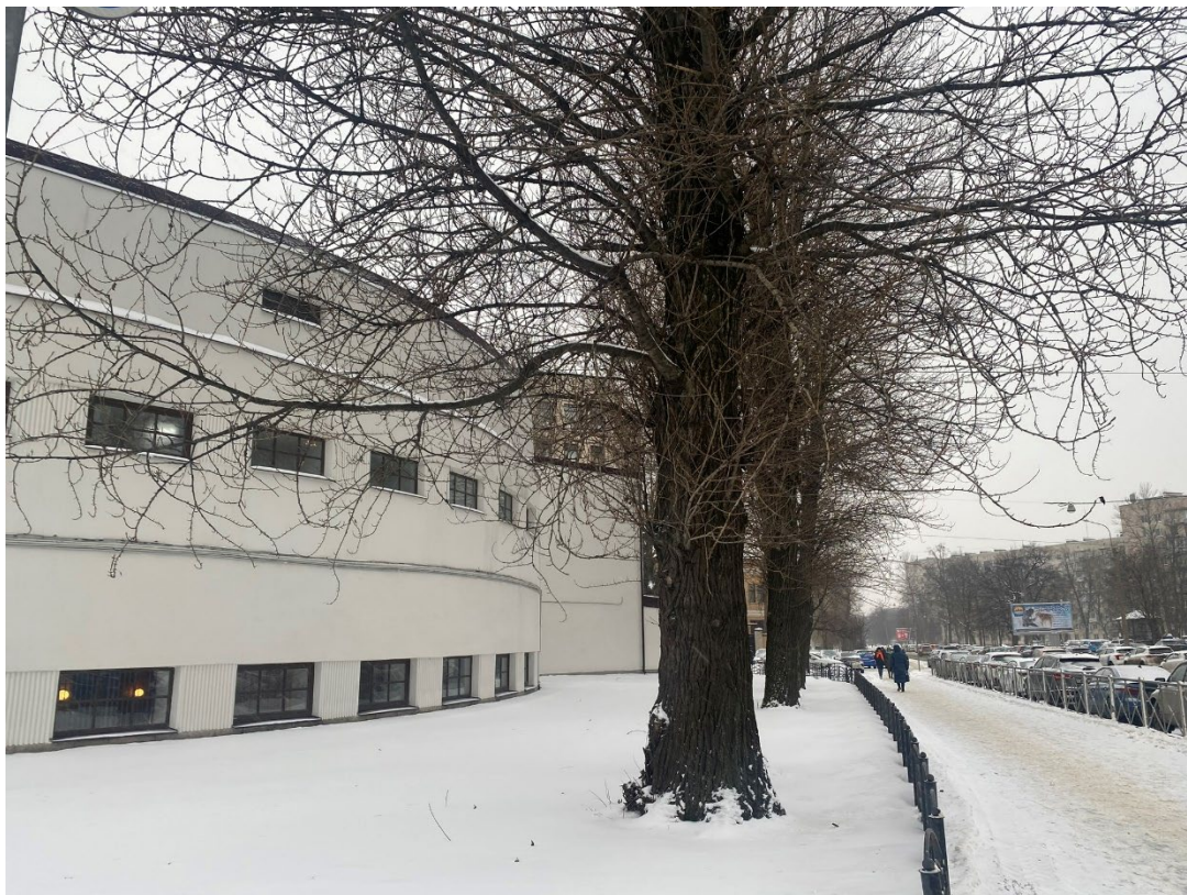
13. Вид на объект культурного наследия регионального значения «Круглая баня»;
