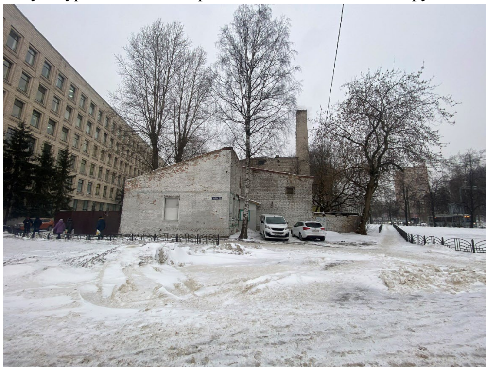
8. Вид на котельную с восточной стороны, на территории объекта культурного наследия регионального значения «Круглая баня»;
