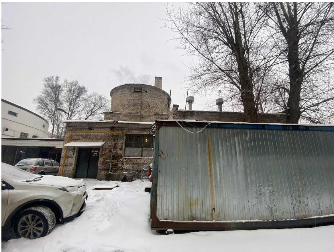
5. Вид на котельную с южной стороны, находящуюся на территории объекта культурного наследия регионального значения «Круглая баня»;
