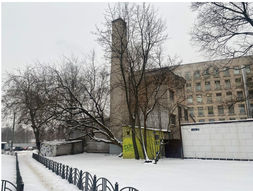
11. Вид на котельную с северной стороны, на территории объекта культурного наследия регионального значения «Круглая баня»;
