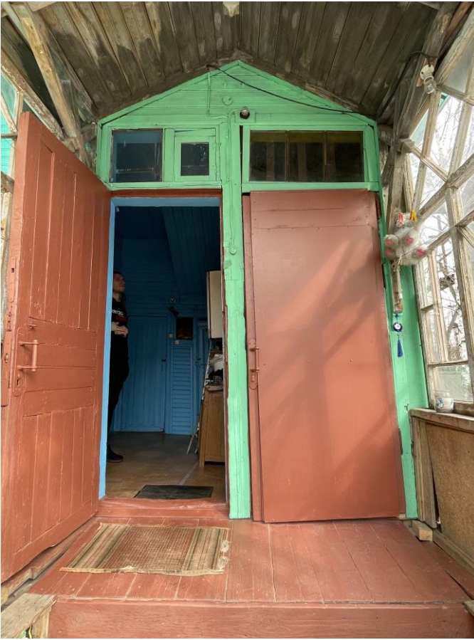
Фото 8. Крыльцо и вход в здание. Юго-западный фасад
