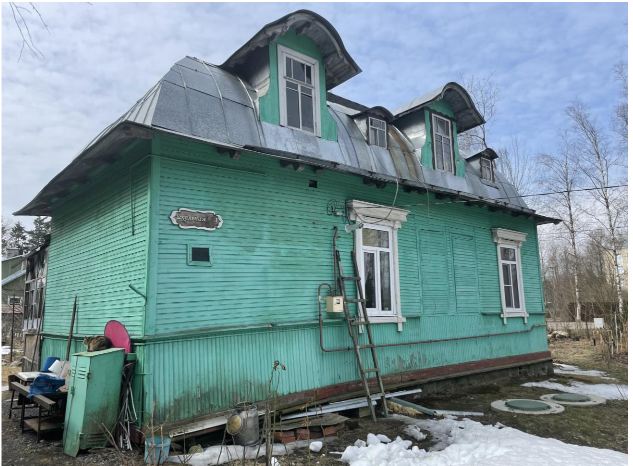
Фото 6. Северо-восточный фасад здания.
