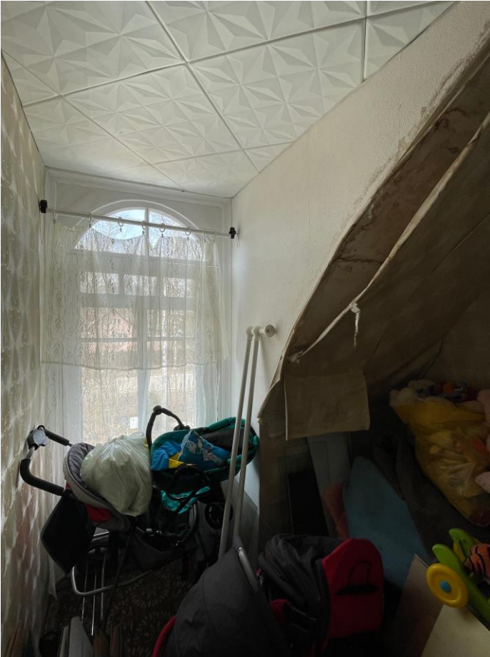
Фото 20. Помещение в объеме мансарды.
