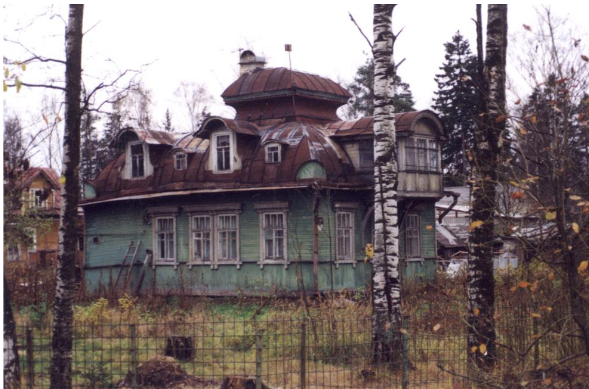
Илл. 29. Северо-восточный и северо-западный фасады дачи. 1999 г. // Учетная карточка КГИОП
