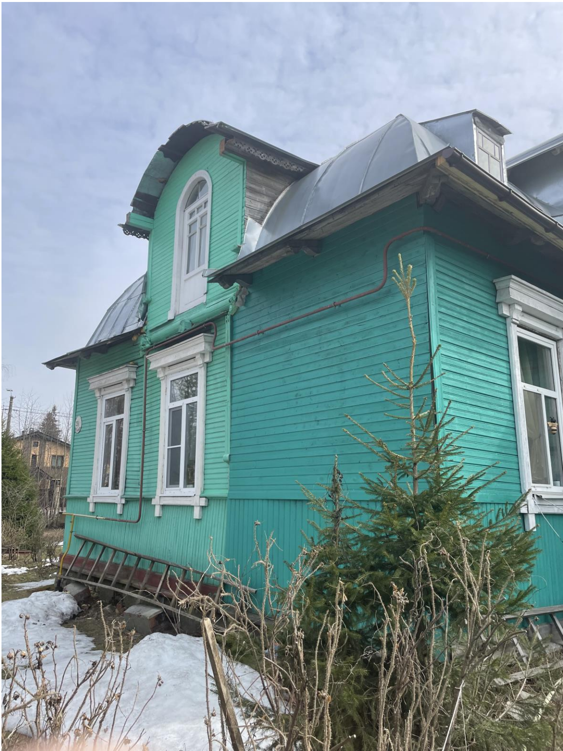
Фото 2. Северо-западный фасад здания.
