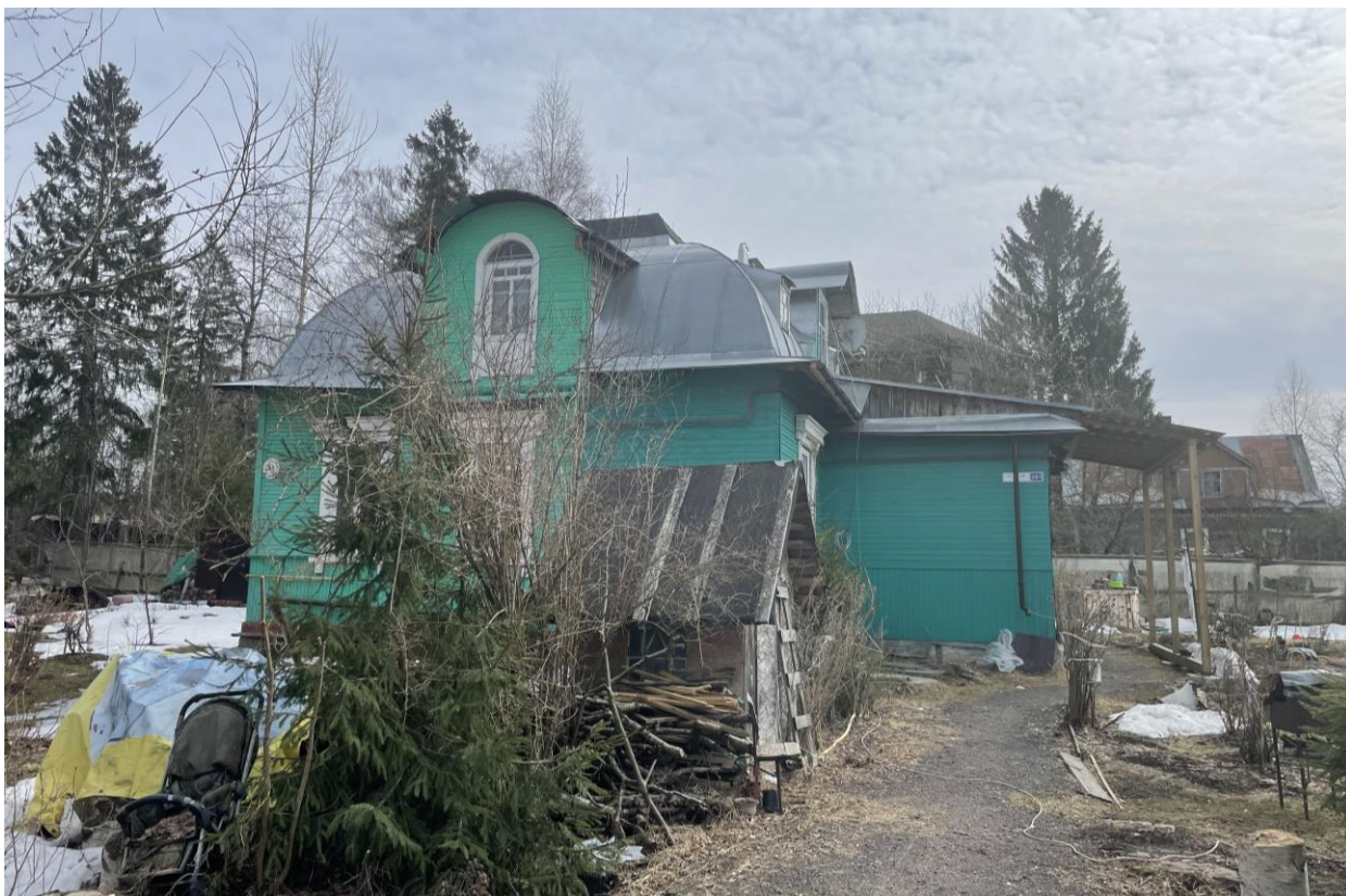
Фото 1. Северо-западный фасад здания.
