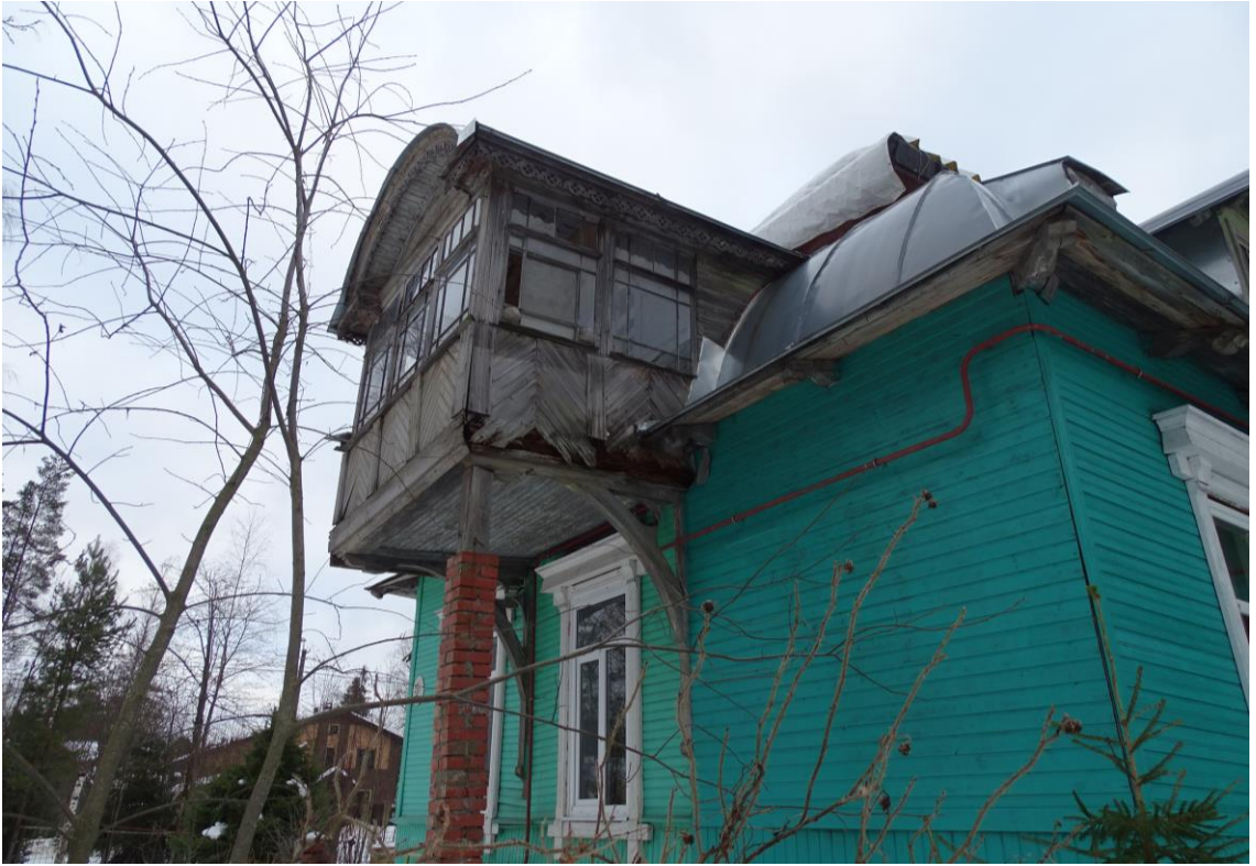
Илл. 35. Северо-западный фасад. Эркер. Фотография 2021 г.
