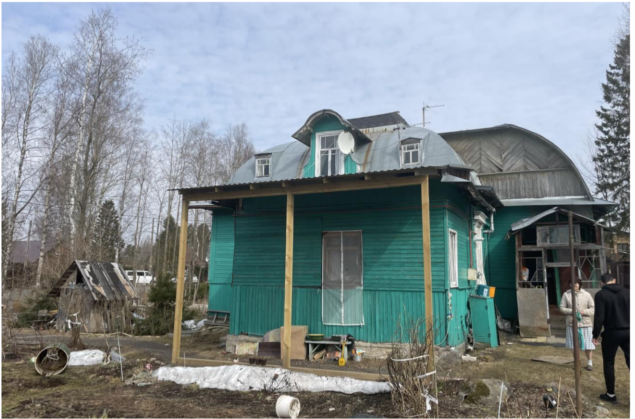
Фото 4. Юго-западный фасад здания.
