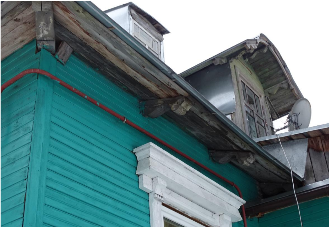
Илл. 36. Юго-западный фасад. Фрагмент. Фотография 2021 г.
