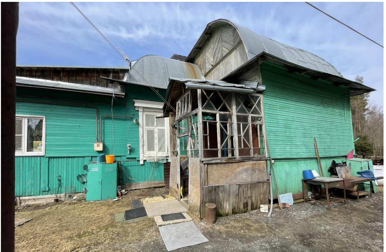
Фото 5. Юго-восточный фасад здания.
