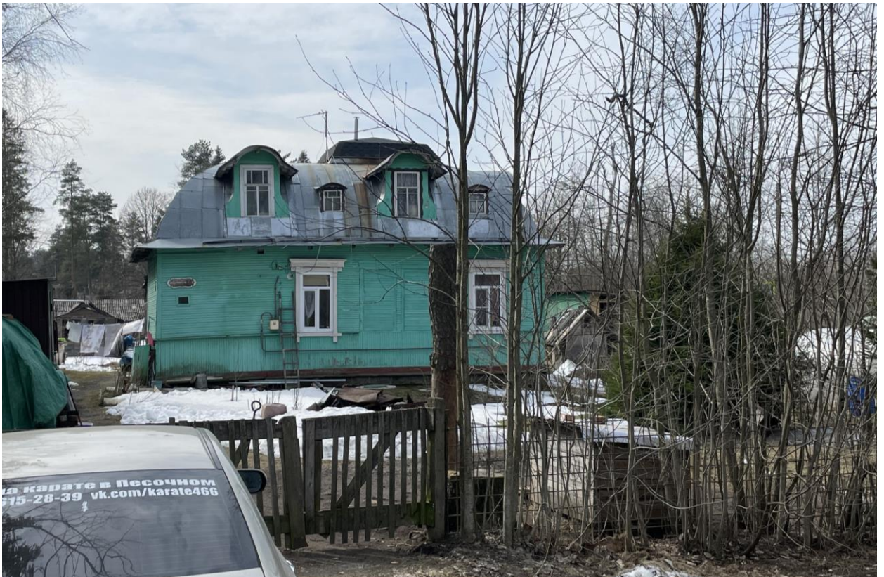
Фото 7. Северо-восточный фасад здания.
