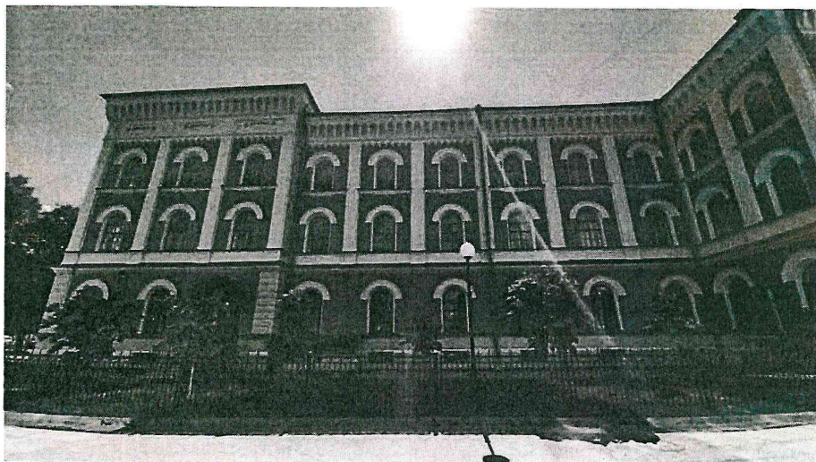
4. Здание института. Фрагмент северного фасада
