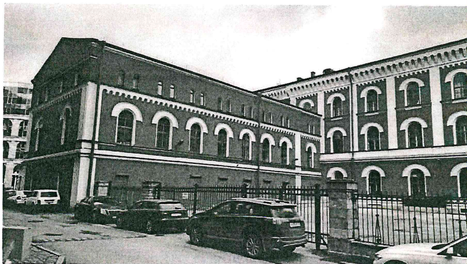
3. Здание института. Южный фасад
