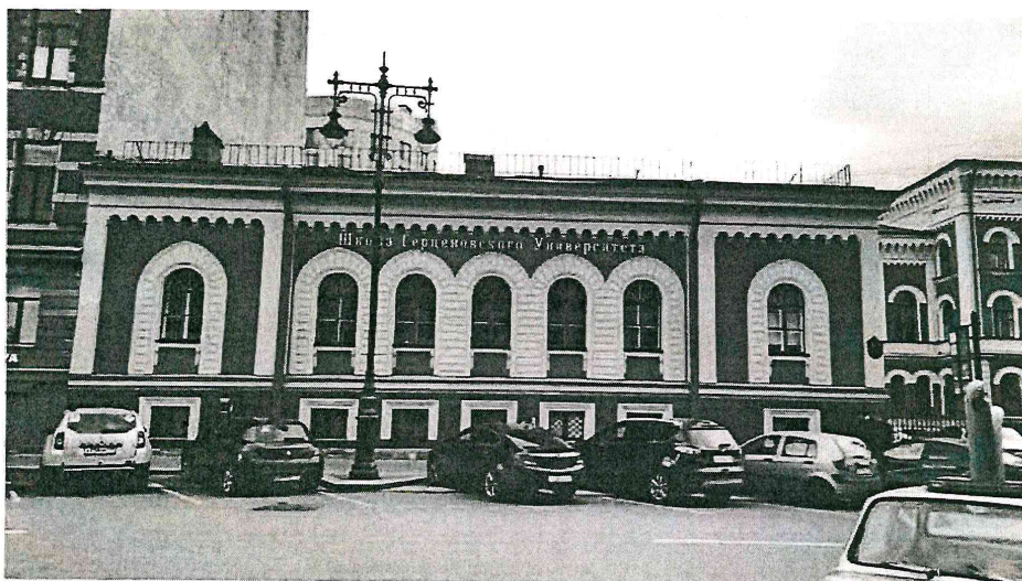
10. Флигель. Восточный фасад
