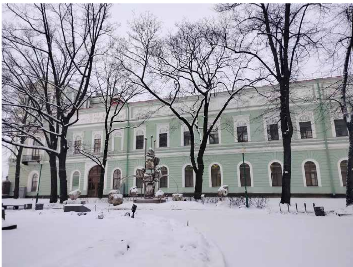
Фото 6. Лицевой фасад объекта культурного наследия федерального значения «Корпус служебный», входящего в состав объекта культурного наследия федерального значения «Мраморный дворец»
