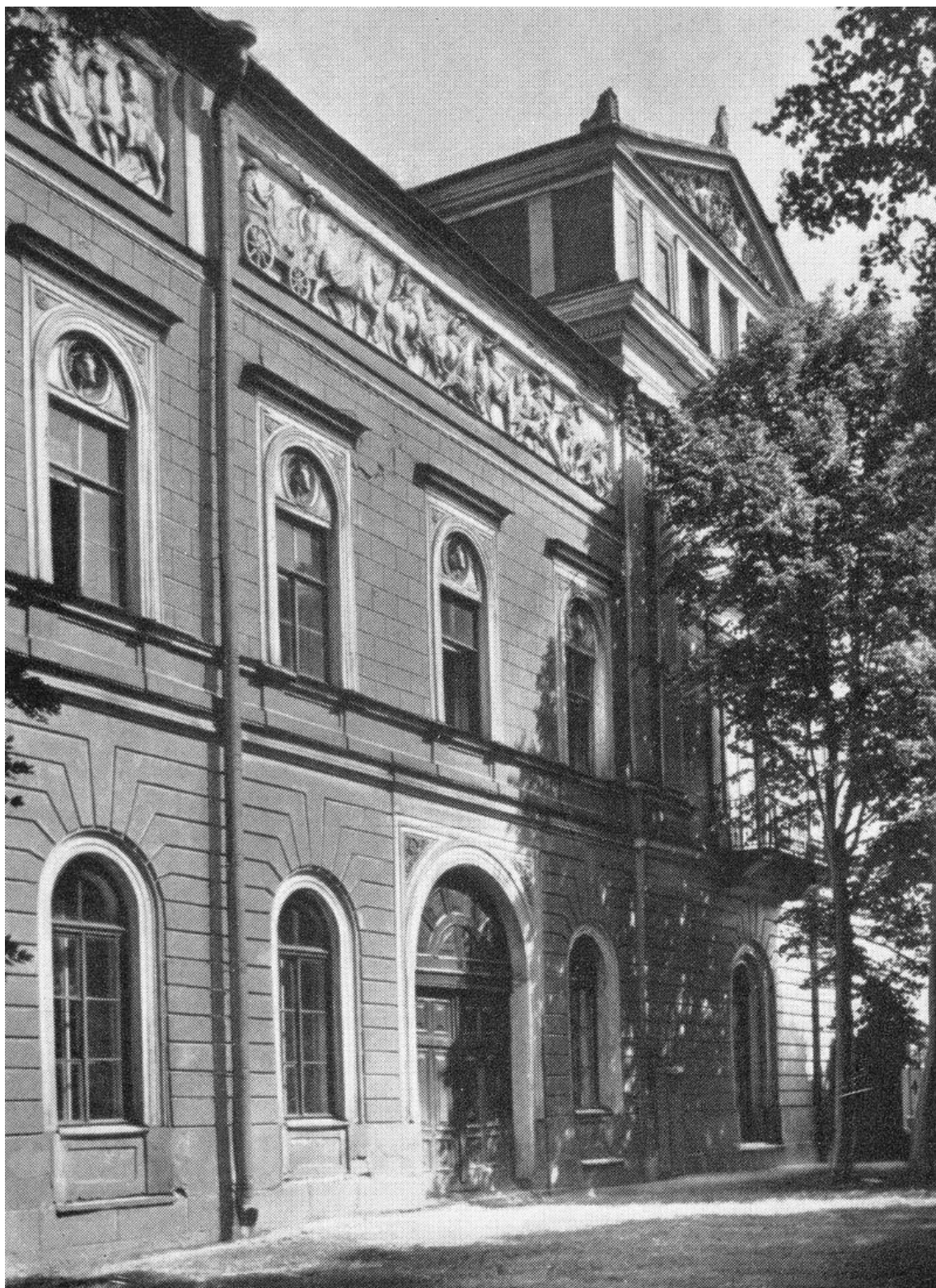
18. Служебный корпус Мраморного дворца. Западный фасад. 1972-1973 гг. // Памятники архитектуры Ленинграда / Гл. ред. Г.Н. Булдаков Изд. 4-е, перераб. — Л.: Стройиздат, ЛО, 1975 (ГлавПУ исполкома Ленсовета. Гос. инспекция по охране памятников).
