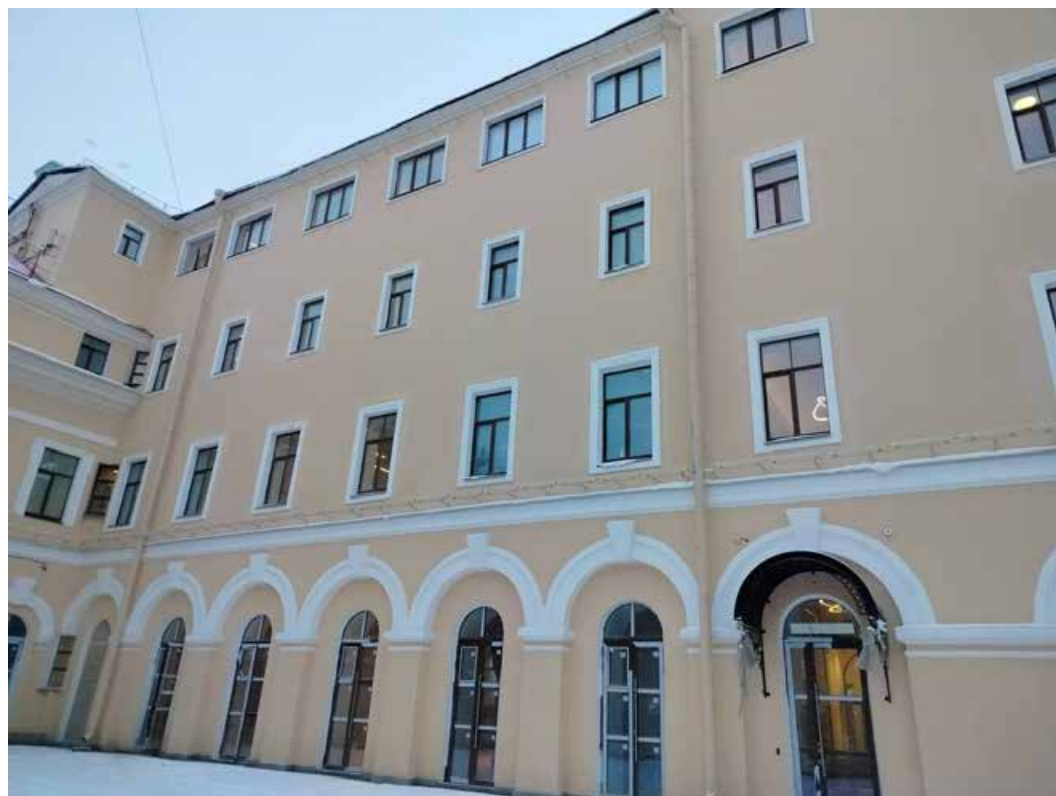
Фото 8. Фрагмент дворового фасада объекта культурного наследия федерального значения «Корпус служебный», входящего в состав объекта культурного наследия федерального значения «Мраморный дворец»
