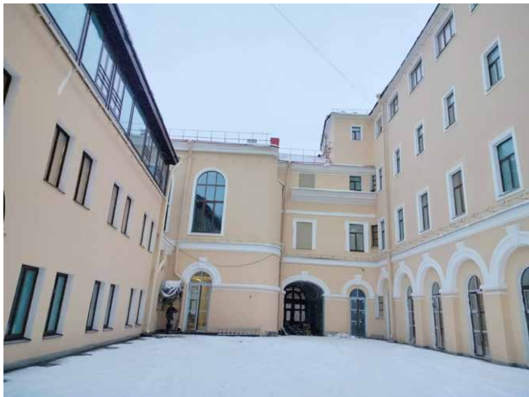
Фото 10. Фрагмент дворового фасада объекта культурного наследия федерального значения «Корпус служебный», входящего в состав объекта культурного наследия федерального значения «Мраморный дворец»
