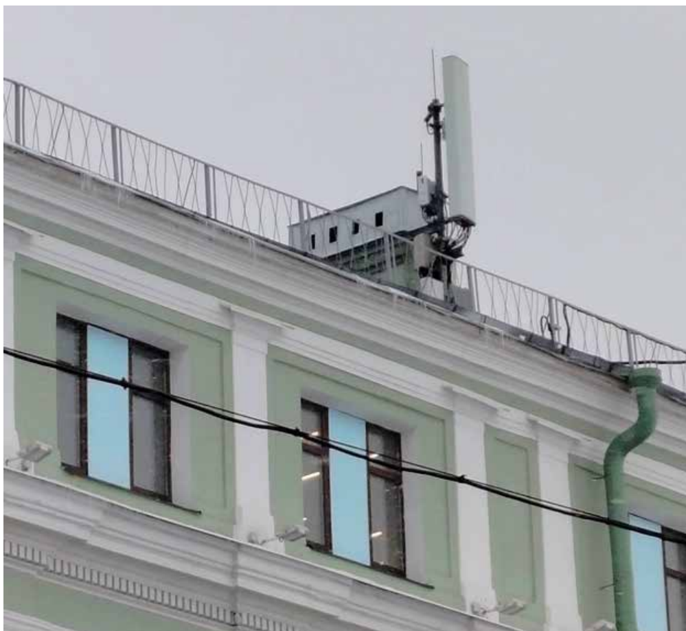
Фото 13. Фрагмент лицевого объекта культурного наследия федерального значения «Корпус служебный», входящего в состав объекта культурного наследия федерального значения «Мраморный дворец», антенна на здании
