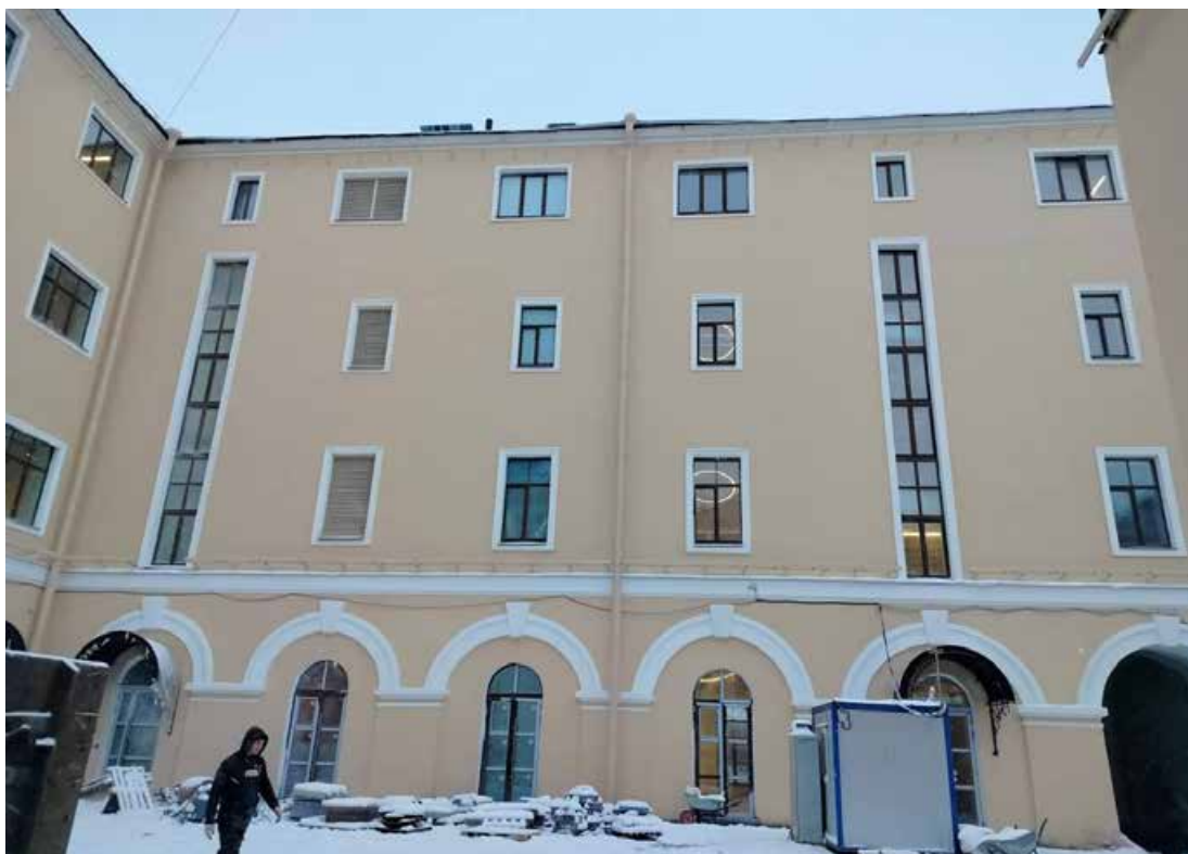
Фото 9. Фрагмент дворового фасада объекта культурного наследия федерального значения «Корпус служебный», входящего в состав объекта культурного наследия федерального значения «Мраморный дворец»
