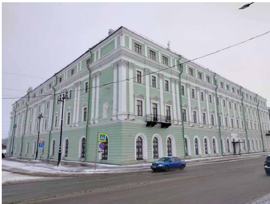
Фото 4. Лицевой фасад объекта культурного наследия федерального значения «Корпус служебный», входящего в состав объекта культурного наследия федерального значения «Мраморный дворец» (угол Миллионной ул. и Суворовской пл.)
