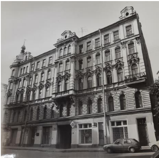
38. Архив КГИОП. П-672. Фото №2. Лицевой фасад по ул. Короленко. Фото О.В. Евдокимова 1995 г. На первом этаже располагался магазин «Гжель».
