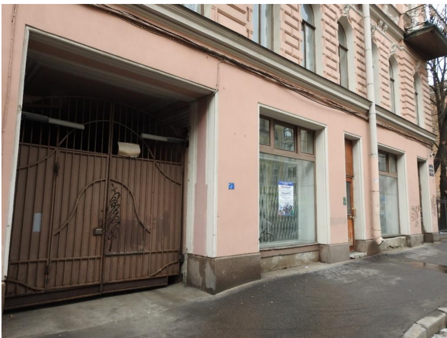
9. «Дом Н.В. Чайковского», ул. Короленко, д. 2, лит. А. Фрагмент фасада по ул. Короленко. Фото 05.04.2023г.
