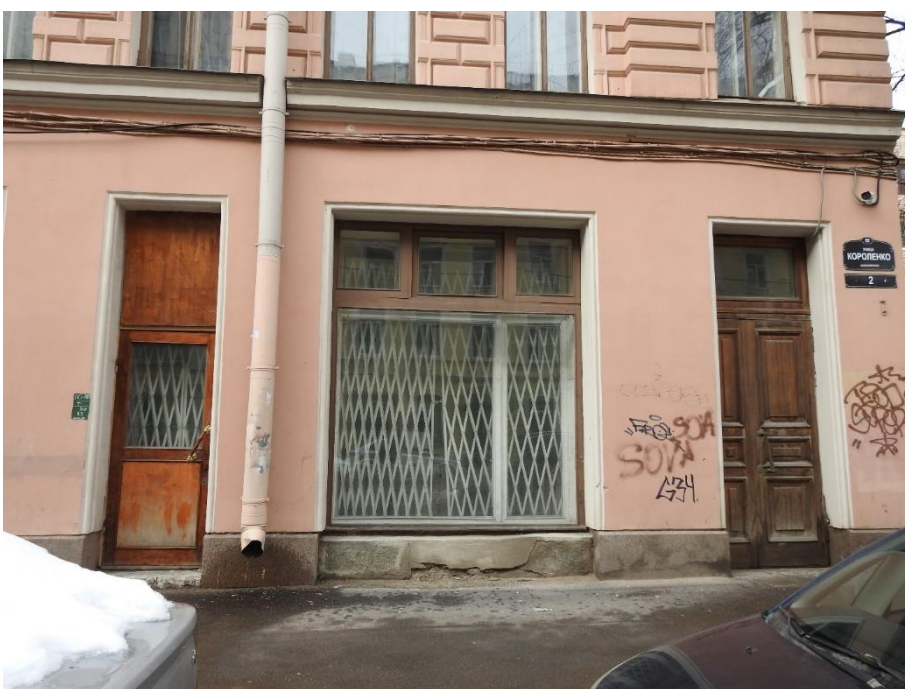
10. «Дом Н.В. Чайковского», ул. Короленко, д. 2, лит. А. Общий вид входной группы в помещения 1-Н. Фото 05.04.2023г.
