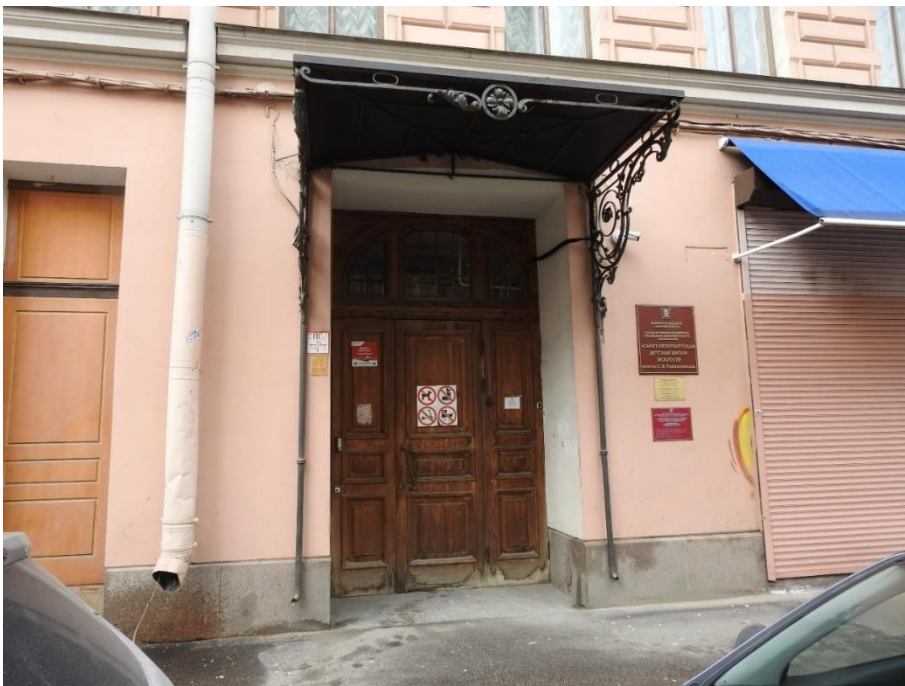
8. «Дом Н.В. Чайковского», ул. Короленко, д. 2, лит. А. Фрагмент фасада по ул. Короленко д. 2. Фото 05.04.2023г.
