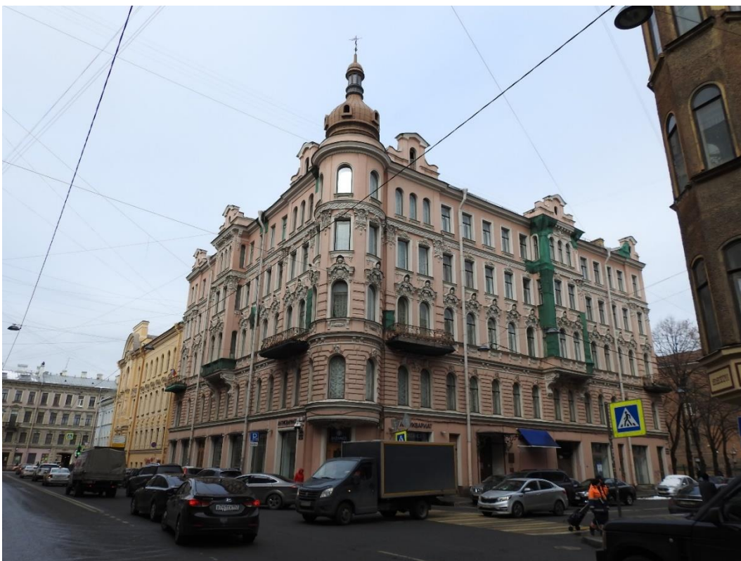
1. «Дом Н.В. Чайковского», ул. Короленко, д. 2, лит. А. Общий вид фасадов по ул. Некрасова д.4 и ул. Короленко д. 2. Фото 05.04.2023г.
