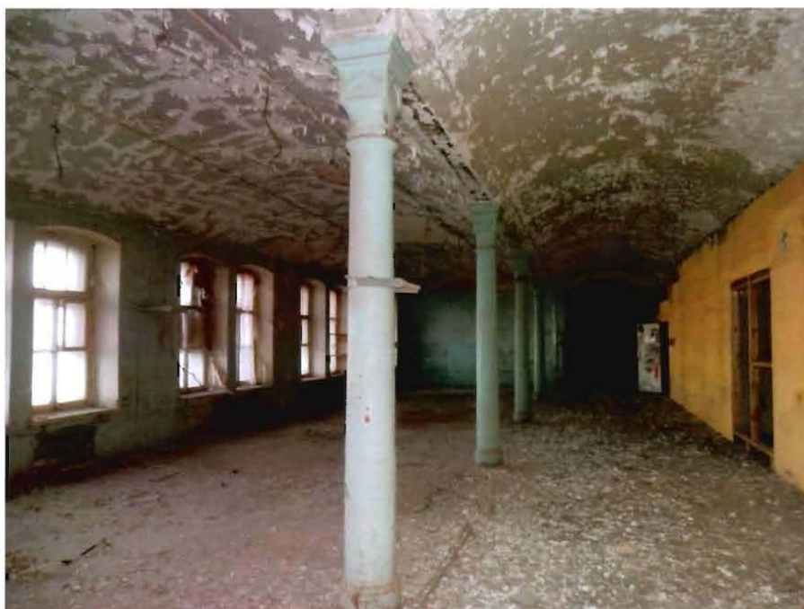
6. Чугунные колонны внутреннего каркаса.
