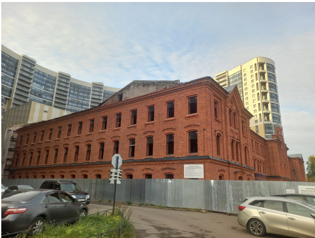
Фото 9. Западный фасад. Западный флигель. Главный фасад.
