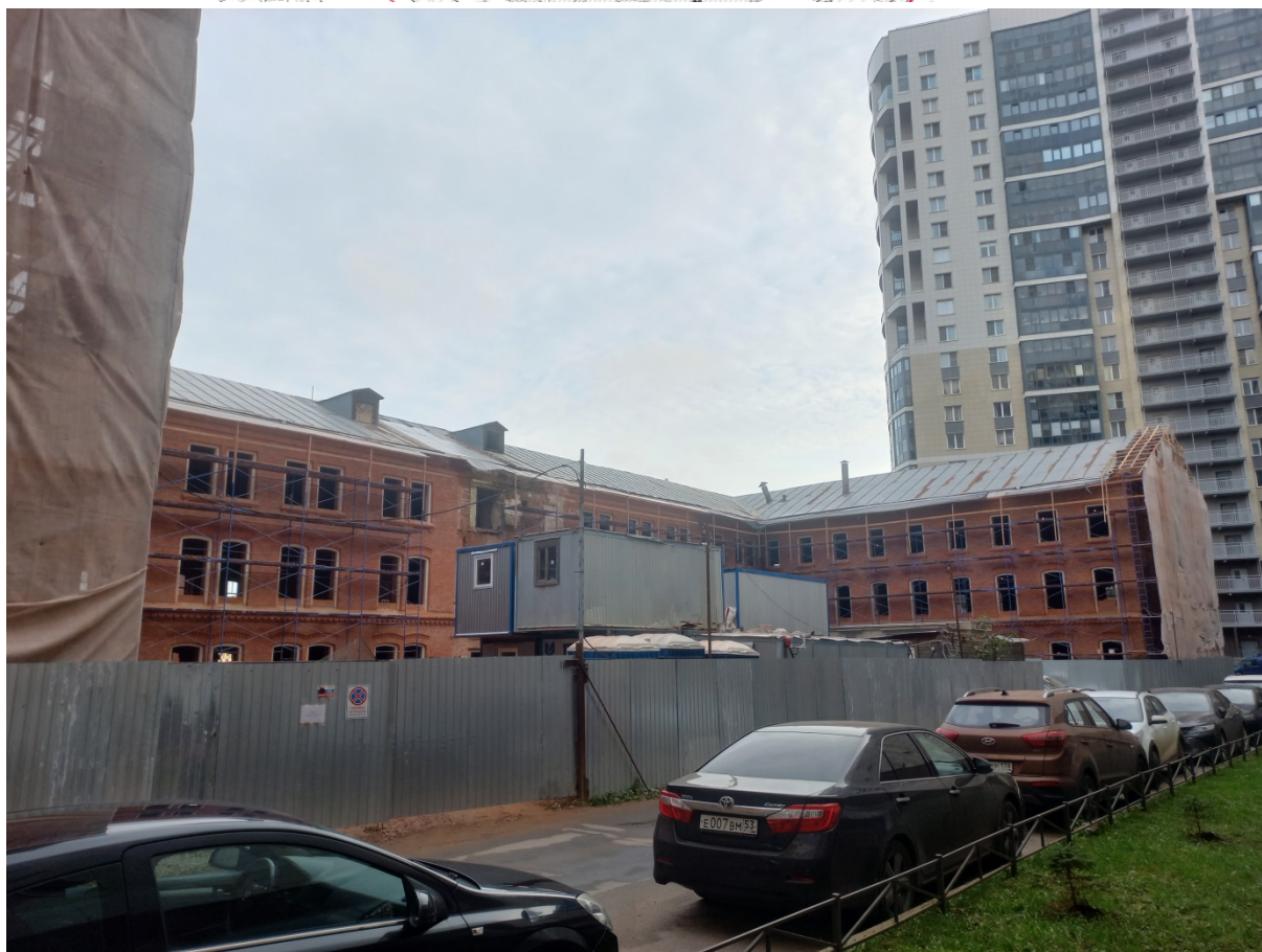
Фото 5. Южный фасад, восточный флигель.
