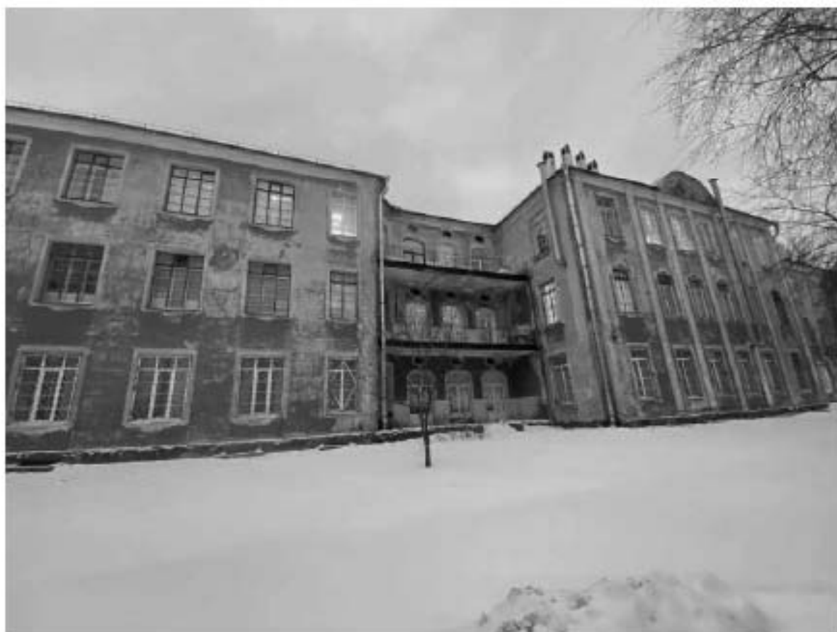
Фото №7. Фрагмент восточного фасада
