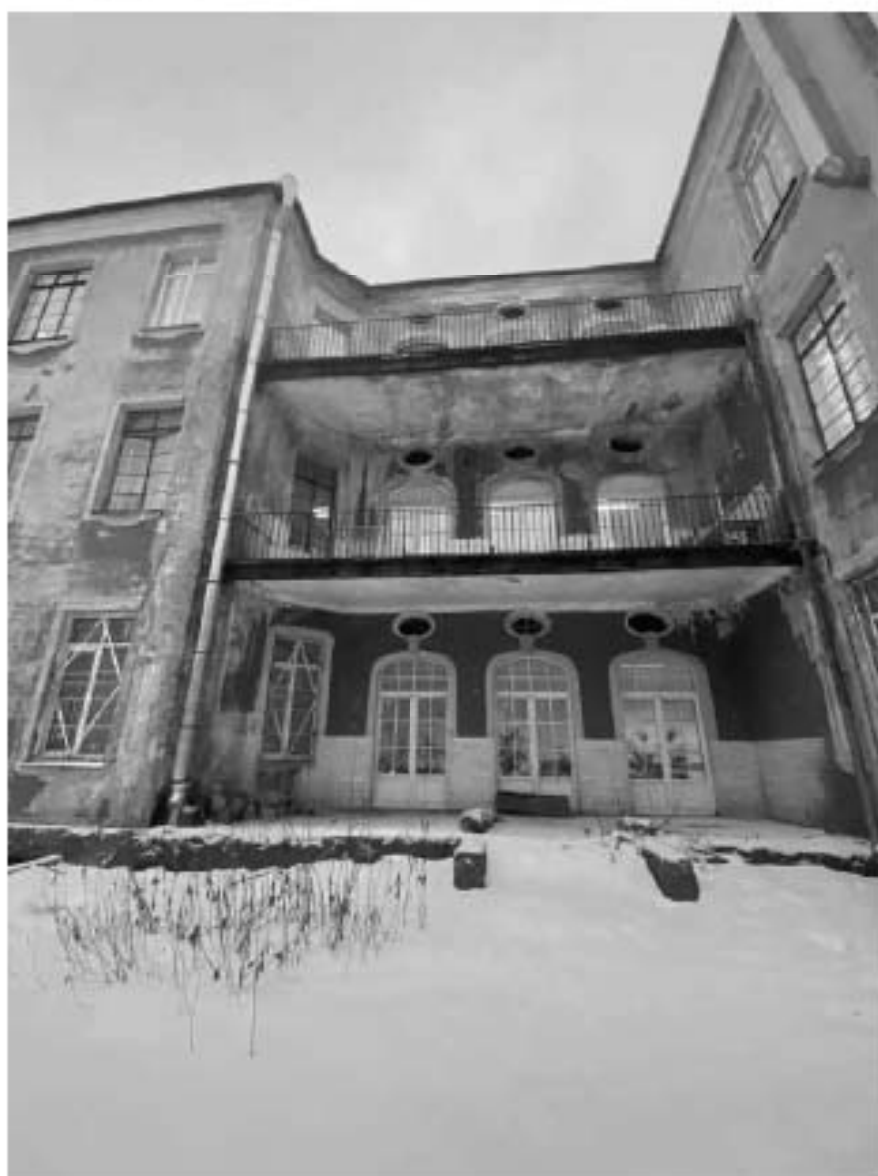
Фото №8. Фрагмент восточного фасада.
