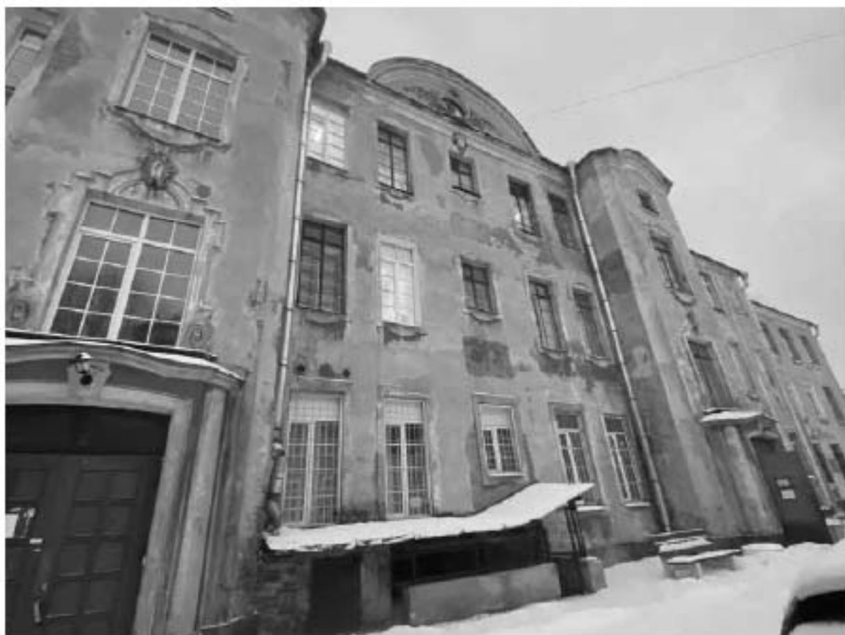
Фото №4. Фрагмент западного фасада.
