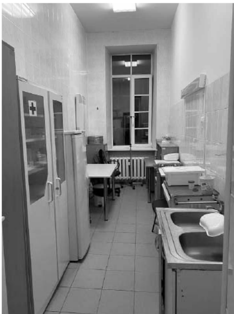
Фото №44. 2-ый этаж. Помещение 5-Н (3).
