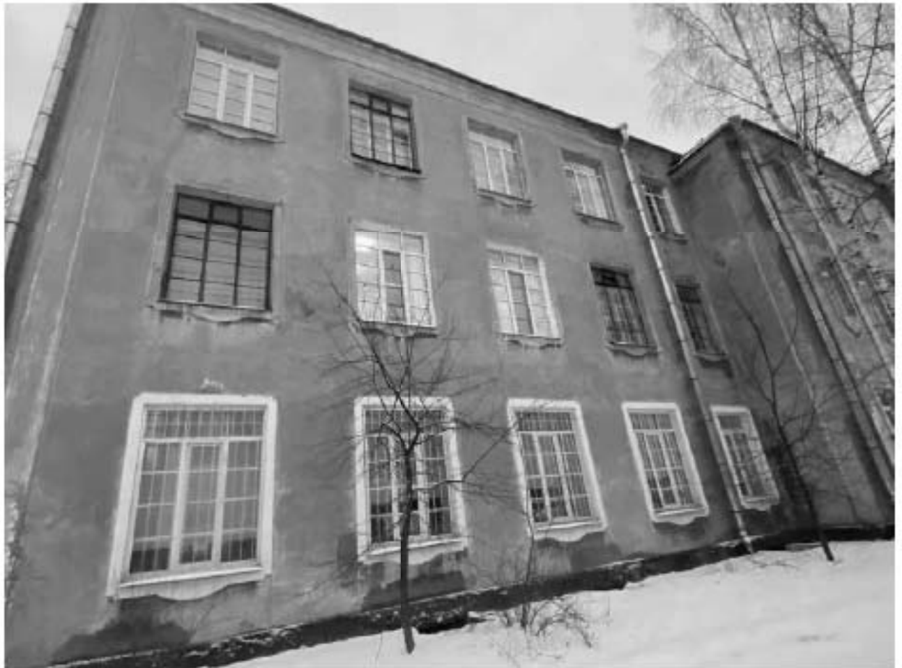
Фото №3. Фрагмент западного фасада.
