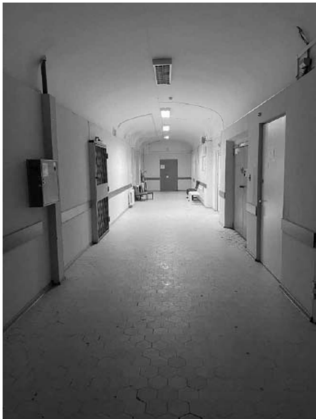
Фото №26. 1-ый этаж. Помещение 4-Н (17).
