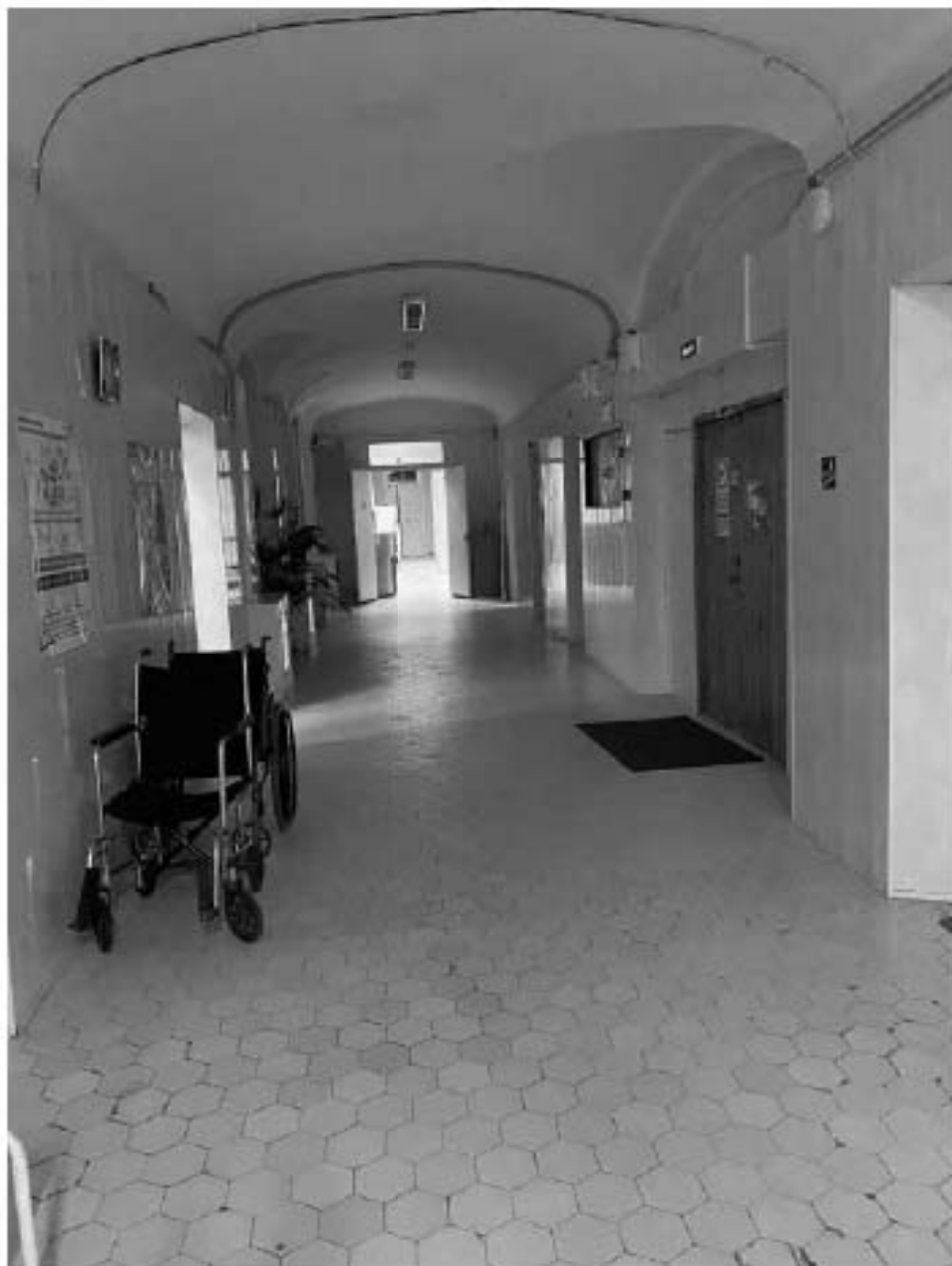
Фото №45. 2-ый этаж. Помещение 5-Н (17).
