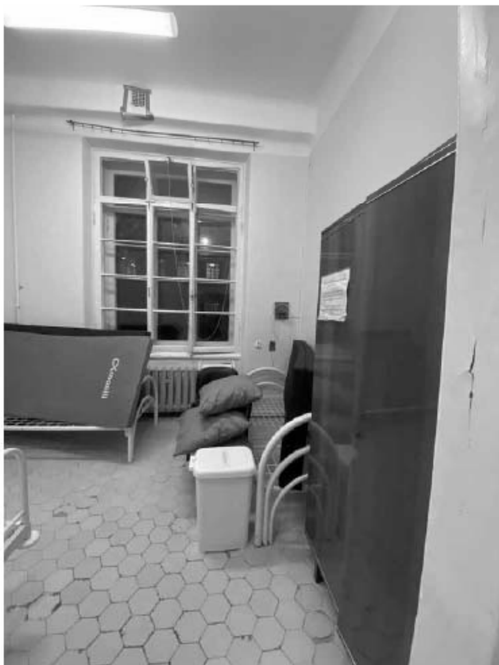
Фото №30. 2-ый этаж. Помещение 5-Н (14).
