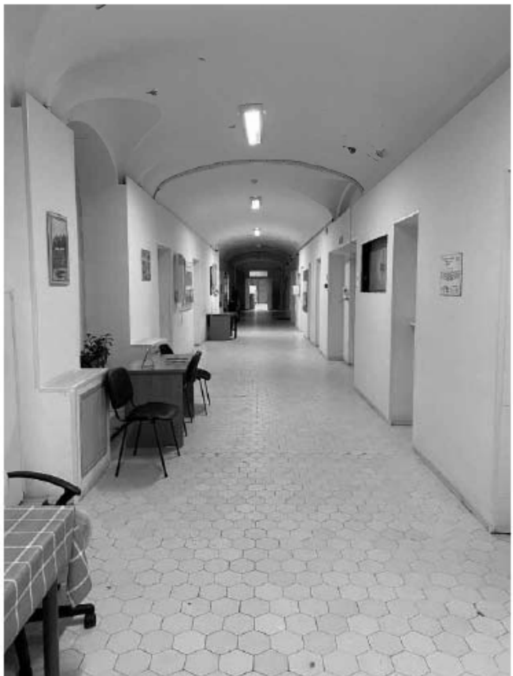
Фото №38. 2-ый этаж. Помещение 5-Н (17).
