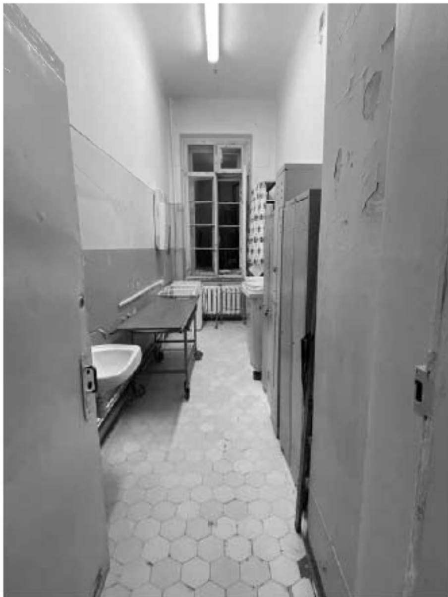
Фото №43. 2-ый этаж. Помещение 5-Н (4).
