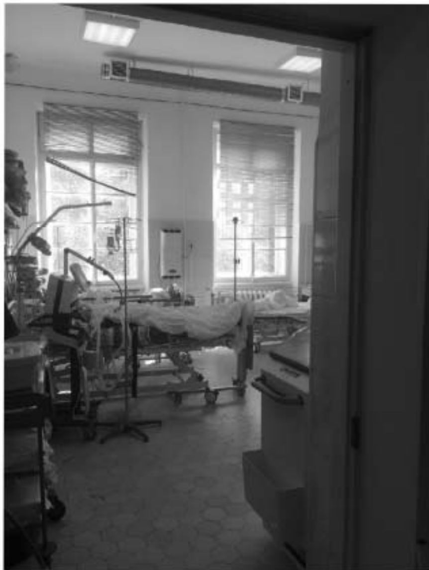
Фото №42. 2-ый этаж. Помещение 5-Н (19).
