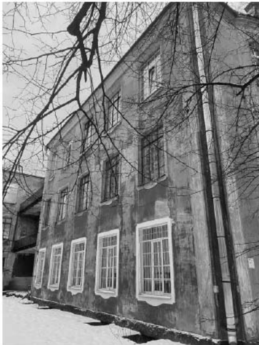
Фото №1. Фрагмент восточного фасада.
