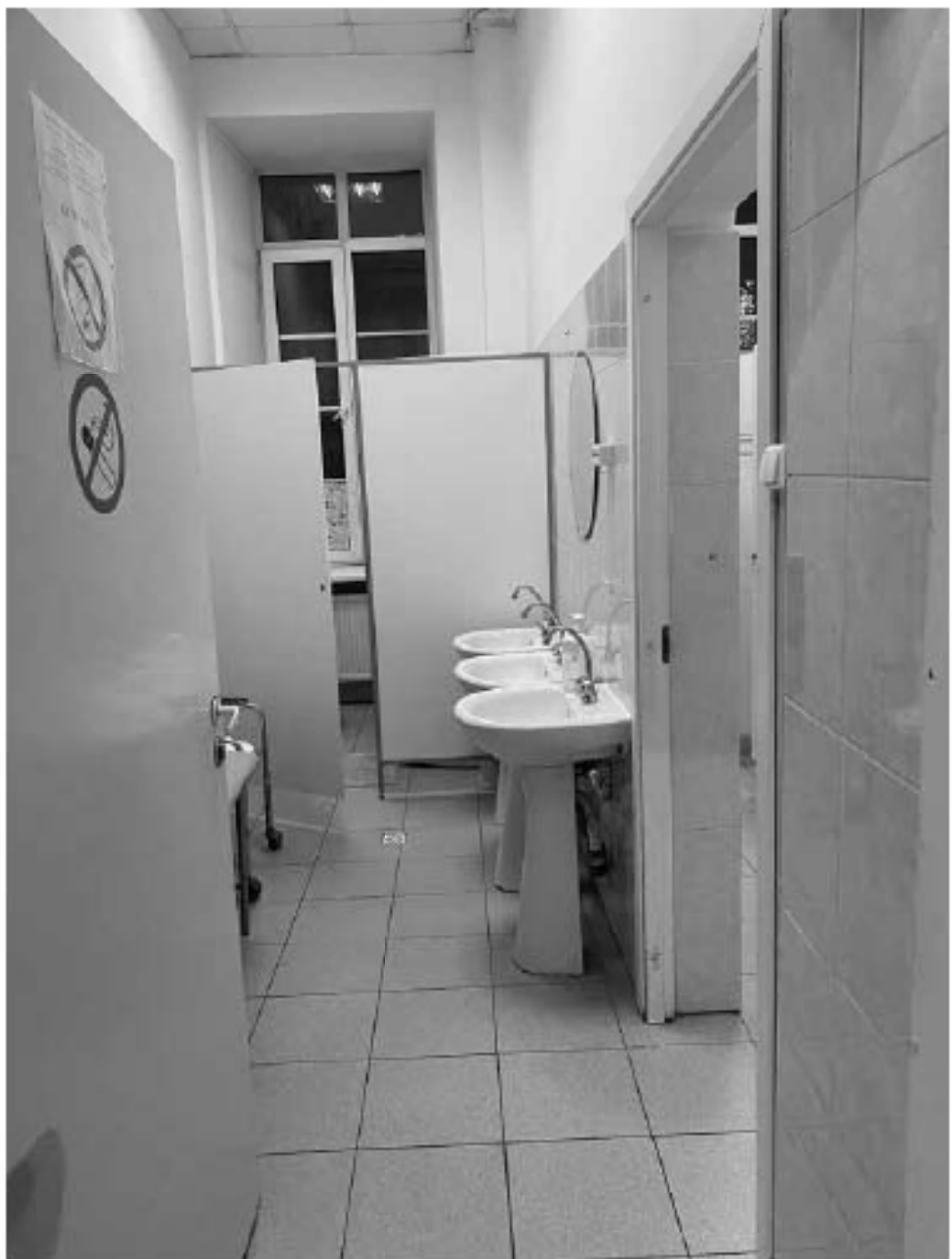
Фото №39. 2-ый этаж. Помещение 5-Н (6).
