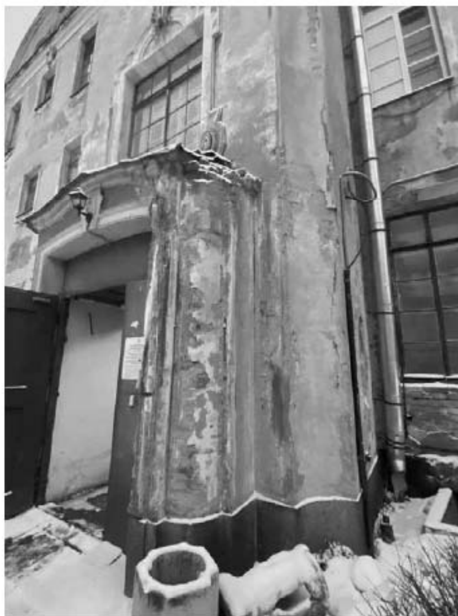
Фото №5. Фрагмент западного фасада, вход в помещение лестничной клетки.
