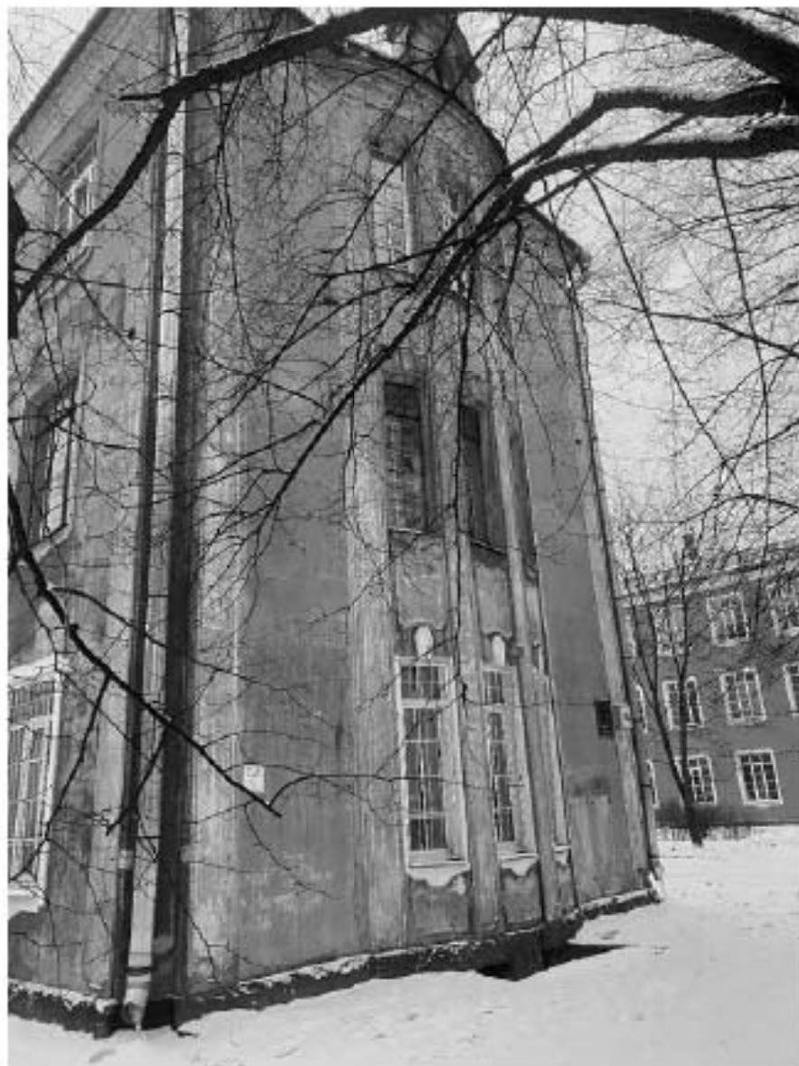
Фото №2. Северный фасад.
