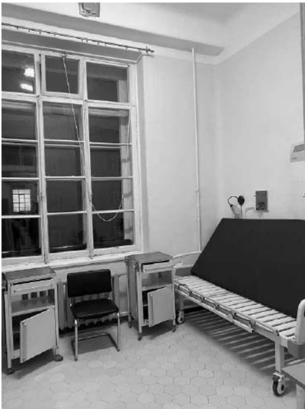
Фото №48. 2-ый этаж. Помещение 5-Н (24).
