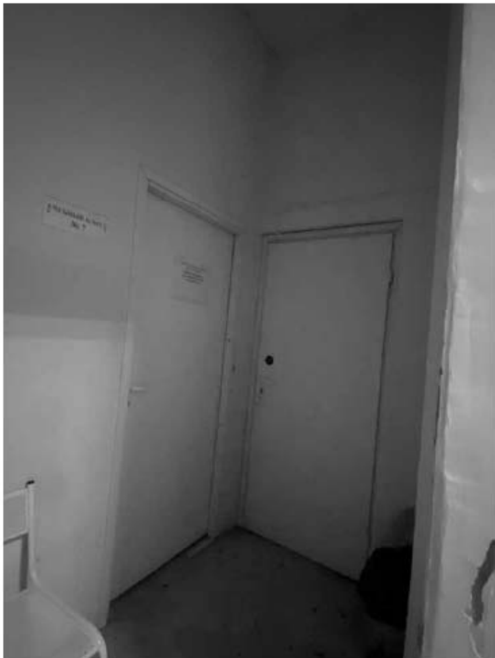
Фото №14. 1-ый этаж. Помещение 4-Н (22).
