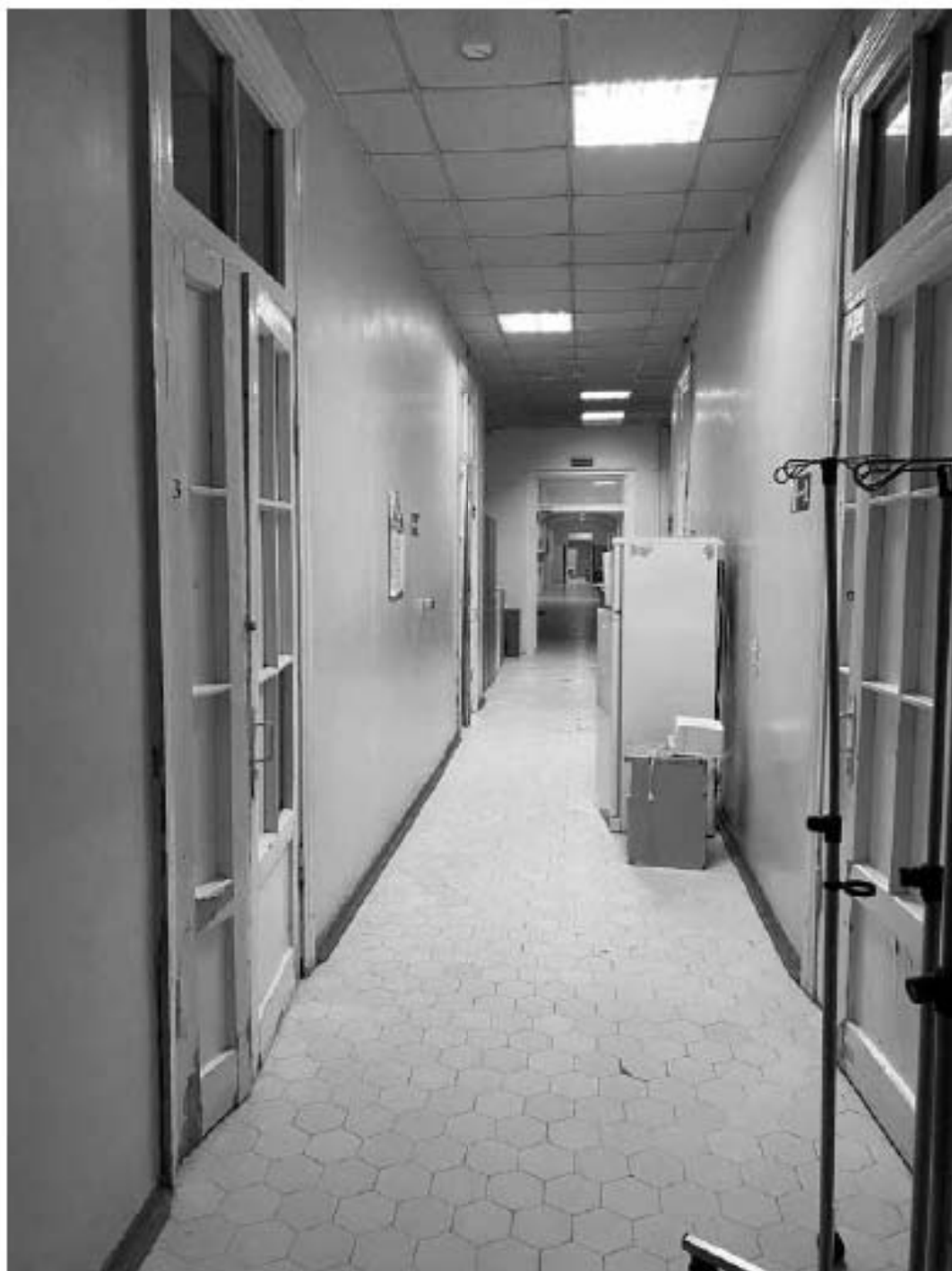
Фото №51. 2-ый этаж. Помещение 5-Н (22).
