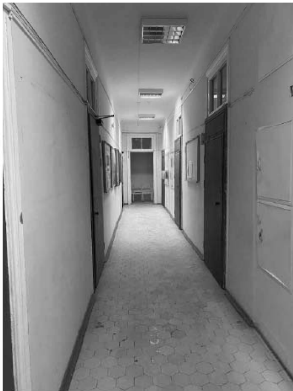
Фото №11. 1-ый этаж. Помещение 4-Н (29).
