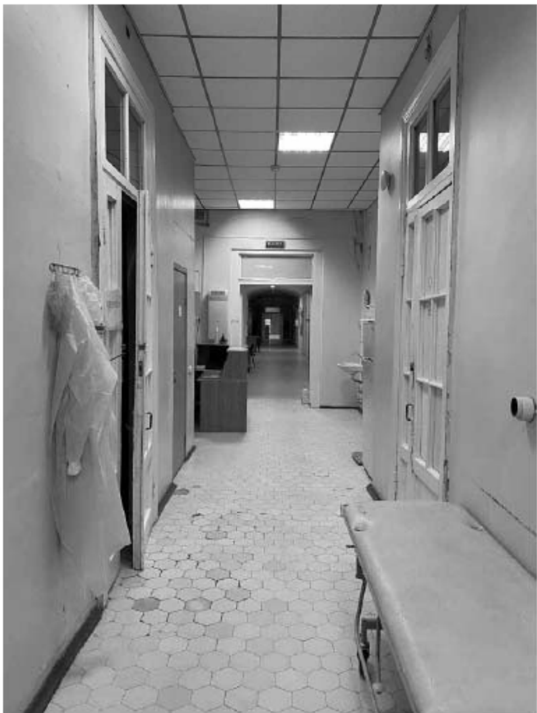
Фото №36. 2-ый этаж. Помещение 5-Н (16, 17).
