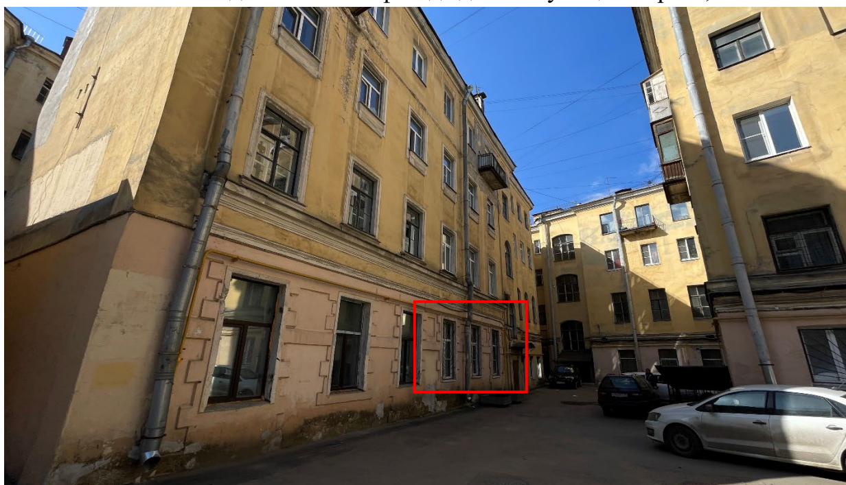
2. Вид на дворовой фасад здания и окна помещения;
