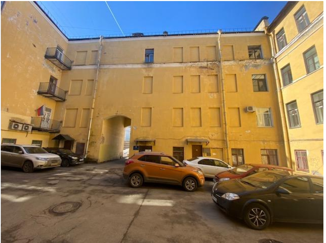
Фото 5. Объект культурного наследия регионального значения «Жилой дом», расположенный по адресу: Санкт-Петербург, город Ломоносов, Дворцовый проспект, д.40, лит.Б. Правый дворовый корпус. Восточный фасад.
