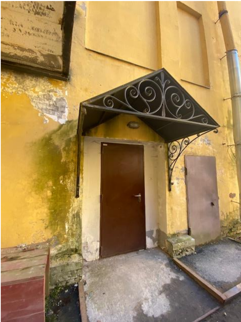
Фото 10. Объект культурного наследия регионального значения «Жилой дом», расположенный по адресу: Санкт-Петербург, город Ломоносов, Дворцовый проспект, д.40, лит.Б. Заполнение входного проема в помещение 20-Н.
