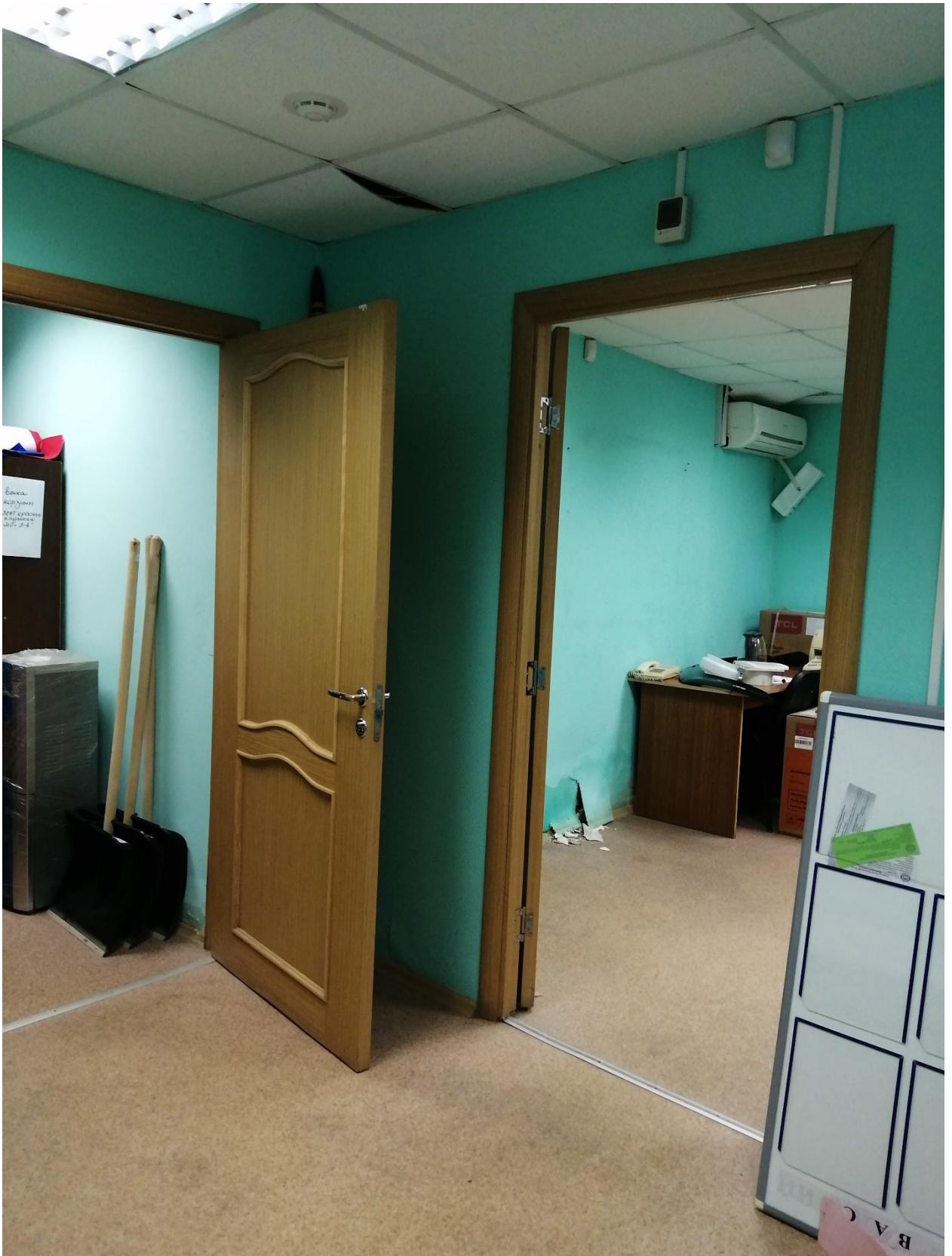
Фото 19. Объект культурного наследия регионального значения «Жилой дом», расположенный по адресу: Санкт-Петербург, город Ломоносов, Дворцовый проспект, д.40, лит.Б. Помещение 20-Н (4). Часть помещения отделена вновь устроенной перегородкой.
