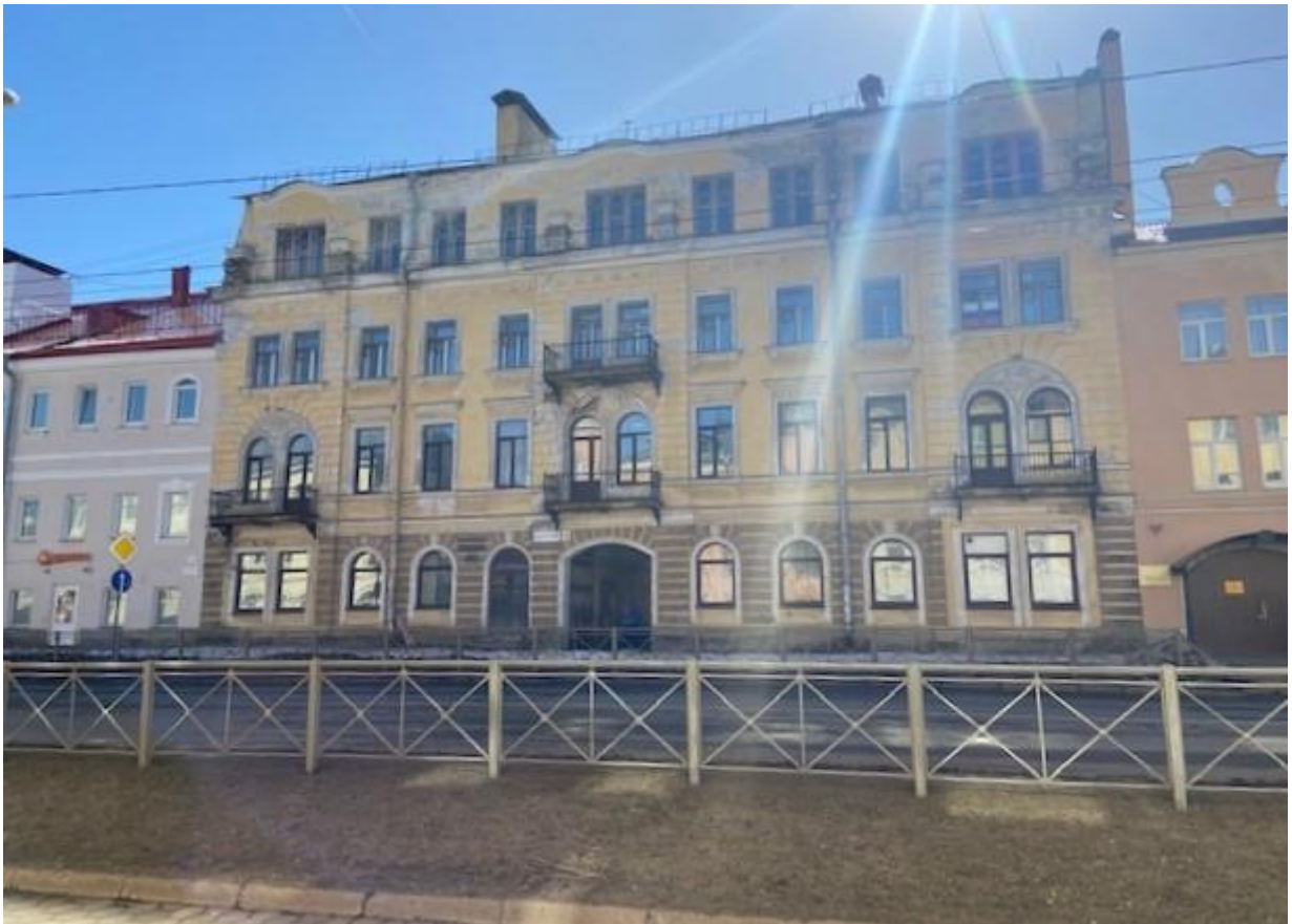
Фото 1. Объект культурного наследия регионального значения «Жилой дом», расположенный по адресу: Санкт-Петербург, город Ломоносов, Дворцовый проспект, д.40, лит.Б. Северный фасад лицевого корпуса.
