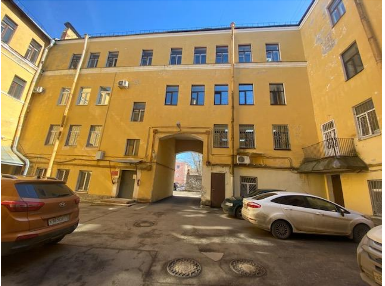
Фото 6. Объект культурного наследия регионального значения «Жилой дом», расположенный по адресу: Санкт-Петербург, город Ломоносов, Дворцовый проспект, д.40, лит.Б. Левый дворовый корпус. Западный фасад.
