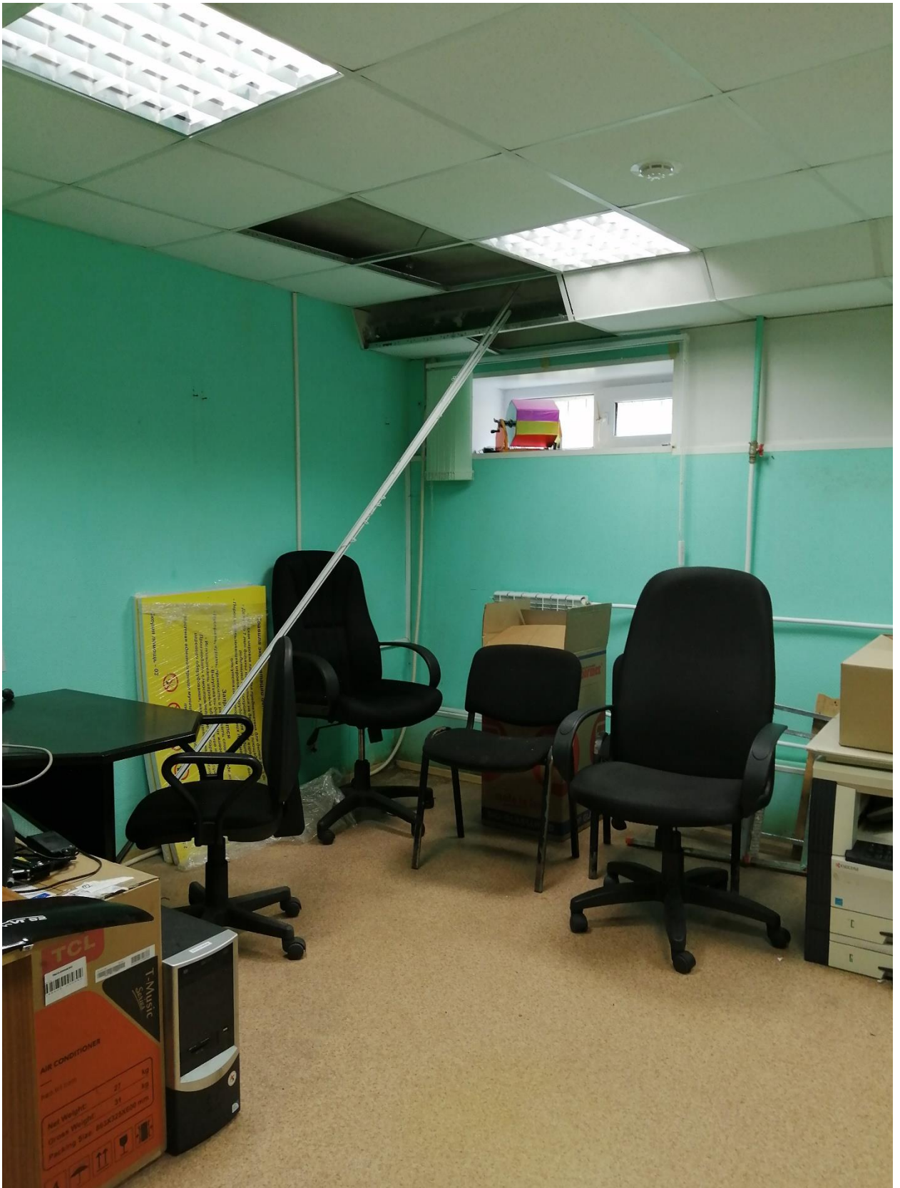
Фото 17. Объект культурного наследия регионального значения «Жилой дом», расположенный по адресу: Санкт-Петербург, город Ломоносов, Дворцовый проспект, д.40, лит.Б. Помещение 20-Н (4). Вновь устроенный оконный проем в капитальной стене.
