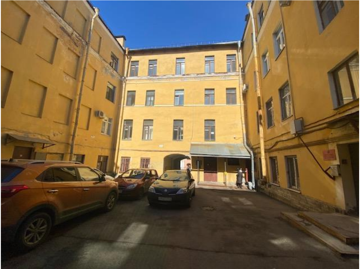
Фото 4. Объект культурного наследия регионального значения «Жилой дом», расположенный по адресу: Санкт-Петербург, город Ломоносов, Дворцовый проспект, д.40, лит.Б. Южный (дворовый) фасад лицевого корпуса.
