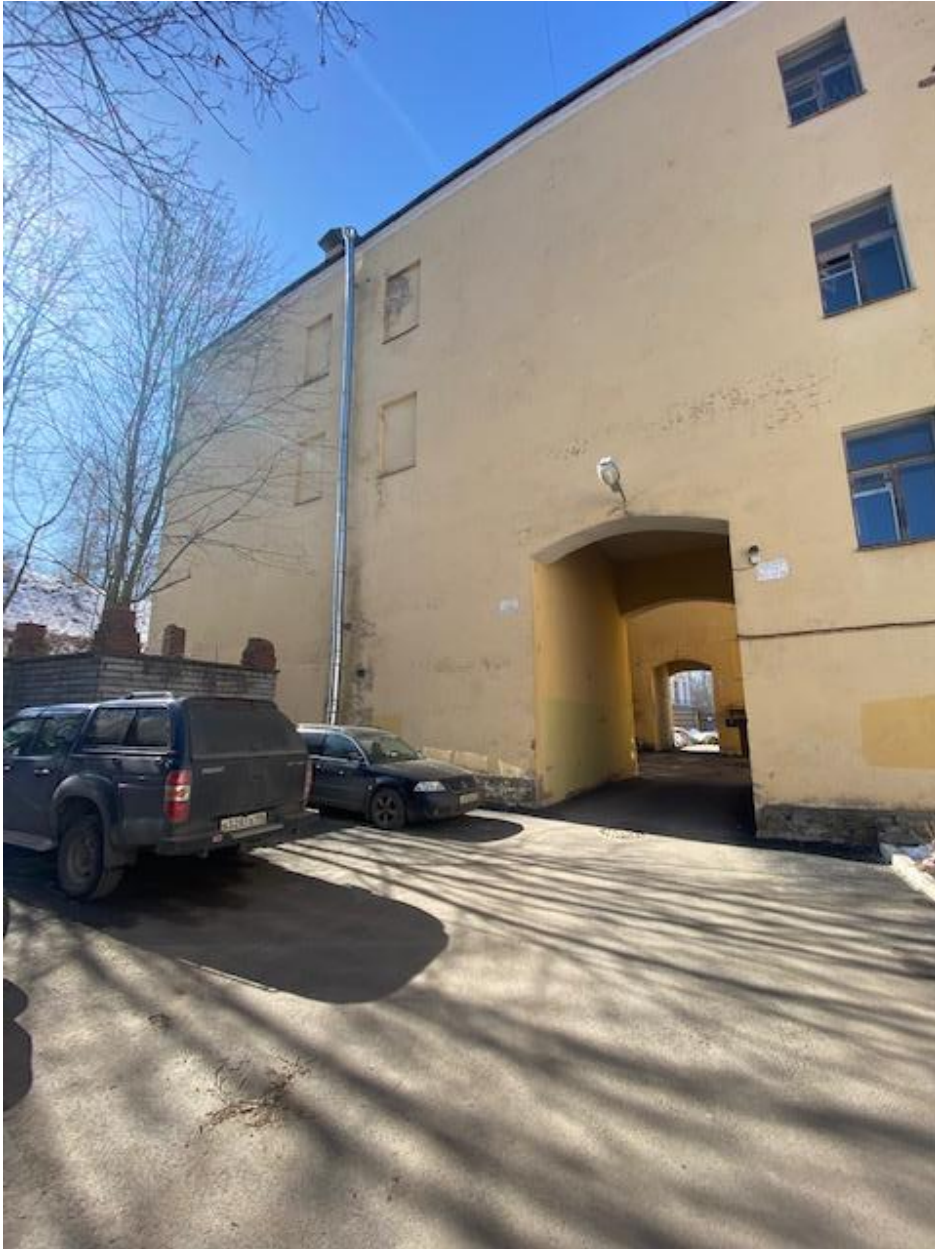
Фото 9. Объект культурного наследия регионального значения «Жилой дом», расположенный по адресу: Санкт-Петербург, город Ломоносов, Дворцовый проспект, д.40, лит.Б. Левый дворовый корпус, восточный фасад. Фрагмент.
