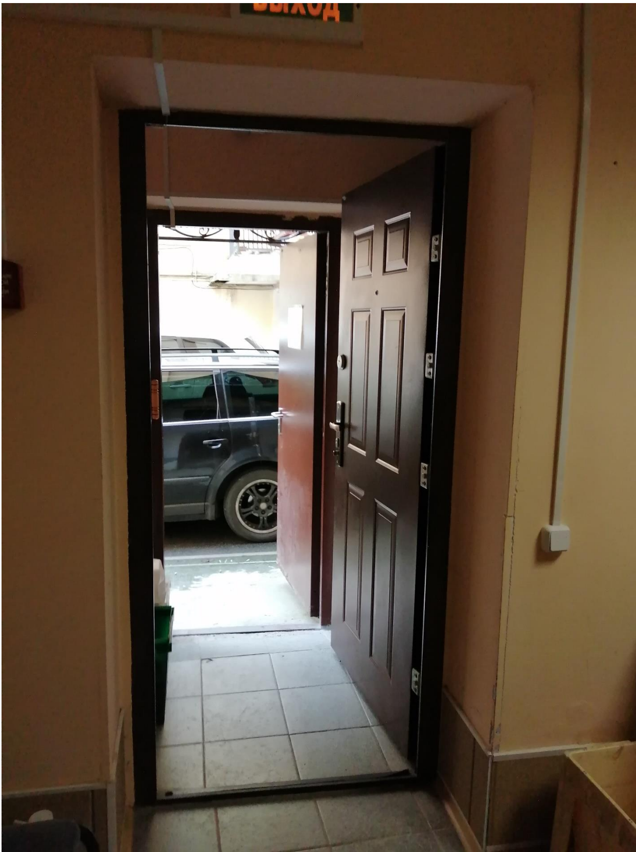
Фото 11. Объект культурного наследия регионального значения «Жилой дом», расположенный по адресу: Санкт-Петербург, город Ломоносов, Дворцовый проспект, д.40, лит.Б. Помещение 20-Н (2), заполнение проема между частью помещения 1 и частью помещения 2.
