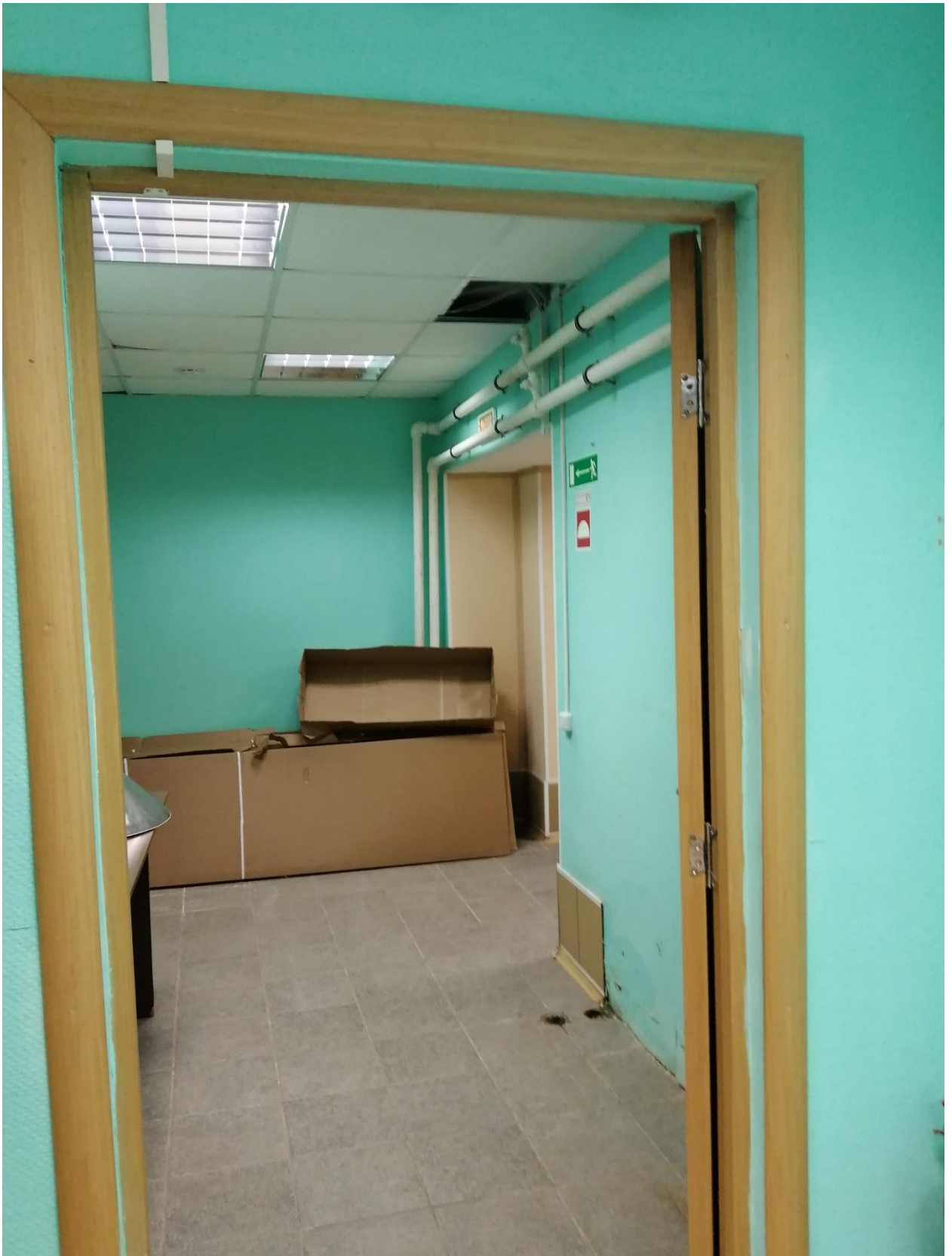
Фото 14. Объект культурного наследия регионального значения «Жилой дом», расположенный по адресу: Санкт-Петербург, город Ломоносов, Дворцовый проспект, д.40, лит.Б. Помещение 20-Н (3).
