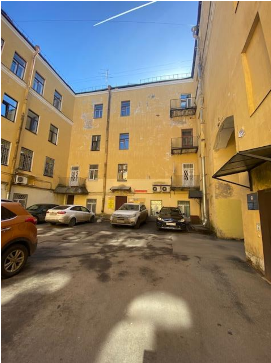
Фото 3. Объект культурного наследия регионального значения «Жилой дом», расположенный по адресу: Санкт-Петербург, город Ломоносов, Дворцовый проспект, д.40, лит.Б. Центральный дворовый корпус. Северный фасад.
