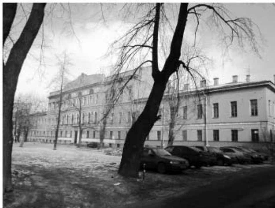
67. Бывший Николаевский дом призрения престарелых и увечных граждан Санкт-Петербургского купеческого общества. Общий вид здания. Фотография. 2010-е гг. www.citywalls.ru .
