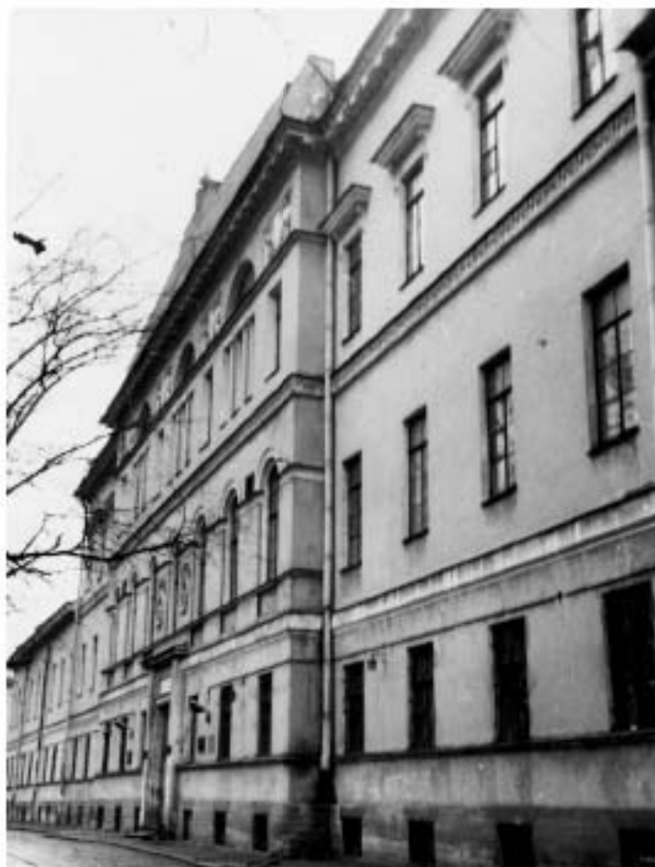
60. Бывший Николаевский дом призрения престарелых и увечных граждан Санкт-Петербургского купеческого общества. Главное здание (вид вдоль фасада). Фотография. 1995 г. Автор съемки: Андрей Агафонов. www.citywalls.ru
