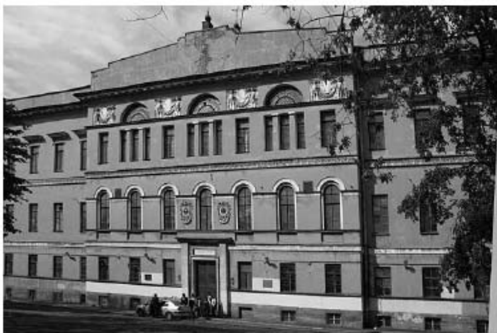
61. Бывший Николаевский дом призрения престарелых и увечных граждан Санкт-Петербургского купеческого общества. Общий вид главного здания. Фотография. 2000-е гг. www.citywalls.ru .
