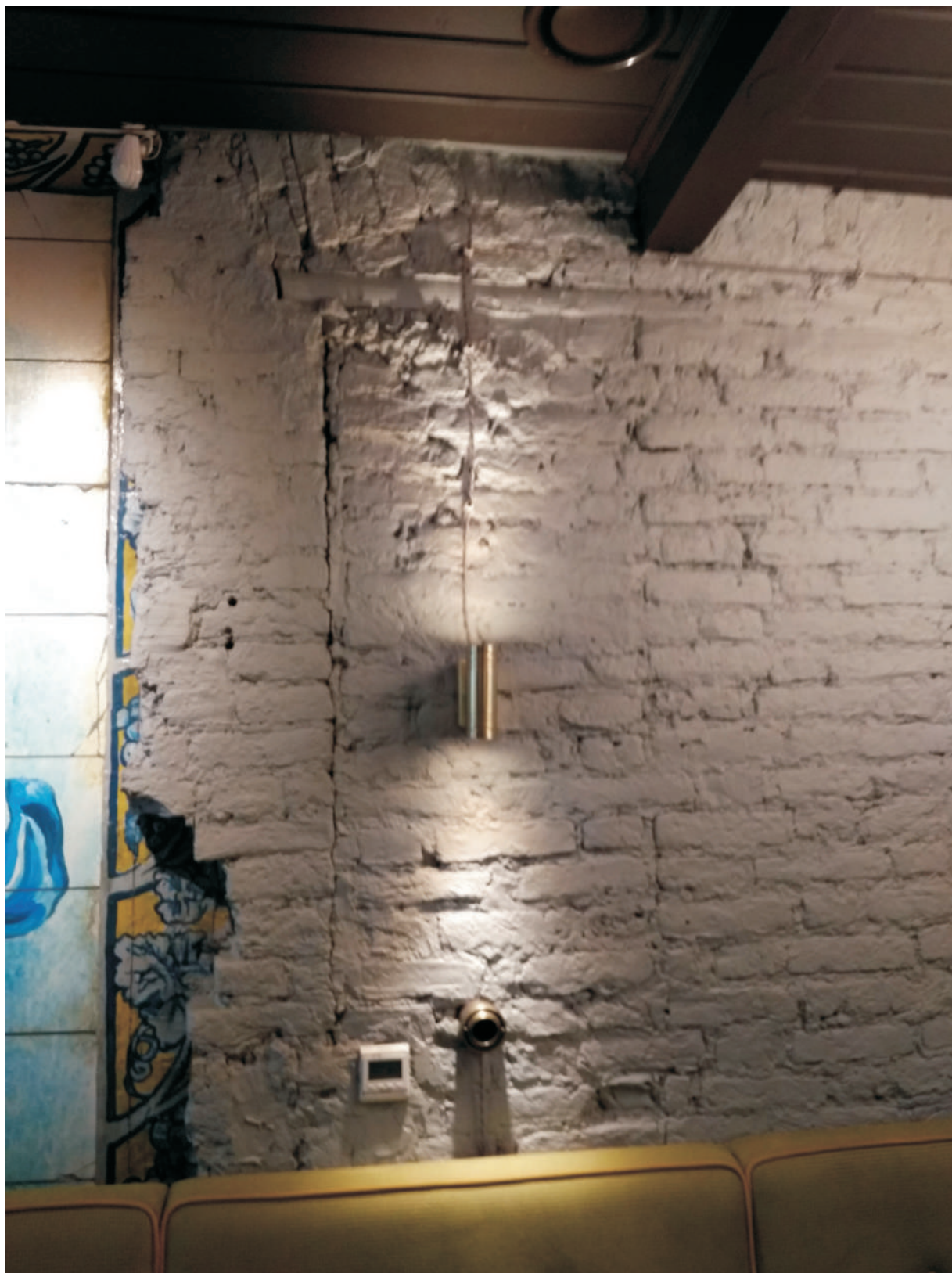
Ил. 79. Дом №20 по набережной реки Фонтанки. Помещение 1-Н. Фрагмент южной стены второго этажа с заложенными разновременными проемами с лучковой и прямой перемычками. Фотография 10.06.2021 г.
