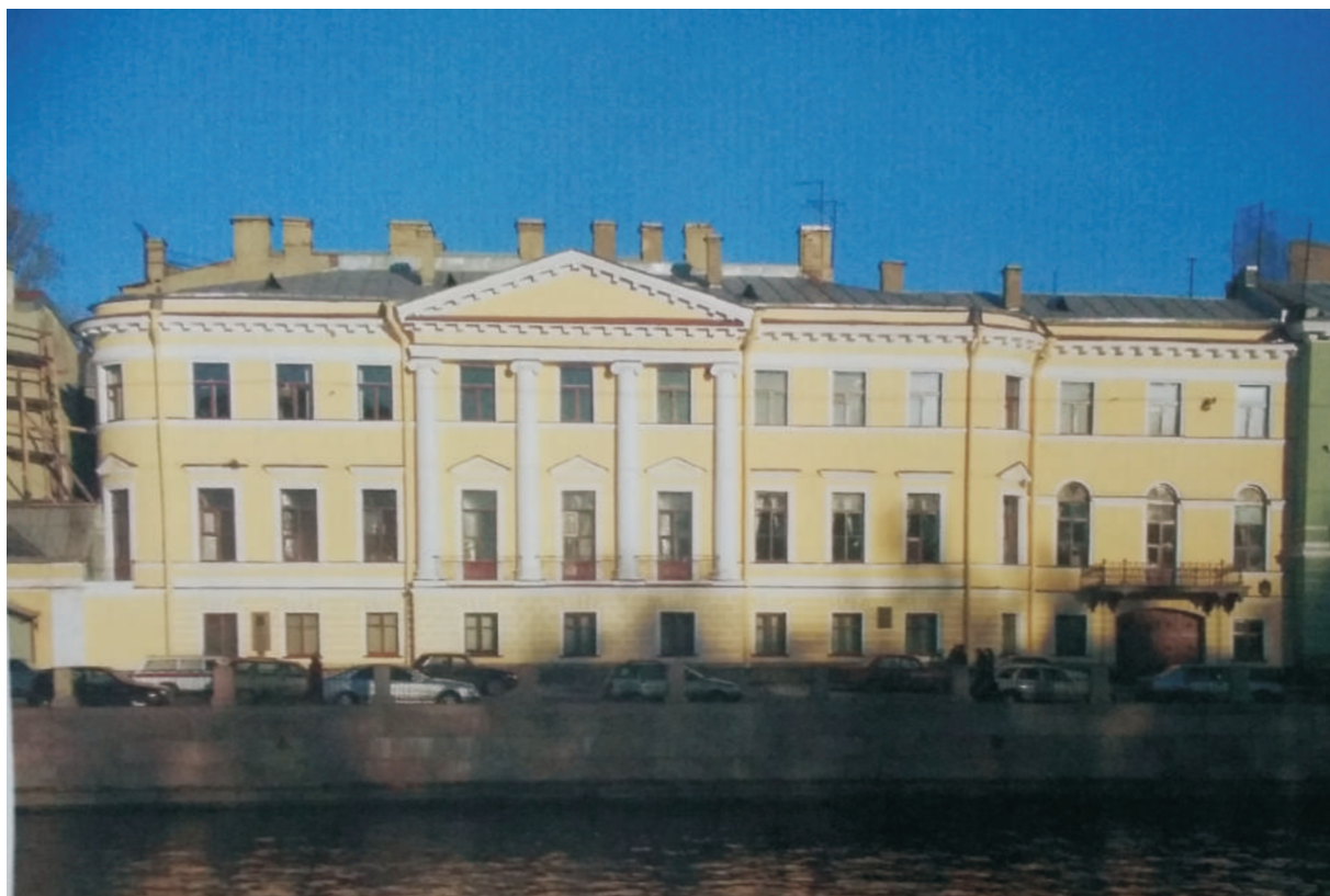
Ил. 63. Наб. р. Фонтанки, 20. Лицевой фасад после реставрации. Фото 2005 г. Опубл.: КГИОП. п.179. №-7799. Дом Неклюдова П.В. (Дом Министерства Императорского Двора «Дом Голицына») наб. р. Фонтанки, д. 20. Отчет о реставрации / РПНЦ «Специалист». СПб., 2005. Ил.3.
