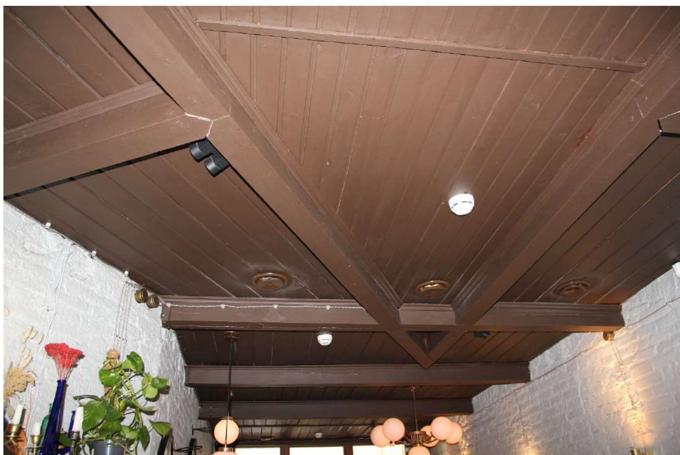
Фото№27: Вид на зашивку потолка деревянным сайдингом
