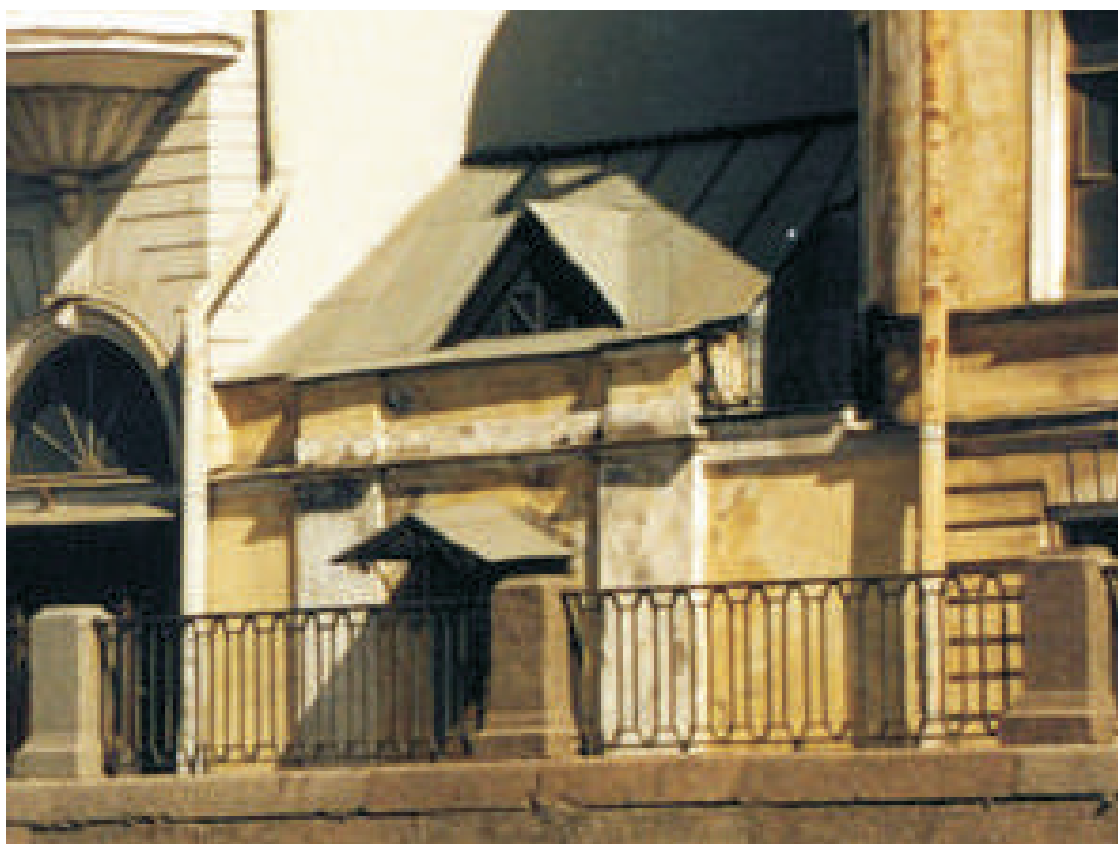
Фрагмент снимка с пристройкой у дома по адресу: наб. реки Фонтанки 20.
