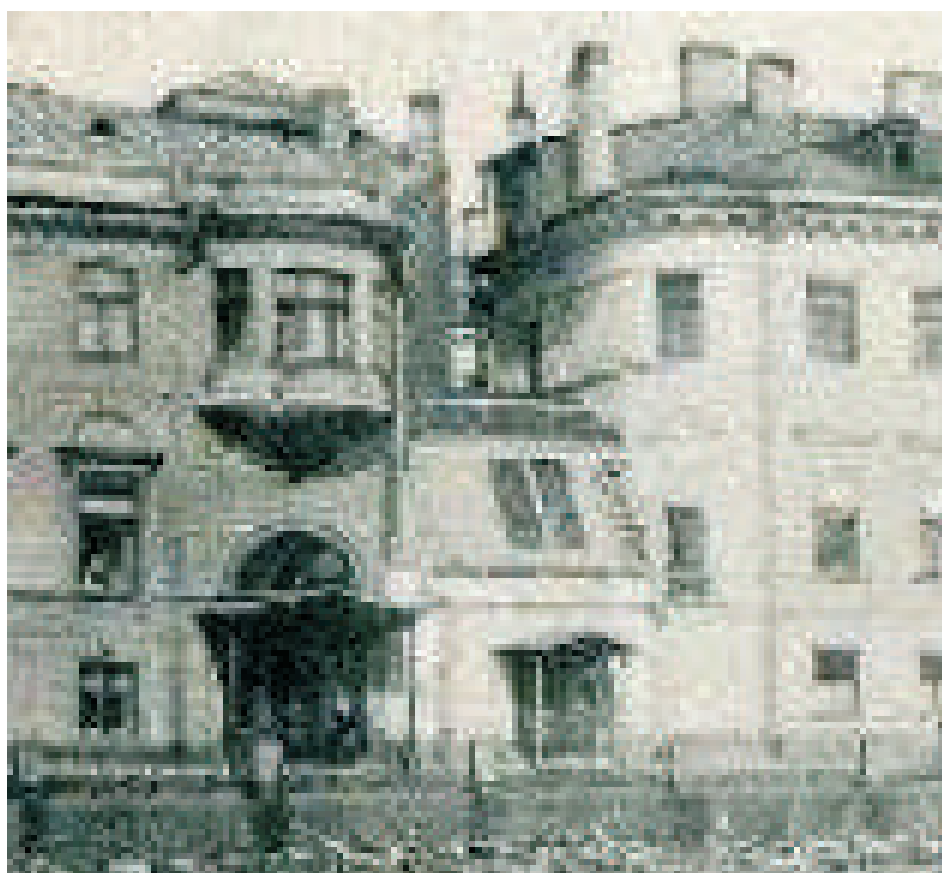
Фрагмент с одноэтажной пристройкой между домами №20 и №18.
