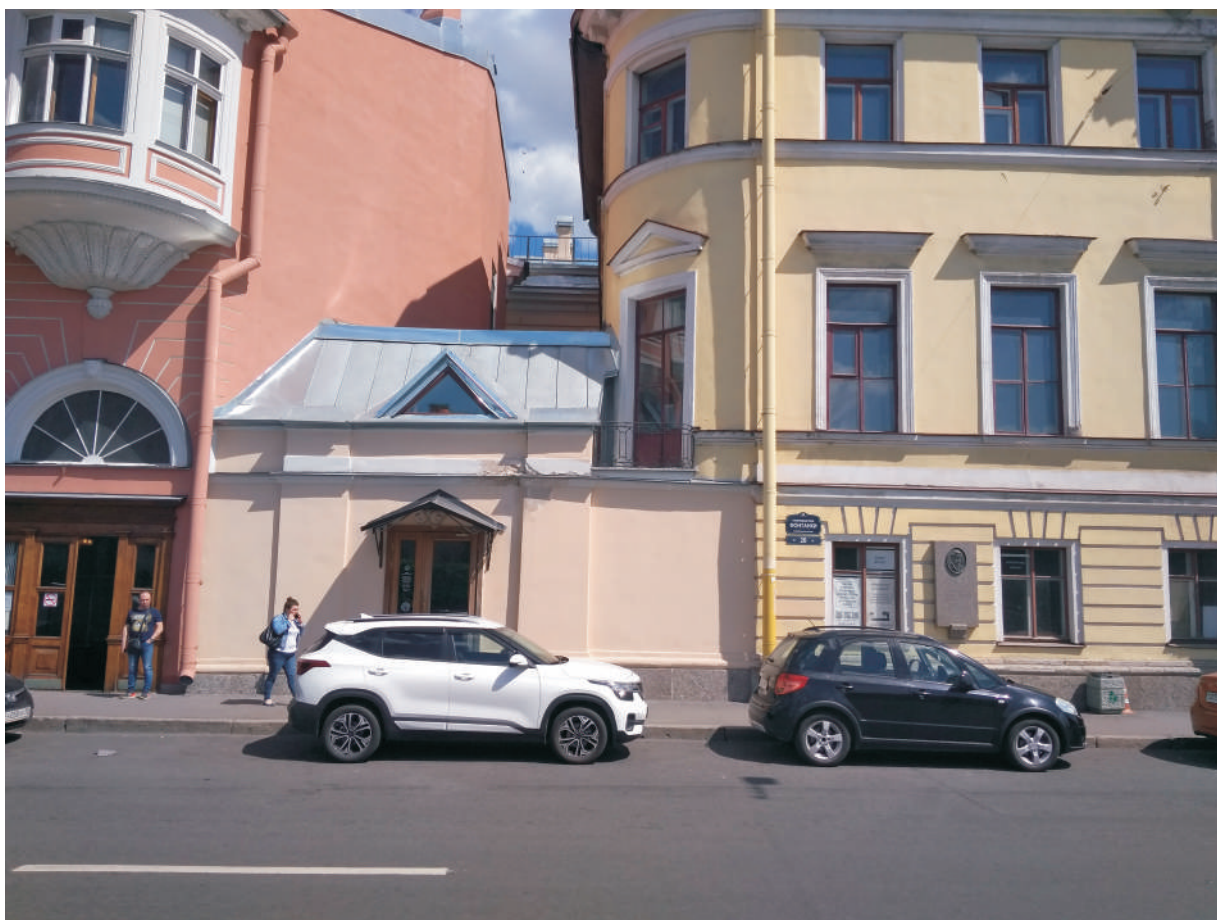
Ил. 73. Северная часть лицевого фасада дома №20 по набережной реки Фонтанки с рассматриваемой пристройкой между домами №20 и №18. Фотография 10.06.2021 г.
