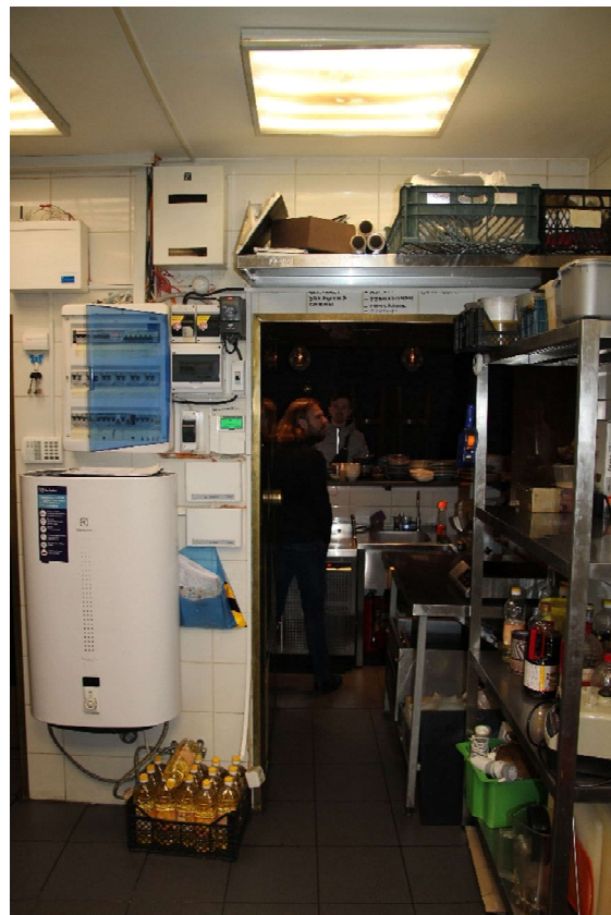
Фото№22: Вид дверного заполнения и Зал №2 со стороны кухни
