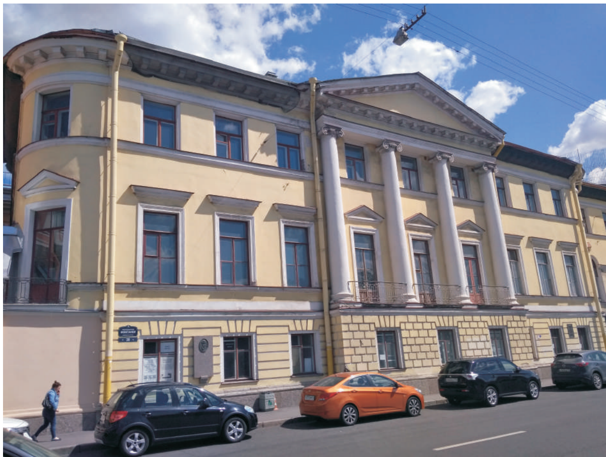
Ил. 72. Лицевой фасад дома №20 по набережной реки Фонтанки. Фотография 10.06.2021 г.
