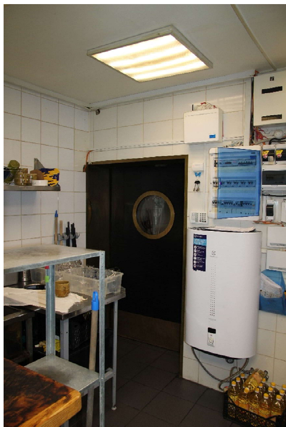
Фото№21: Вид дверного заполнения со стороны кухни
