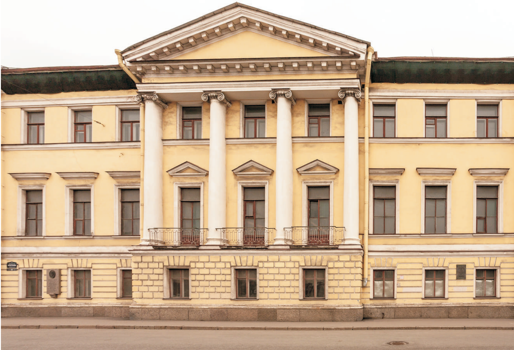
Ил. 66. Дом по адресу: Санкт-Петербург, наб. р. Фонтанки 20. Центральная часть лицевого фасада. Фото 2015-2016 гг. (?) Опубл.: Дом П. В. Неклюдова - Е. И. Вадковской - А. Н. Голицына (Санкт-Петербург, наб. Фонтанки, д. 20): альбом фотографий / Меленьтьев, А. М. СПб., 2016. (Святейший Синод в истории российской государственности).
