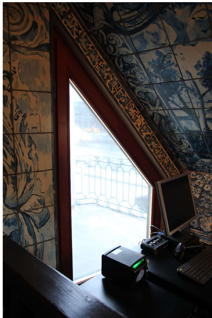
Фото№29: Вид на оконное заполнение проема на втором этаже
