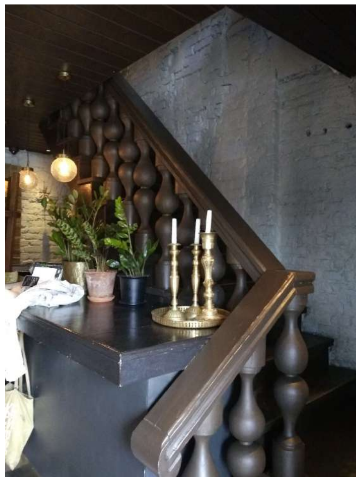
Фото№5: Фрагмент лестницы на первом этаже
