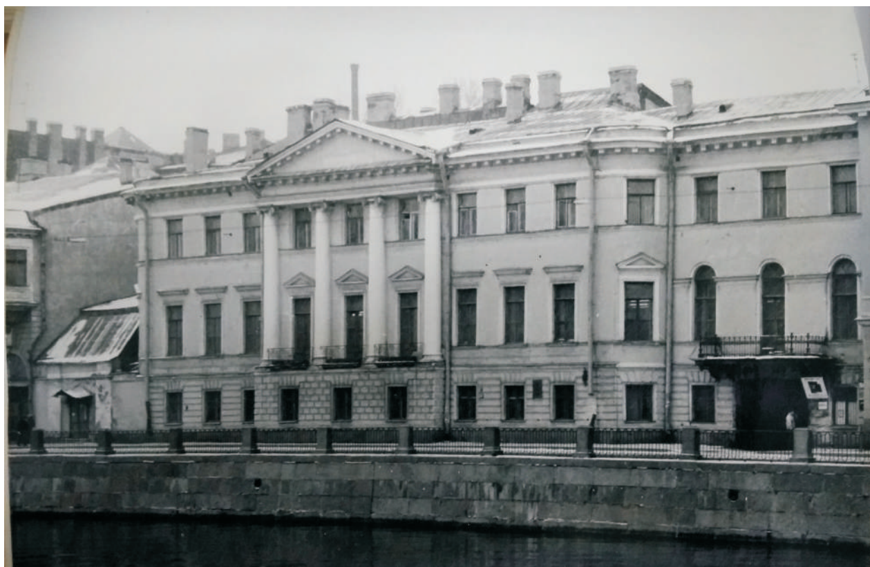
Ил. 58. Дом Голицына (Дом Министерства Императорского Двора). Общий вид фасада. Фото 1992 г. Автор снимка: В.Ф. Егоровский.
