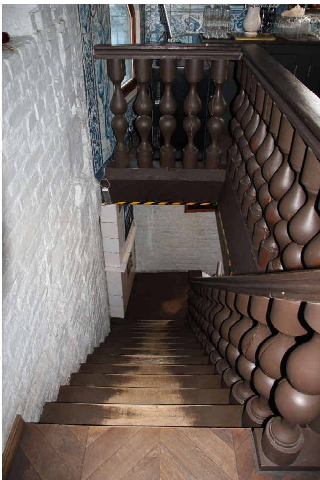
Фото№23: Вид лестницы со второго этажа
