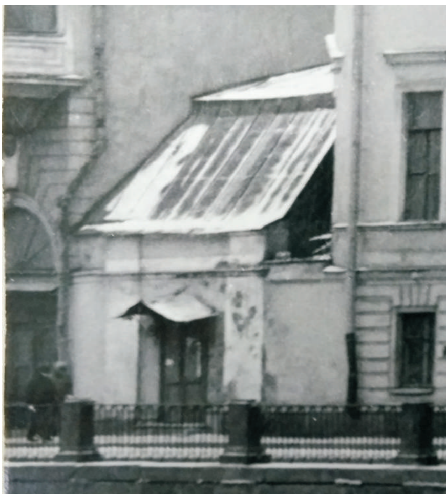
Фрагмент с одноэтажной постройкой между домами №20 и №18.
