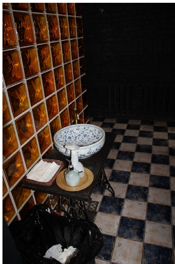
Фото№17: Фрагмент стены из стеклоблоков со стороны санузлов
