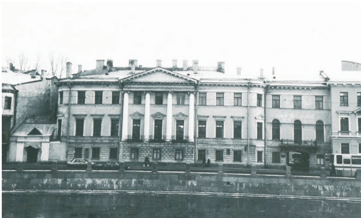
Ил. 59. Здание по адресу: набережная реки Фонтанки, 20. Фотография 1995 г. Автор снимка: Андрей Агафонов. Опубликован на сайте: https://sobory.ru/photo/267532
