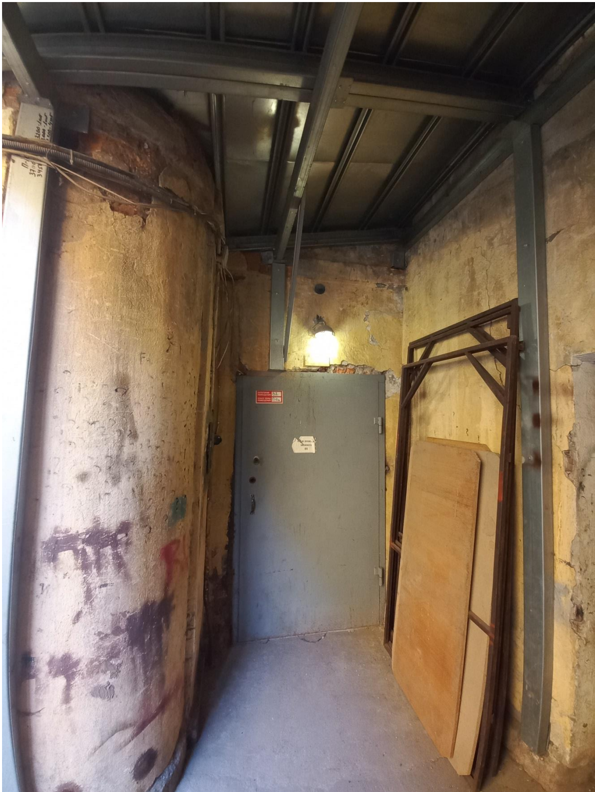
Фото 3. Здание литер Б. Северная часть дворовой территории. Вход в пом. №8 по проектной экспликации.
