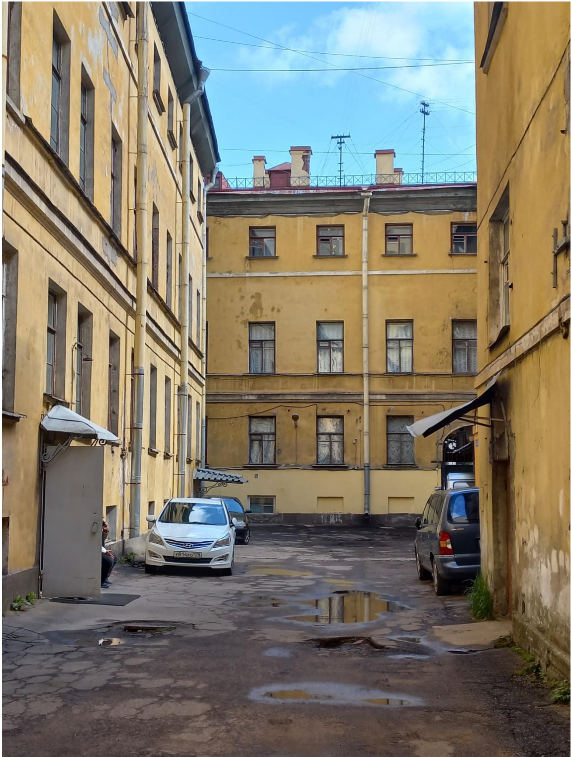
Фото 6. Территория внутреннего двора. Южная часть.
