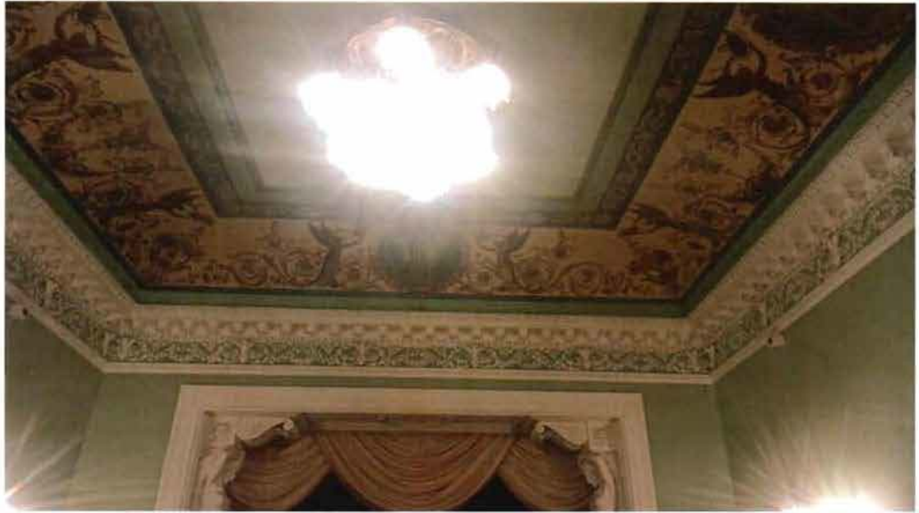
2. Помещение 2-го этажа (16-Н).
