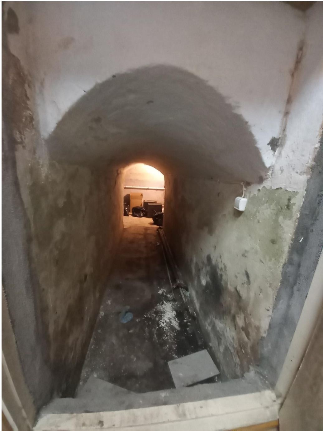
Фото 11. Вход в помещение 10.
