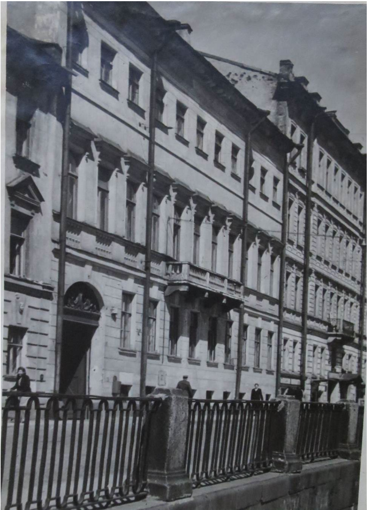
21. Дом Ильиных - О.А. Кочневой. Главный фасад. Вид вдоль набережной реки Фонтанки. Фотография. 1940-е гг. Архив КГИОП. Инв. № 17727.
