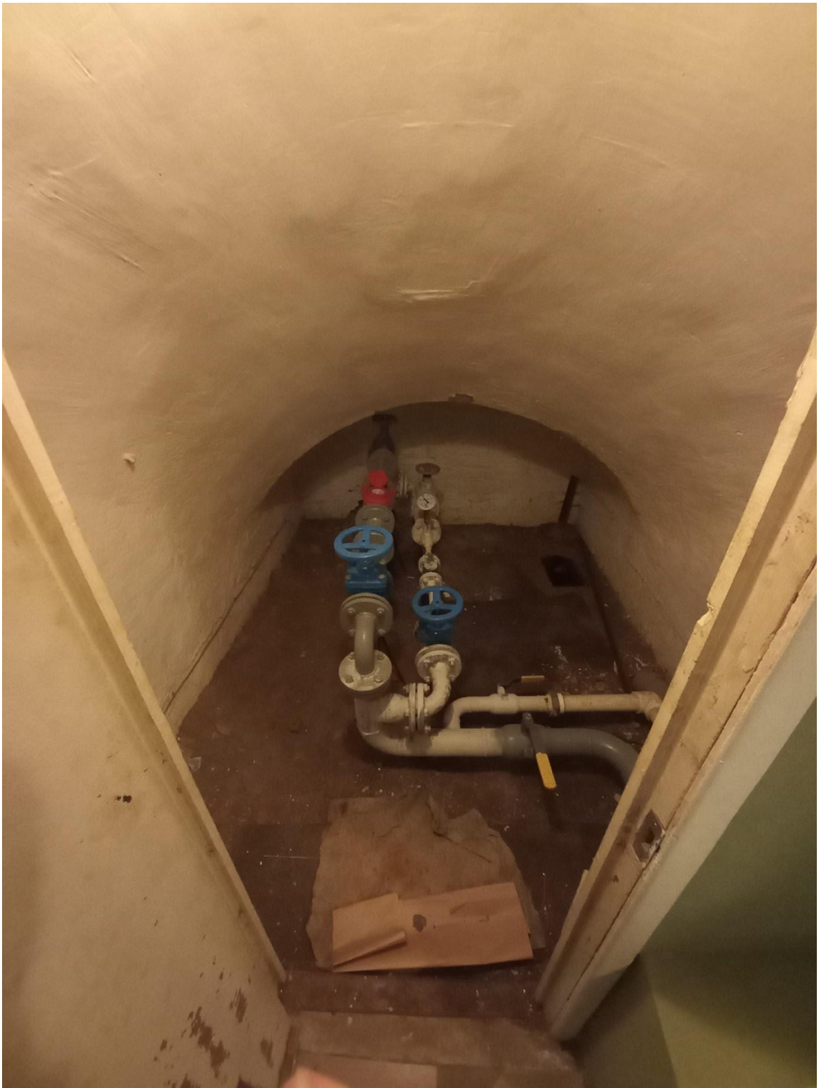
Фото 4. Помещение 6. Водомерный узел.
