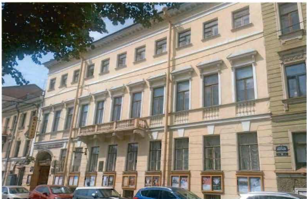
1. Вид на лицевой фасад объекта культурного наследия.
