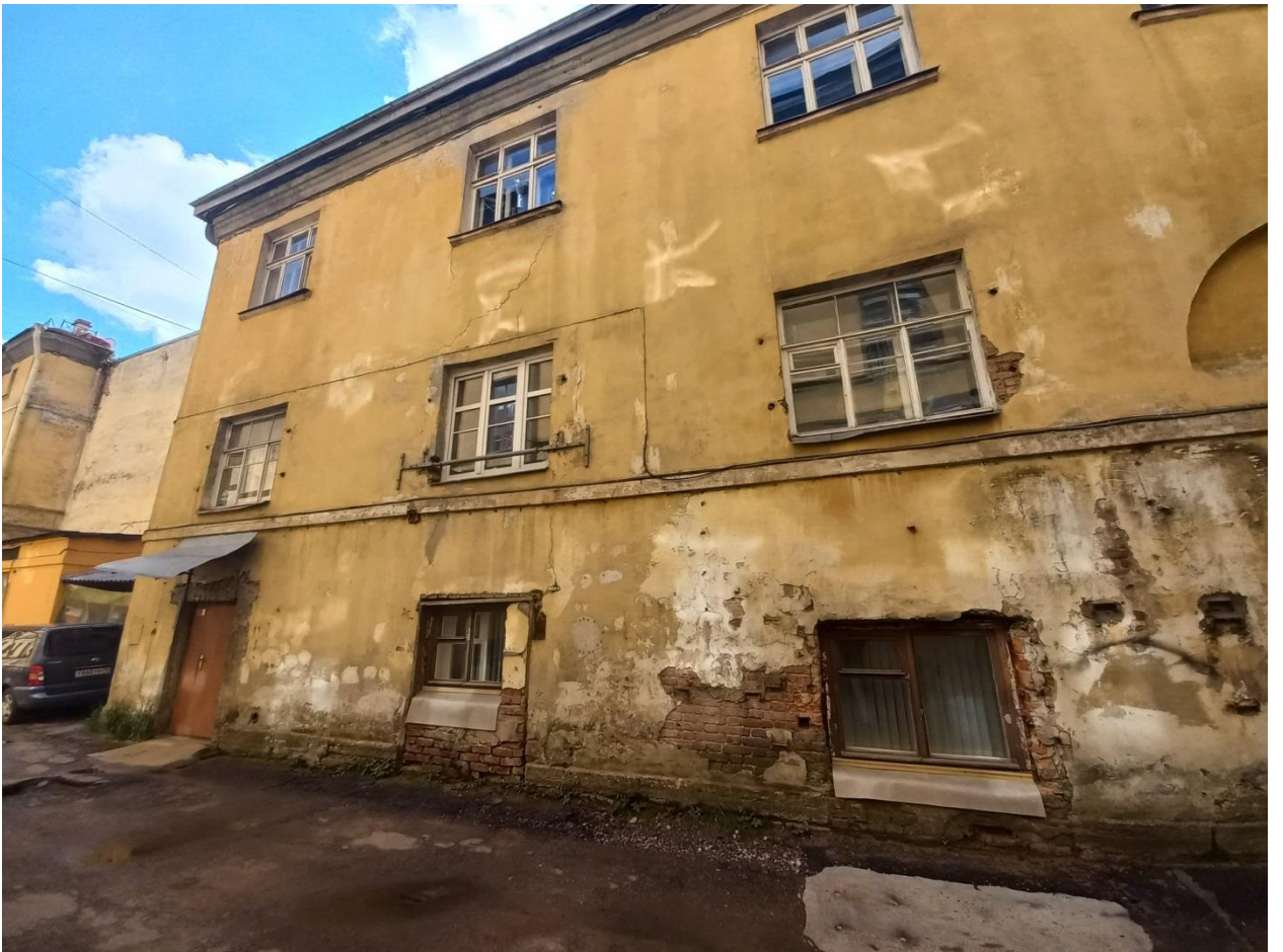
Фото 4. Фасад здания литер Б.
