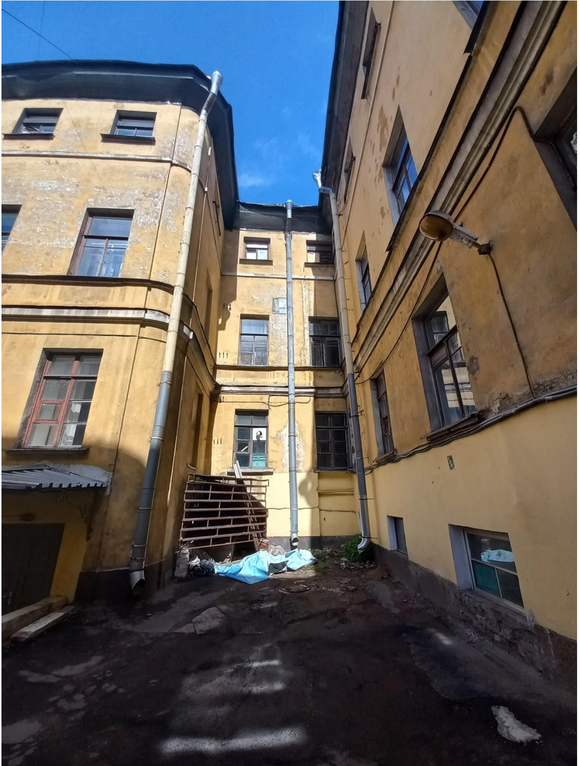
Фото 9. Фасад здания лит. А, южная часть.
