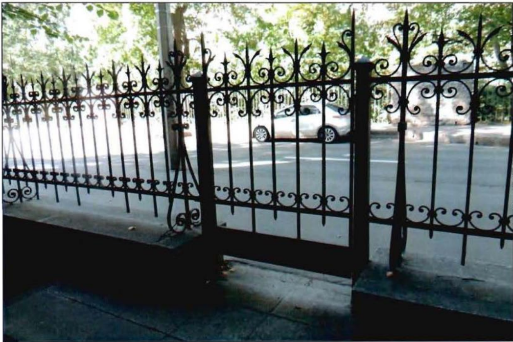
14. Общий вид объекта культурного наследия с юго-востока. Решетка ограждения палисадника.
