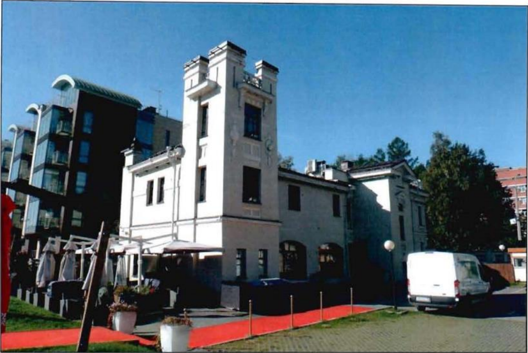
8. Общий вид объекта культурного наследия с северо-востока.
