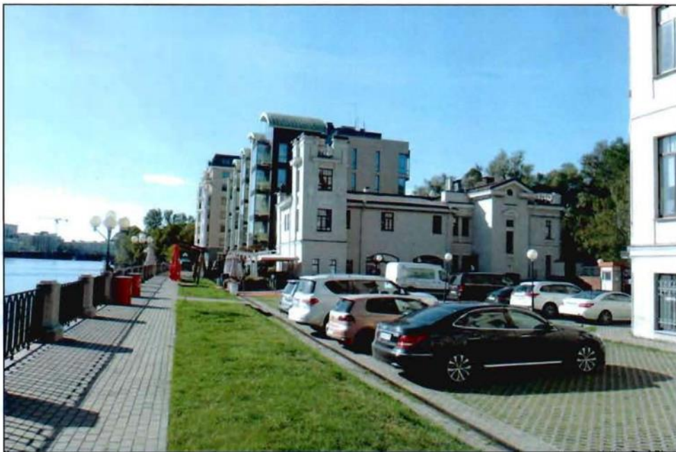
16. Общий вид объекта культурного наследия с северо-востока.
