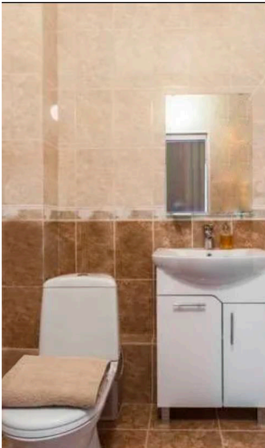
Фото 14. Общий вид на помещение санузла (пом. 5).
