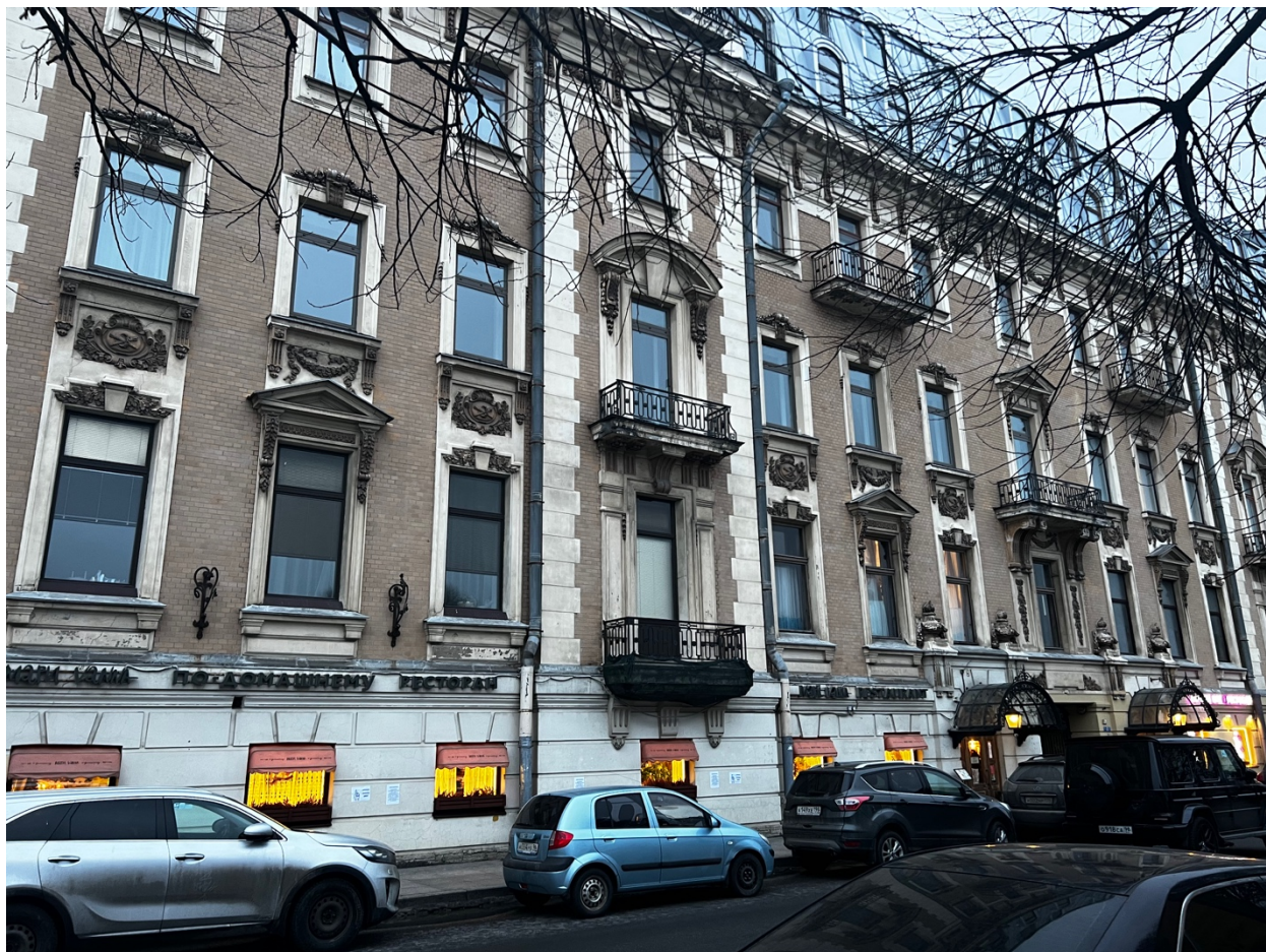
Фото 3. Общий вид на часть лицевого фасада здания, выходящего на Мытнинскую набережную.
