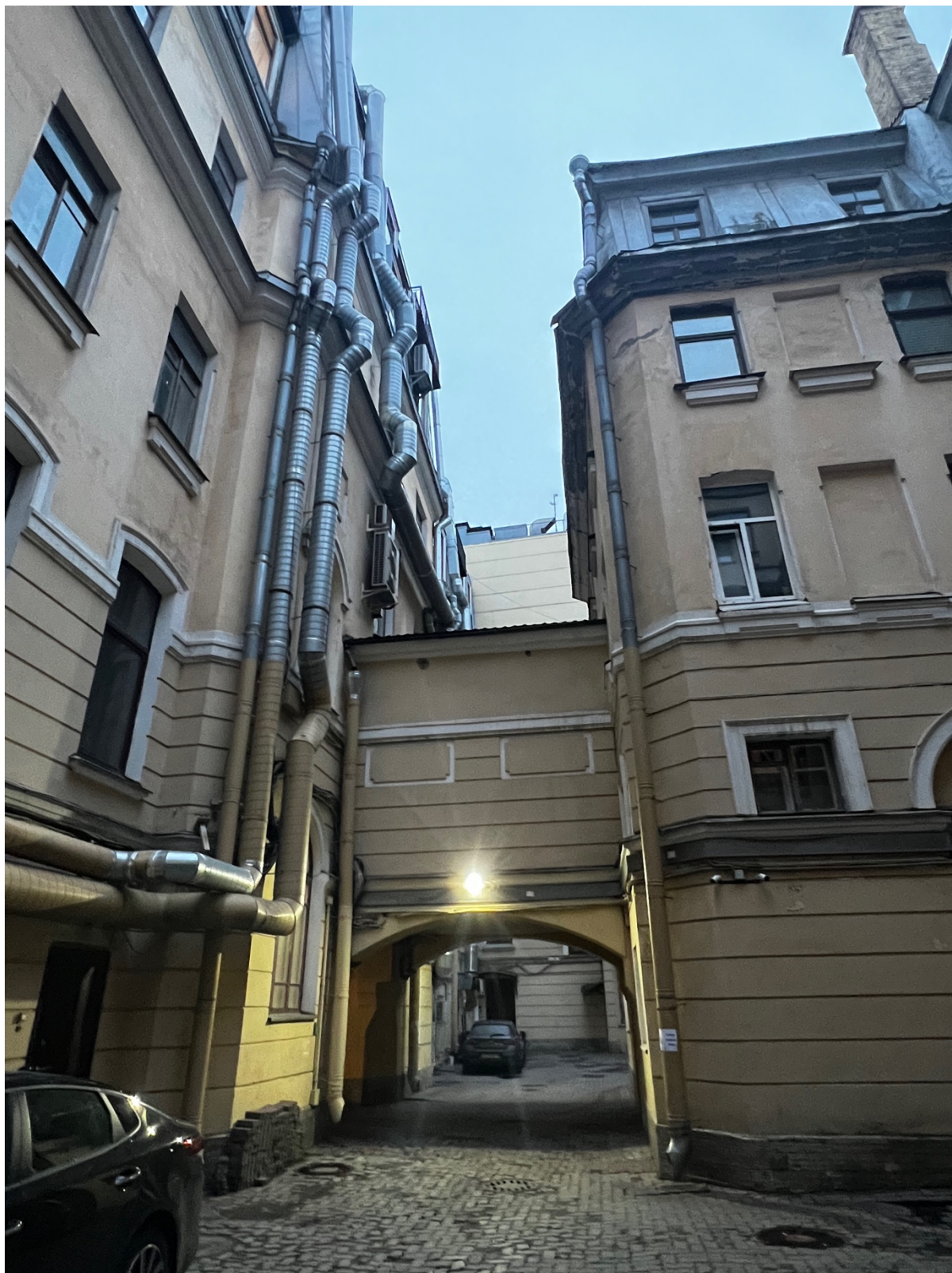
Фото 6. Вид на часть дворового фасада, наблюдается установка дополнительного оборудования, замена оконных заполнений.
