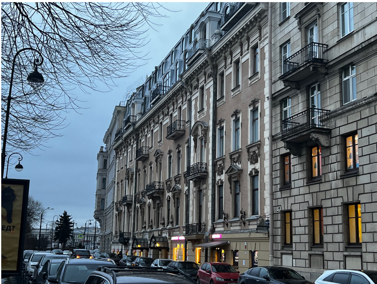
Фото 1. Общий вид на лицевой фасад здания, выходящий на Мытнинскую наб.
