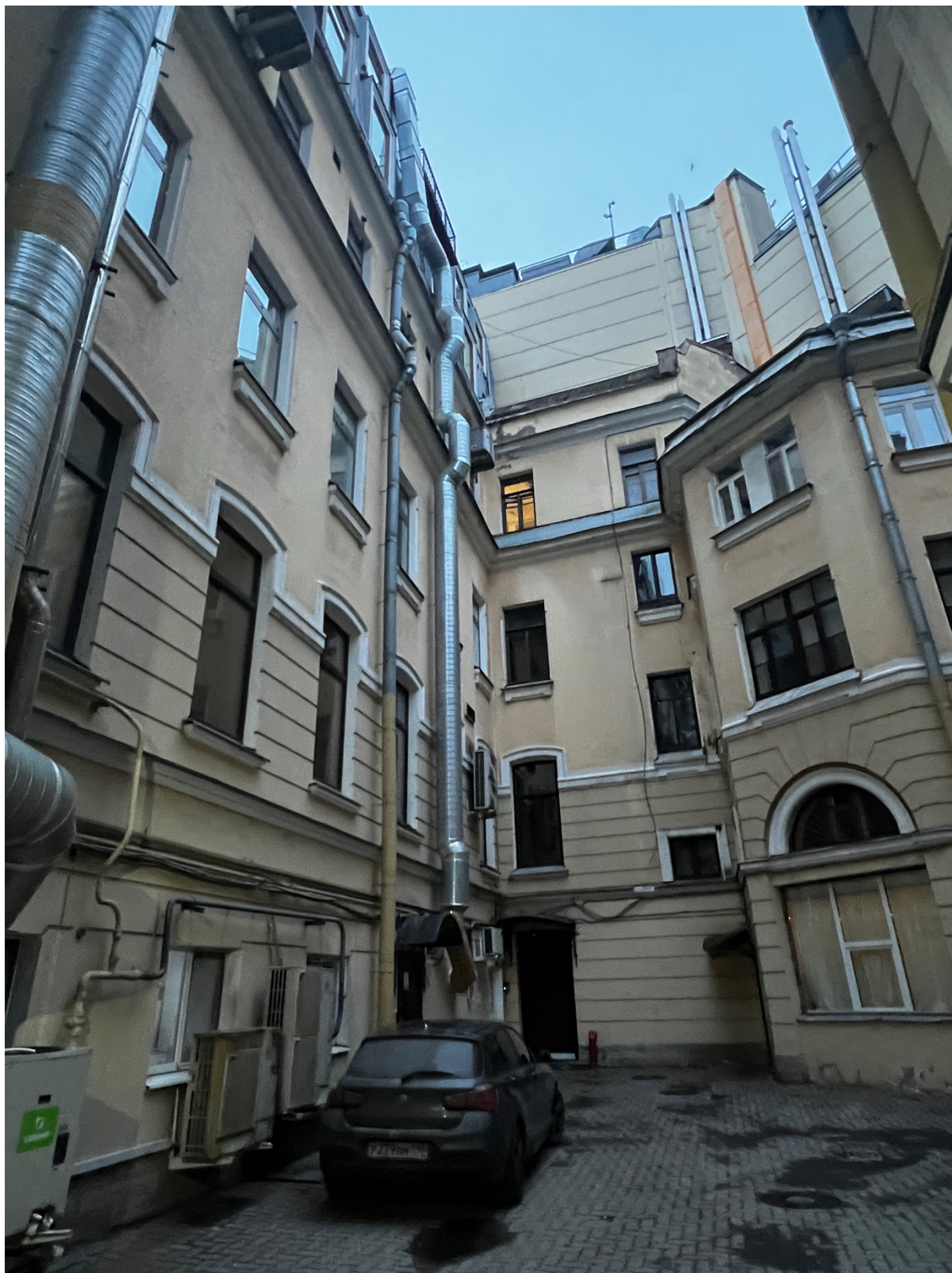
Фото 7. Вид на часть дворового фасада, наблюдается установка дополнительного оборудования, замена оконных заполнений.
