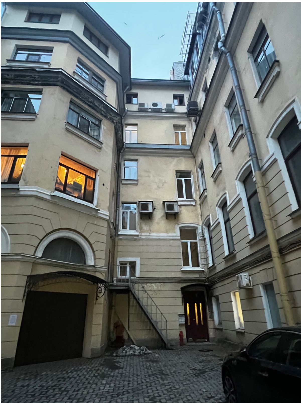
Фото 4. Вид на часть дворового фасада, наблюдается установка дополнительного оборудования, замена оконных заполнений.
