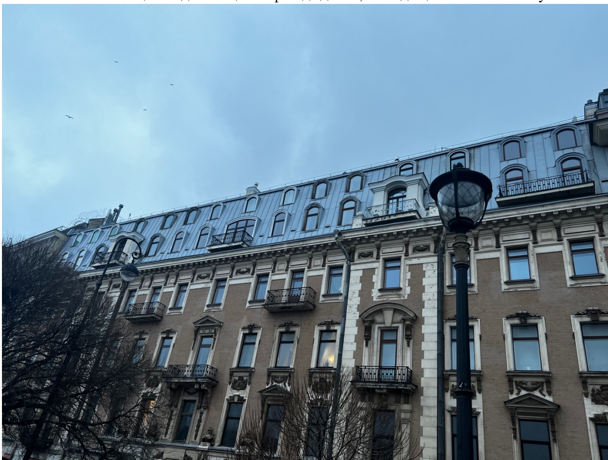
Фото 2. Общий вид на часть лицевого фасада здания, выходящего на Мытнинскую набережную.
