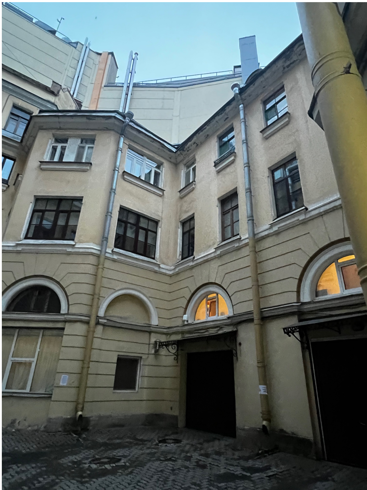
Фото 8. Вид на часть дворового фасада, наблюдается установка дополнительного оборудования, замена оконных заполнений.
