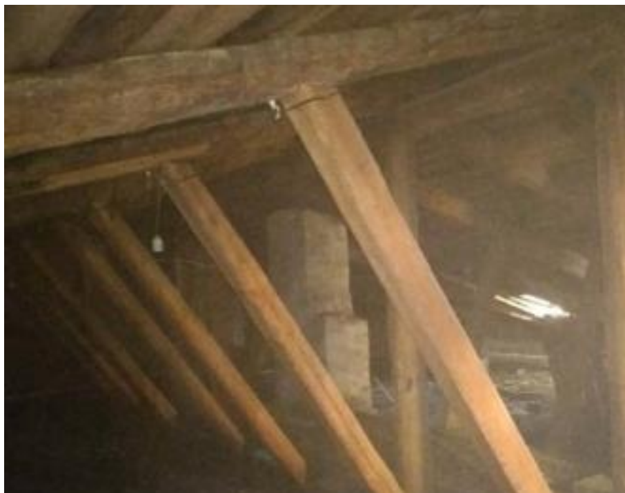
15. Объект культурного наследия федерального значения «Дом для приходящих богомольцев» по адресу: г. Санкт-Петербург, Московский проспект, д. 100, лит. Я, входящий в состав объекта культурного наследия федерального значения «Монастырь Воскресенский Новодевичий» по адресу: Санкт-Петербург, Московский проспект, дом 100, литеры А, Г, О, П, Р, С, Я, Московский проспект, дом 100, корпус 2. Чердак. Стропильная система. Фрагмент.
