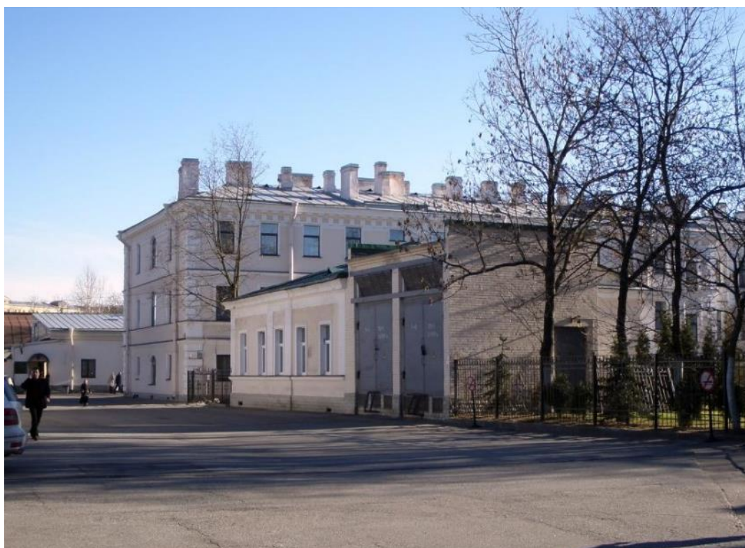
24. Воскресенский Новодевичий монастырь. Дом для приходящих богомольцев. Общий вид здания с поздней пристройкой. 2013 г. https://www.citywalls.ru .
