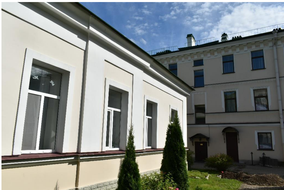
5. Объект культурного наследия федерального значения «Дом для приходящих богомольцев» по адресу: г. Санкт-Петербург, Московский проспект, д. 100, лит. Я, входящий в состав объекта культурного наследия федерального значения «Монастырь Воскресенский Новодевичий» по адресу: Санкт-Петербург, Московский проспект, дом 100, литеры А, Г, О, П, Р, С, Я, Московский проспект, дом 100, корпус 2. Западный фасад. Фрагмент.
