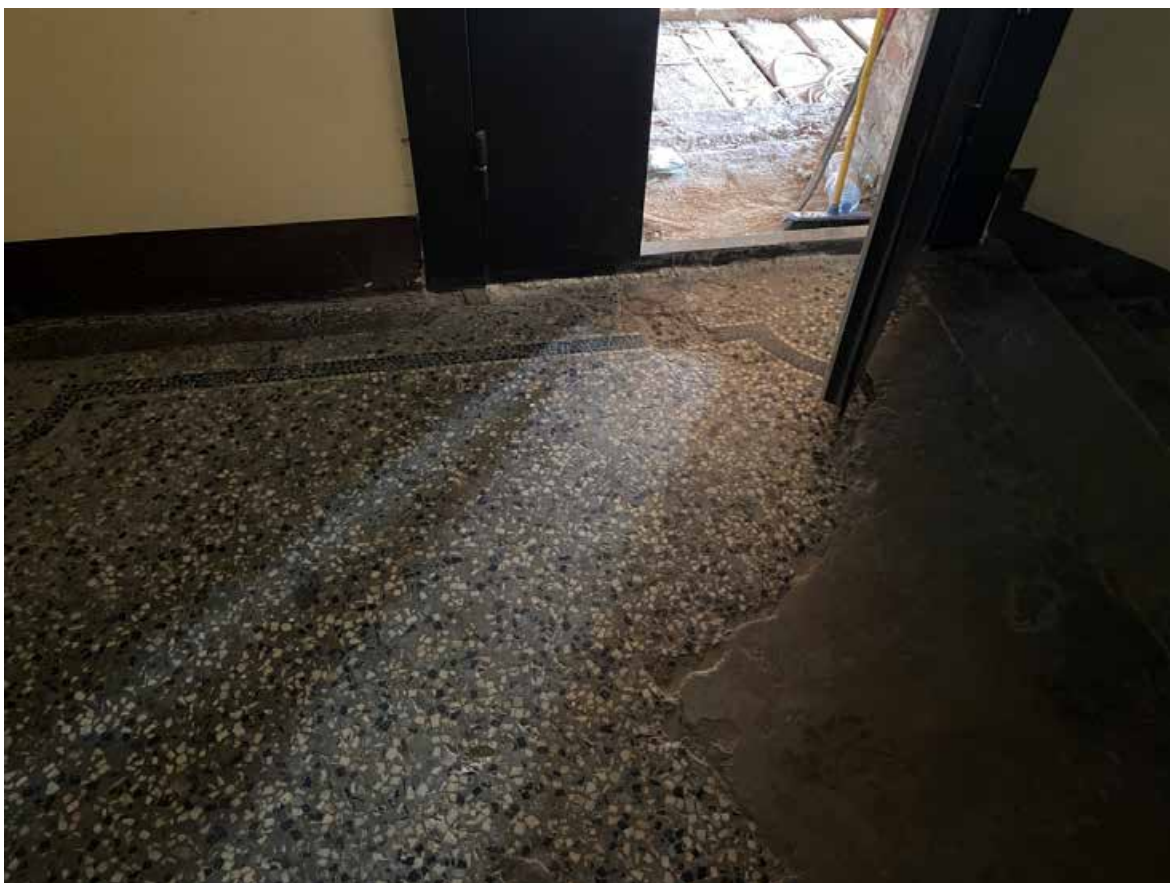
Фото 15. Вид на лестничную площадку при входе в квартиру № 25 объекта культурного наследия.
