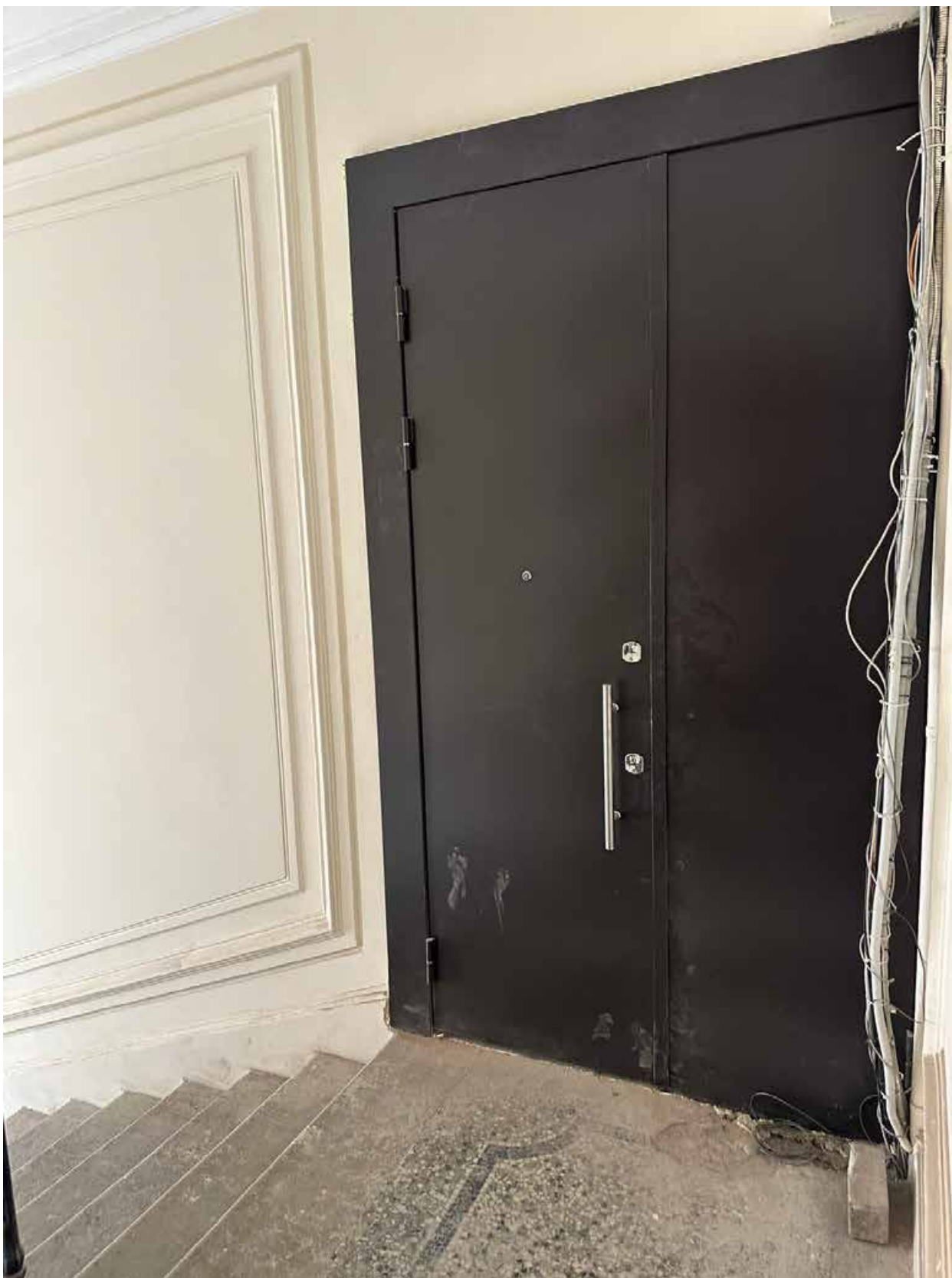
Фото 36. Вид на дверное заполнение квартиры № 25 объекта культурного наследия.
