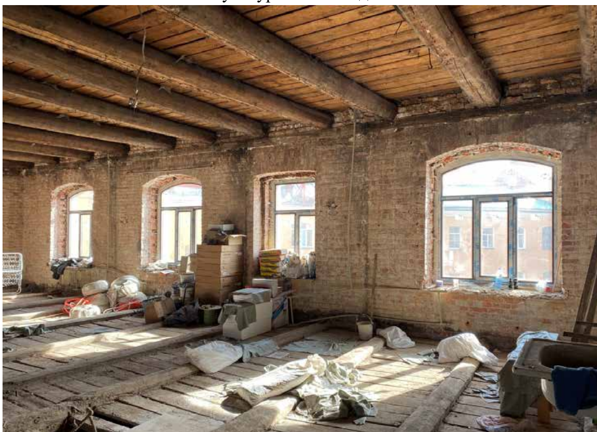
Фото 16. Вид на внутренние помещения квартиры № 25 объекта культурного наследия.
