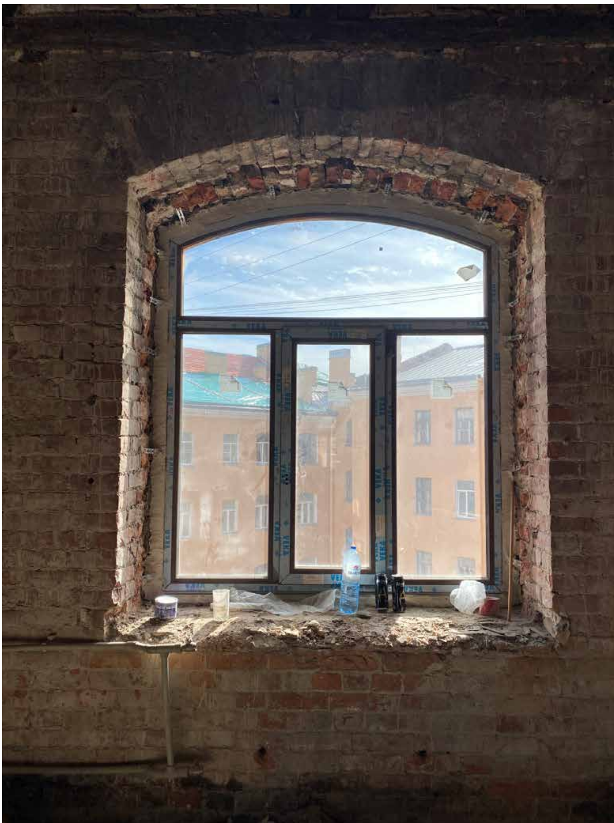
Фото 23. Вид на оконное заполнение квартиры № 25 объекта культурного наследия.
