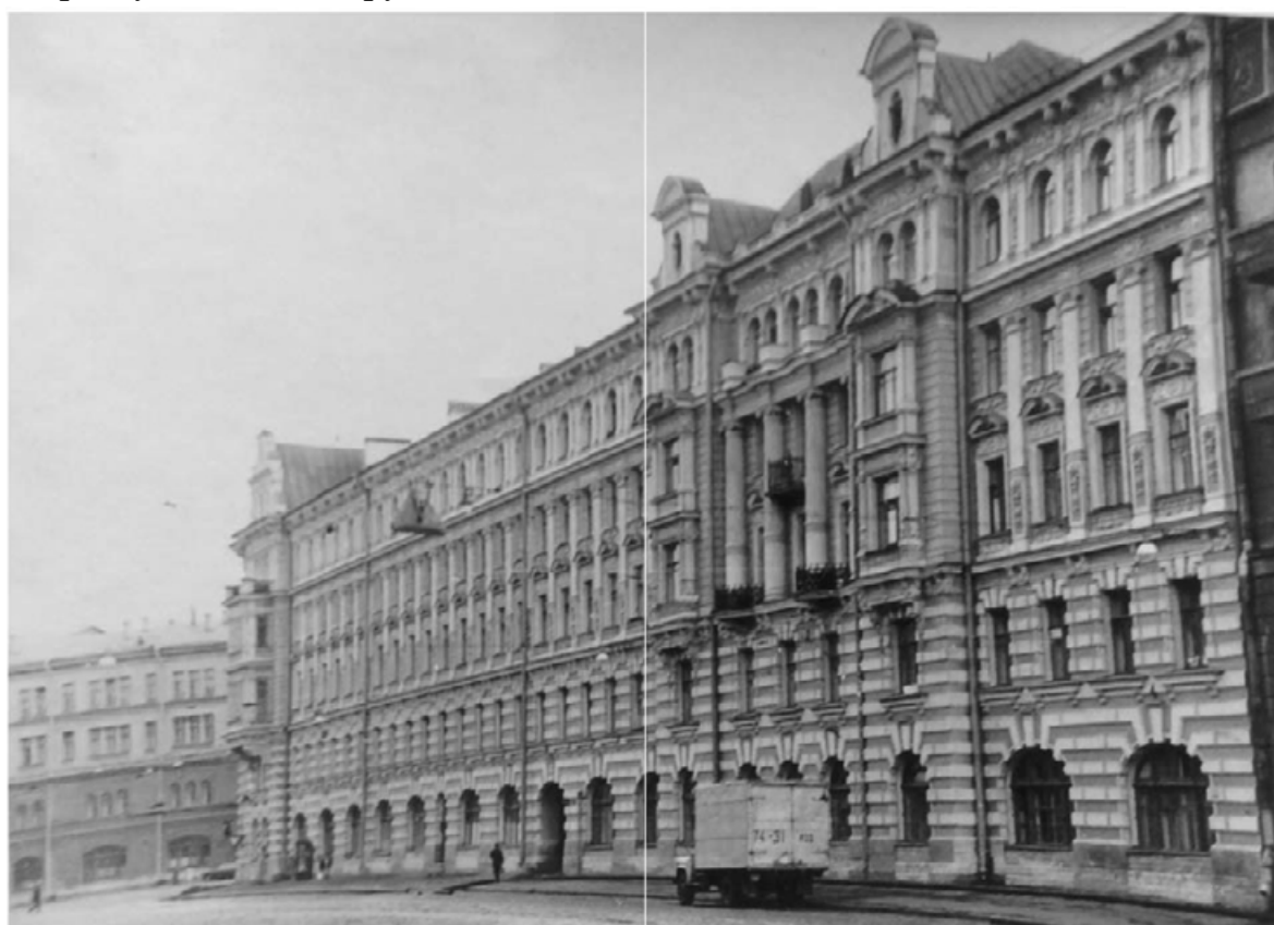
Илл. 67. 2-ая Советская ул., 27. Лицевой фасад. Фото 1978 г. Паспорт памятника истории «Дом, в котором у В.Д. Бонч-Бруевича бывал В.И. Ленин». 1979. КГИОП. Инв. № 777.
