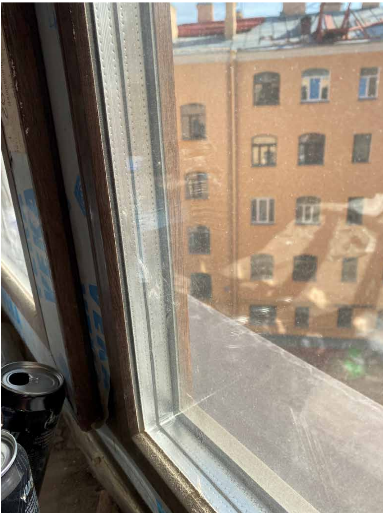
Фото 24. Вид на оконное заполнение квартиры № 25 объекта культурного наследия.
