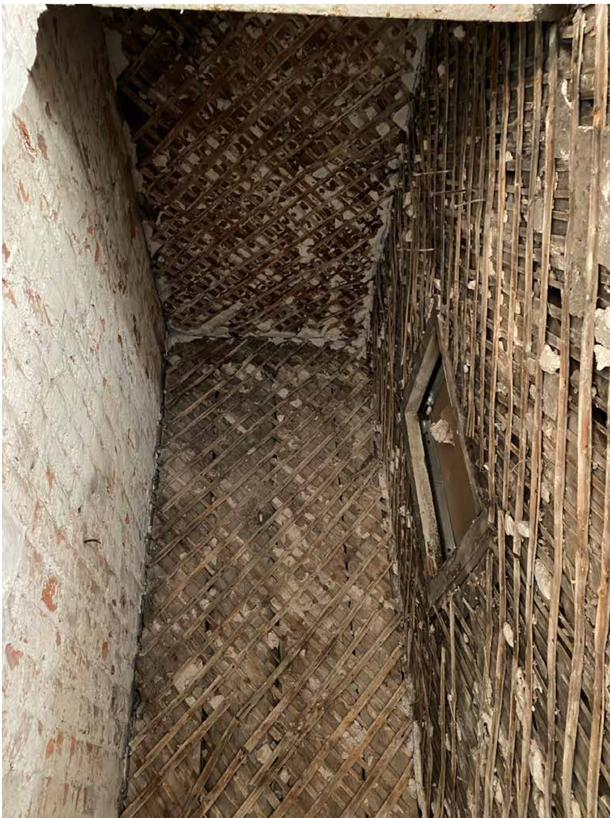
Фото 25. Вид на внутренние помещения квартиры № 25 объекта культурного наследия.
