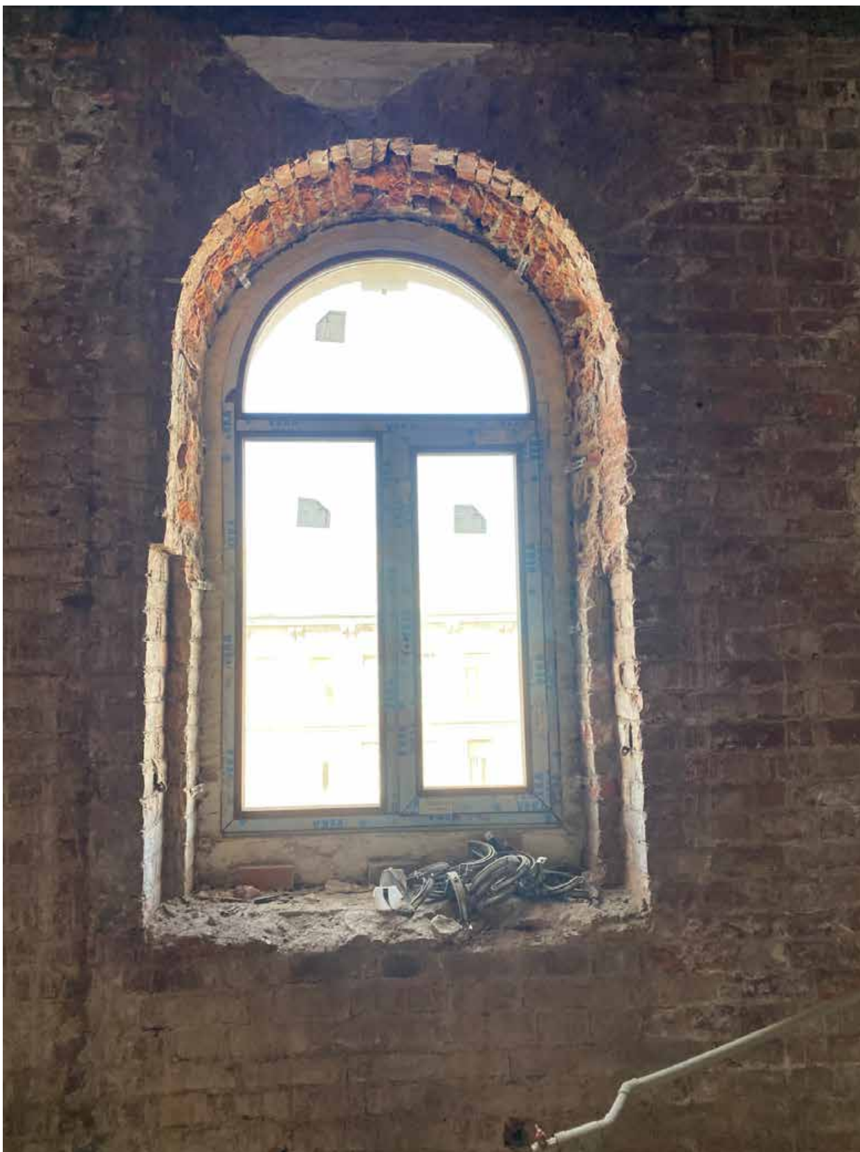
Фото 32. Вид на оконное заполнение квартиры № 25 объекта культурного наследия.
