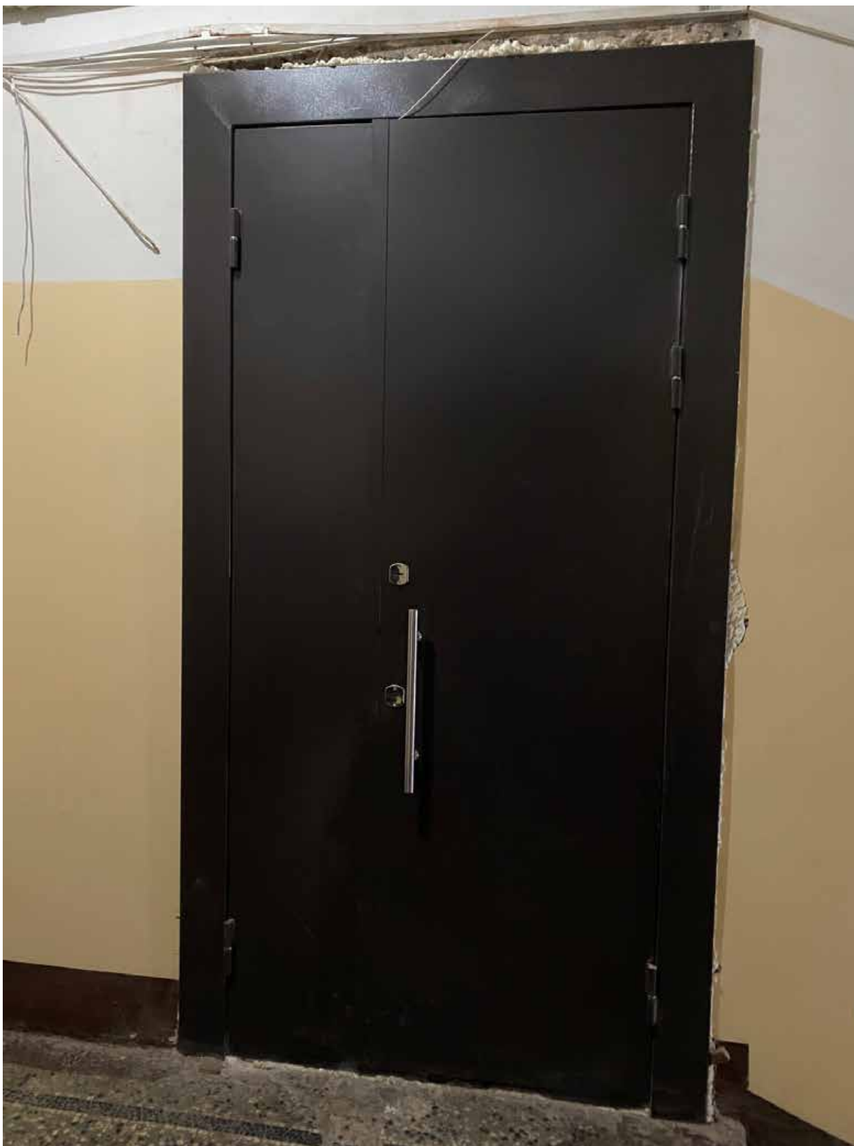
Фото 14. Вид на входное дверное заполнение квартиры № 25, являющейся частью объекта культурного наследия.
