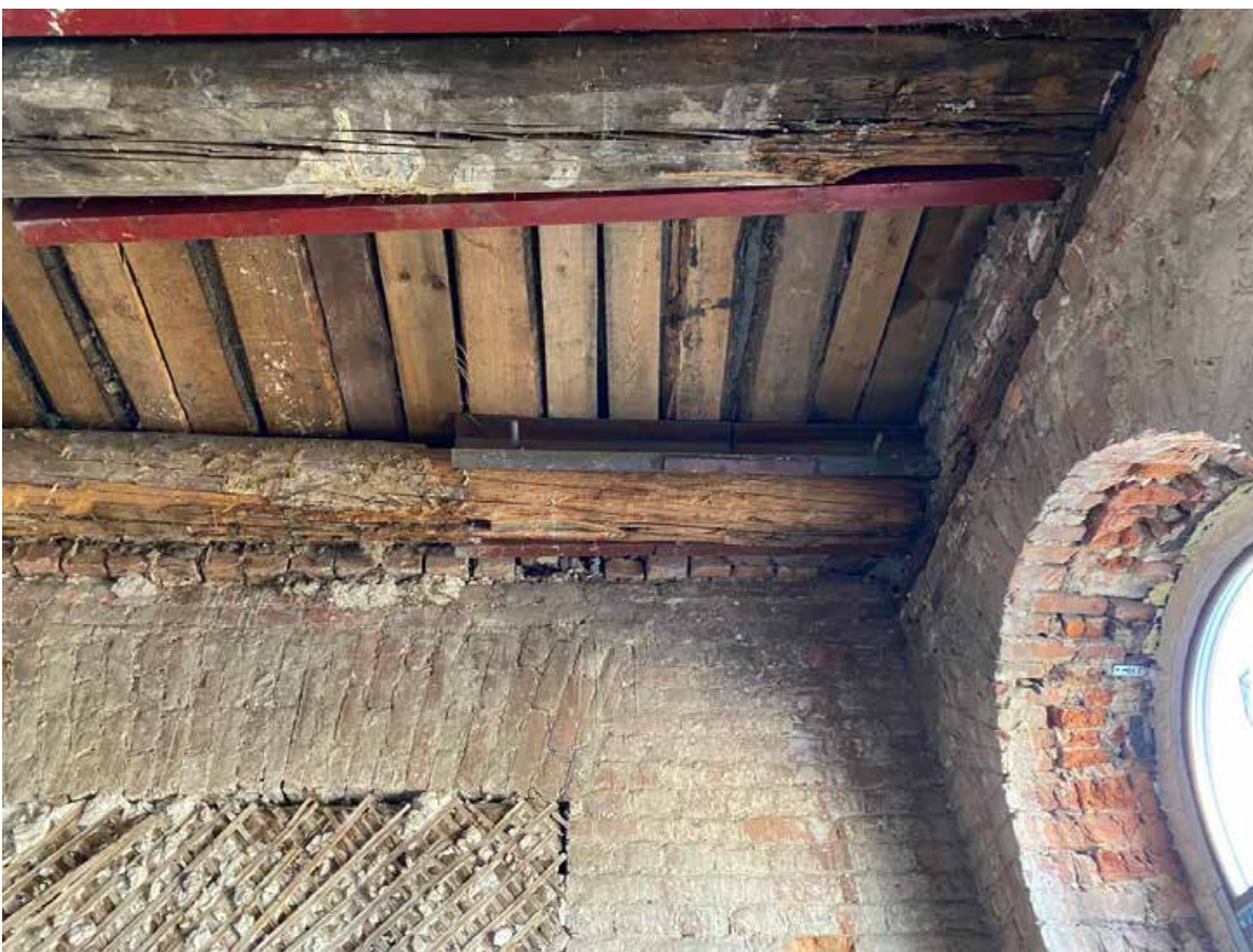
Фото 34. Вид на внутренние помещения квартиры № 25 объекта культурного наследия.
