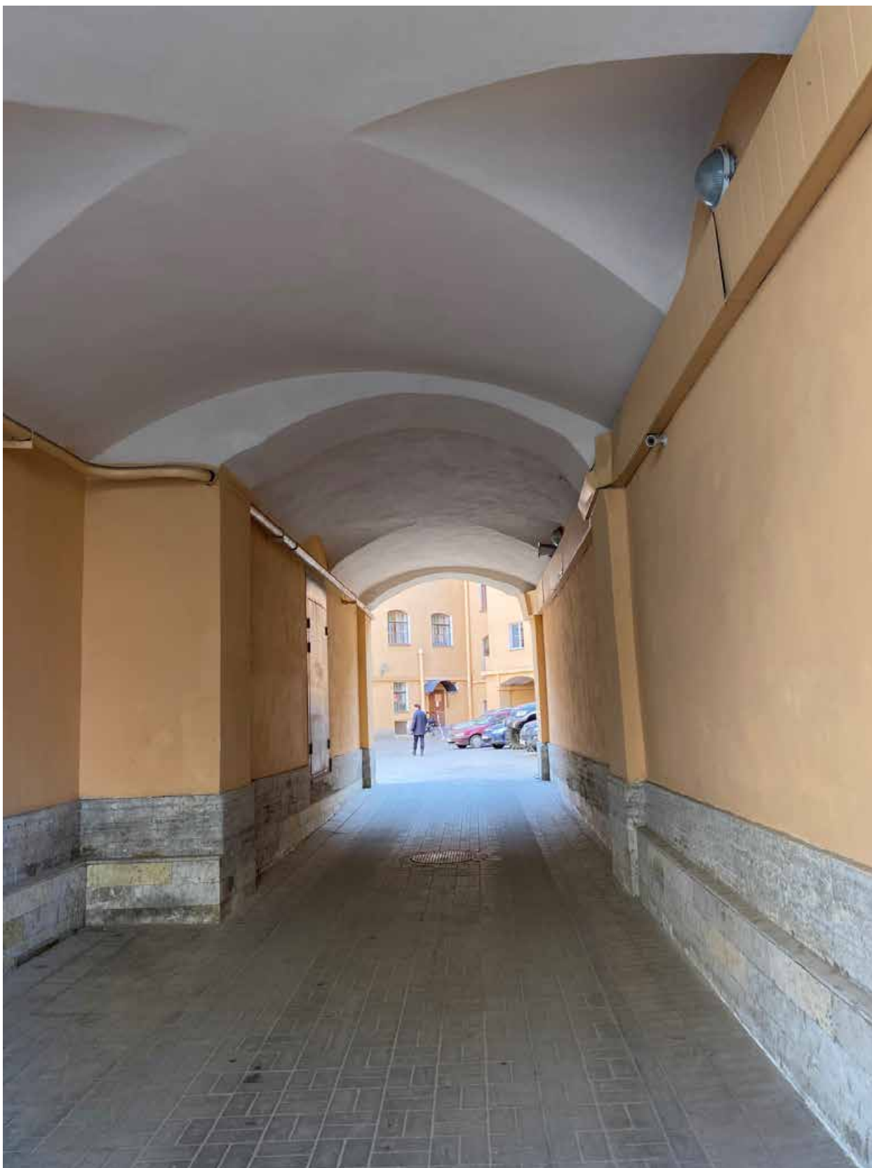
Фото 9. Фрагмент арочного проезда объекта культурного наследия «Дом по 2-й Советской ул. с дворовым флигелем» со 2-й Советской улицы.
