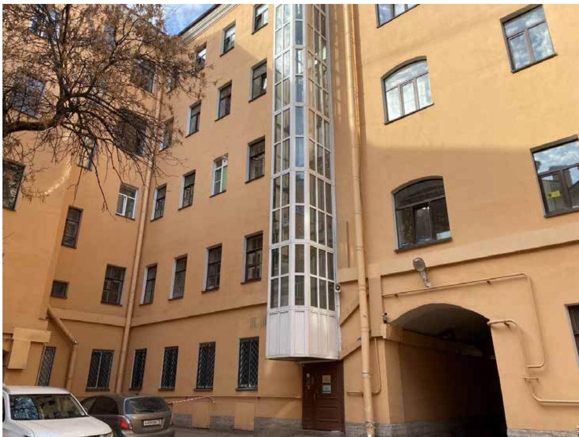
Фото 10. Фрагмент дворовых фасадов объекта культурного наследия «Дом по 2-й Советской ул. с дворовым флигелем».
