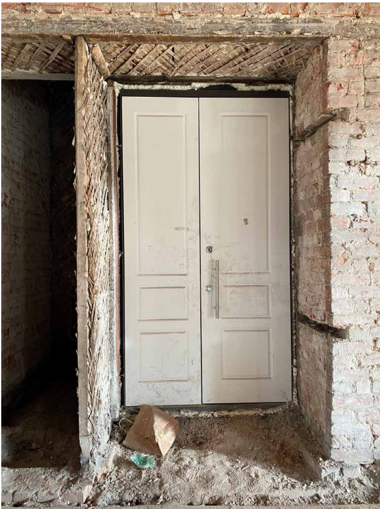
Фото 35. Вид на дверное заполнение квартиры № 25 объекта культурного наследия.
