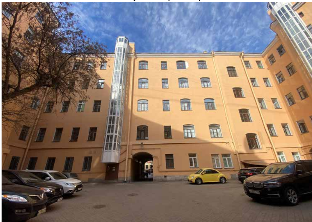
Фото 11. Фрагмент дворовых фасадов объекта культурного наследия «Дом по 2-й Советской ул. с дворовым флигелем».
