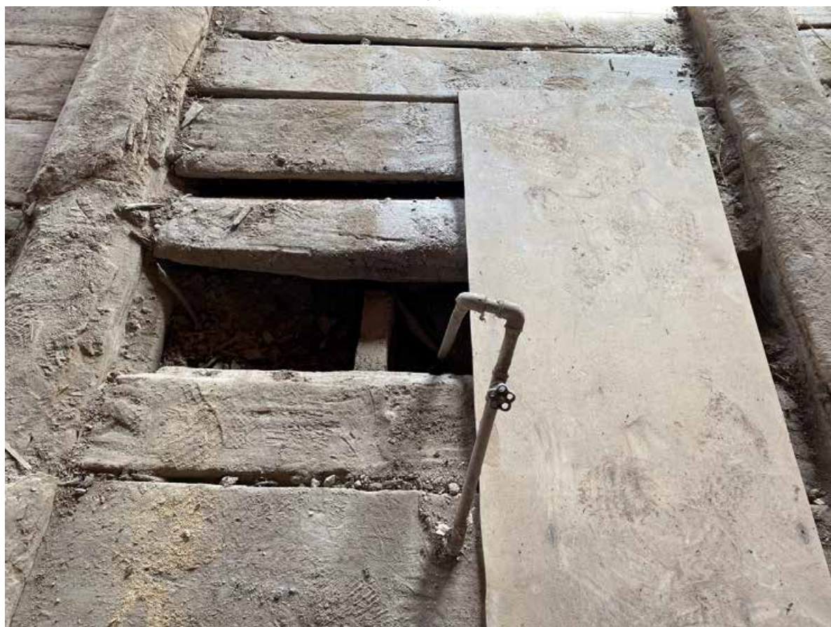
Фото 20. Фрагмент перекрытия квартиры № 25 объекта культурного наследия.
