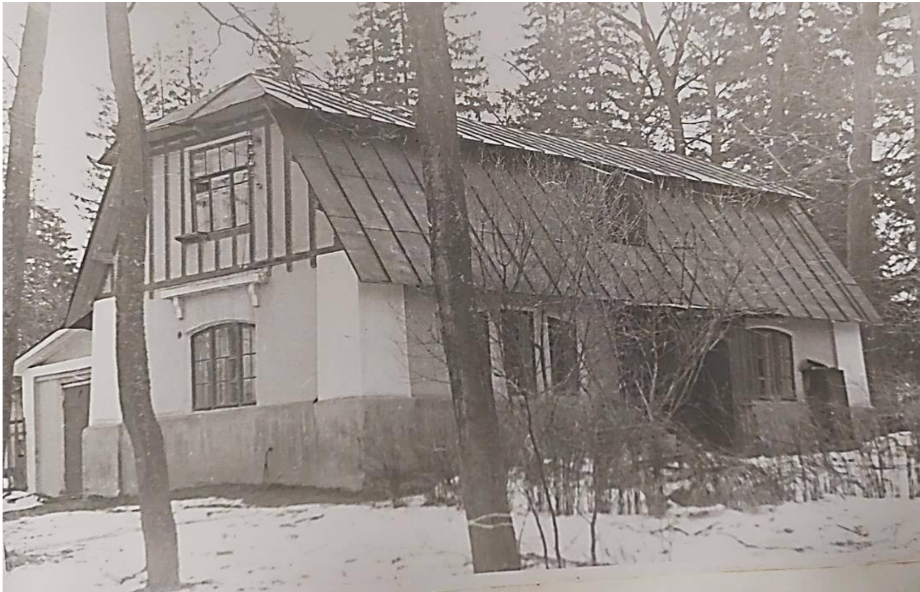
48. Вид на бывший дом садовника в Шуваловском парке. На территории парка размещается Всесоюзный научно-исследовательский институт токов высокой частоты им. В.П. Вологодина (отдел главного механика и энергетика). Дата съемки: 1980 г. // ЦГА НТД СПб. Ф. Р-64 Оп.14 Д.325.
