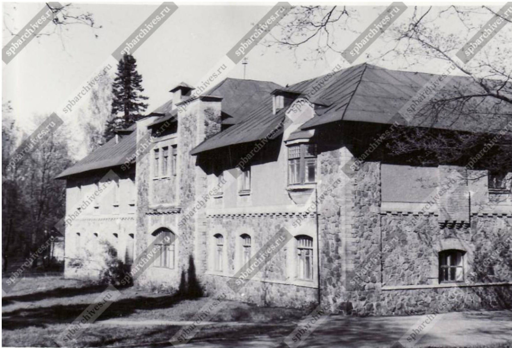
131. Вид здания конюшенного корпуса в усадьбе Шуваловых в Шуваловском парке (архитектор [К.К. Шмидт], 1901-1902 гг.). Дата съёмки: 21 мая 1996 г. ЦГАКФД СПб. Архивный шифр: Ар 225010.
