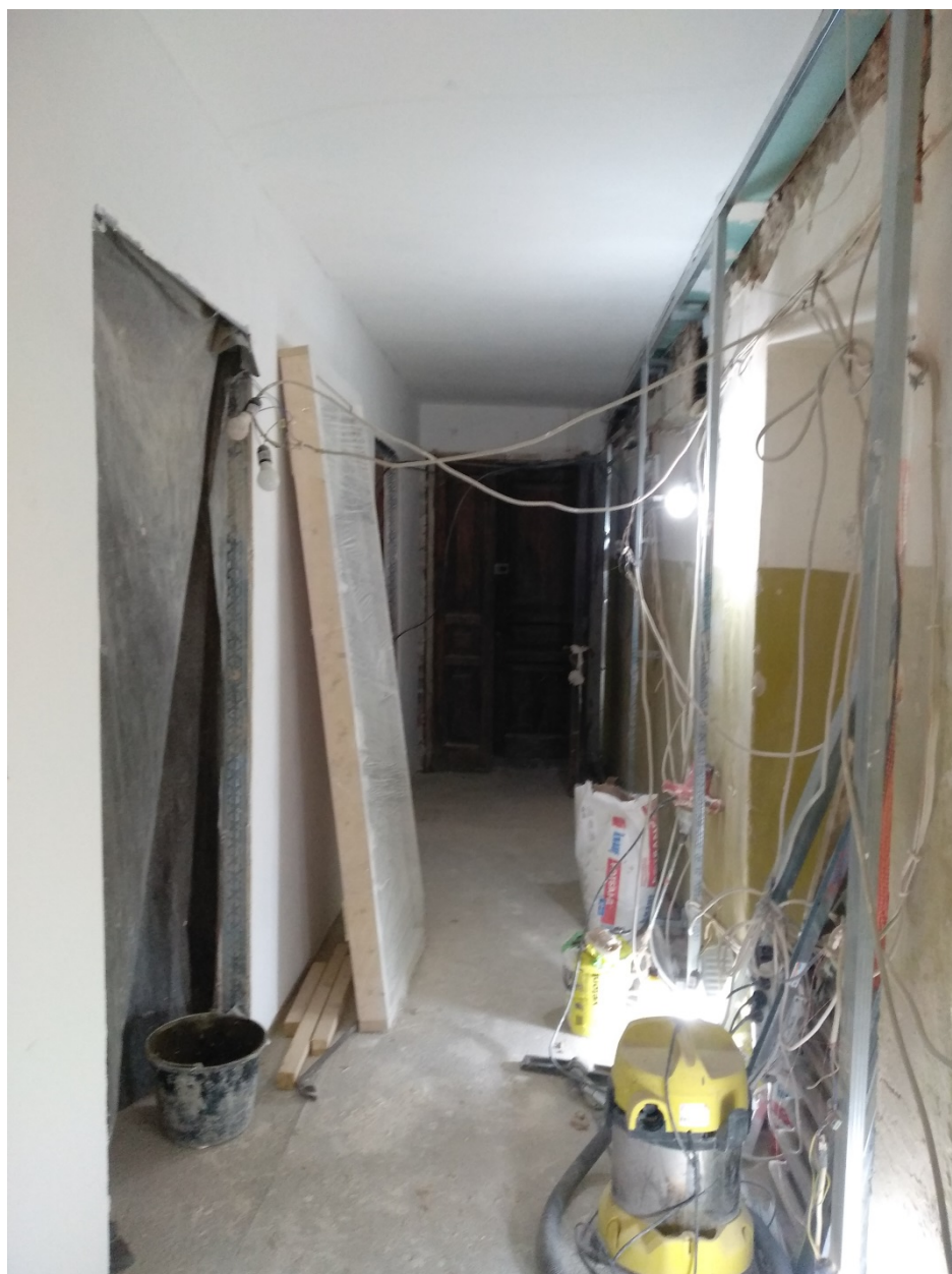
Фото 6. Коридор. Вид на входную дверь.
