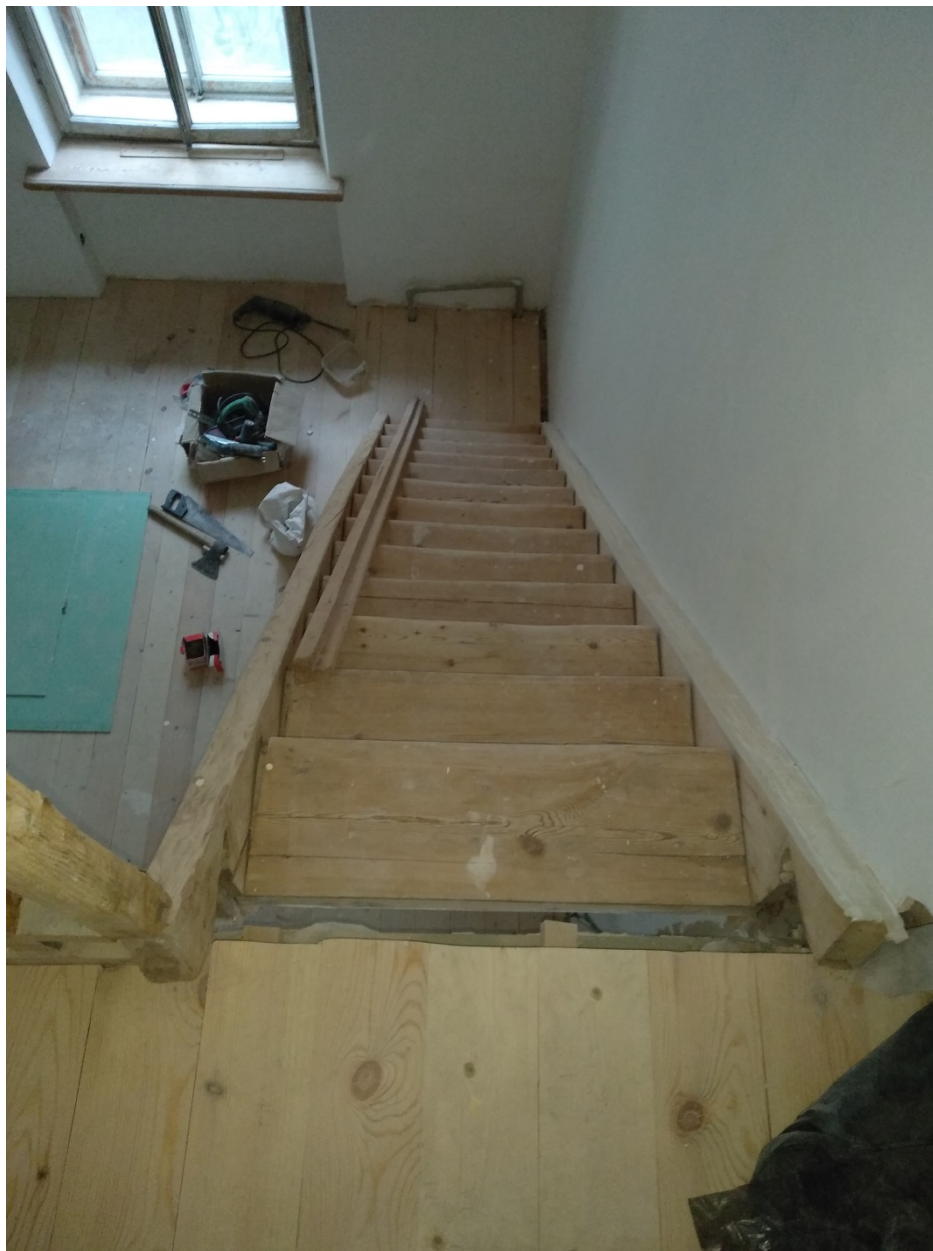
Фото 14. Кухня-столовая (помещение №4 по проектной экспликации). Лестница.
