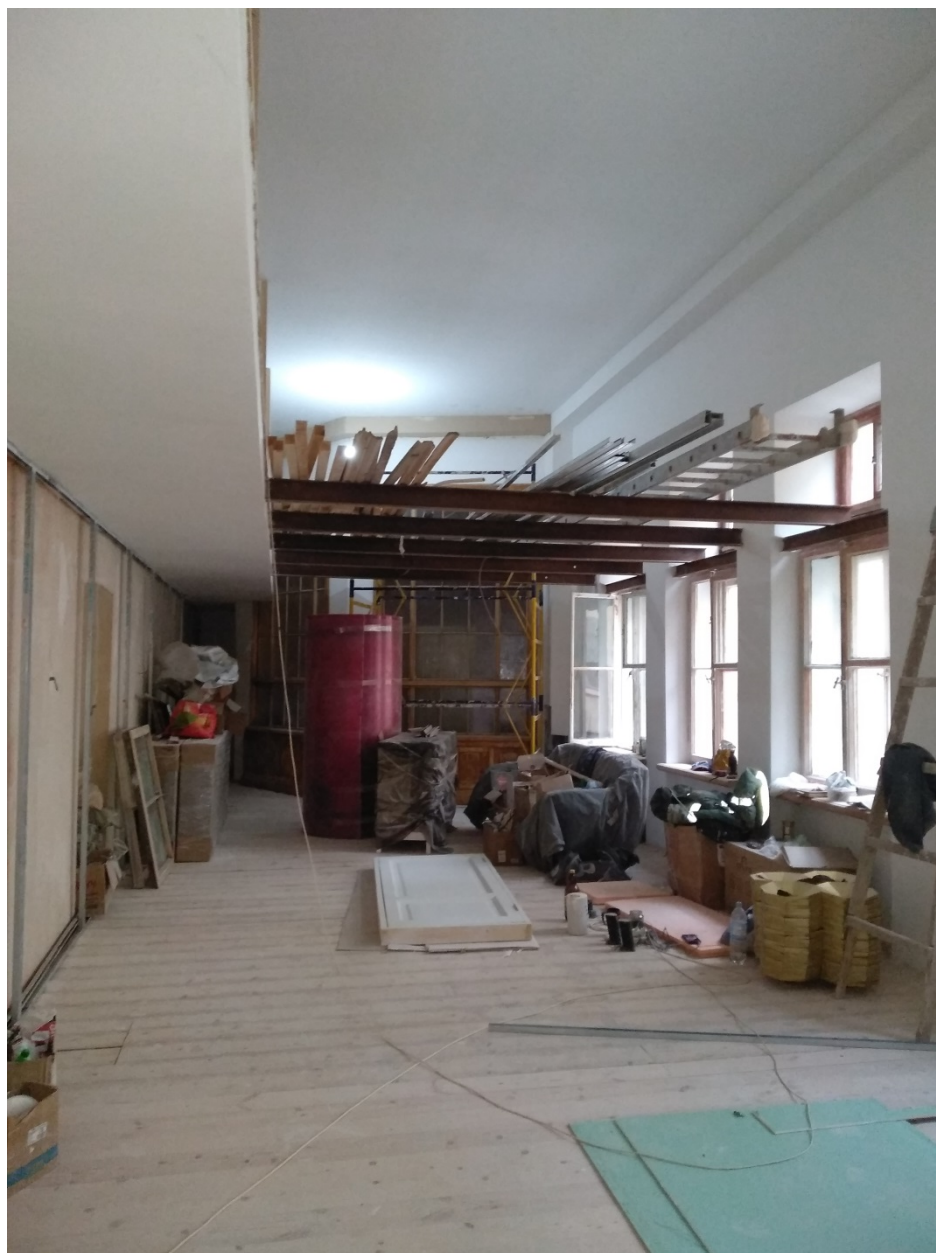
Фото 12. Кухня-столовая (помещение №4 по проектной экспликацией).
