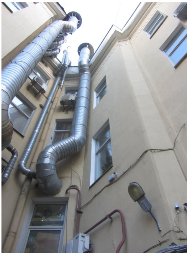
10. Вид дворовых фасадов объекта культурного наследия «Здание Мариинской женской гимназии», расположенного по адресу: Санкт-Петербург, Загородный пр., 13, лит. А.
