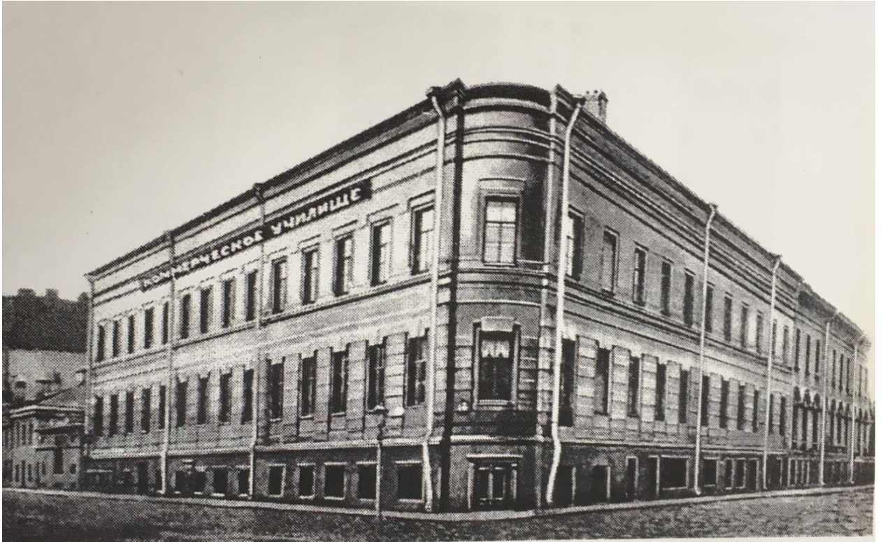
5. 1870-е г. Санкт-Петербургское Коммерческое училище. Общий вид с востока. Фото ( https://vivaldi.nlr.ru/ ).
