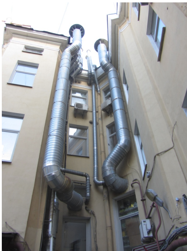
11. Вид дворовых фасадов объекта культурного наследия «Здание Мариинской женской гимназии», расположенного по адресу: Санкт-Петербург, Загородный пр., 13, лит. А.
