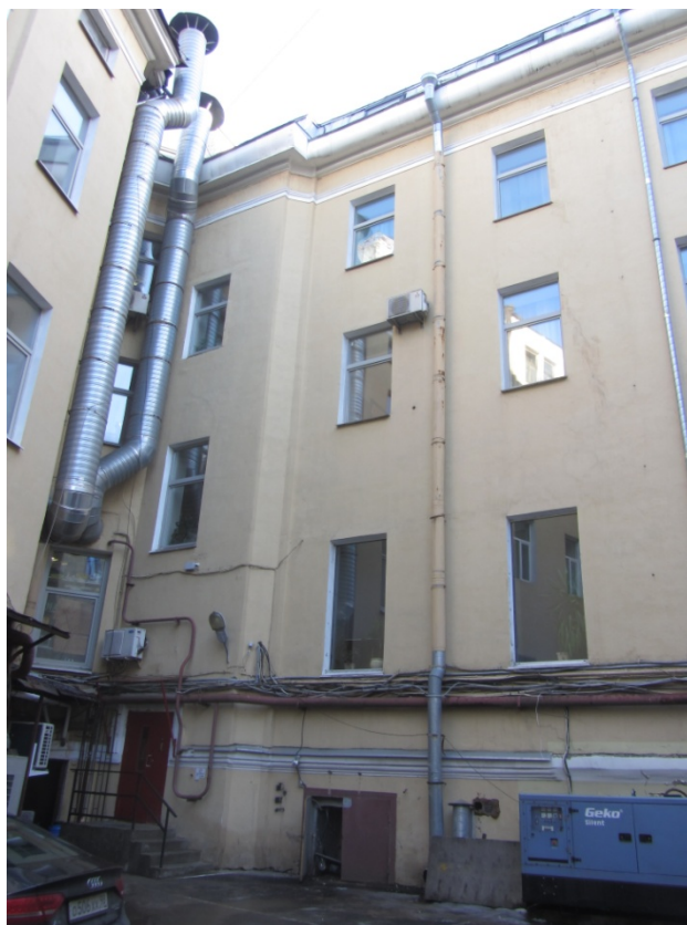
7. Вид дворовых фасадов объекта культурного наследия «Здание Мариинской женской гимназии», расположенного по адресу: Санкт-Петербург, Загородный пр., 13, лит. А.
