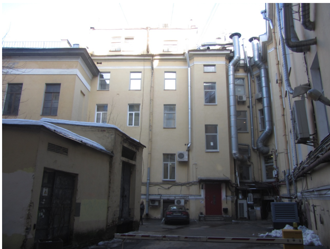
6. Вид дворовых фасадов объекта культурного наследия «Здание Мариинской женской гимназии», расположенного по адресу: Санкт-Петербург, Загородный пр., 13, лит. А.
