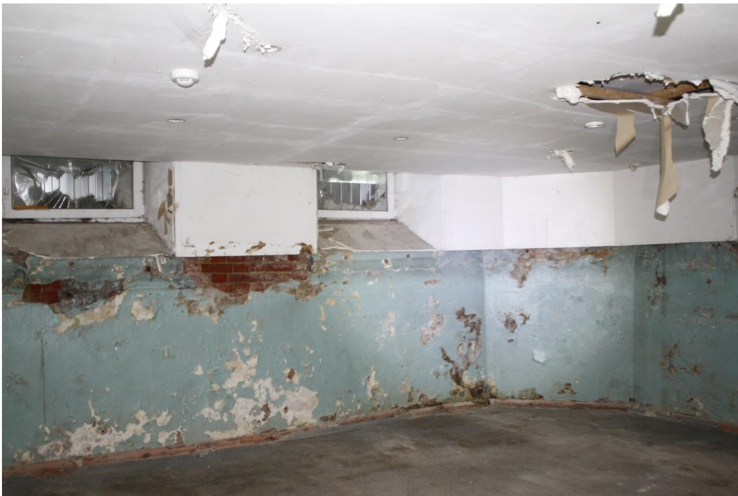
52. “Дом И.В. Кожевникова (Товарищества мануфактур В.И. Кожевникова)”. улица Тюшина дом 9/7, литера А. Фрагмент подвального помещения 1-Н №12. Фото: 15.09.2022.
