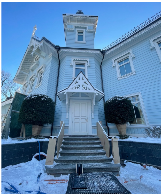
Фото №11. Восточный фасад. Фрагмент входной группы.
