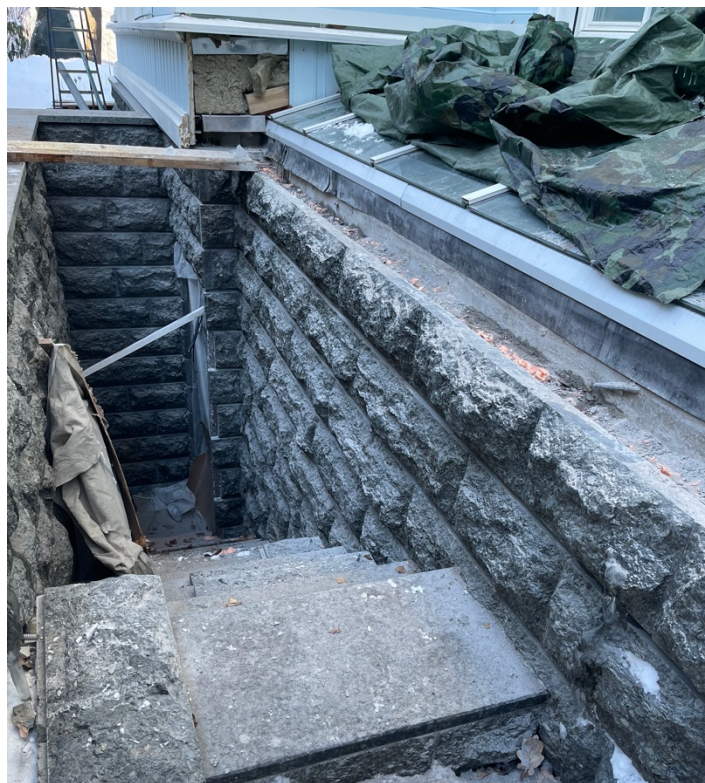
Фото №5. Западный фасад Ведутся работы по устройству зенитного фонаря возле приямка на западном фасаде.
