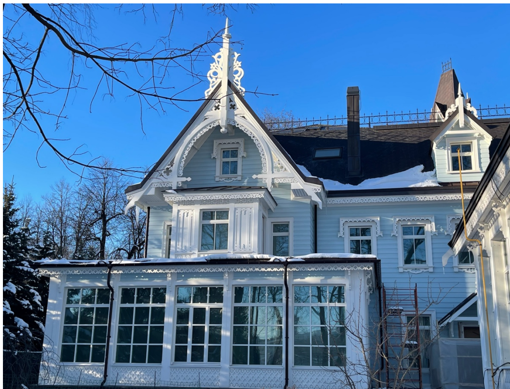
Фото №14. Южный фасад. Общий вид.
