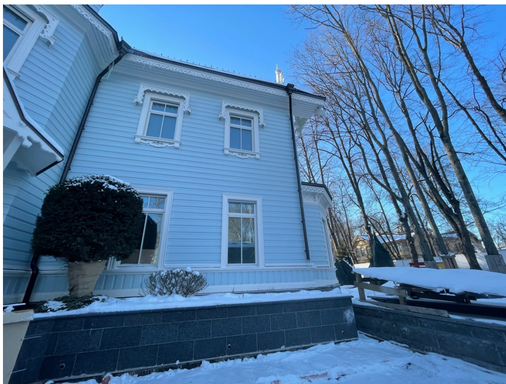
Фото №9. Восточный фасад. Фрагмент.
