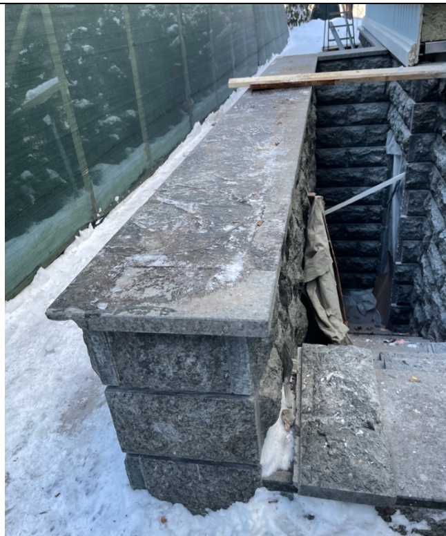
Фото №17 Западный фасад. Фрагмент приямка.
