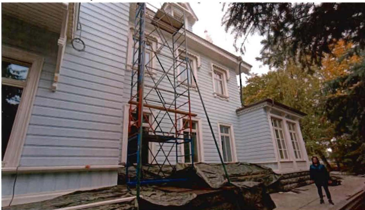
2. Вид на западный фасад.
