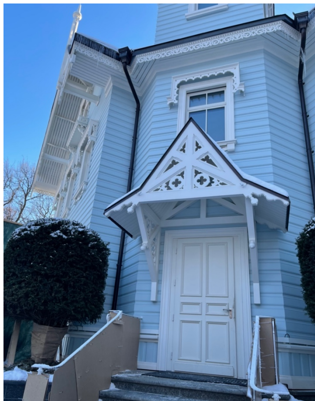
Фото №7. Восточный фасад. Фрагмент входной группы.
