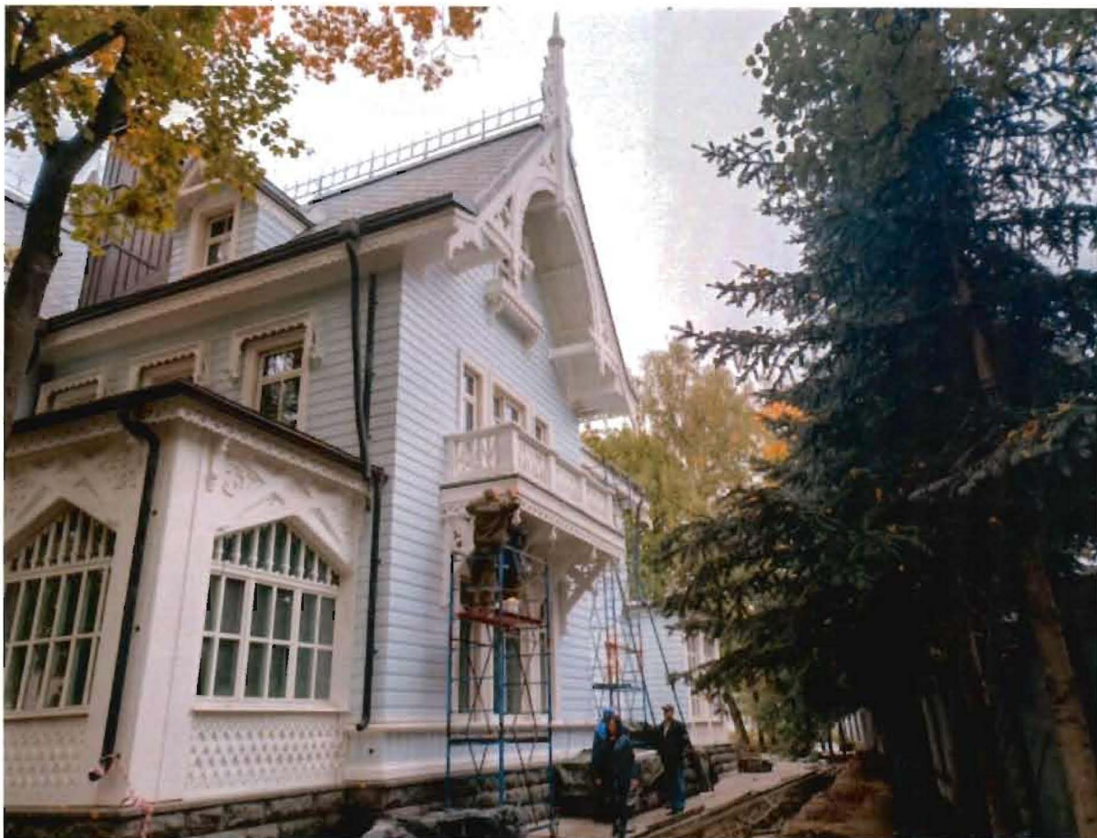
3. Вид на западный фасад.
