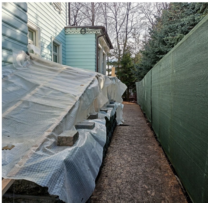
Фото №2. Северный фасад. Фрагмент.
