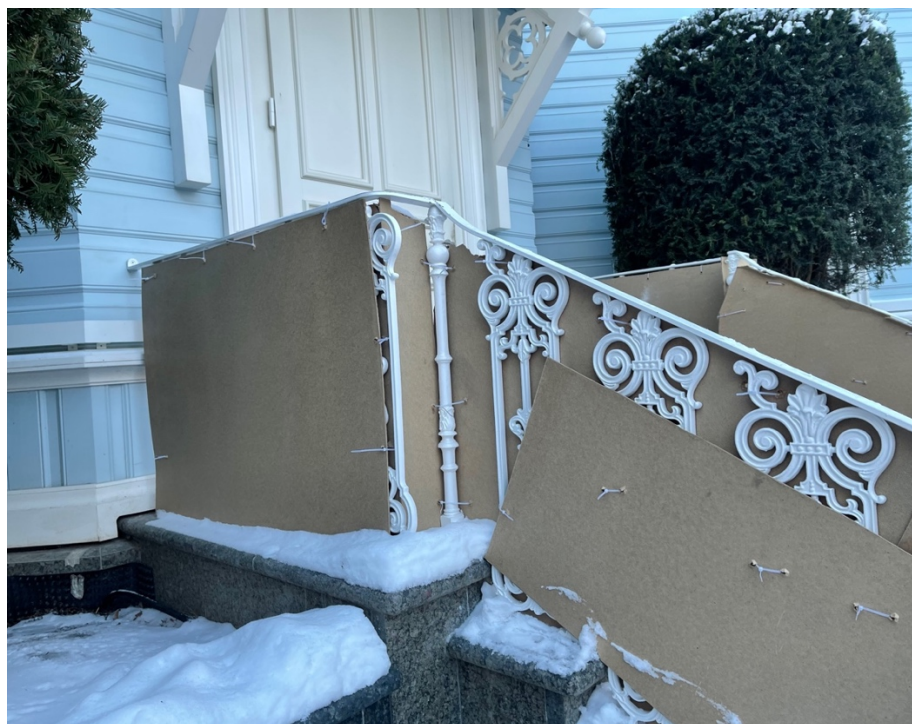
Фото №8. Восточный фасад Ведутся работы по устройству ограждения крыльца главного входа на восточном фасаде.
