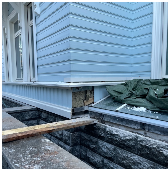
Фото №6. Западный фасад Фрагмент зенитного фонаря и фасада.
