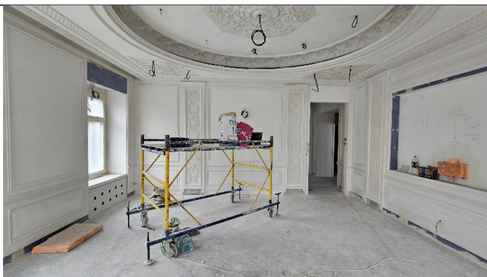
Фото №20. Общий вид помещения первого этажа
