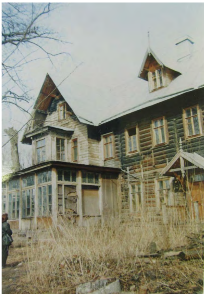
42. 2001г. Бывший дом П. С. Петровой. Южный фасад. Архив КГИОП.
