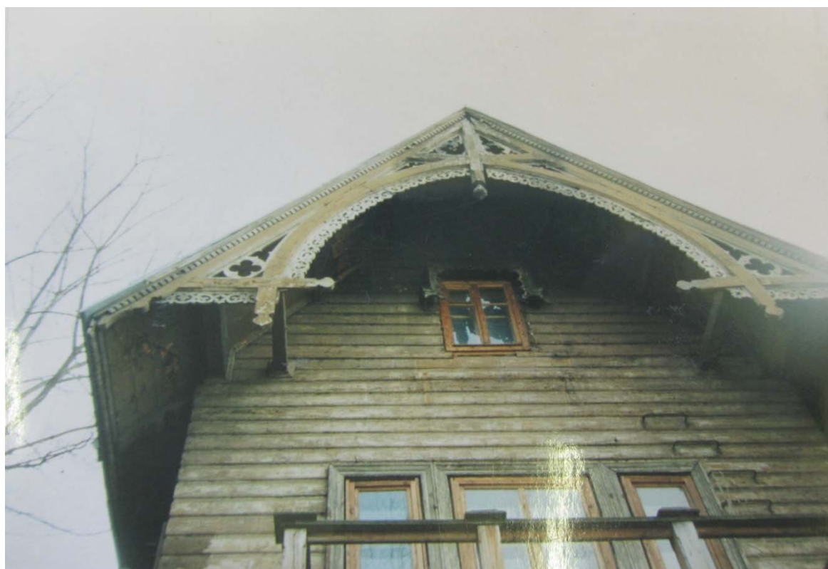
44. 2001г. Бывший дом П. С. Петровой. Фрагмент западного фасада. Архив КГИОП.
