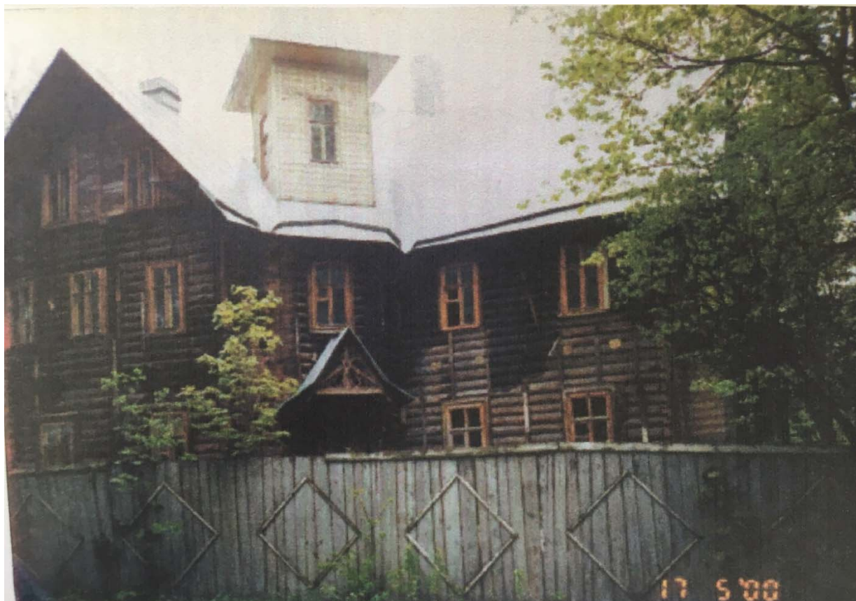
34. 2000г. Вид деревянного дачного дома по набережной Малой Невки 12 (бывшая дача П. С. Петровой). Общий вид здания с северо-востока. Архив КГИОП.
