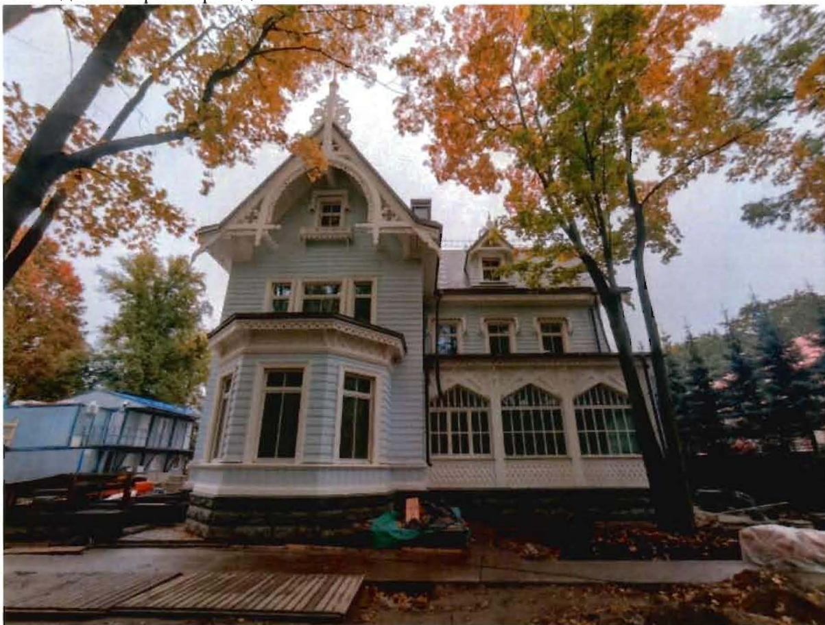
4. Вид на северный фасад.
