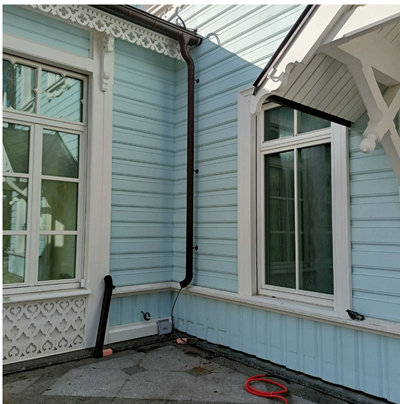
Фото №3. Западный фасад. Фрагмент.
