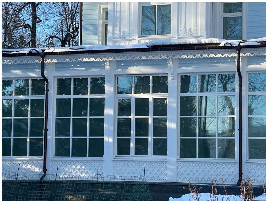
Фото №13. Южный фасад. Фрагмент веранды.
