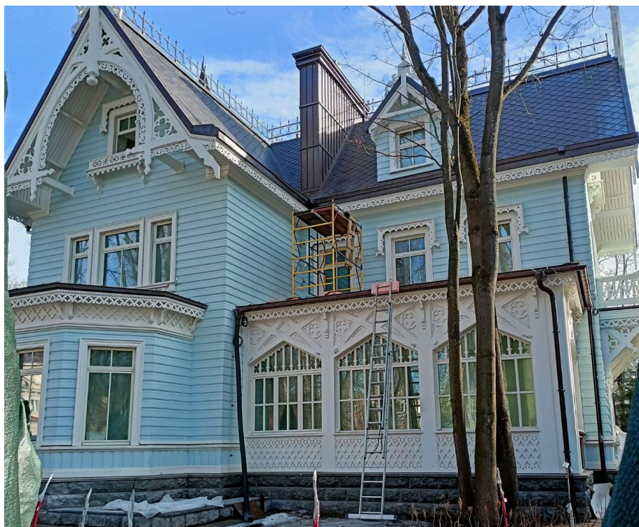
Фото №1. Северный фасад. Общий вид.
