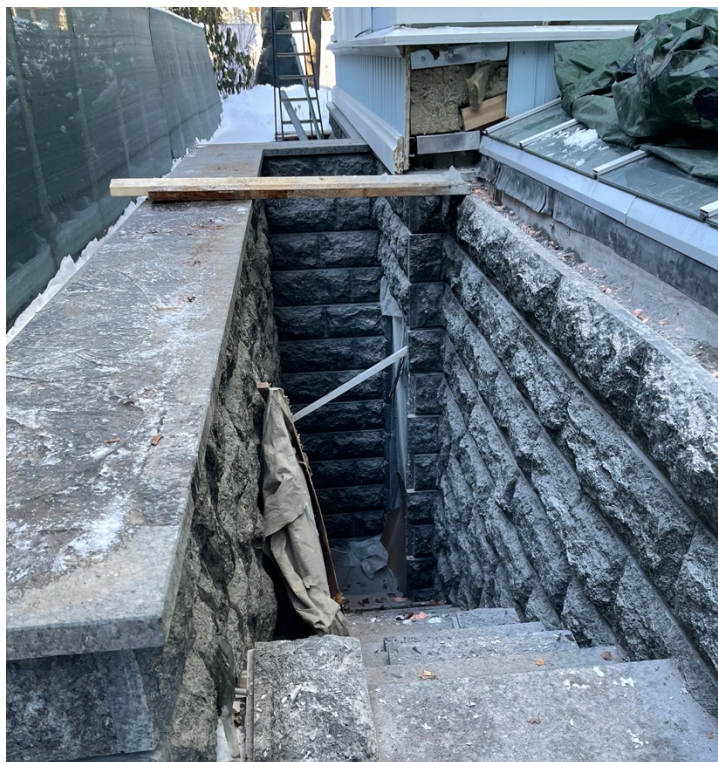
Фото №4. Западный фасад. Фрагмент зенитного фонаря.
