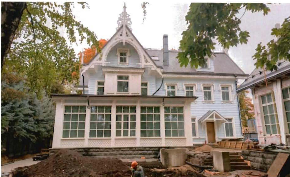
1. Вид на южный фасад.
