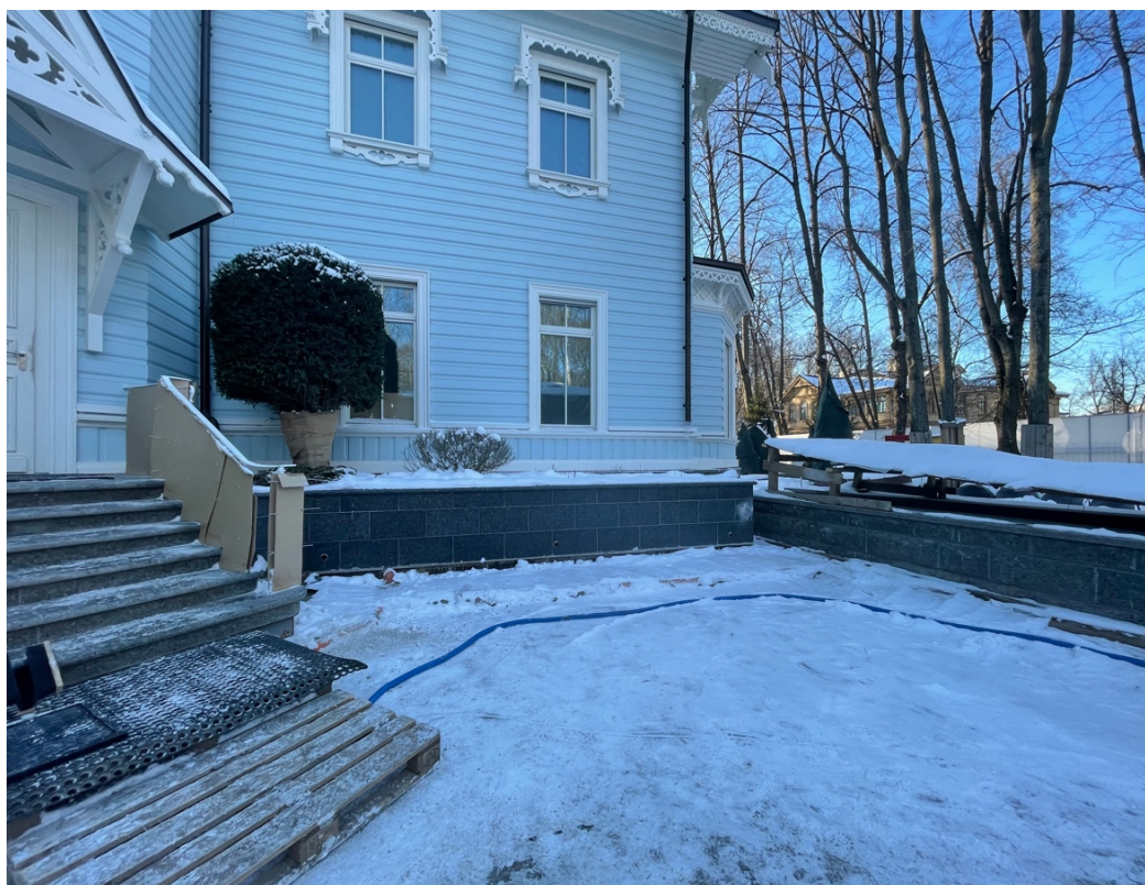
Фото №10. Восточный фасад. Фрагмент входной группы.
