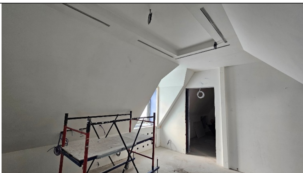
Фото №21. Общий вид мансардного этажа
