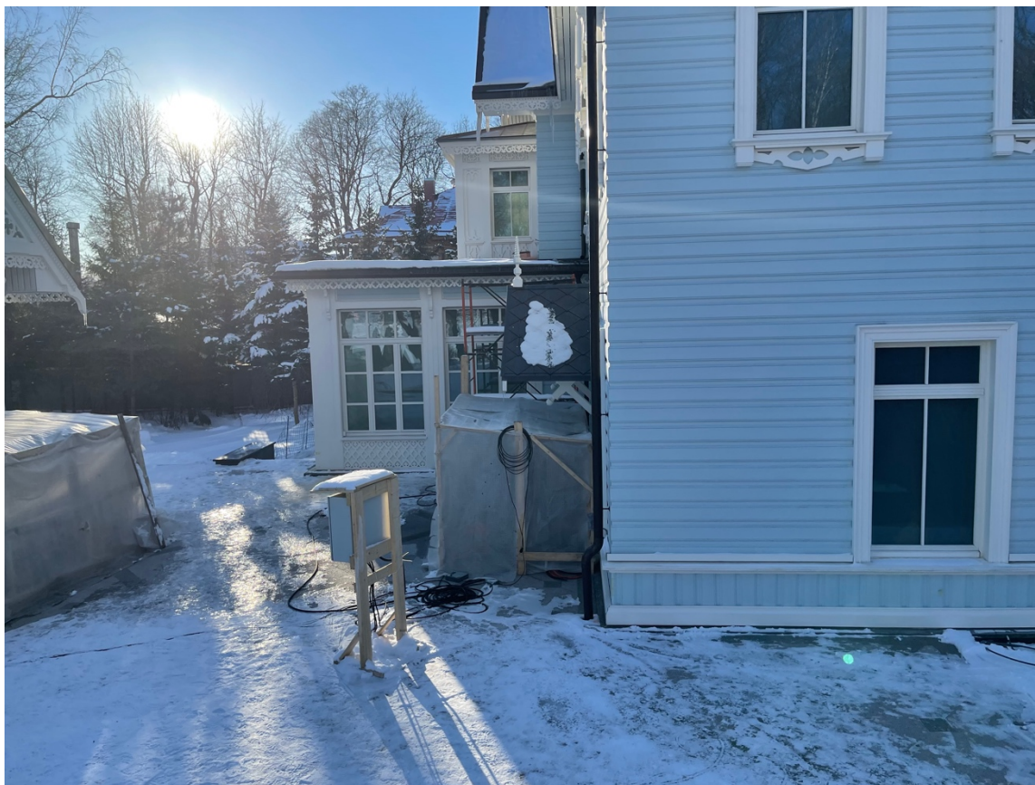
Фото №15. Северный фасад. Общий вид.
