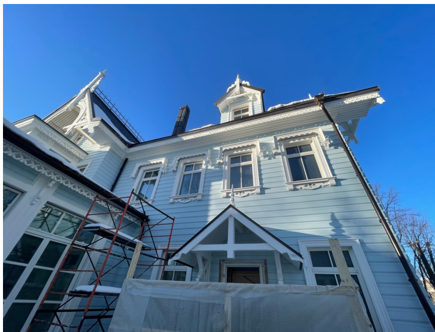
Фото №18. Восточный фасад. Фрагмент.
