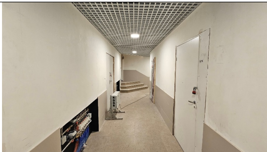
Фото №19. Общий вид помещения подвального этажа
