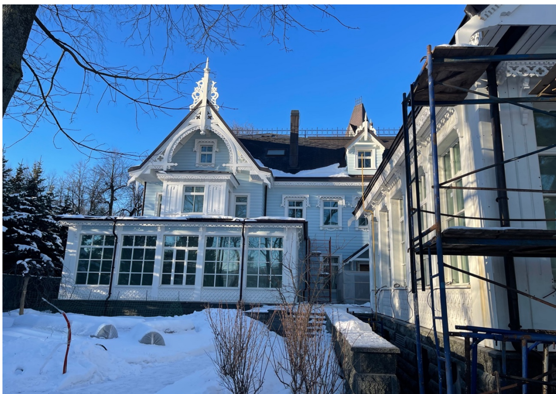
Фото №12. Южный фасад. Общий вид.
