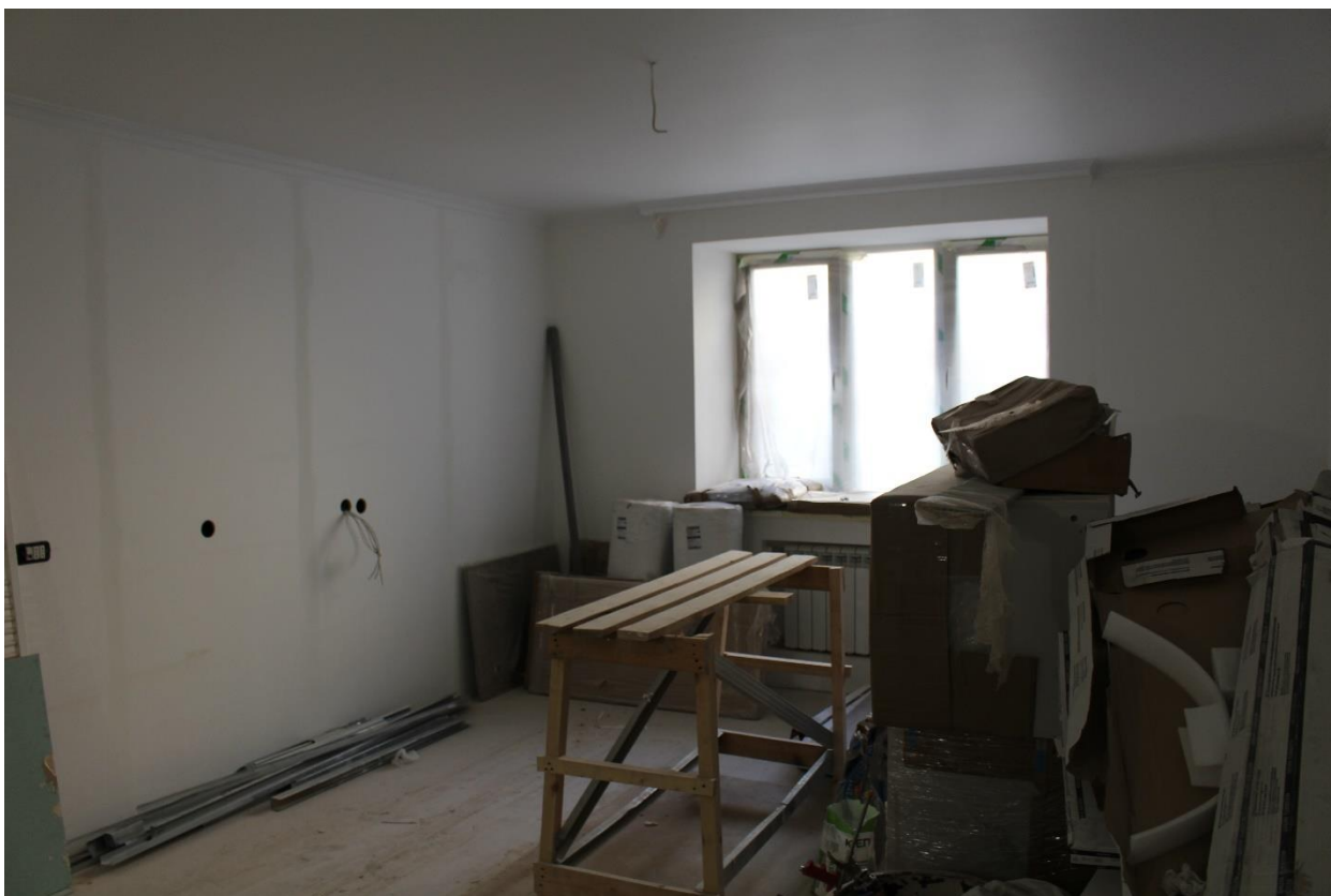
Фото 17. Вид на помещения № 2, 6.
