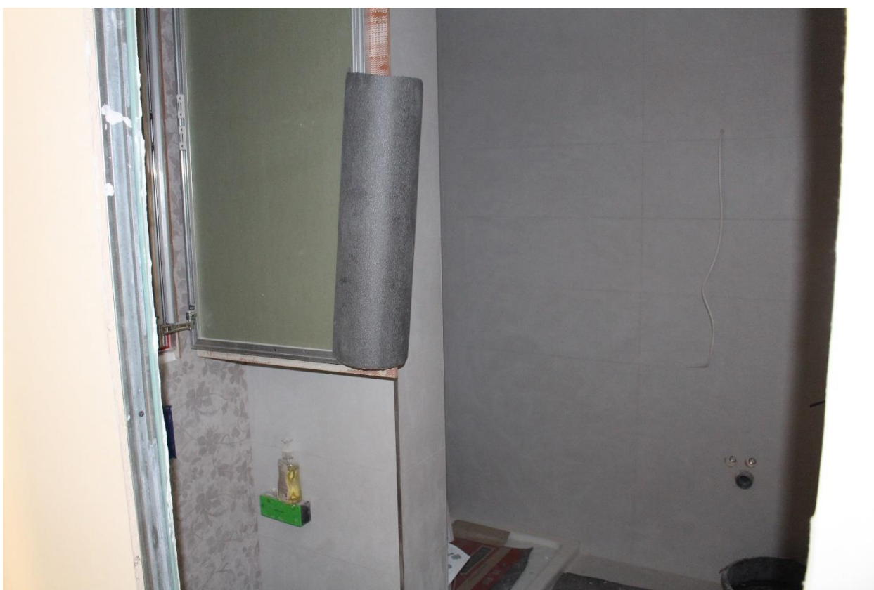
Фото 16. Вид на помещение № 9.
