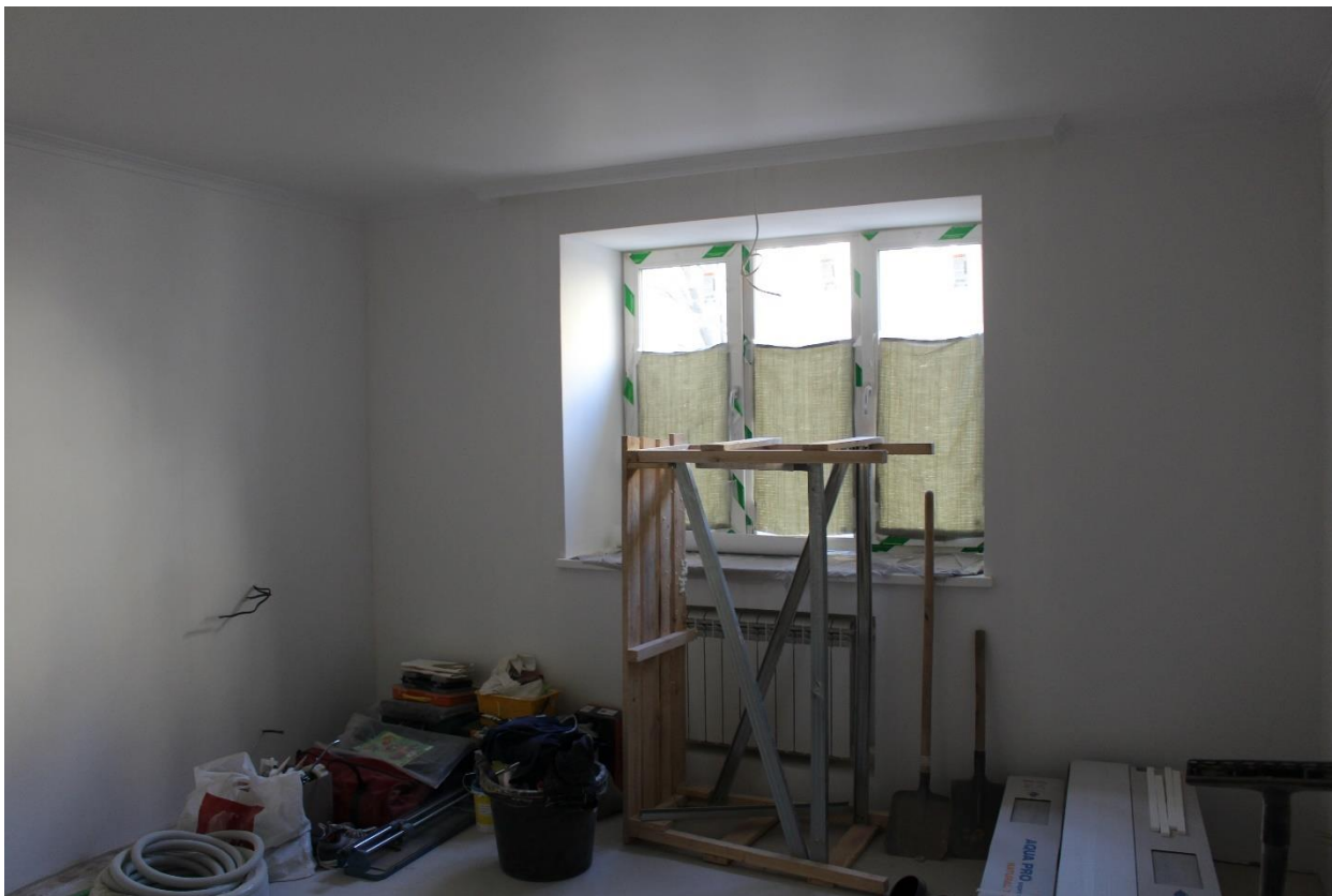
Фото 23. Вид на помещение № 3.
