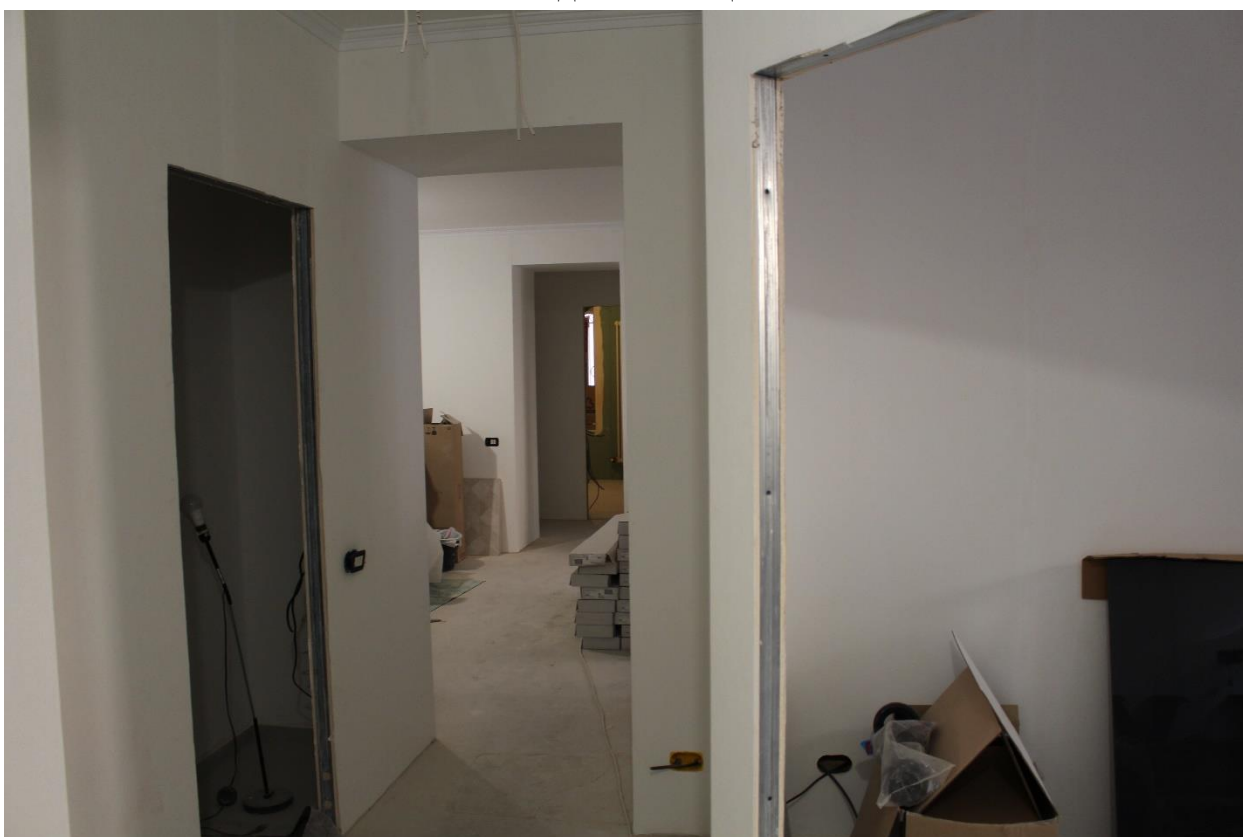
Фото 13. Вид на помещение № 7.
