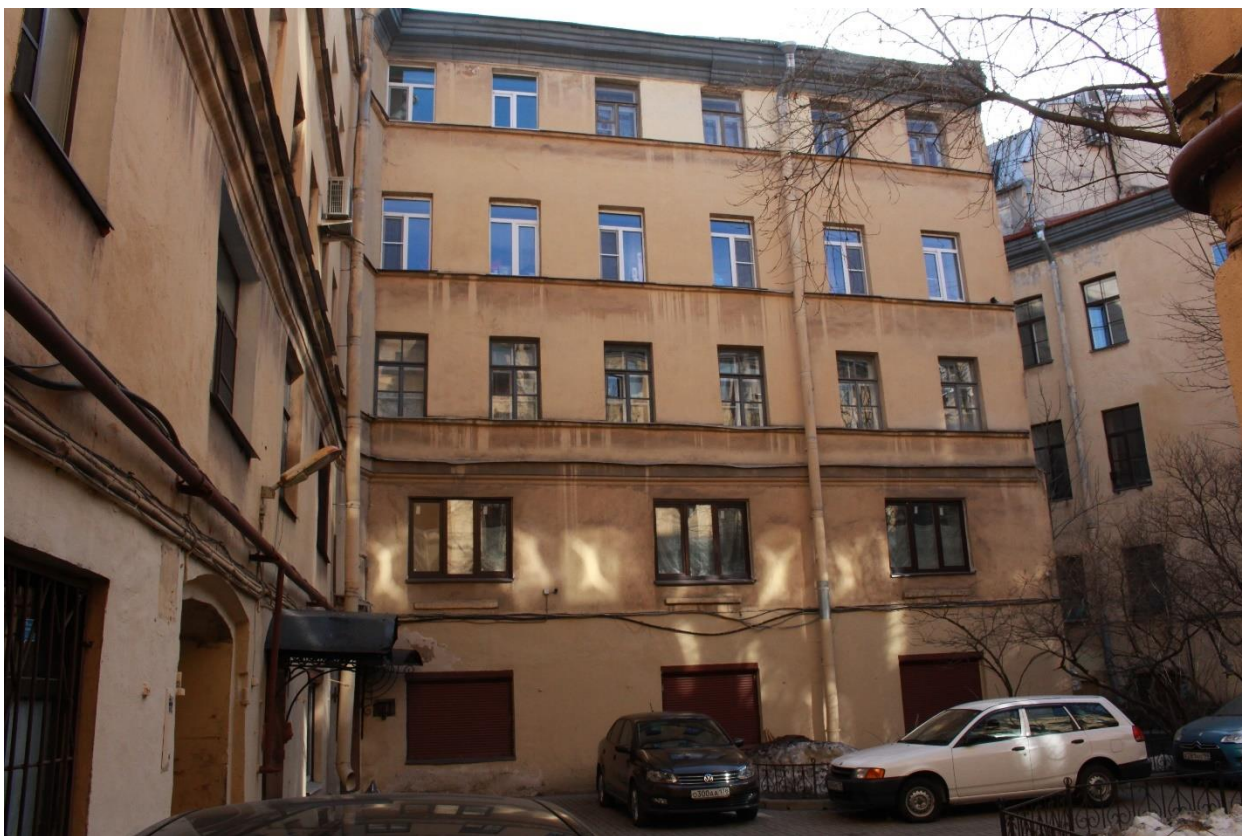
Фото 5. Вид на дворовой фасад объекта культурного наследия, на втором этаже которого расположены окна квартиры № 45.
