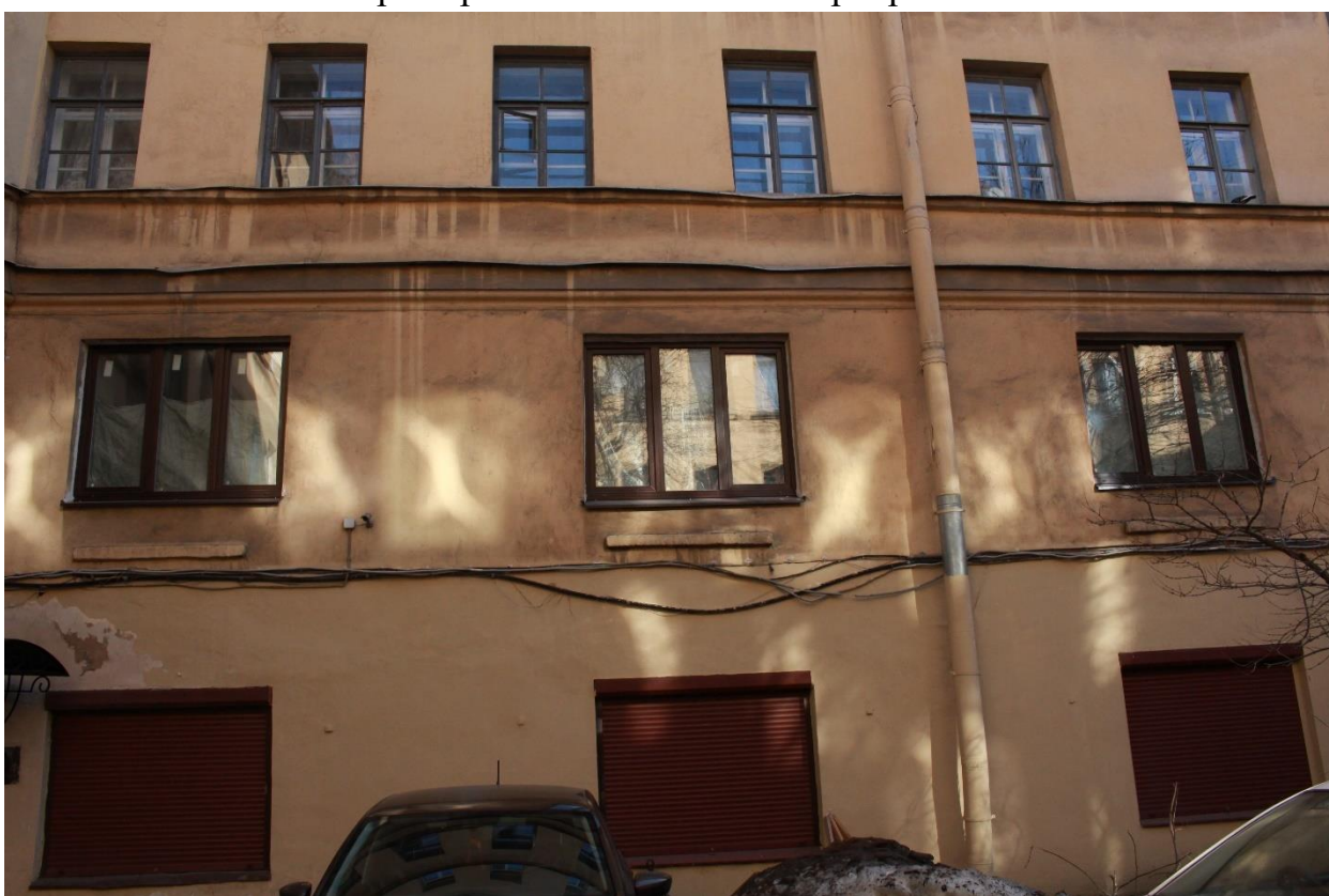
Фото 6. Фрагмент дворового фасада объекта культурного наследия, на втором этаже которого расположены окна квартиры № 45.
