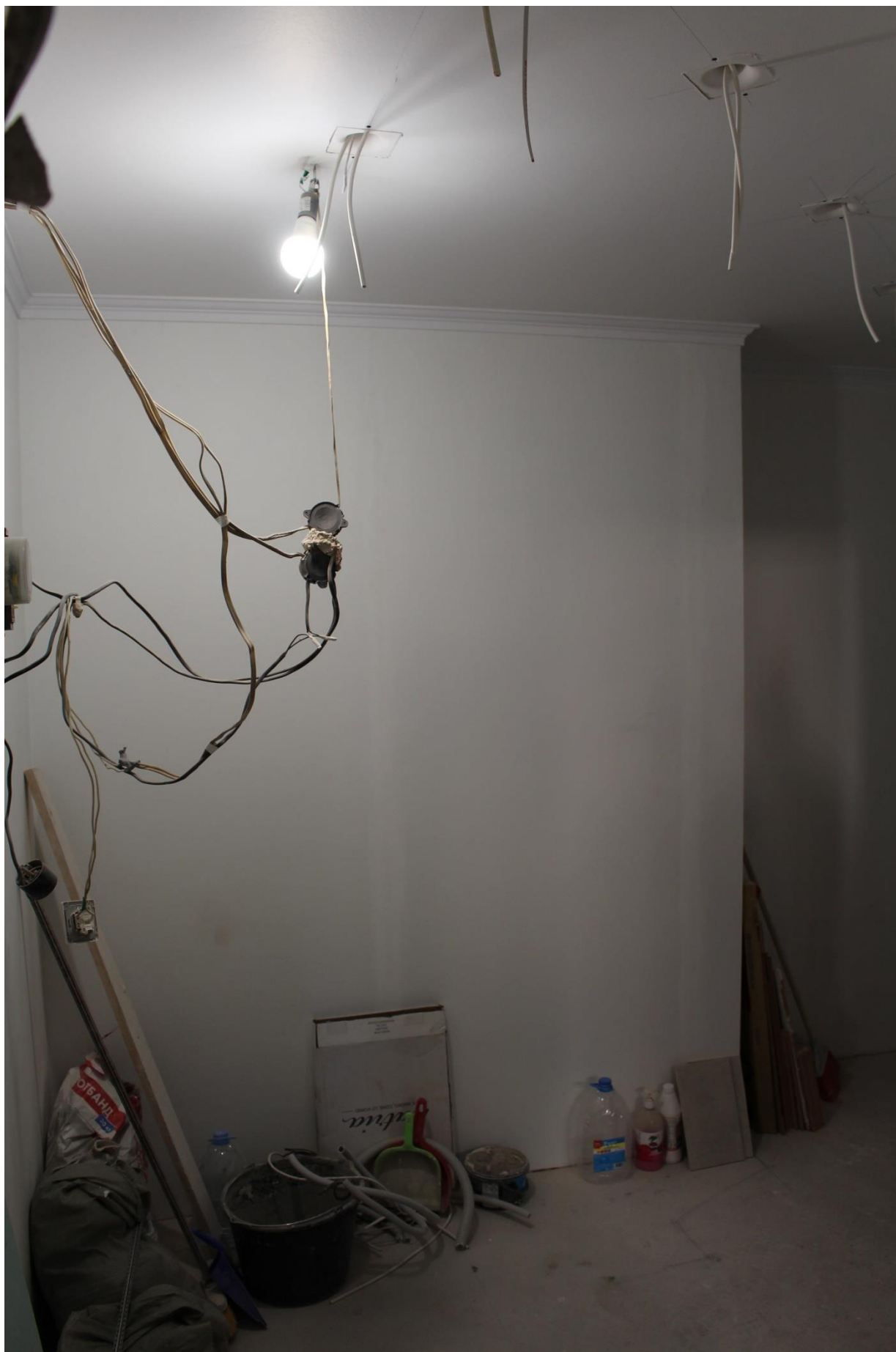
Фото 14. Вид на помещение № 7.
