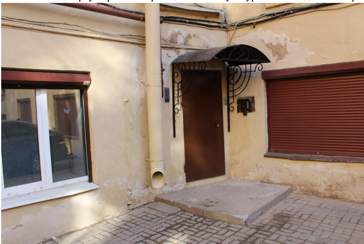
Фото 8. Вид на входную дверь парадной объекта культурного наследия, ведущей в квартиру № 45.
