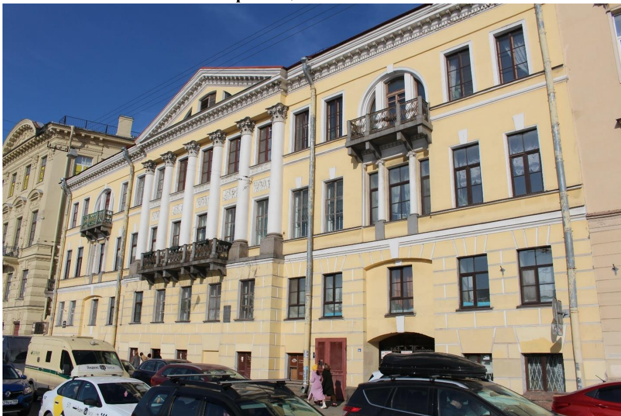
Фото 1. Вид на лицевой фасад объекта культурного наследия по наб. реки Фонтанки.
