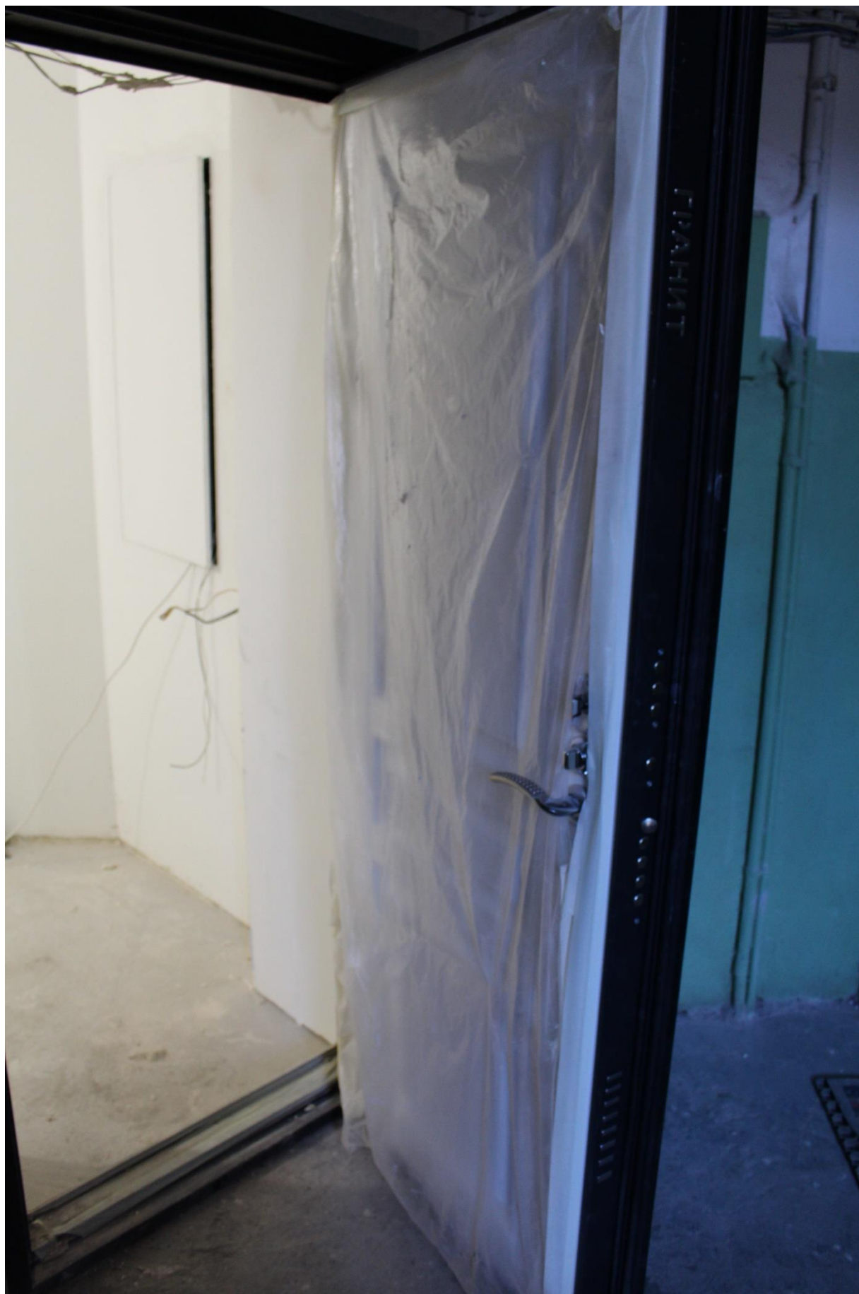
Фото 11. Вид на входную дверь и помещение № 7.
