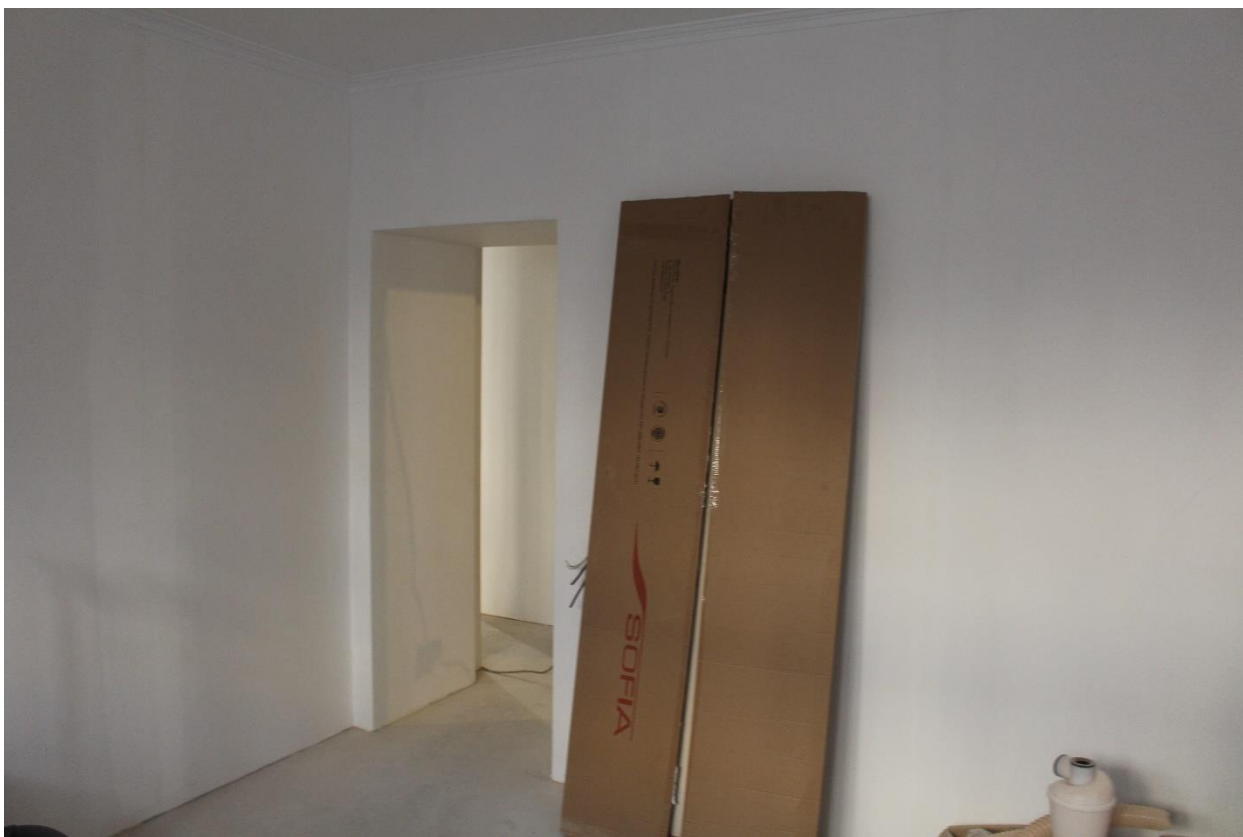
Фото 24. Вид на помещение № 3.
