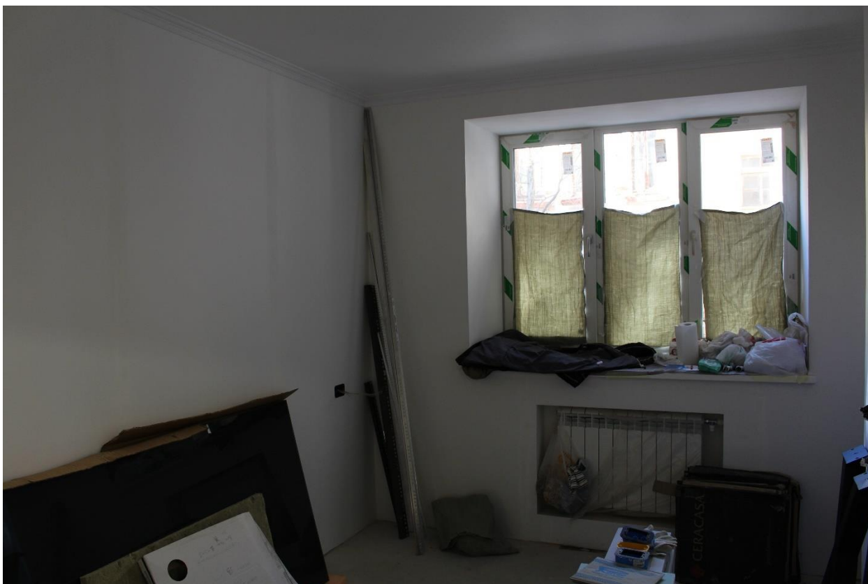
Фото 15. Вид на помещение № 1.
