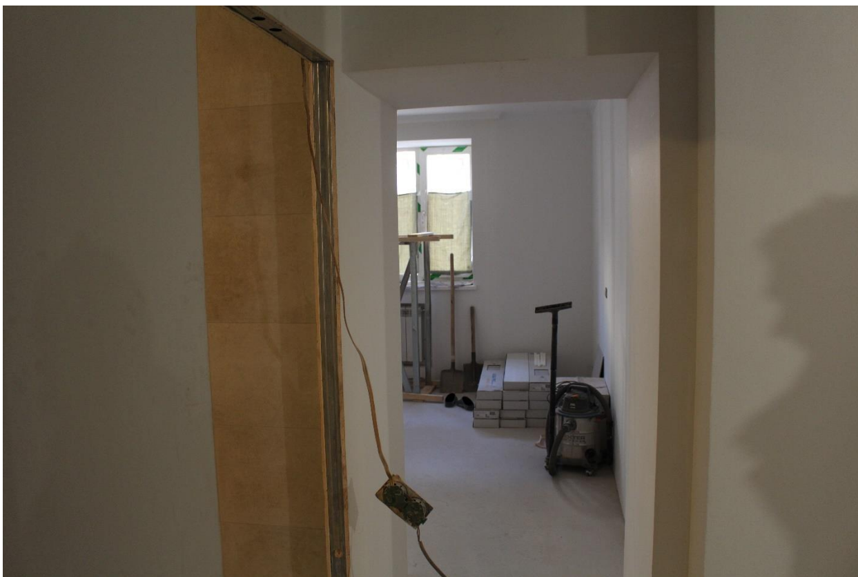
Фото 21. Вид на помещение № 3.
