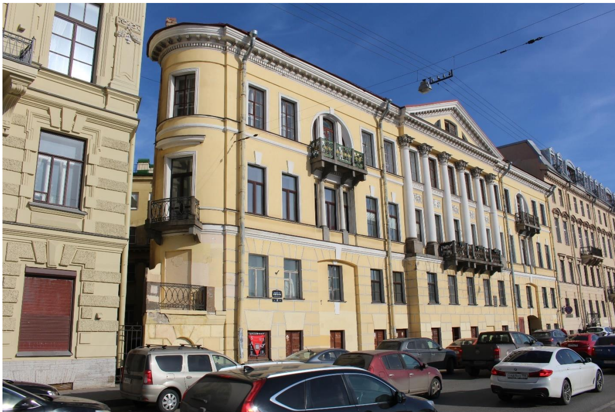
Фото 2. Вид на лицевой фасад объекта культурного наследия по наб. реки Фонтанки.
