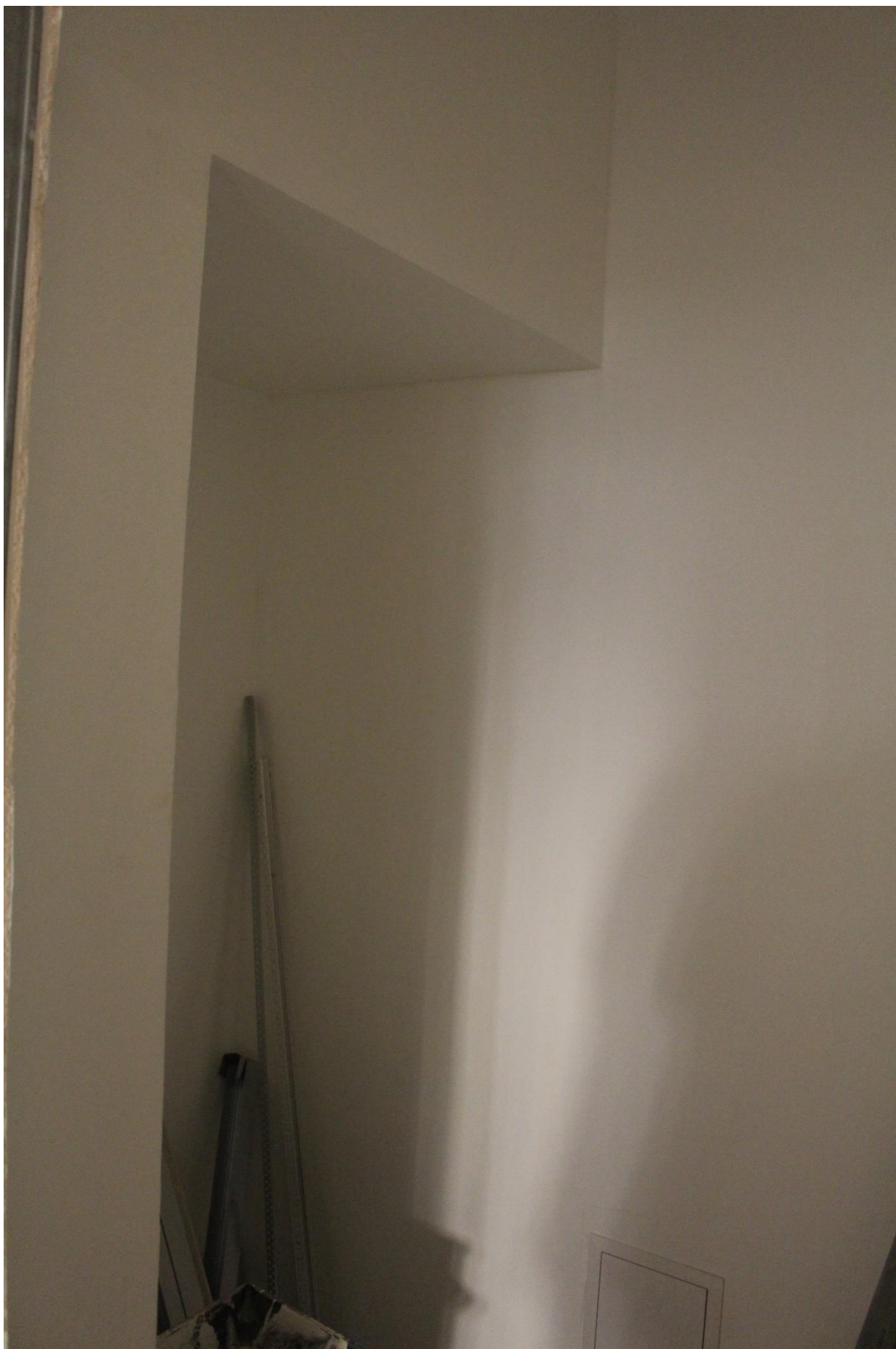
Фото 22. Вид на проем между помещениями 5, 6.
