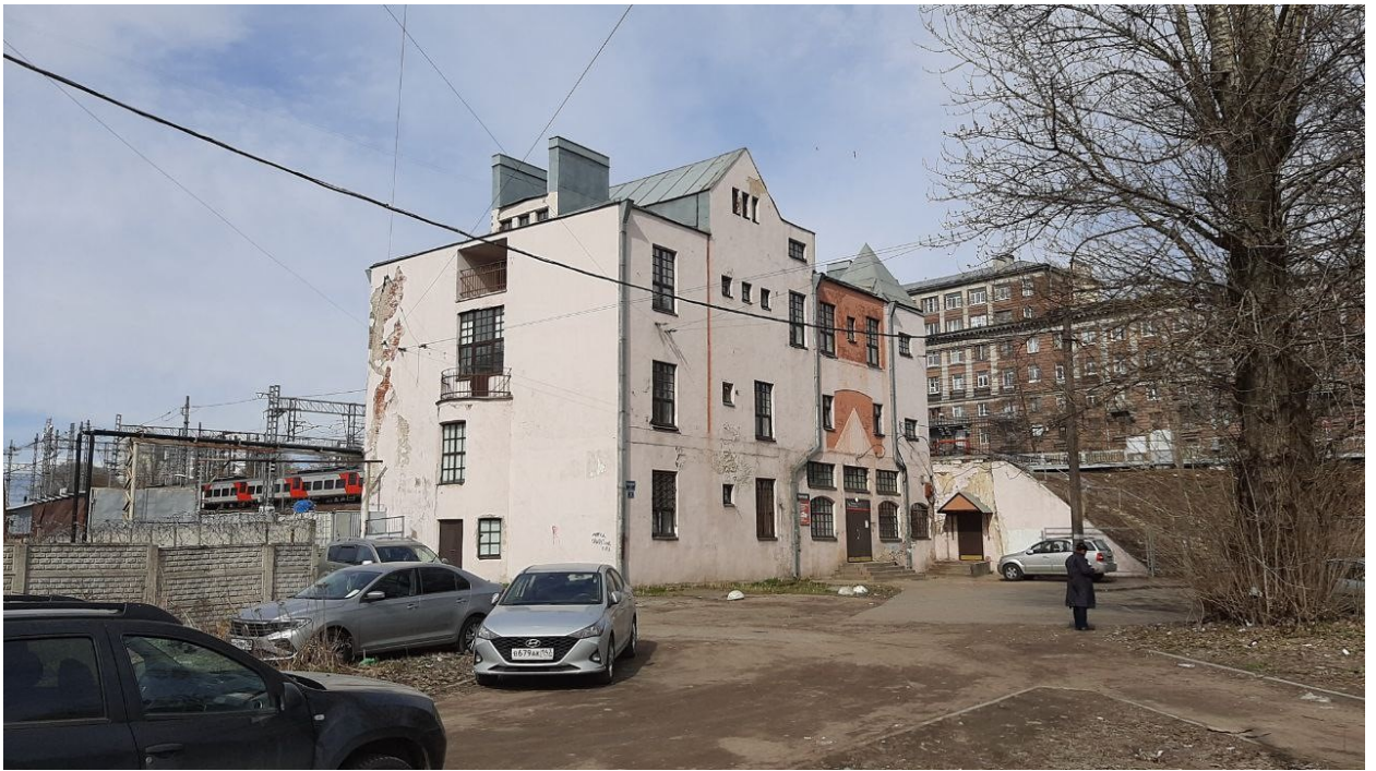
1. «Вокзал железнодорожной станции Ланская». Общий вид.
