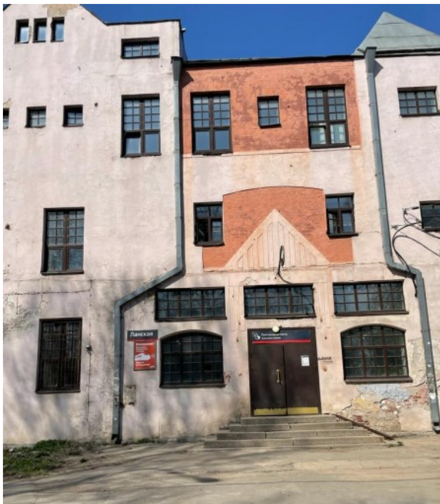
3. «Вокзал железнодорожной станции Ланская». Лицевой фасад. Фрагмент.
