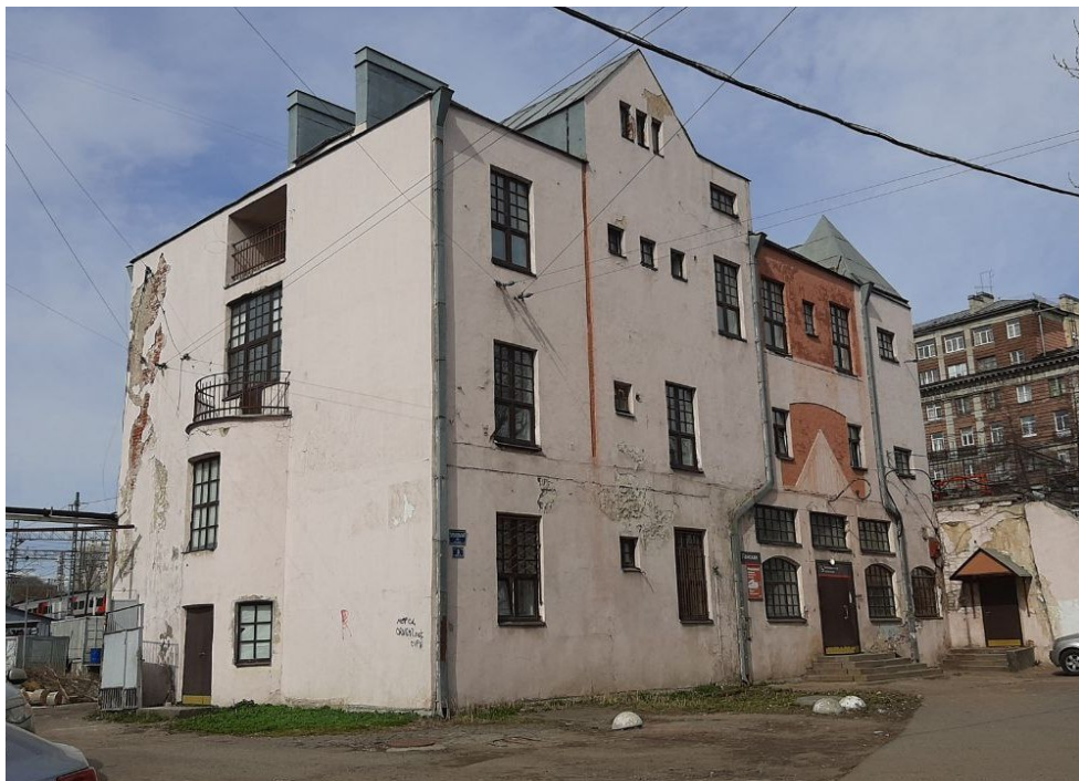
2. «Вокзал железнодорожной станции Ланская». Лицевой (южный) и западный фасады.
