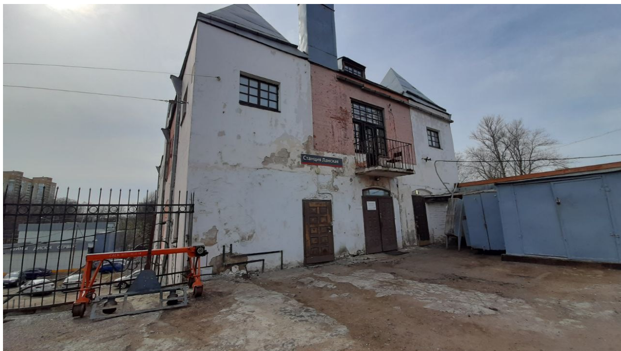
4. «Вокзал железнодорожной станции Ланская». Восточный фасад.
