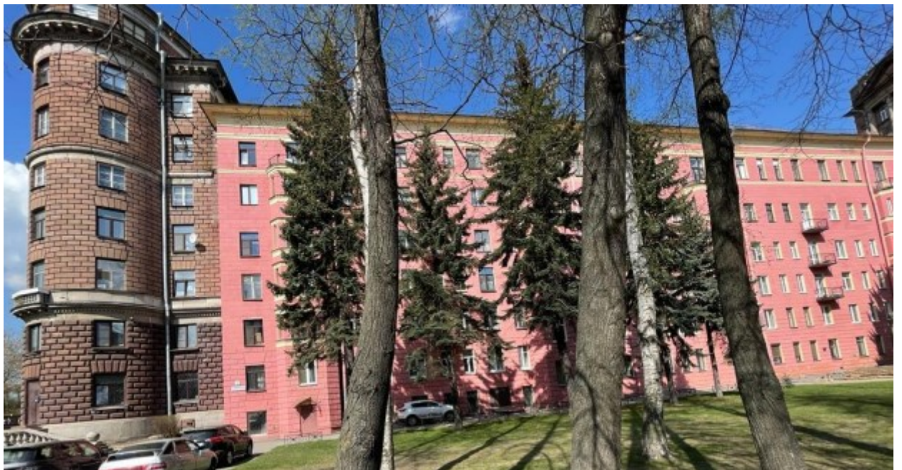
8. «Дом, где в октябре 1917 г. жил Ленин В.И.». Фрагмент левой части лицевого фасада.
