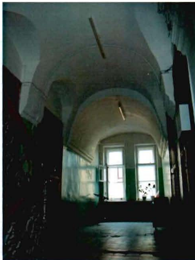
Фото 16. Вестибюль 2-го этажа. Цилиндрические своды с распалубками.
