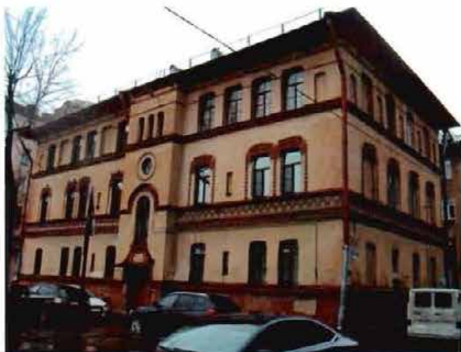
Фото 9. Вид на восточный и северный фасады.
