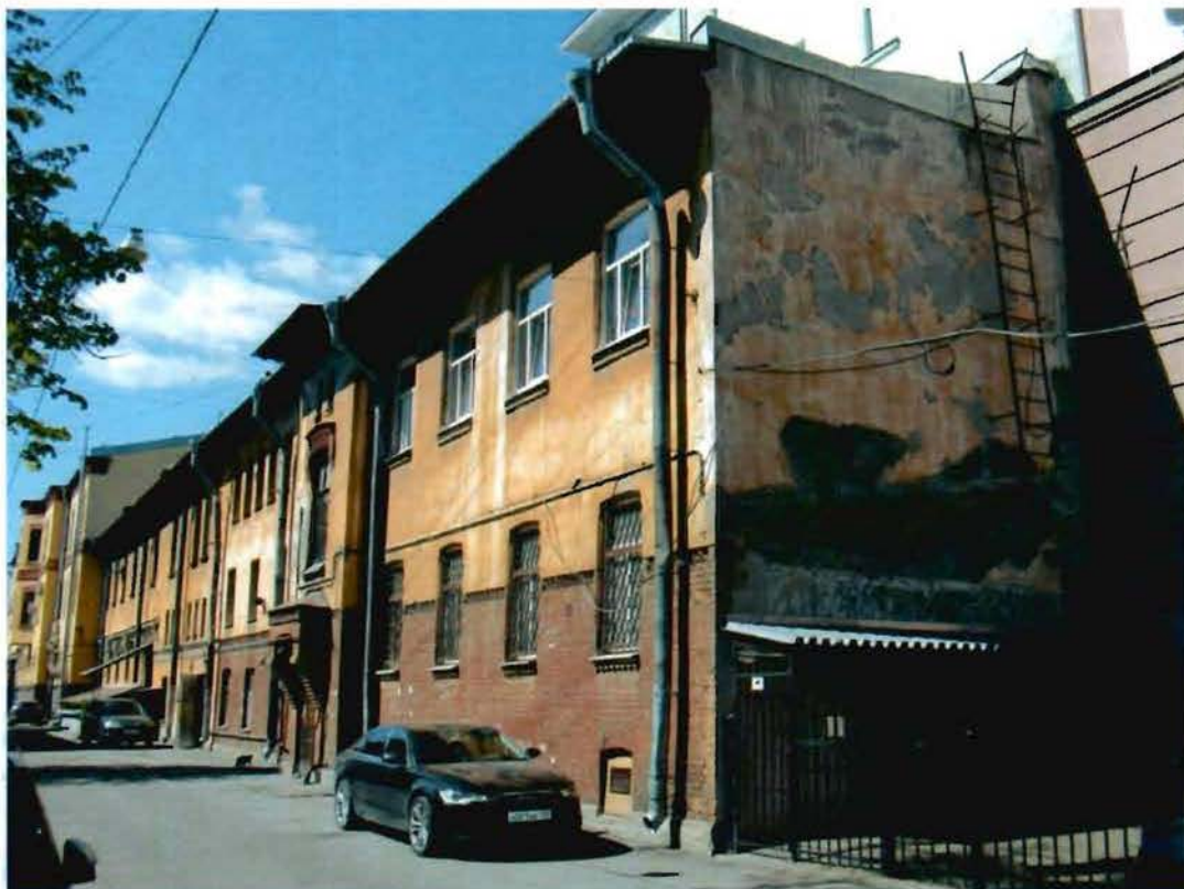
Фото 34. Вид на южный и восточный фасады.
