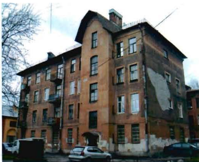
Фото 1. Вид на западный и южный фасады.
