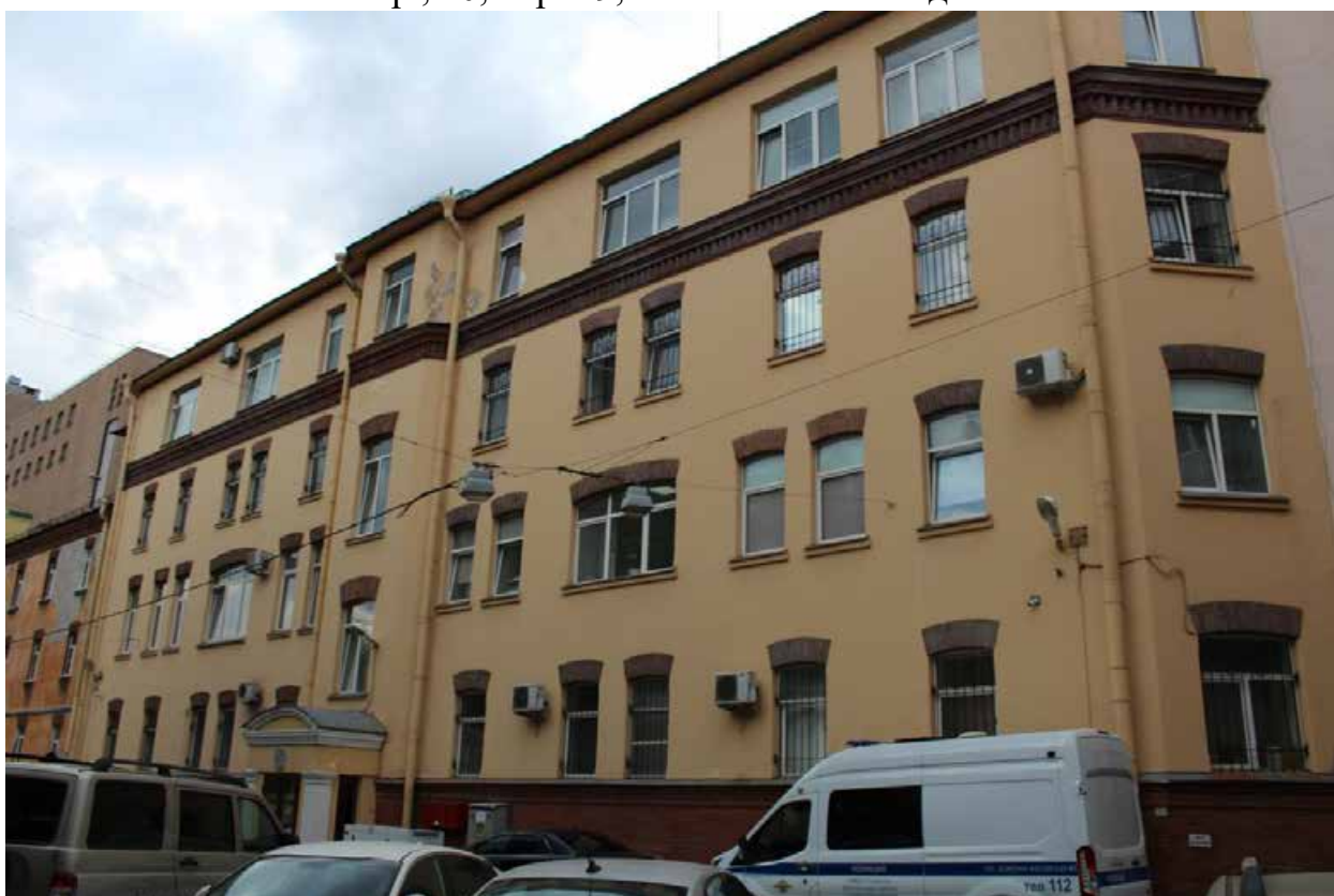
Фото 6. Вид на лицевой фасад жилого дома по адресу: Санкт-Петербург, Лесной пр., 20, корп. 9, лит. Ж с юго-востока.
