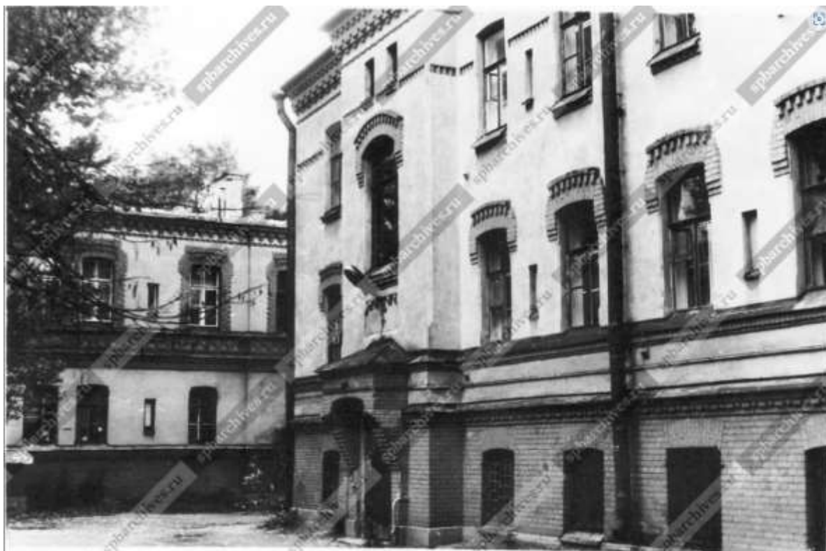
Илл. 56. Вид малоэтажных жилых домов в квартале, ограниченном Лесным и Большим Сампсониевским проспектами. На переднем плане дом 20 корп. 3. 03.07.2004 г. (источник: ЦГАКФФД СПб. Фотодокумент Ар 222387).
