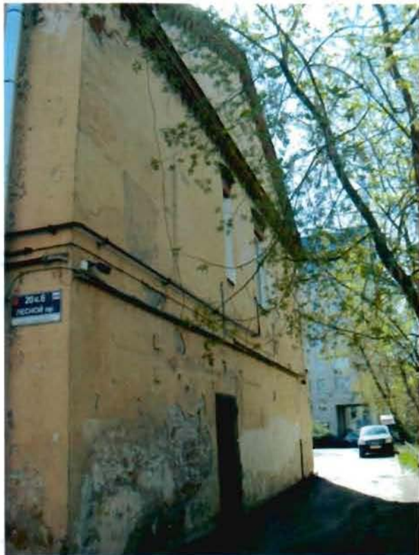
Фото 22. Вид на западный фасад.
