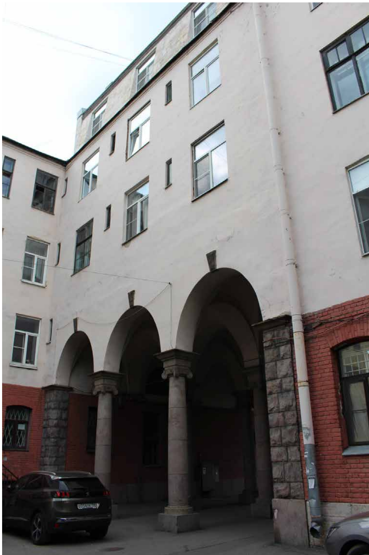
Фото 8. Вид на арку воротного проезда со стороны двора.
