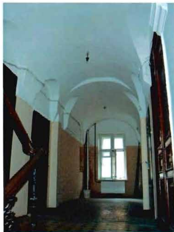
Фото 12. Вестибюль 2-го этажа. Цилиндрические своды с распалубками.
