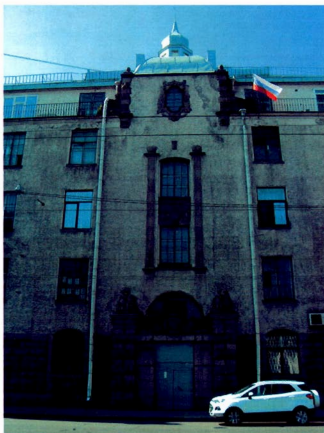
Фото 2. Вид на восточный фасад. Фрагмент.
