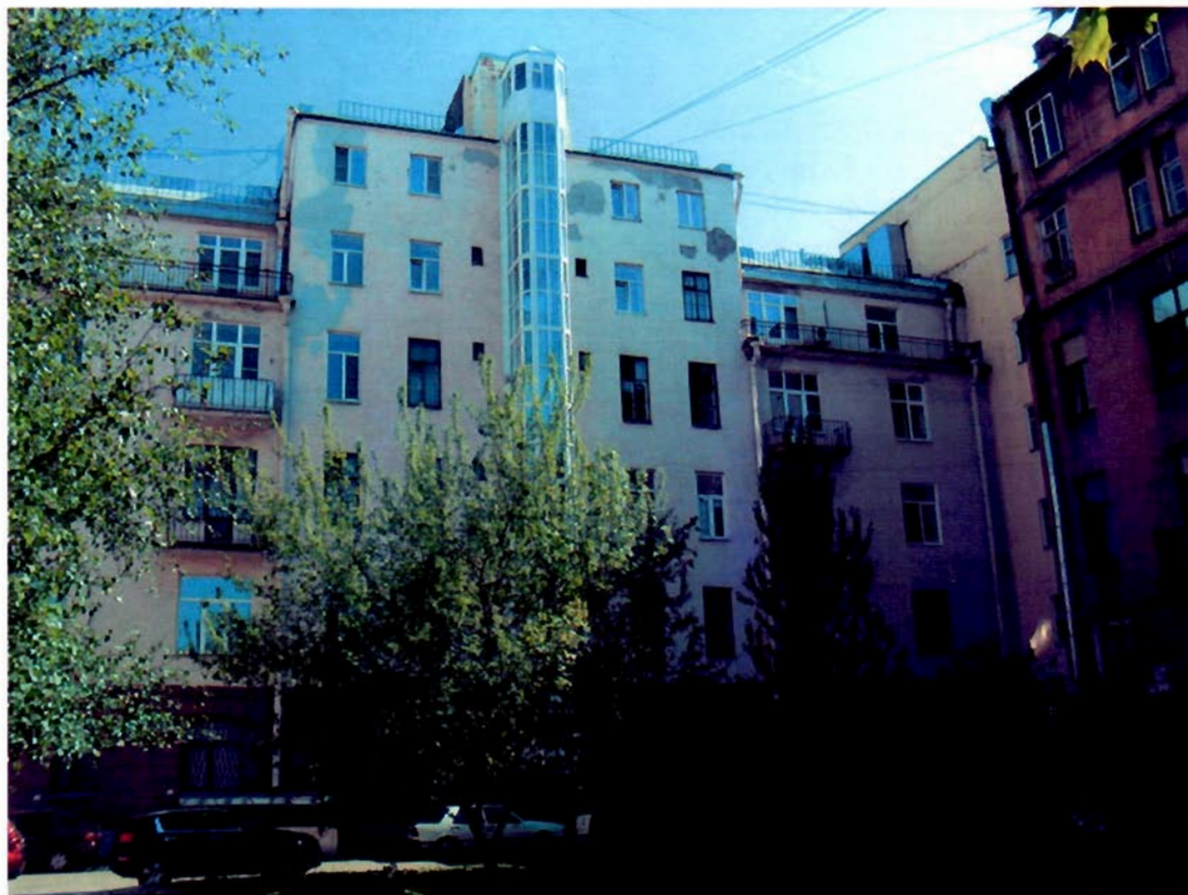
Фото 3. Вид на западный фасад. Фрагмент.
