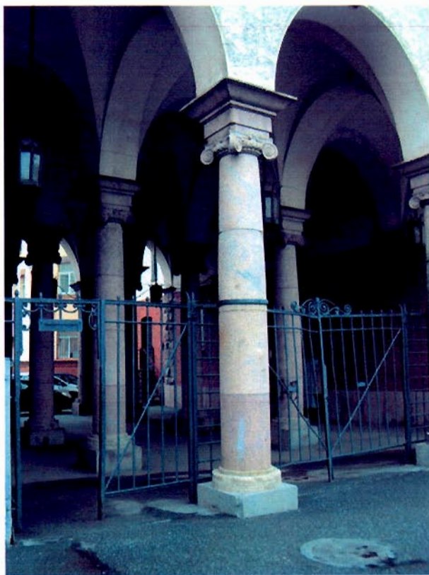
Фото 6. Ограда с калитками и воротами. Фрагмент.
