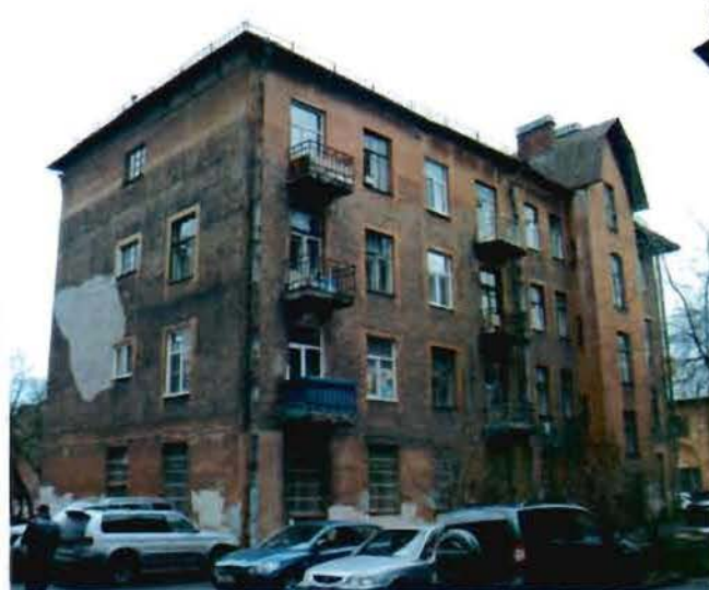
Фото 2. Вид на восточный и южный фасады.
