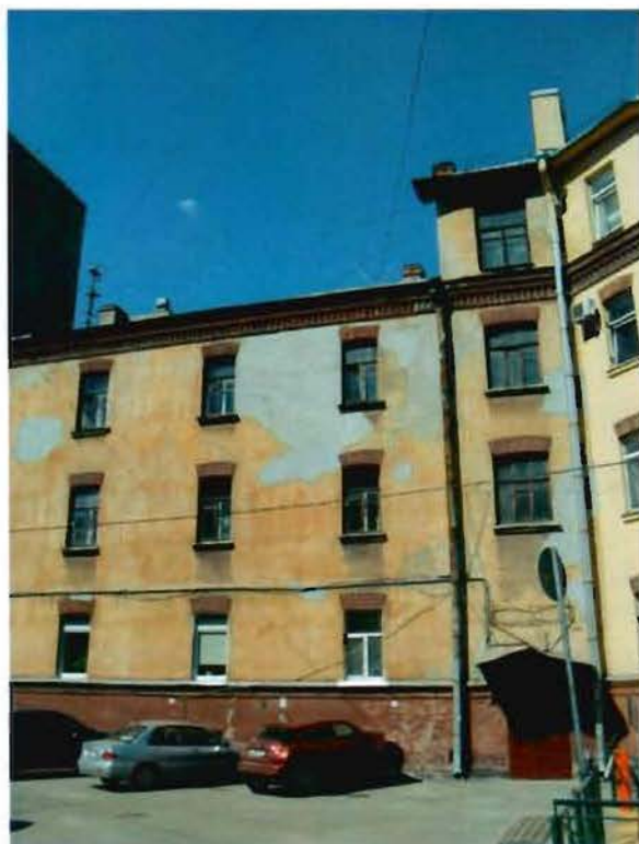
Фото 32. Вид на южный фасад. Фрагмент.
