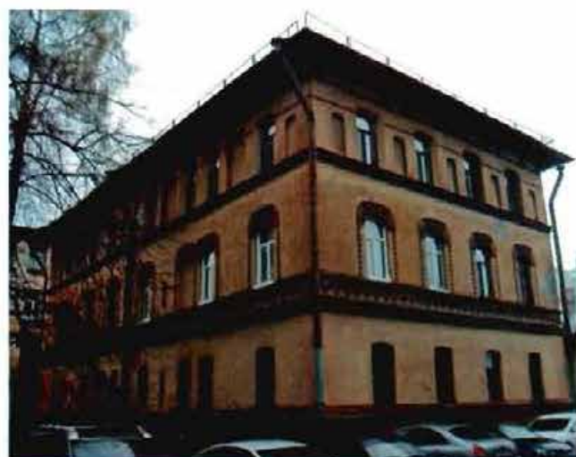
Фото 10. Вид на западный и южный фасады.
