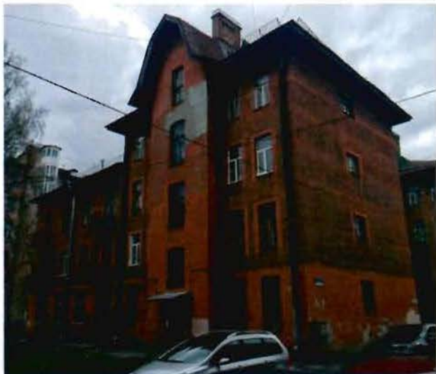
Фото 5. Вид на восточный и северный фасады.
