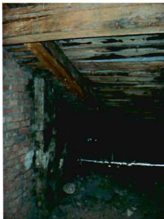
Фото 4. Чердачные помещения. Фрагмент.
