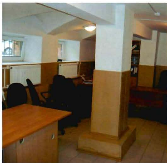
Фото 30. Пилоны в уровне подвального этажа. Фрагмент.
