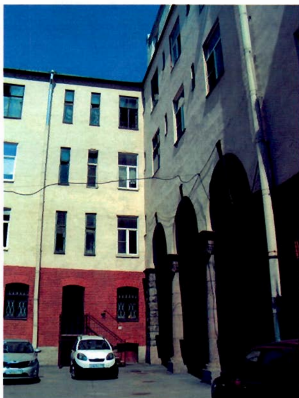
Фото 4. Вид на западный и южный фасады.
