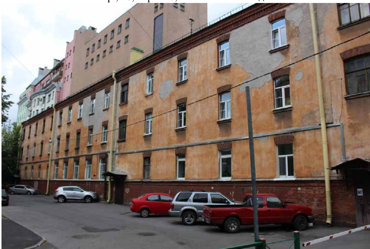
Фото 4. Вид на лицевой фасад жилого дома по адресу: Санкт-Петербург, Лесной пр., 20, корп. 10, лит. Е с юго-востока.
