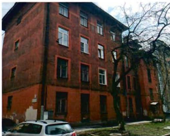
Фото 6. Вид на западный и северный фасады.
