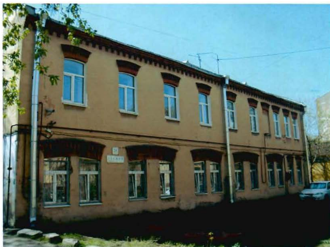
Фото 21. Вид на северный фасад.
