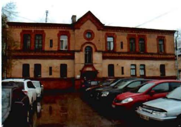
Фото 13. Вид на западный фасад.
