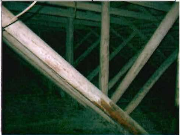
Фото 88. Конструкции крыши. Общий вид.
