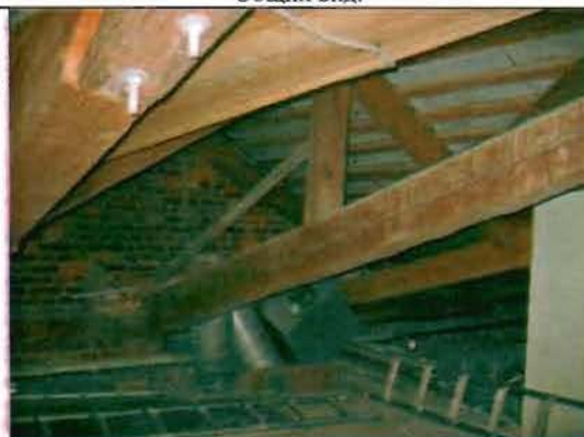
Фото 77. Конструкции крыши. Общий вид.
