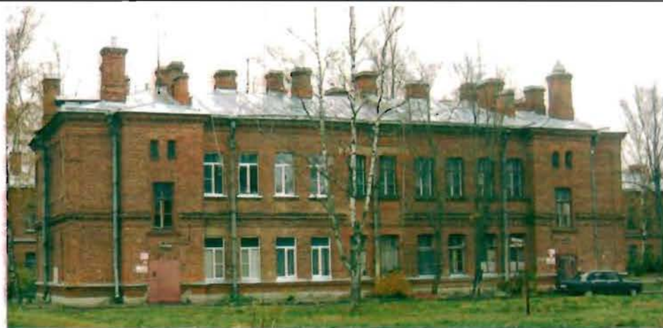
Фото 158. Восточный фасад. Общий вид.
