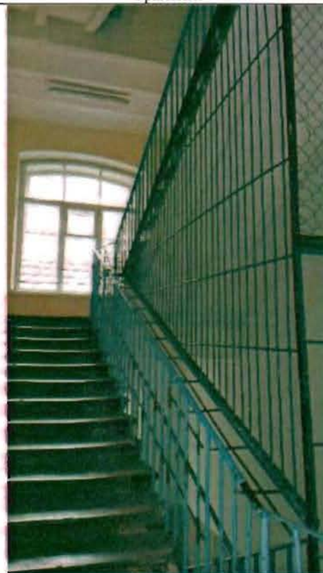
Фото 61. Интерьер. Лестница в южной части здания. Фрагмент.
