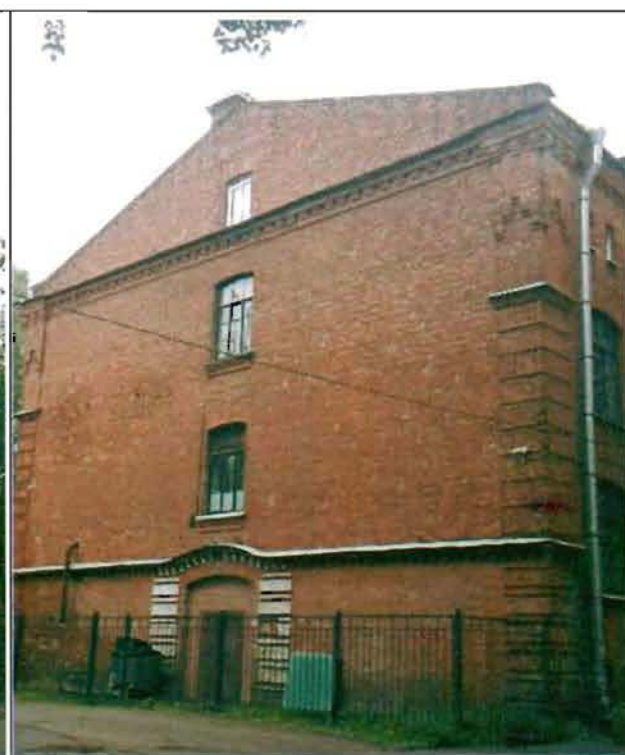
Фото 50. Южный фасад. Общий вид.
