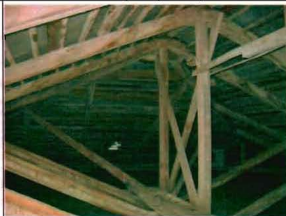
Фото 82. Конструкции крыши. Общий вид.
