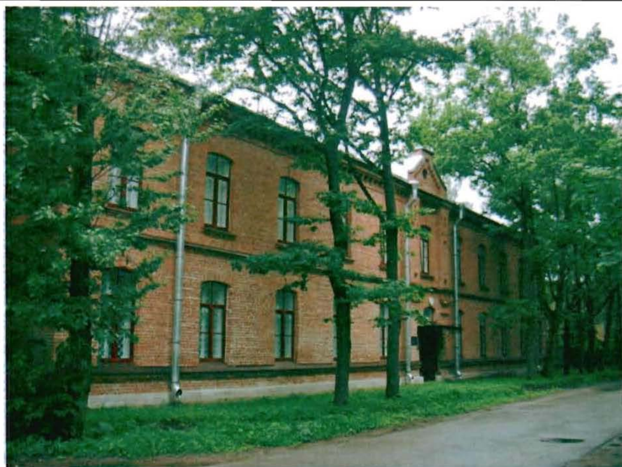
Фото 39. Восточный фасад. Общий вид.
