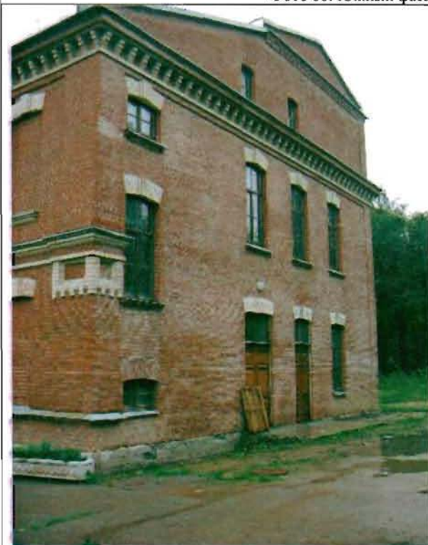
Фото 67. Западный фасад. Общий вид.
