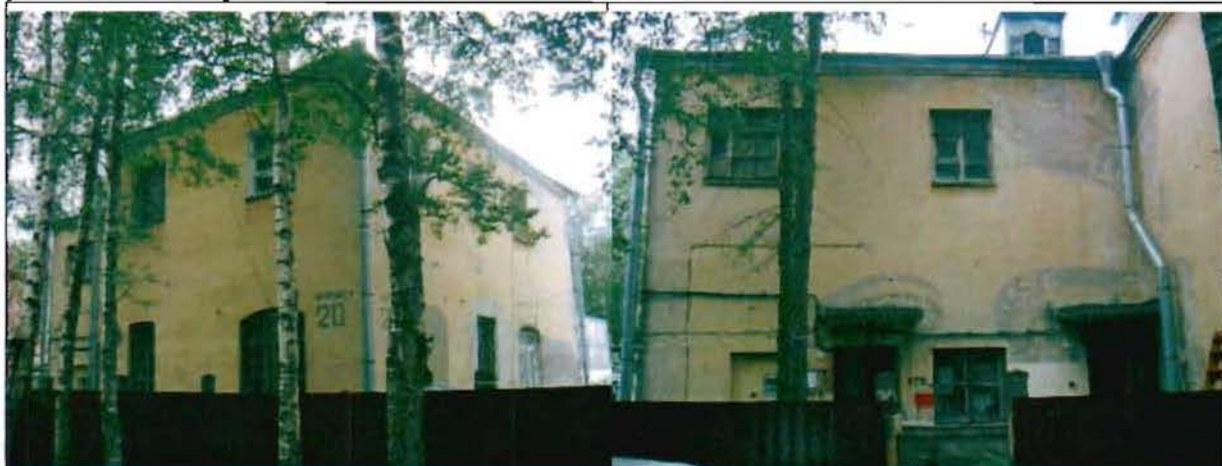
Фото 43. Северный, восточный фасады. Общий вид.
