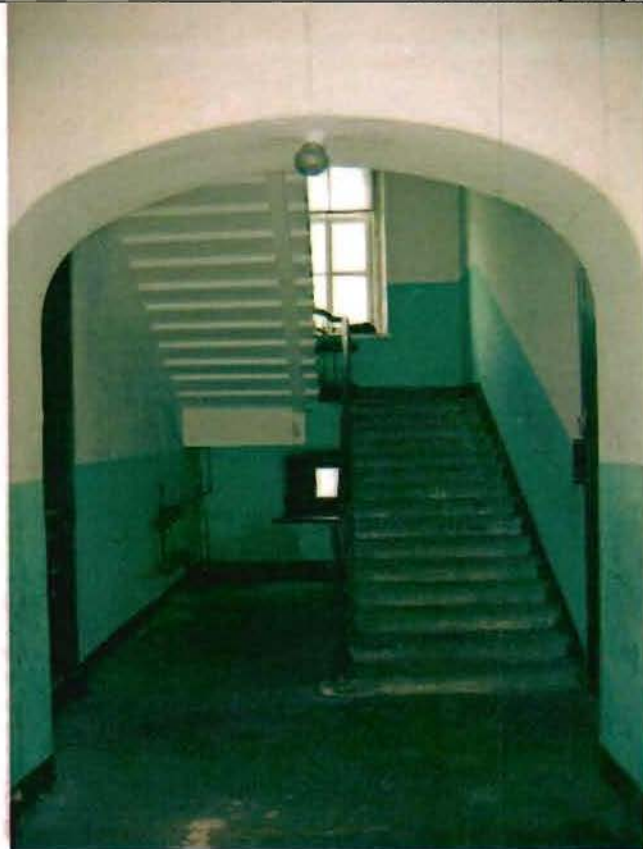
Фото 181. Парадная лестница в центральной части здания. Общий вид.
