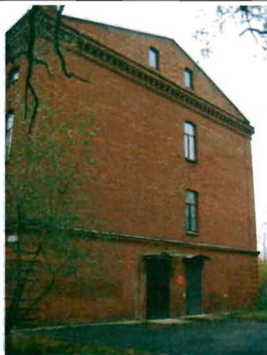
Фото 16. Южный фасад. Общий вид.
