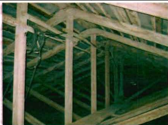
Фото 81 Конструкции крыши. Общий вид.
