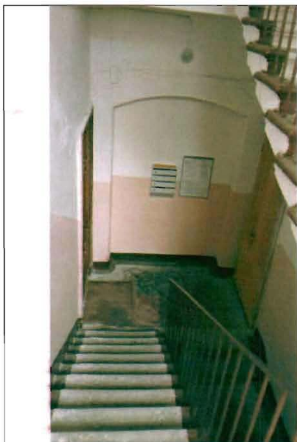
Фото 130. Лестница № 1 в южной части здания. Общий вид.
