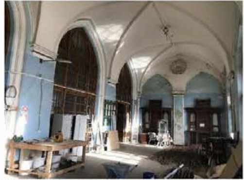
1 этаж. Кассовый зал
