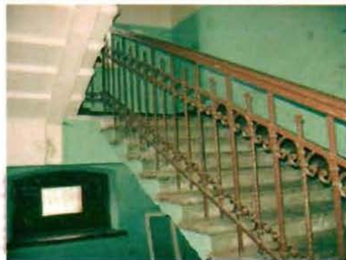
Фото 182. Парадная лестница в центральной части здания. Фрагмент.
