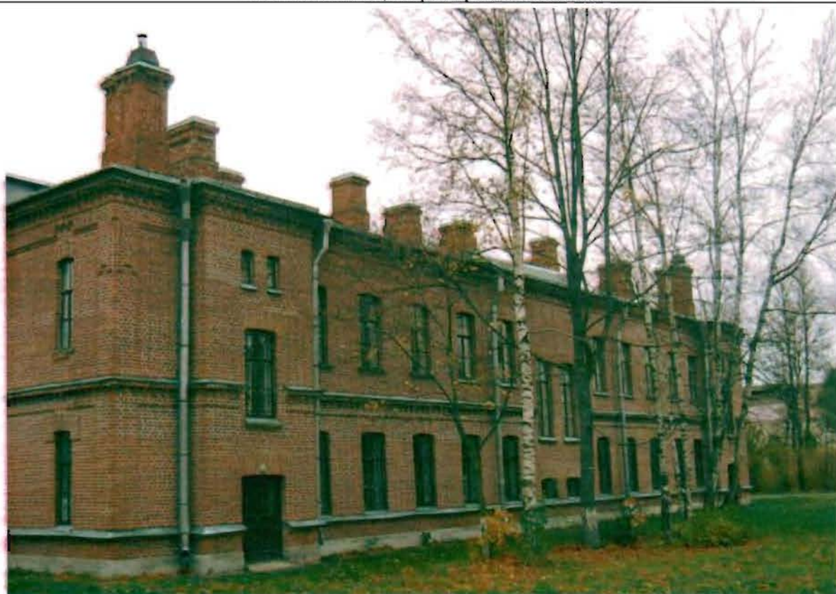
Фото 133. Восточный фасад. Общий вид.
