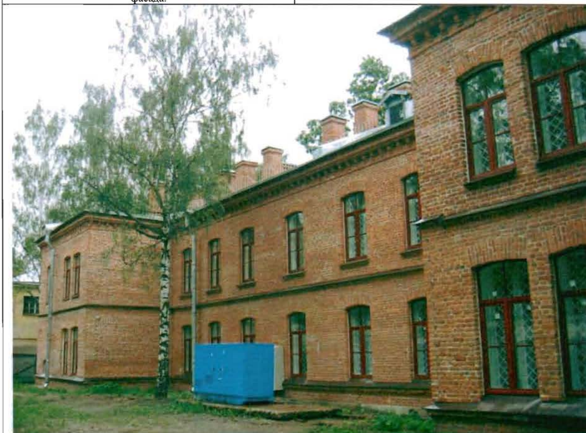
Фото 42. Западный фасад. Общий вид.
