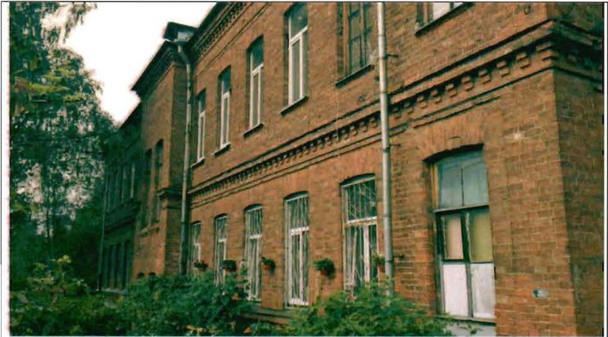
Фото 171. Восточный фасад. Общий вид.
