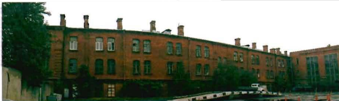
Фото 29. Западный фасад. Общий вид.
