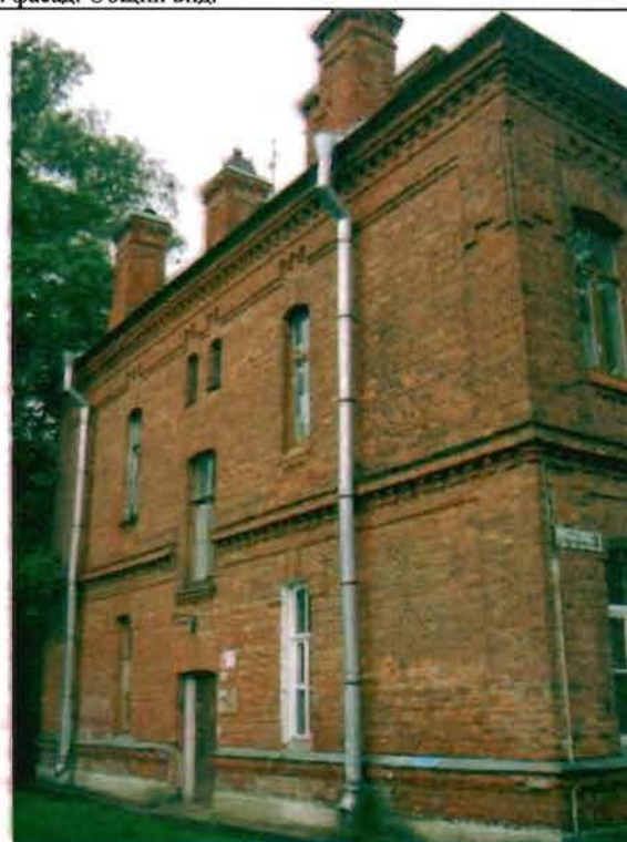
Фото 148. Северный фасад. Общий вид.
