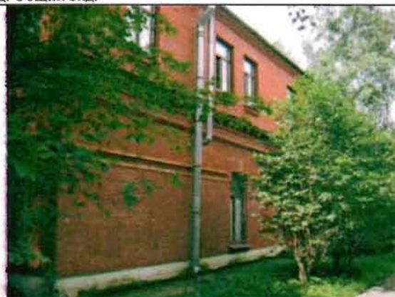
Фото 80. Северный фасад. Фрагмент.
