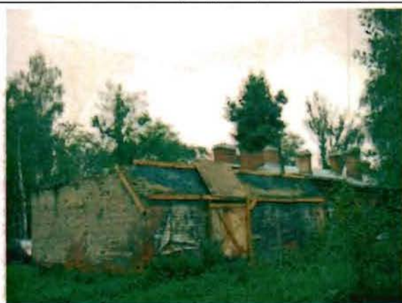
Фото 186. Западный, северный фасады. Общий вид.
