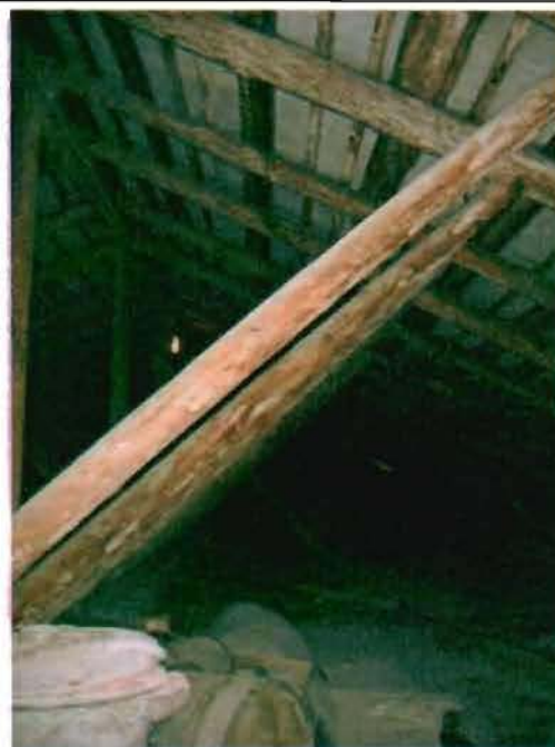
Фото 27. Конструкции крыши. Фрагмент.
