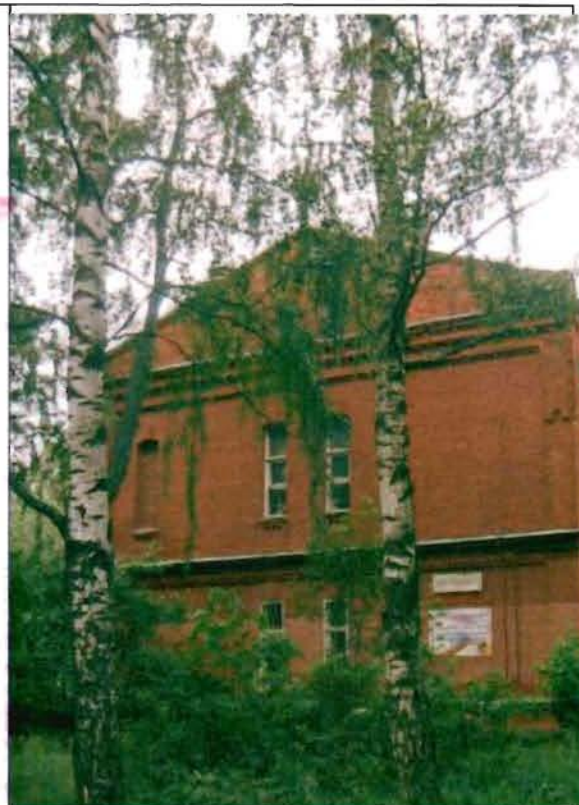
Фото 91. Северный фасад. Общий вид.
