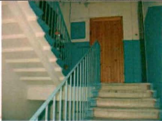
Фото 161. Лестница № 1 в южной части здания. Фрагмент.
