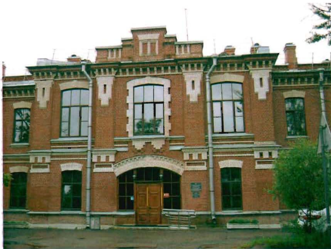
Фото 65. Северный фасад. Фрагмент центральной части фасада.
