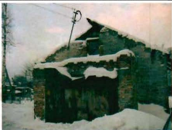
Фото 184. Восточный фасад. Общий вид. 14.01.2015.
