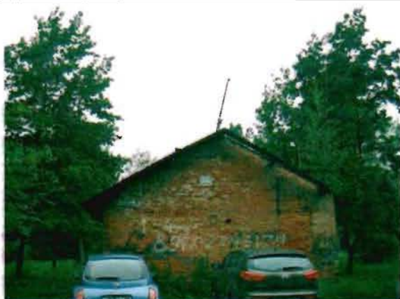
Фото 94. Восточный фасад. Общий вид.
