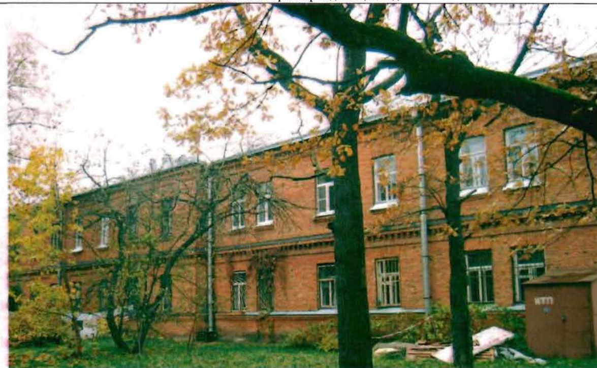
Фото 84. Южный фасад. Общий вид.
