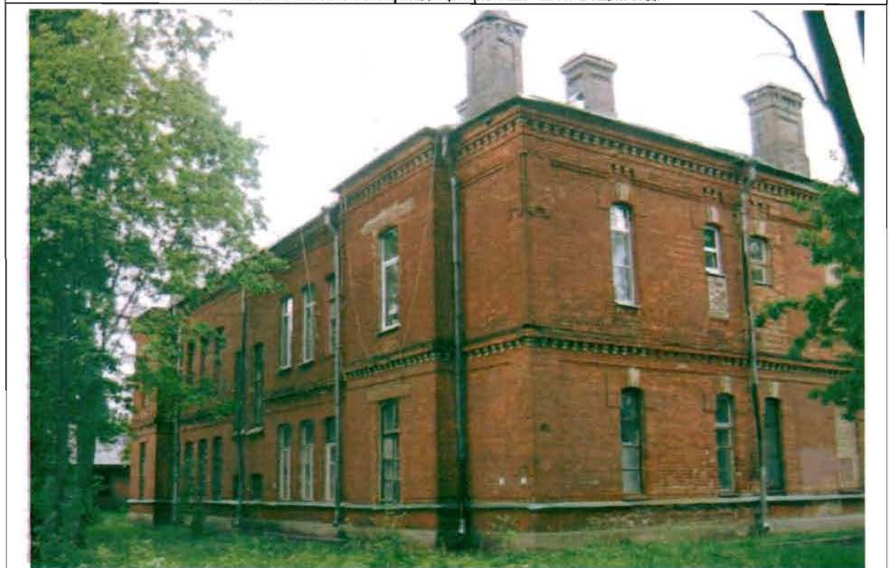
Фото 105. Западный, южный фасады. Общий вид.
