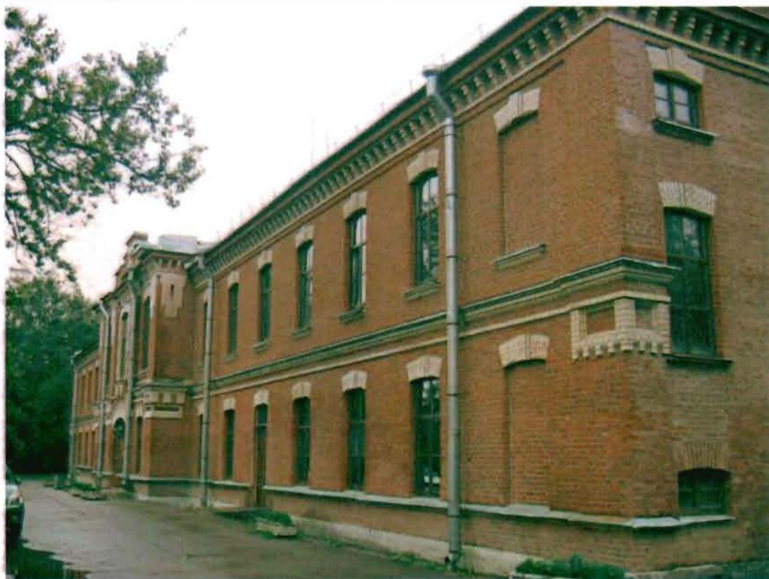
Фото 64. Северный фасад. Общий вид.
