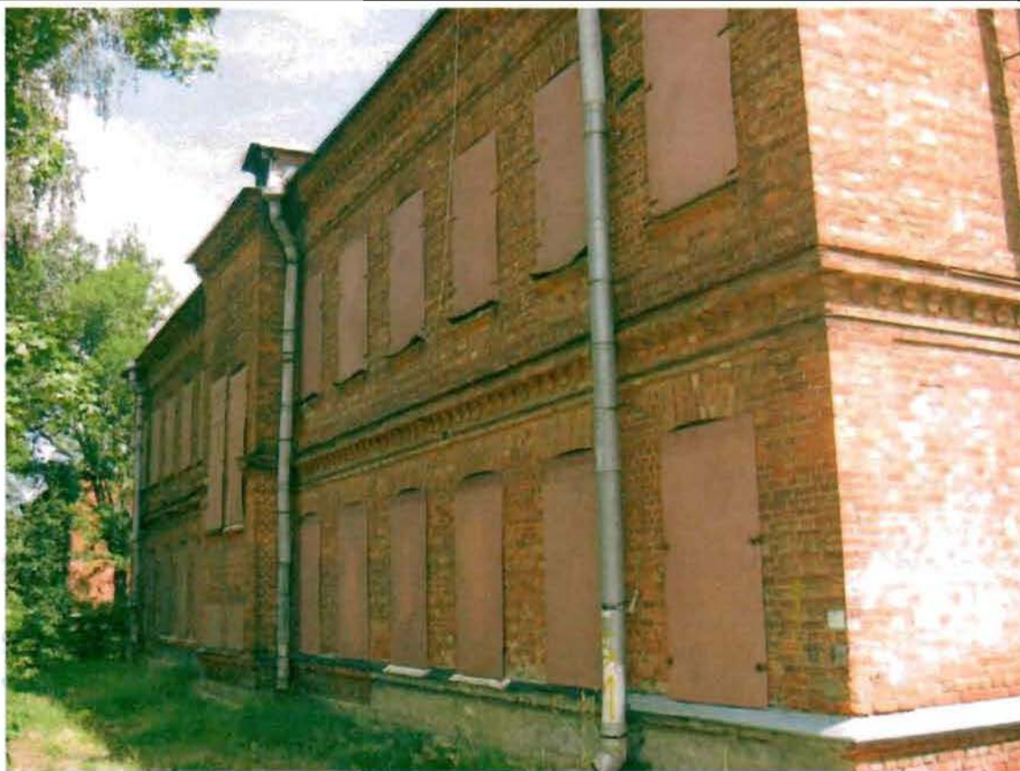
Фото 119. Западный фасад. Общий вид.
