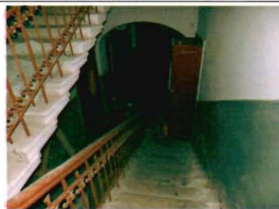
Фото 123. Парадная лестница в центральной части здания. Фрагмент.
