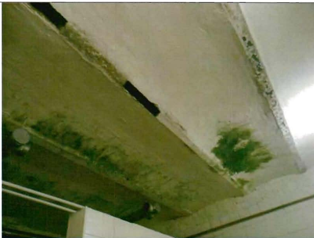
Своды по металлическим балкам. Съёмка 27.11.2012, Воронина Н.В.
