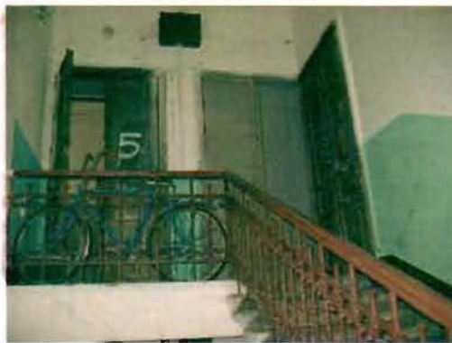
Фото 183. Парадная лестница в центральной части здания. Фрагмент.
