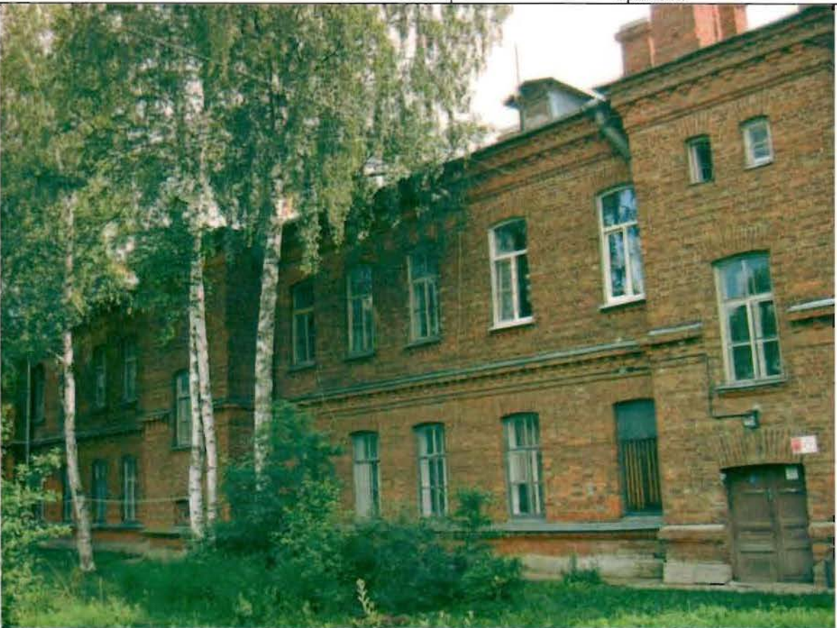
Фото 179. Западный фасад. Общий вид.
