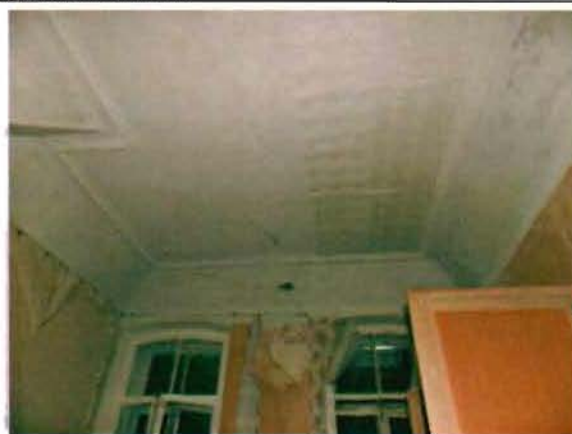
Фото 121. Помещение 1-го этажа.
