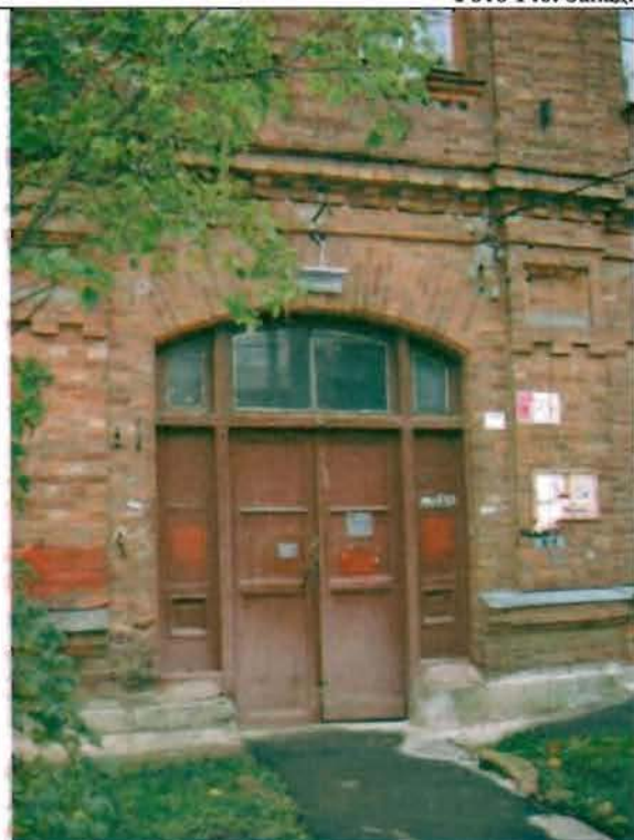
Фото 147. Дверной проем западного фасада. Общий вид.
