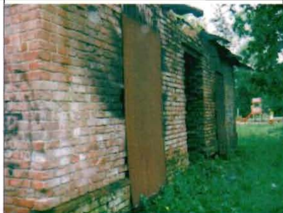
Фото 95. Северный фасад. Общий вид.
