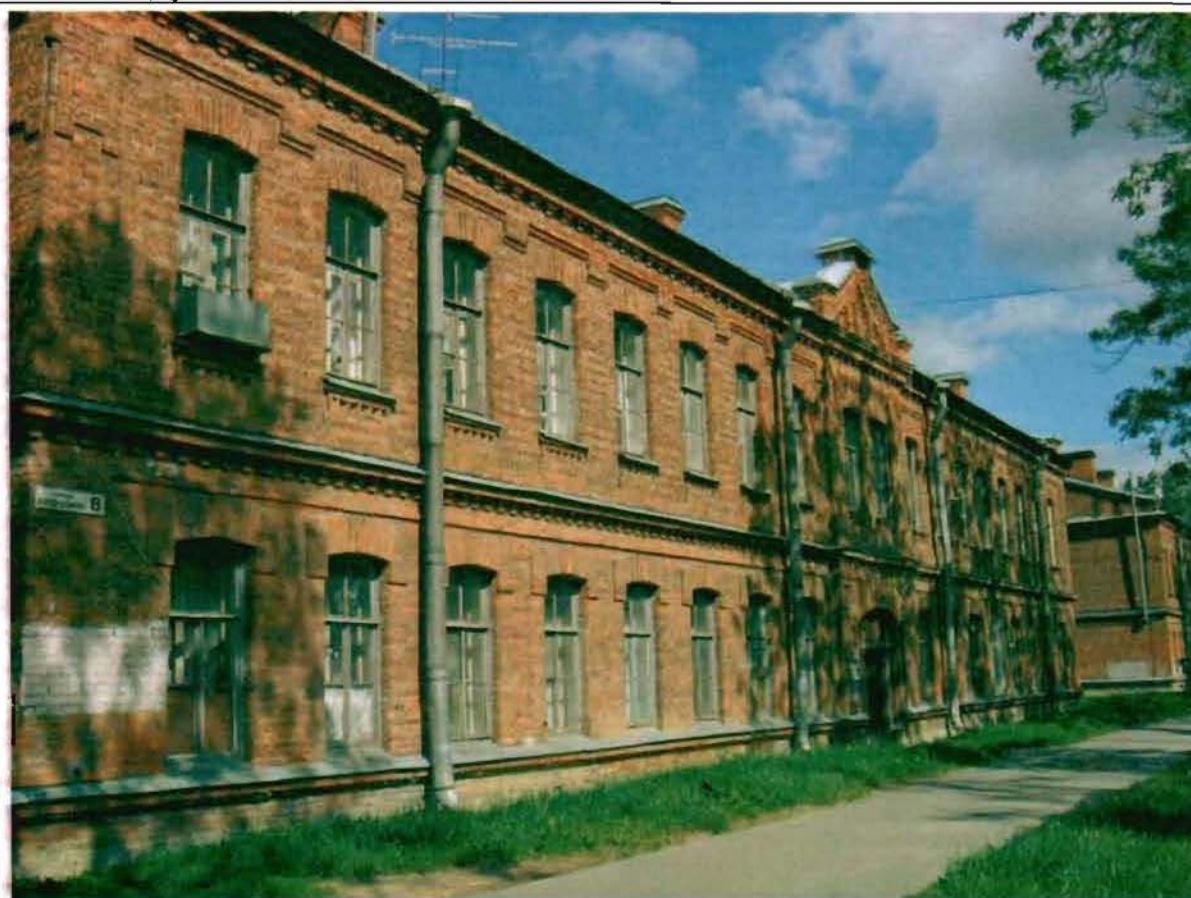
Фото 176. Восточный фасад. Общий вид.
