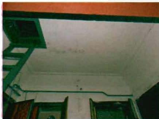
Фото 102. Отделка потолка тамбура. Общий вид.
