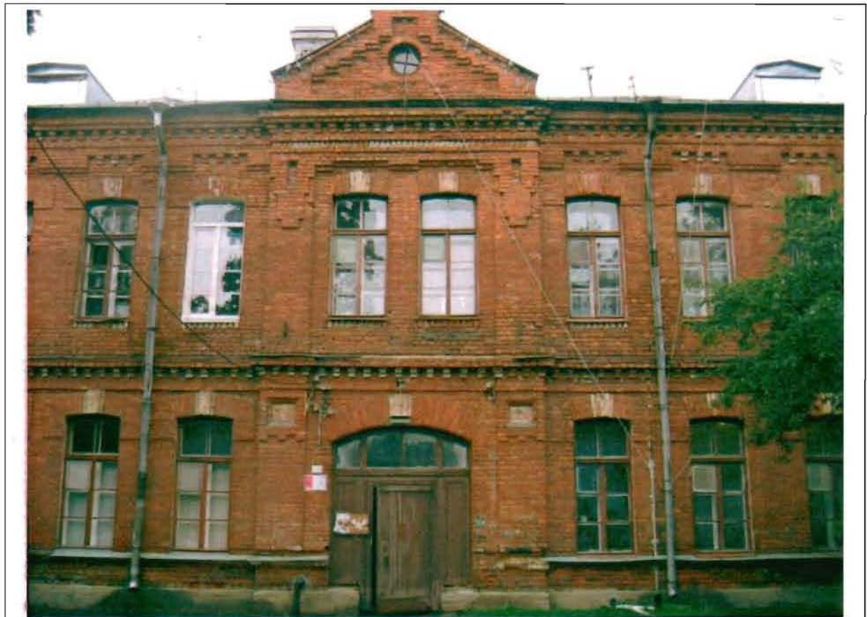
Фото 104. Восточный фасад. Центральная часть. Общий вид.
