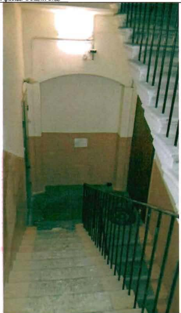
Фото 173. Лестница № 1 в северной части здания. Фрагмент.
