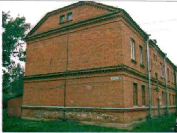
Фото 85. Восточный фасад. Общий вид.
