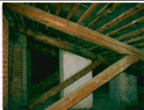
Фото 141. Конструкции крыши. Фрагмент.
