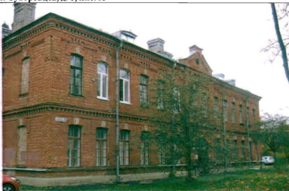
Фото 103. Восточный фасад. Общий вид.
