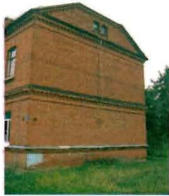
Фото 86. Западный фасад. Общий вид.
