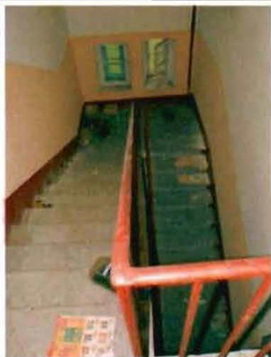
Фото 124. Лестница в южной части здания. Общий вид.
