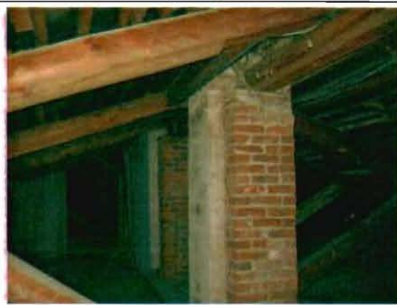
Фото 142. Конструкции крыши. Фрагмент.
