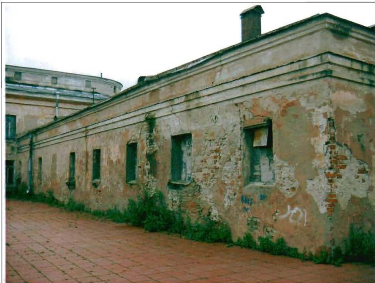
Фото 25. Восточный фасад. Общий вид.
