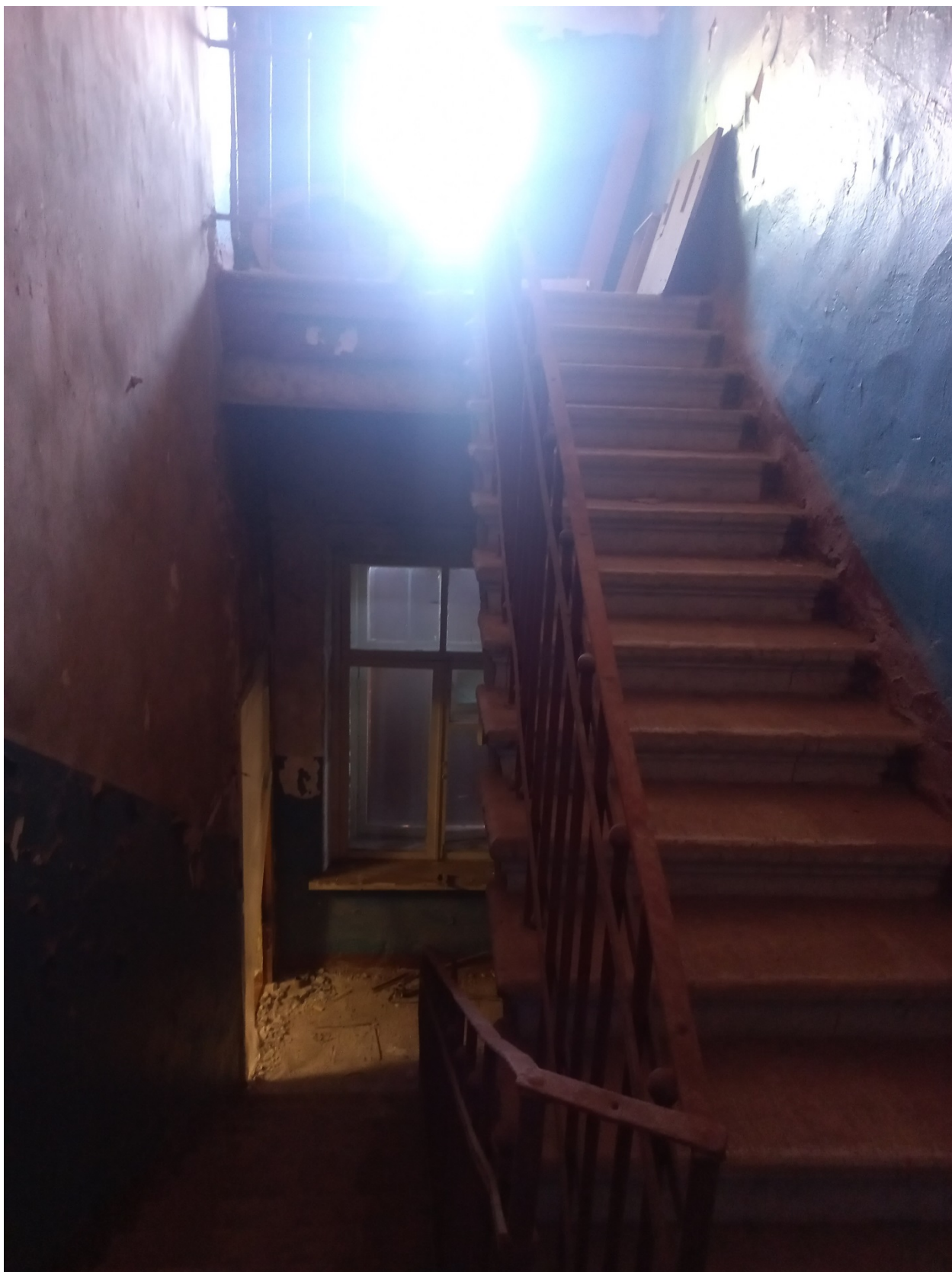
Фото 30. Подъем со второго этажа на чердак.
