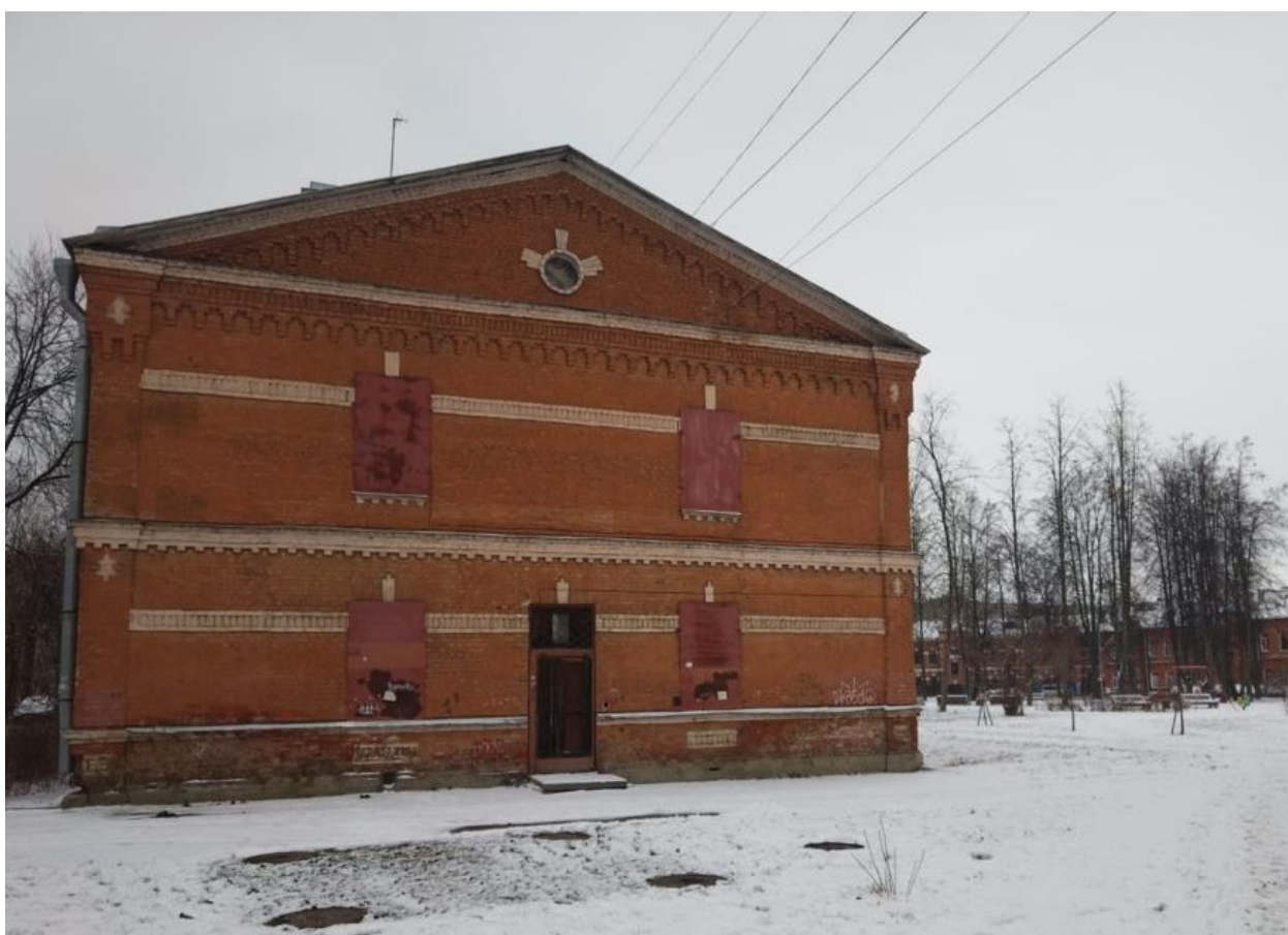
Фото 3. Восточный торцевой фасад.
