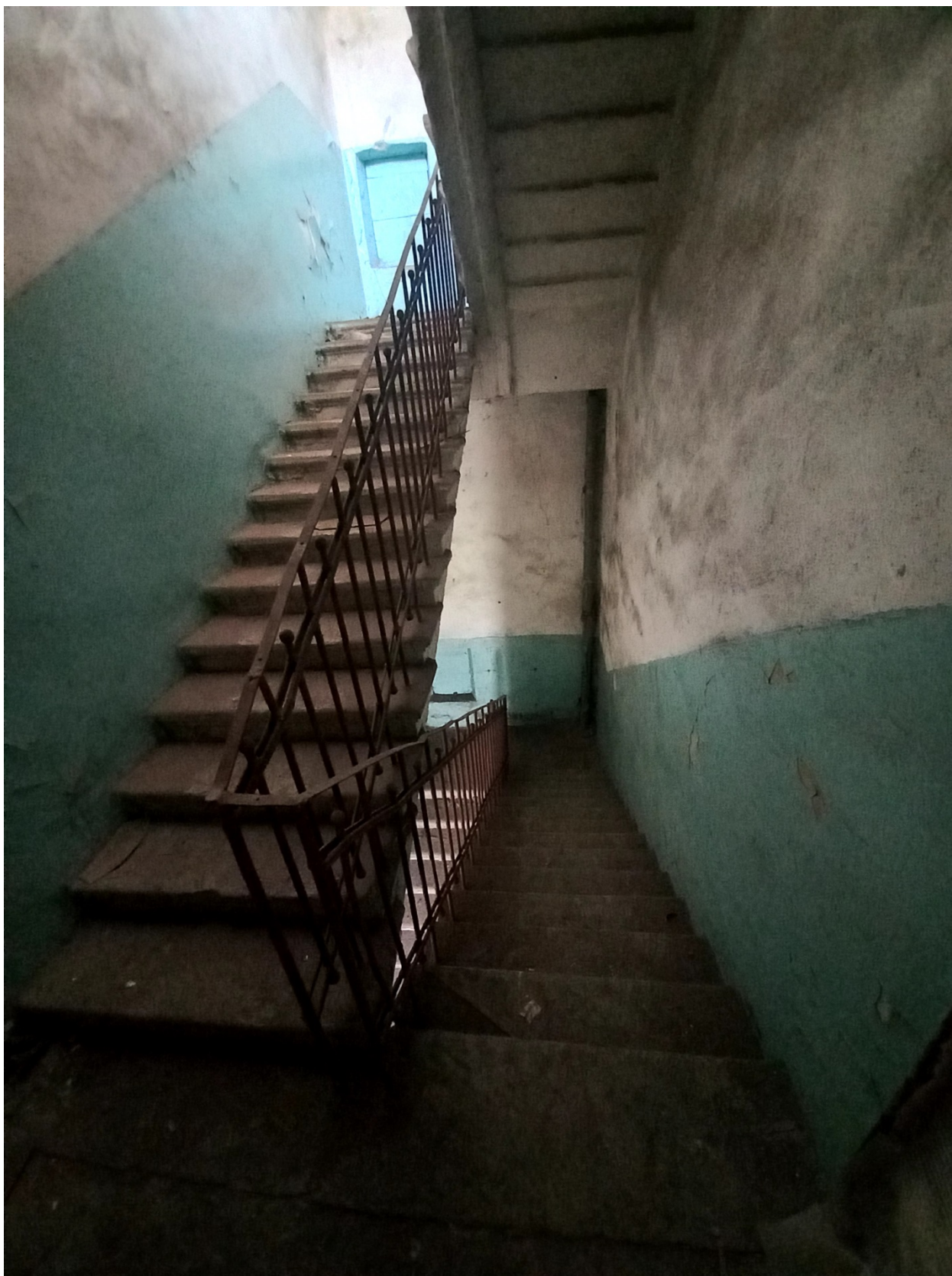
Фото 27. Площадка на уровне второго этажа.
