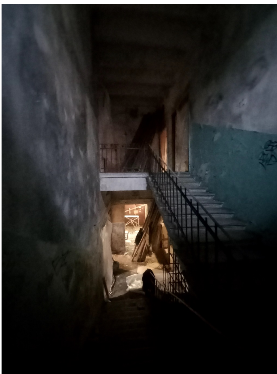
Фото 23. Вид с площадки между 1 и 2 этажами.
