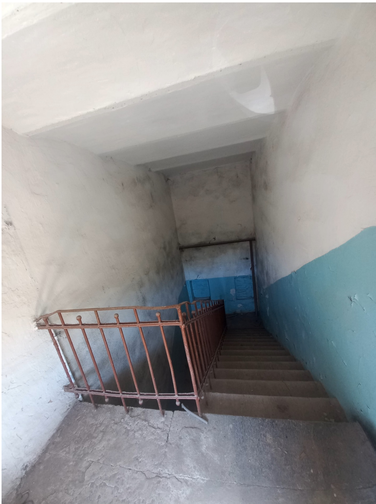
Фото 26. Площадка на уровне чердака. Бетонные своды.
