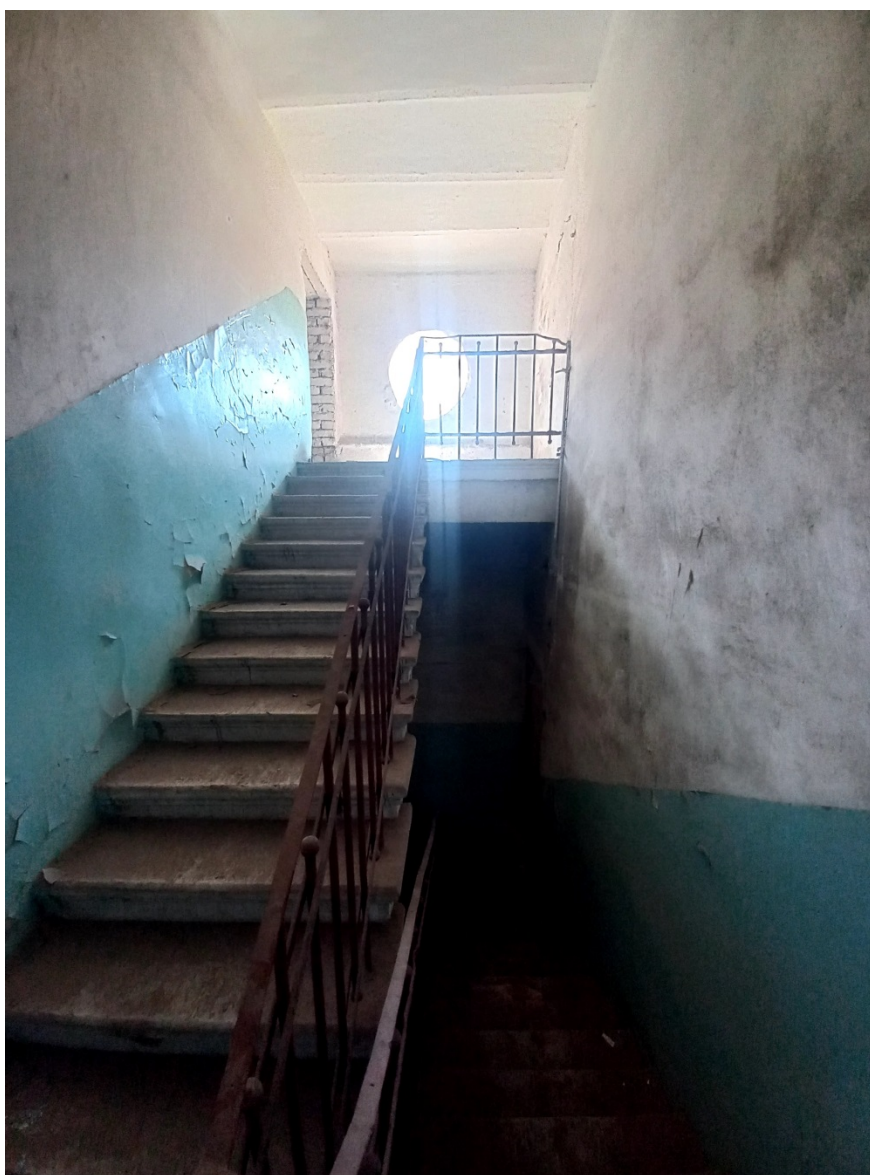
Фото 25. Площадка на уровне чердака.
