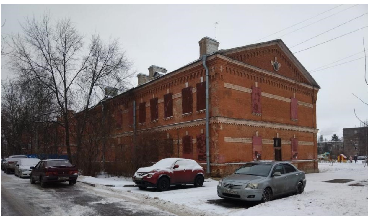
Фото 2. Южный, восточный торцевой фасады.
