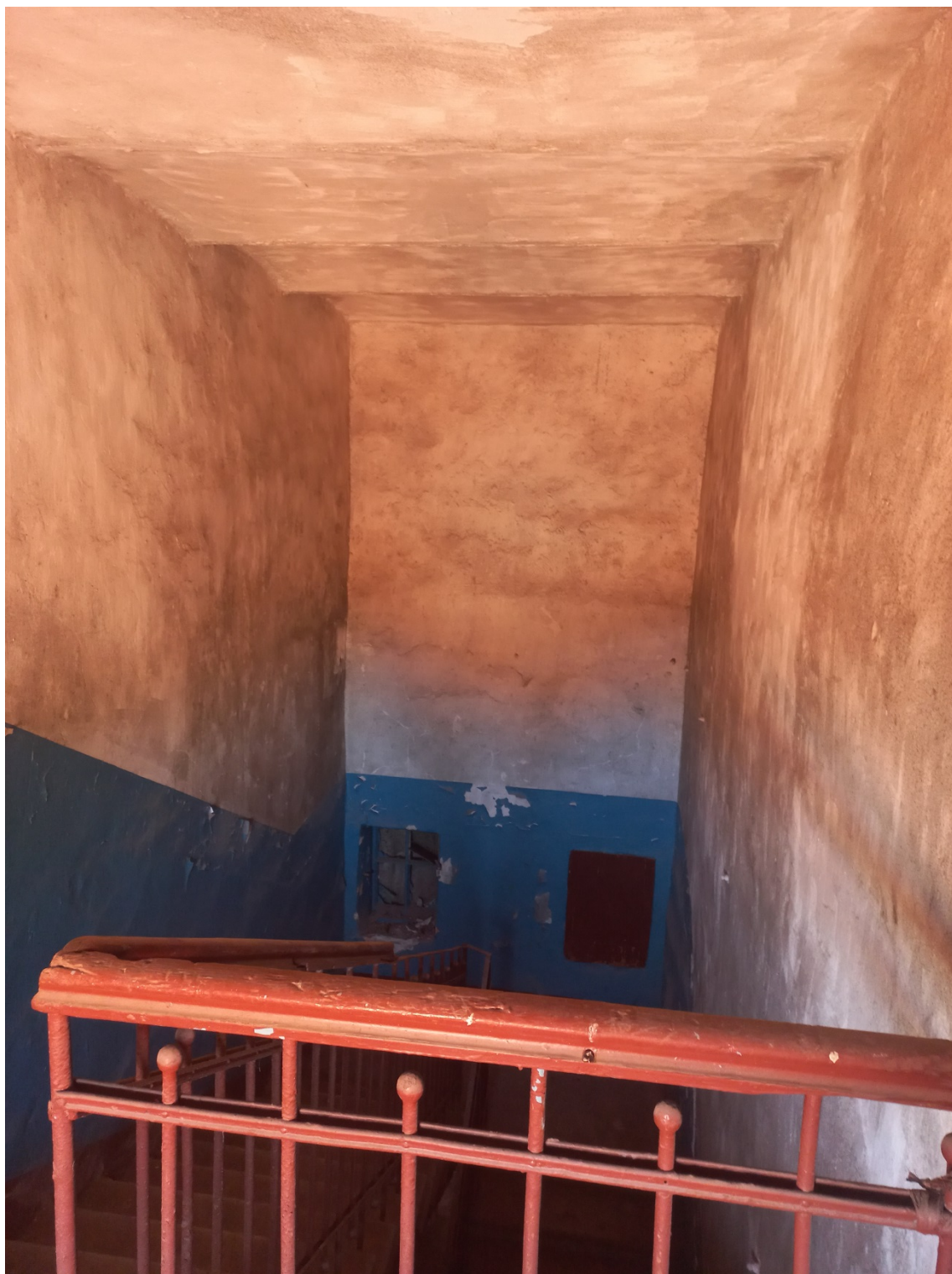
Фото 31. Вид с площадки на уровне чердака. Бетонные своды.
