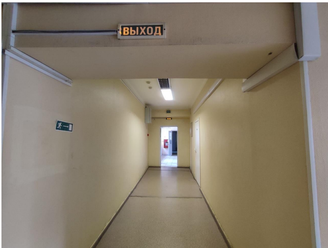
65. Выявленный объект культурного наследия «Здание общежития Транспортной Академии», по адресу: г. Санкт-Петербург, Малая Посадская ул., д. 22-24, лит. А. Фрагмент пом. 102-С (336) в уровне 4-го этажа.
