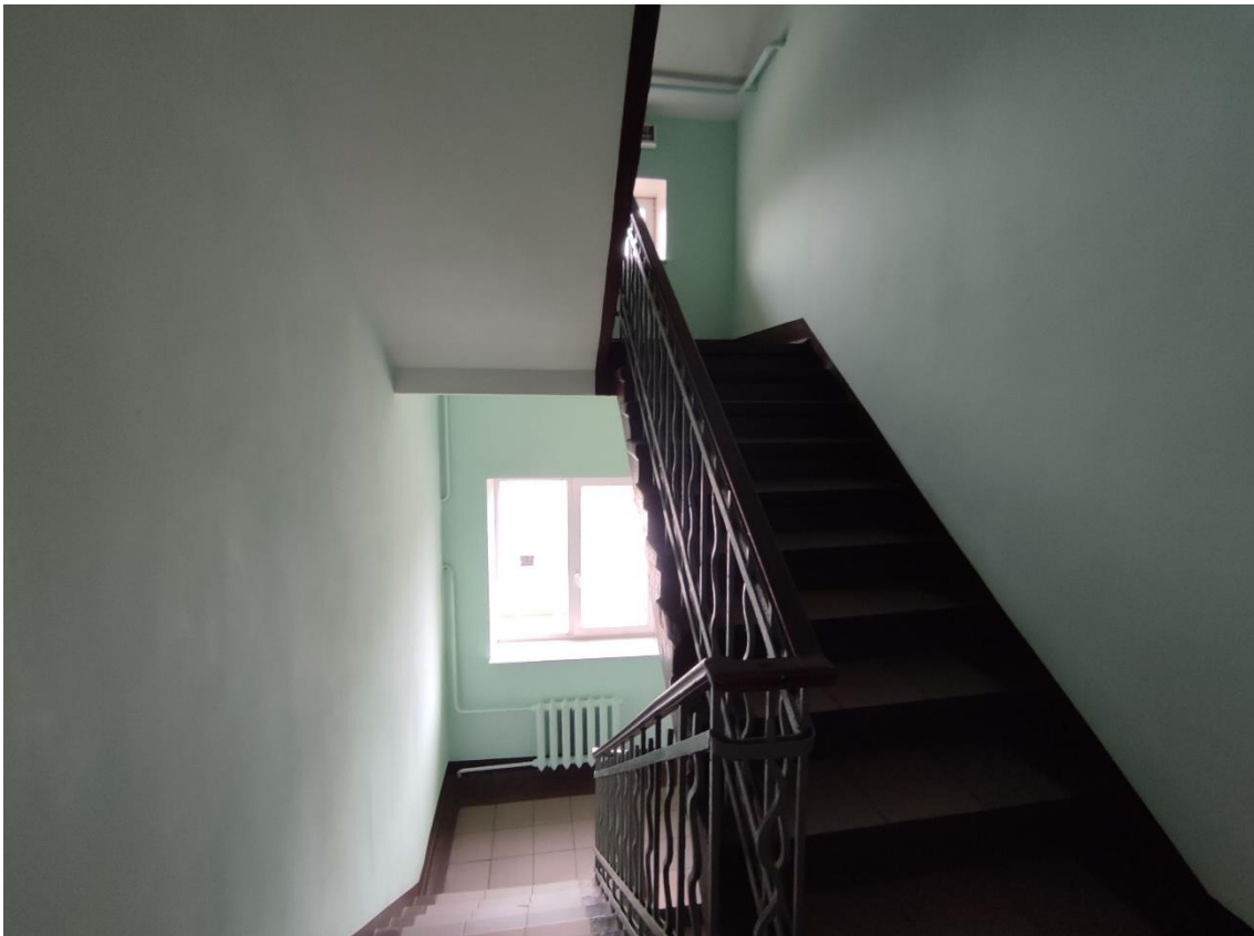
82. Выявленный объект культурного наследия «Здание общежития Транспортной Академии», по адресу: г. Санкт-Петербург, Малая Посадская ул., д. 22-24, лит. А. Общий вид лестничной клетки, расположенной в осях А-Б/2-3 (пом. 102-С (413)) в уровне 5-го этажа.
