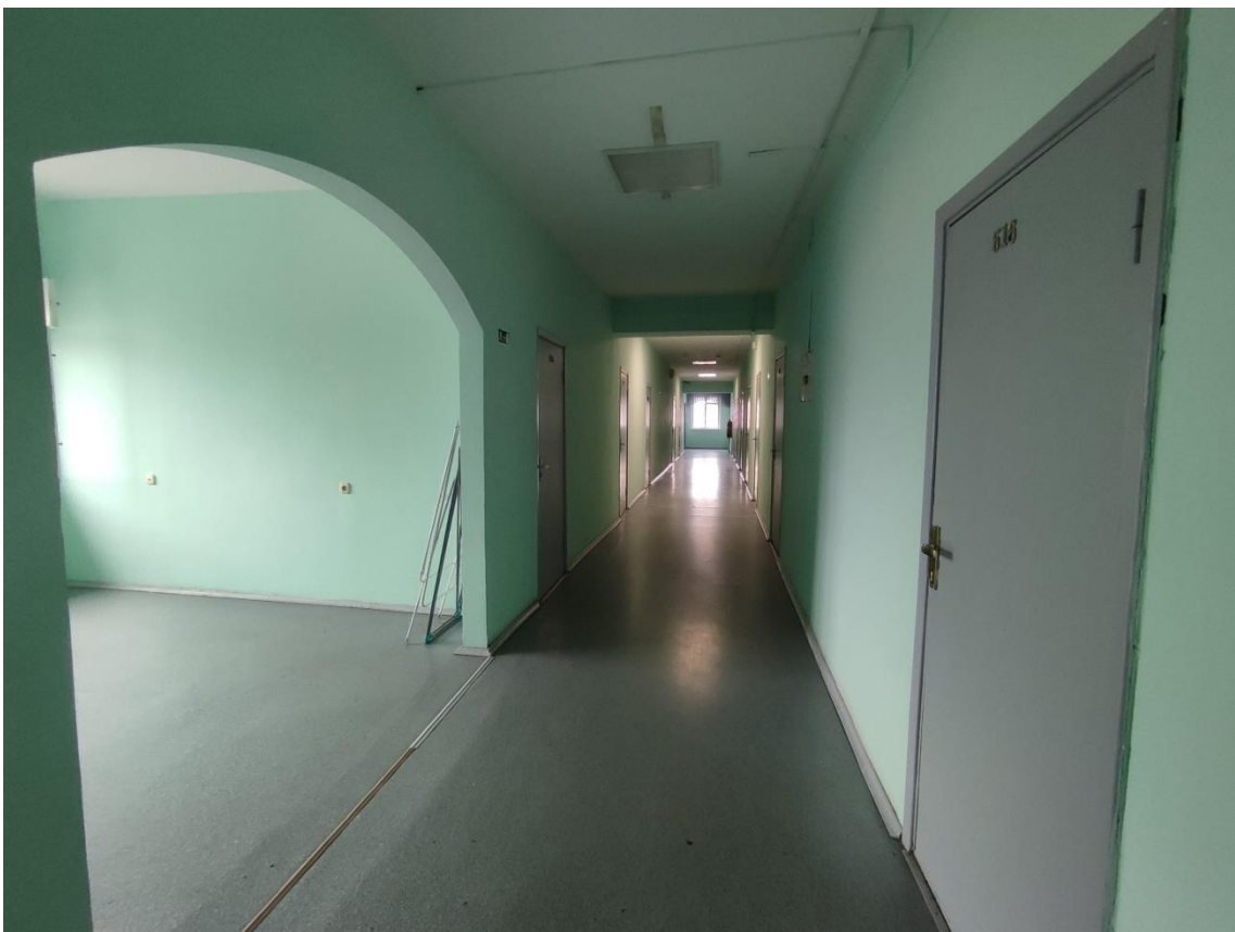
73. Выявленный объект культурного наследия «Здание общежития Транспортной Академии», по адресу: г. Санкт-Петербург, Малая Посадская ул., д. 22-24, лит. А. Общий вид пом. 102-С (481) в уровне 5-го этажа.
