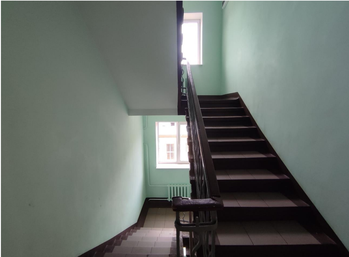
61. Выявленный объект культурного наследия «Здание общежития Транспортной Академии», по адресу: г. Санкт-Петербург, Малая Посадская ул., д. 22-24, лит. А. Общий вид лестничной клетки, расположенной в осях А-Б/2-3 (пом. 102-С (307)) в уровне 4-го этажа.
