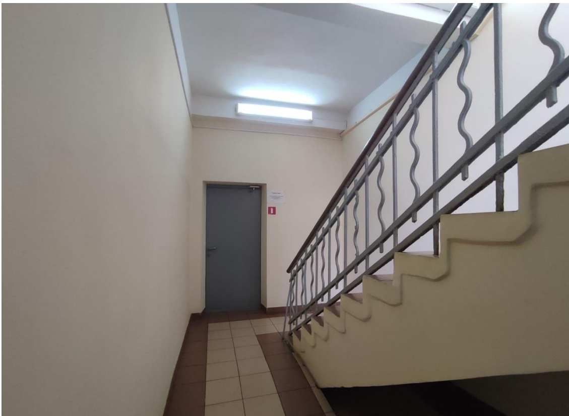
19. Выявленный объект культурного наследия «Здание общежития Транспортной Академии», по адресу: г. Санкт-Петербург, Малая Посадская ул., д. 22-24, лит. А. Общий вид лестничной клетки, расположенной в осях А2-А3/2-4 (пом. 14-Н (1)) в уровне 1-го этажа.
