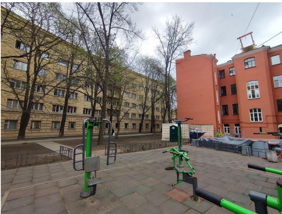
2. Выявленный объект культурного наследия «Здание общежития Транспортной Академии», по адресу: г. Санкт-Петербург, Малая Посадская ул., д. 22-24, лит. А. Фрагмент западного фасада пятиэтажного корпуса.
