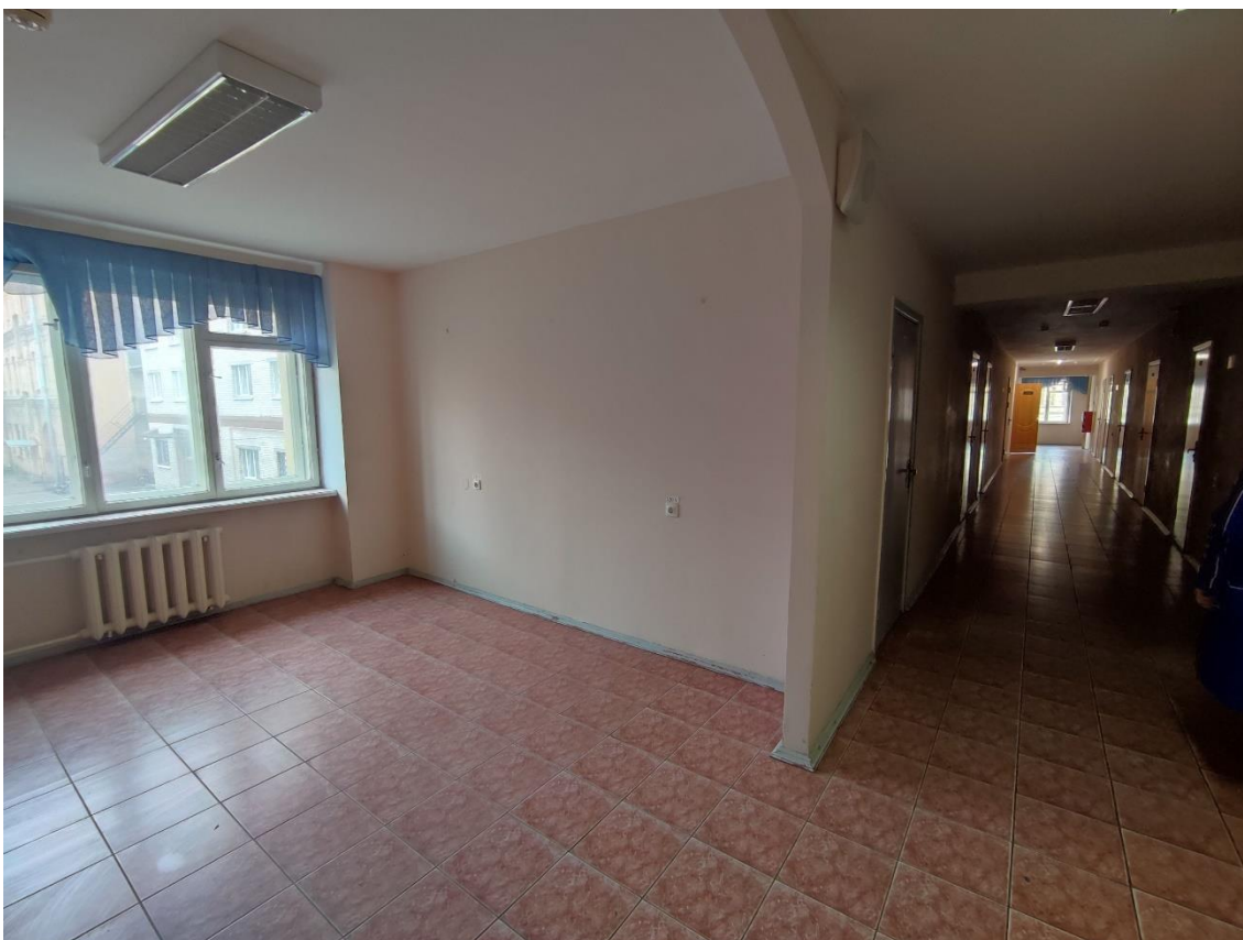
47. Выявленный объект культурного наследия «Здание общежития Транспортной Академии», по адресу: г. Санкт-Петербург, Малая Посадская ул., д. 22-24, лит. А. Фрагмент пом. 102-С (153) в уровне 2-го этажа.
