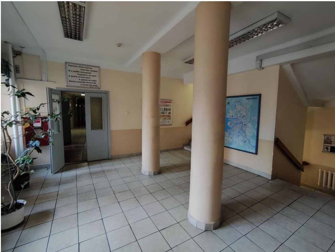
41. Выявленный объект культурного наследия «Здание общежития Транспортной Академии», по адресу: г. Санкт-Петербург, Малая Посадская ул., д. 22-24, лит. А. Общий вид пом. 102-С (72) в уровне 2-го этажа.
