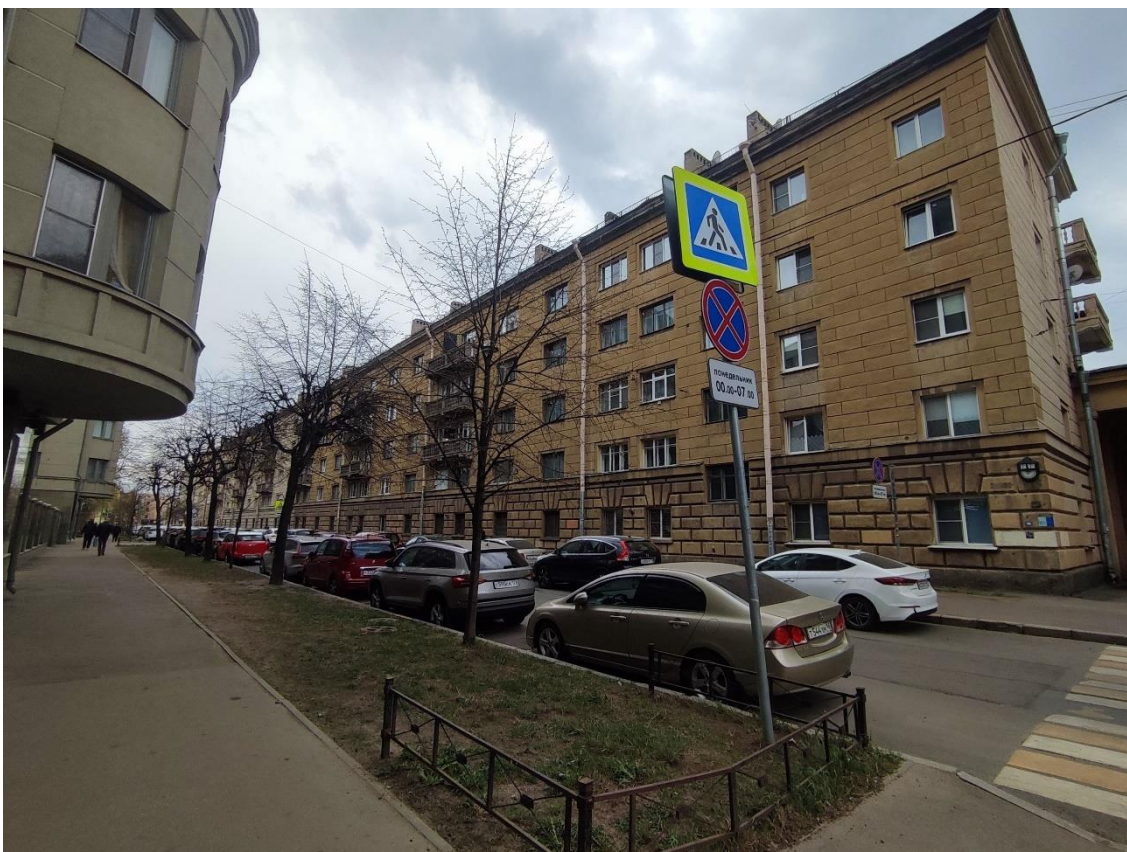
7. Выявленный объект культурного наследия «Здание общежития Транспортной Академии», по адресу: г. Санкт-Петербург, Малая Посадская ул., д. 22-24, лит. А. Общий вид северо-западного фасада корпуса по Большой Посадской улице.
