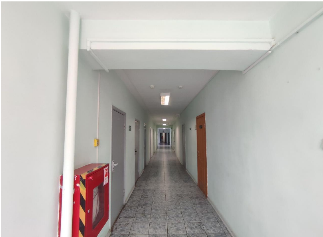
50. Выявленный объект культурного наследия «Здание общежития Транспортной Академии», по адресу: г. Санкт-Петербург, Малая Посадская ул., д. 22-24, лит. А. Общий вид пом. 102-С (287) в уровне 3-го этажа.
