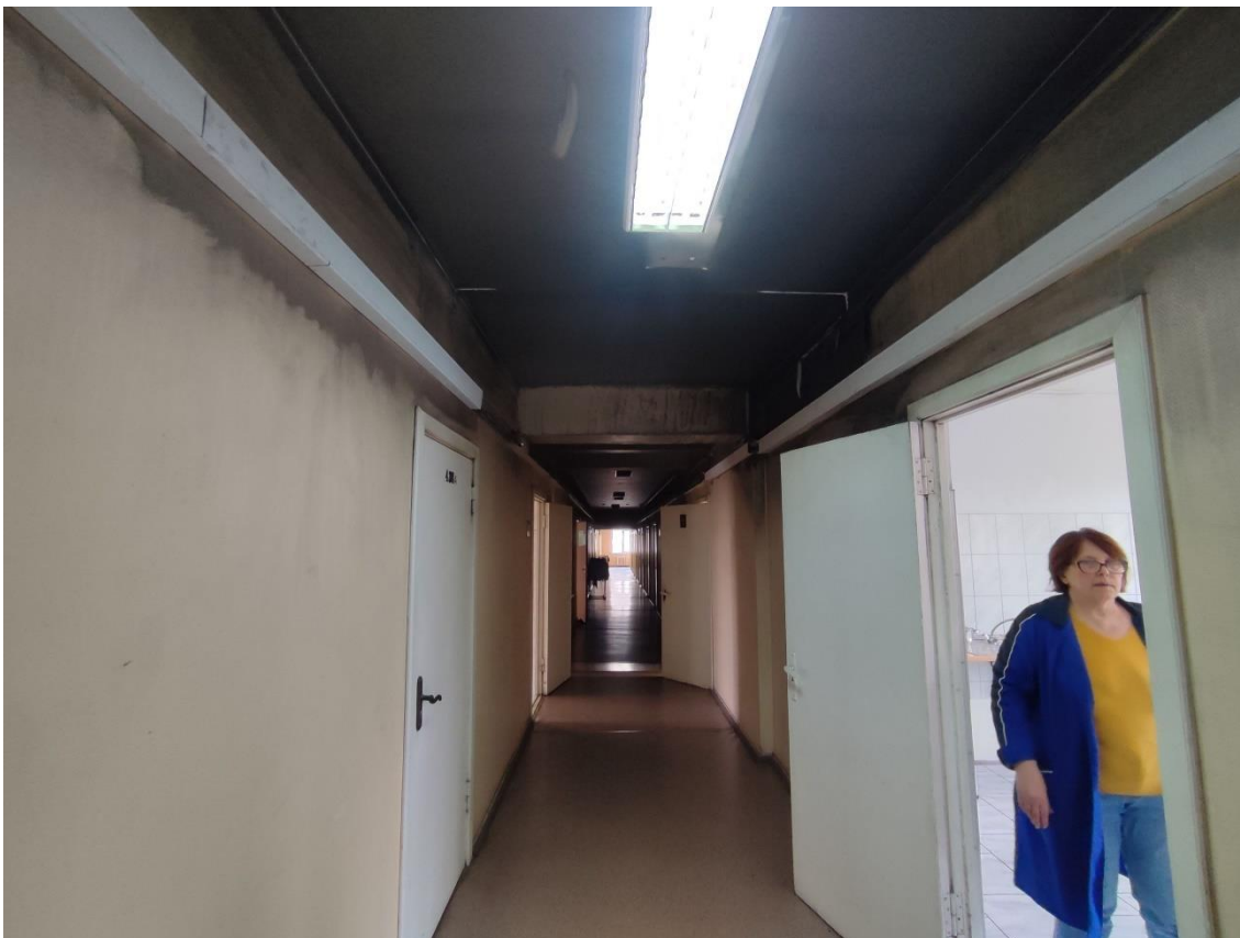
63. Выявленный объект культурного наследия «Здание общежития Транспортной Академии», по адресу: г. Санкт-Петербург, Малая Посадская ул., д. 22-24, лит. А. Общий вид пом. 102-С (336) в уровне 4-го этажа.
