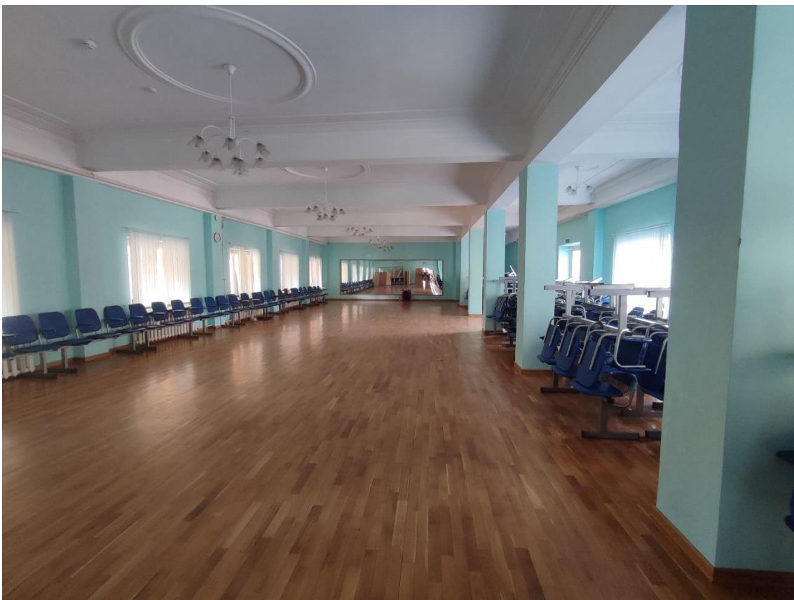
32. Выявленный объект культурного наследия «Здание общежития Транспортной Академии», по адресу: г. Санкт-Петербург, Малая Посадская ул., д. 22-24, лит. А. Общий вид пом. 102-С (82) в уровне 2-го этажа.
