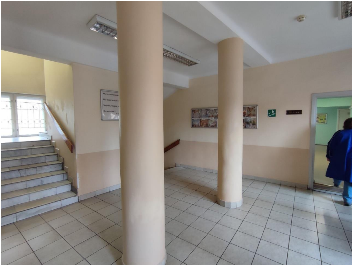
55. Выявленный объект культурного наследия «Здание общежития Транспортной Академии», по адресу: г. Санкт-Петербург, Малая Посадская ул., д. 22-24, лит. А. Общий вид пом. 102-С (186) в уровне 3-го этажа.
