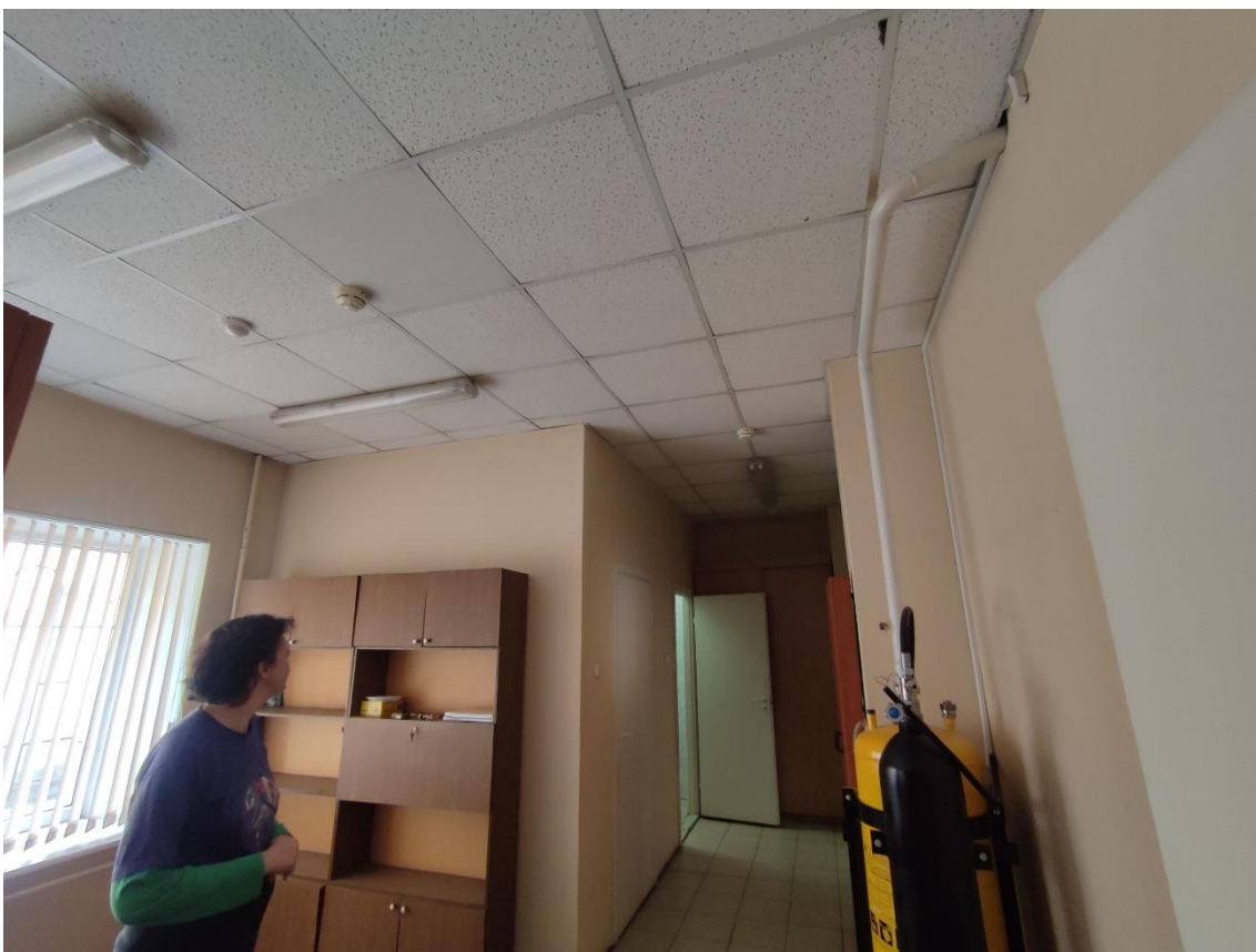
27. Выявленный объект культурного наследия «Здание общежития Транспортной Академии», по адресу: г. Санкт-Петербург, Малая Посадская ул., д. 22-24, лит. А. Общий вид пом. 14-Н (5) в уровне 2-го этажа.
