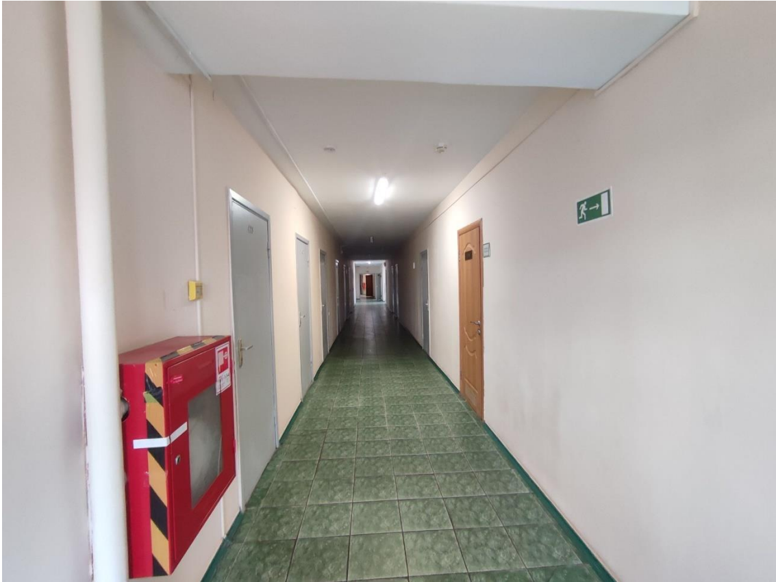
71. Выявленный объект культурного наследия «Здание общежития Транспортной Академии», по адресу: г. Санкт-Петербург, Малая Посадская ул., д. 22-24, лит. А. Общий вид пом. 102-С (361) в уровне 4-го этажа.
