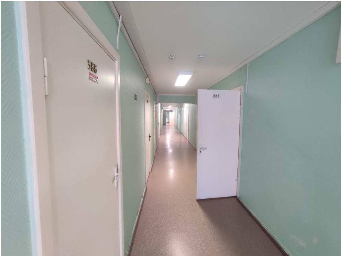
57. Выявленный объект культурного наследия «Здание общежития Транспортной Академии», по адресу: г. Санкт-Петербург, Малая Посадская ул., д. 22-24, лит. А. Общий вид пом. 102-С (232) в уровне 3-го этажа.
