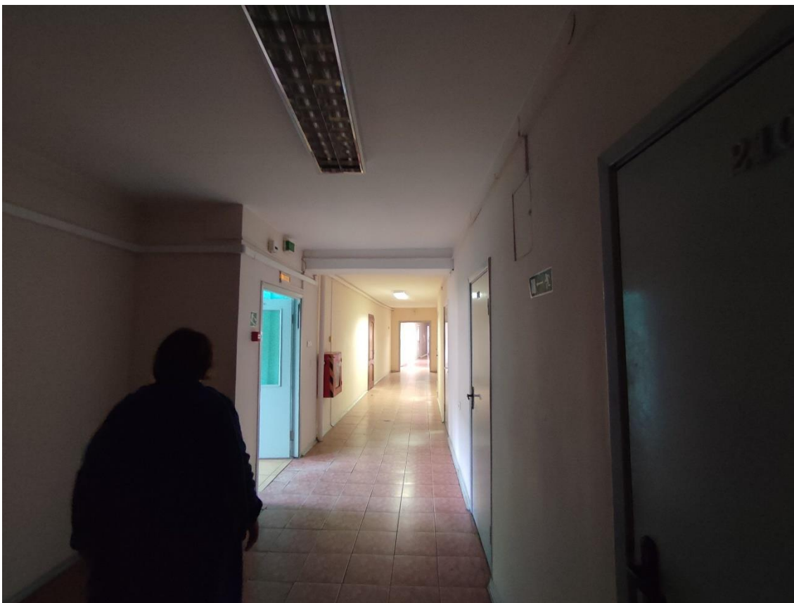
44. Выявленный объект культурного наследия «Здание общежития Транспортной Академии», по адресу: г. Санкт-Петербург, Малая Посадская ул., д. 22-24, лит. А. Общий вид пом. 102-С (139) в уровне 2-го этажа.
