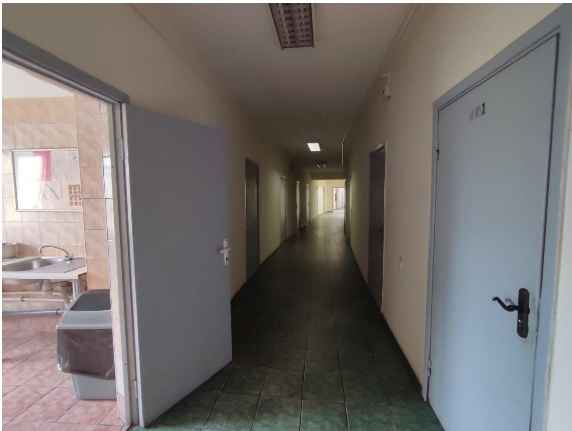
67. Выявленный объект культурного наследия «Здание общежития Транспортной Академии», по адресу: г. Санкт-Петербург, Малая Посадская ул., д. 22-24, лит. А. Общий вид пом. 102-С (393) в уровне 4-го этажа.
