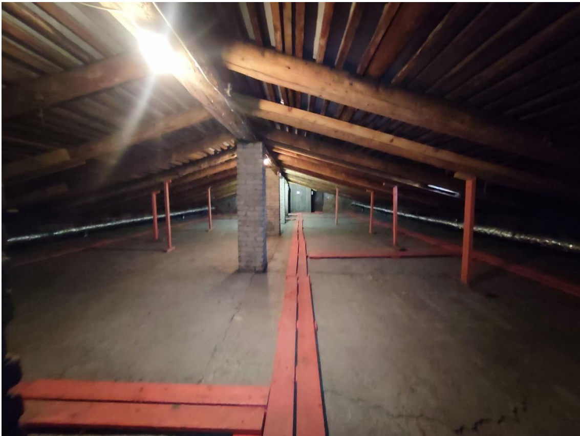
90. Выявленный объект культурного наследия «Здание общежития Транспортной Академии», по адресу: г. Санкт-Петербург, Малая Посадская ул., д. 22-24, лит. А. Общий вид стропильной системы крыши в осях А-В/1-3.
