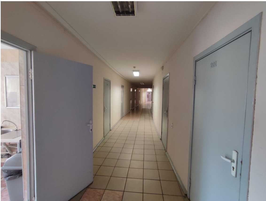
42. Выявленный объект культурного наследия «Здание общежития Транспортной Академии», по адресу: г. Санкт-Петербург, Малая Посадская ул., д. 22-24, лит. А. Общий вид пом. 102-С (130) в уровне 2-го этажа.
