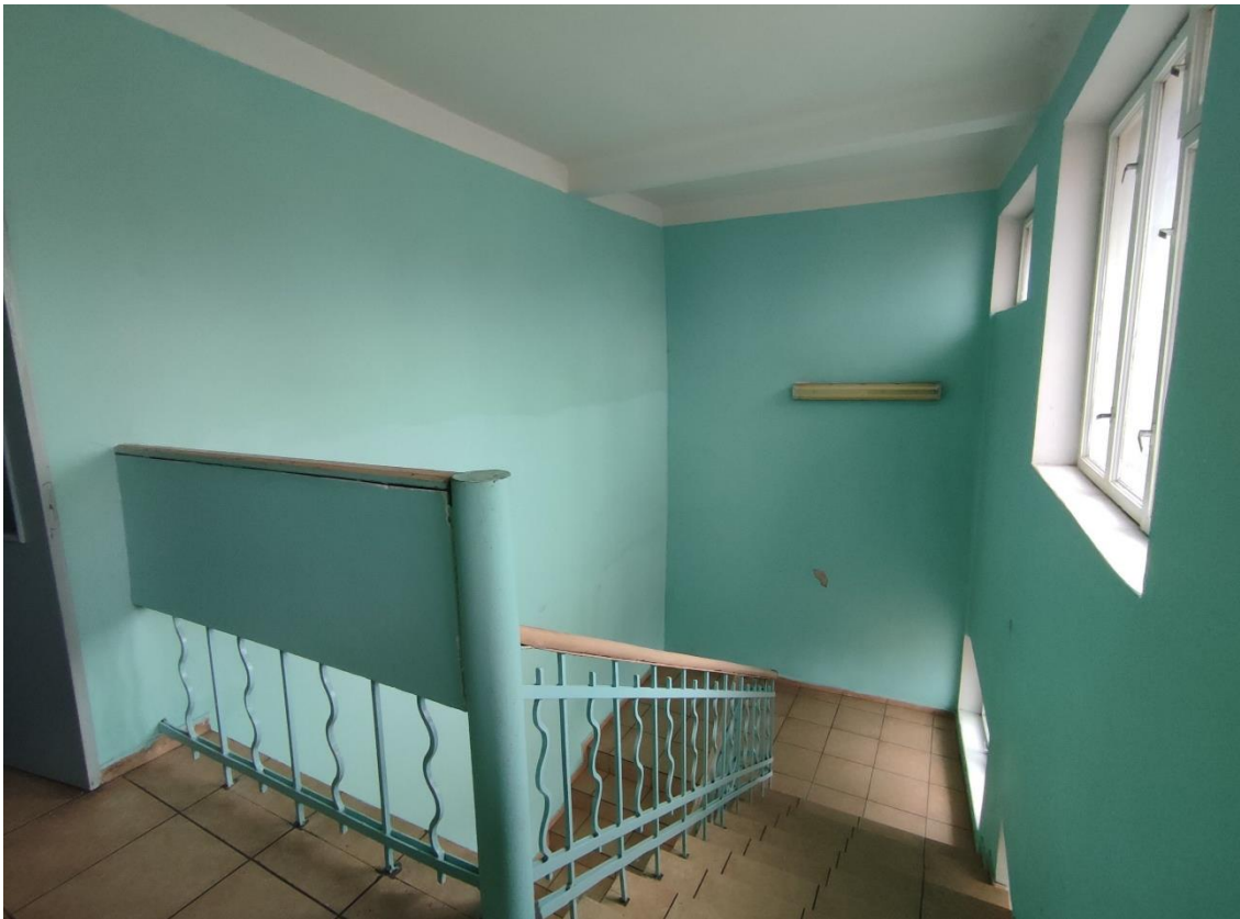
74. Выявленный объект культурного наследия «Здание общежития Транспортной Академии», по адресу: г. Санкт-Петербург, Малая Посадская ул., д. 22-24, лит. А. Общий вид лестничной клетки, расположенной в центральной части пятиэтажного корпуса (пом. 102-С (461)) в уровне 5-го этажа.
