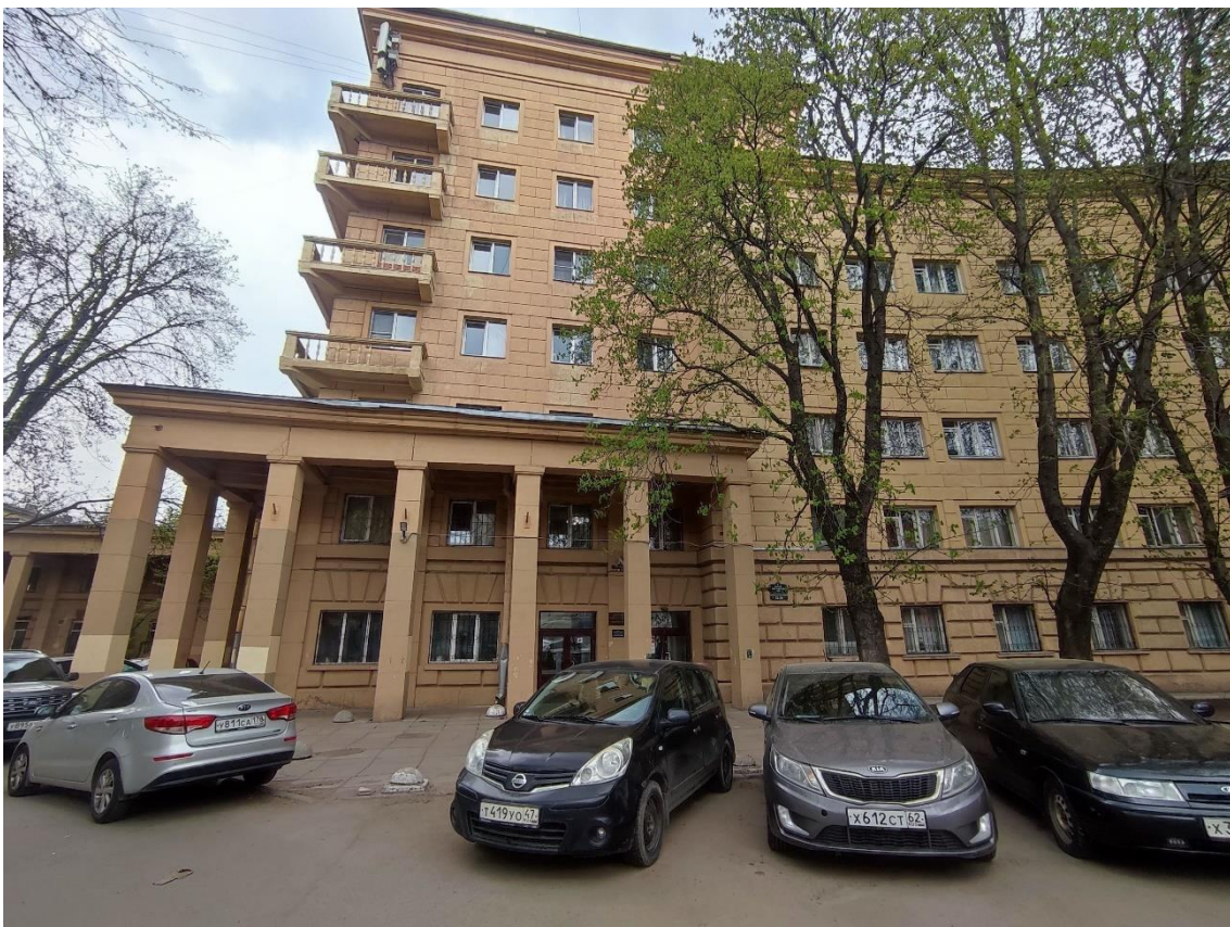
4. Выявленный объект культурного наследия «Здание общежития Транспортной Академии», по адресу: г. Санкт-Петербург, Малая Посадская ул., д. 22-24, лит. А. Фрагмент западного фасада пятиэтажного корпуса.
