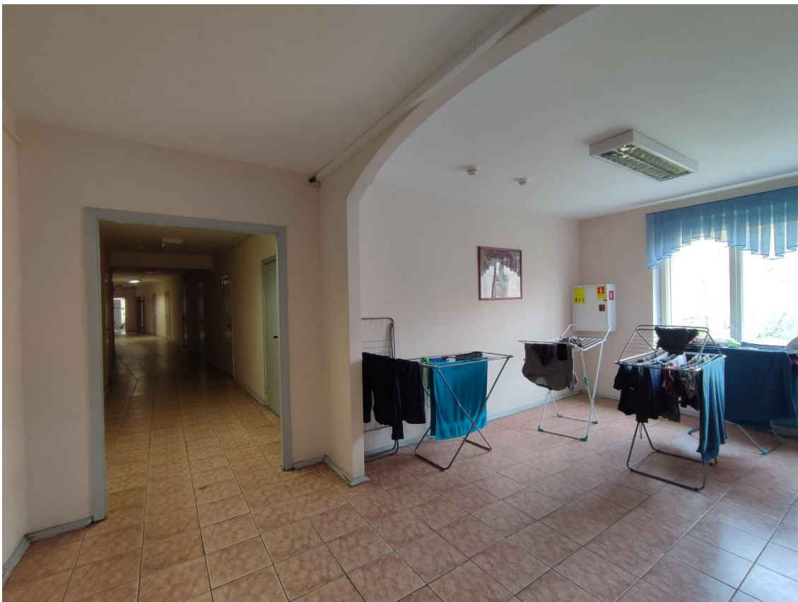
43. Выявленный объект культурного наследия «Здание общежития Транспортной Академии», по адресу: г. Санкт-Петербург, Малая Посадская ул., д. 22-24, лит. А. Общий вид пом. 102-С (138) в уровне 2-го этажа.
