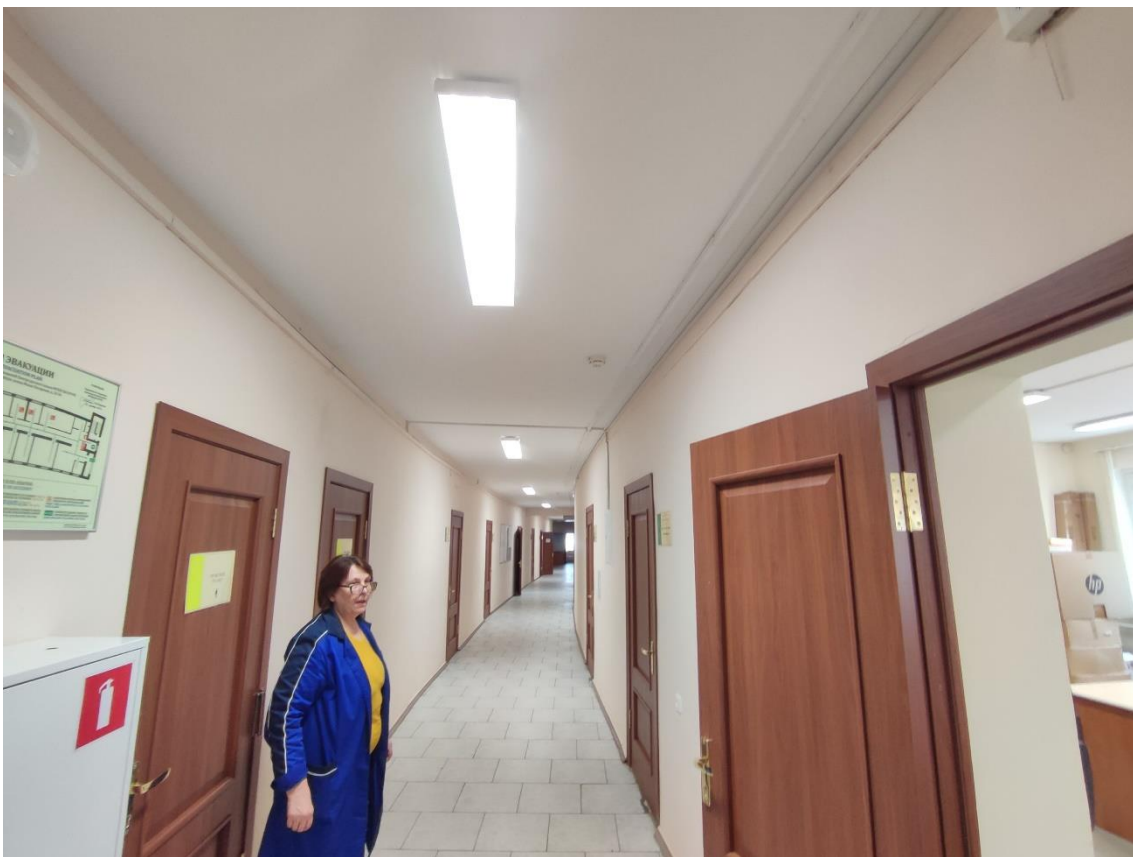
24. Выявленный объект культурного наследия «Здание общежития Транспортной Академии», по адресу: г. Санкт-Петербург, Малая Посадская ул., д. 22-24, лит. А. Общий вид пом. 102-С (41) в уровне 1-го этажа.
