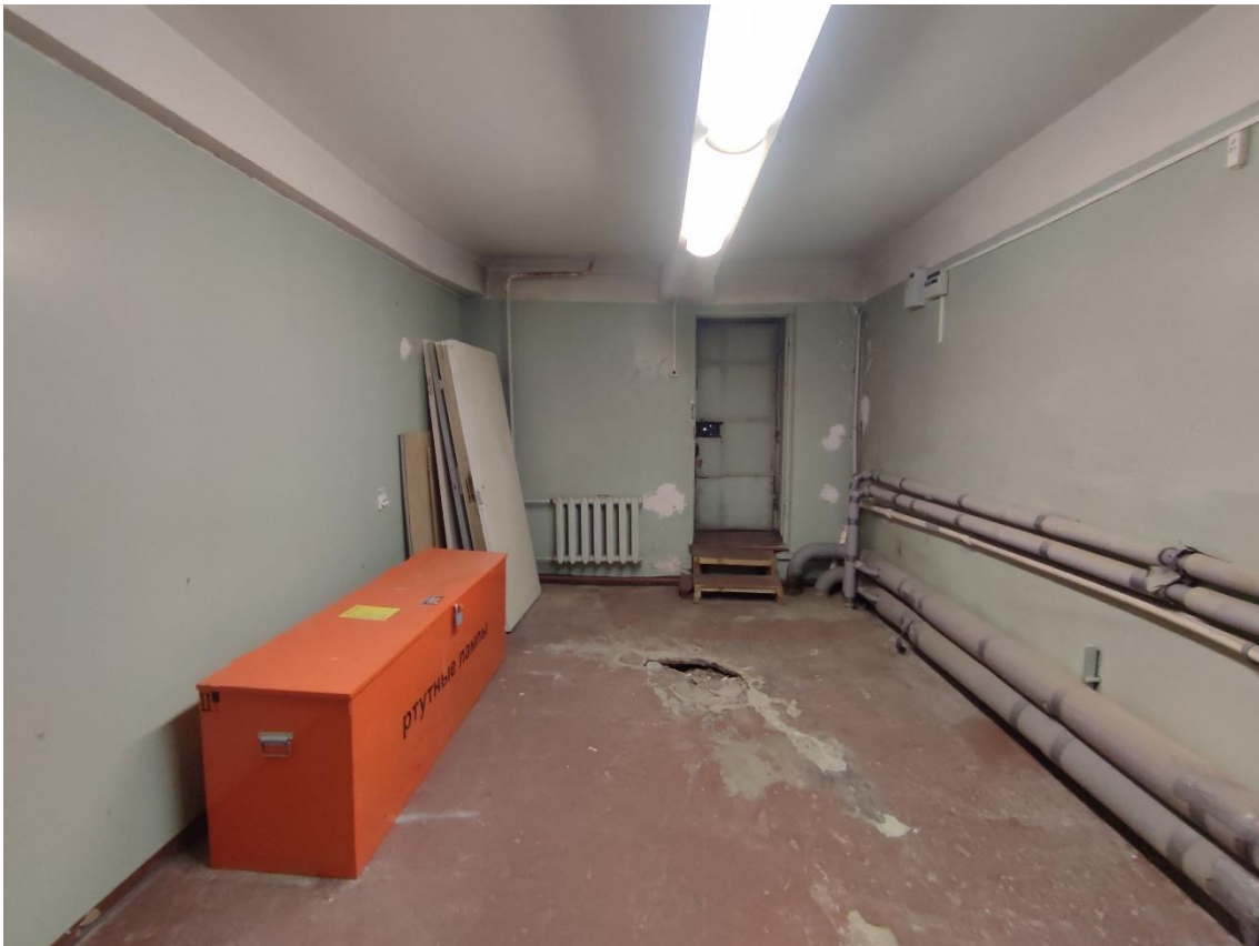
15. Выявленный объект культурного наследия «Здание общежития Транспортной Академии», по адресу: г. Санкт-Петербург, Малая Посадская ул., д. 22-24, лит. А. Общий вид пом. 102-С (103) в уровне 1-го этажа.
