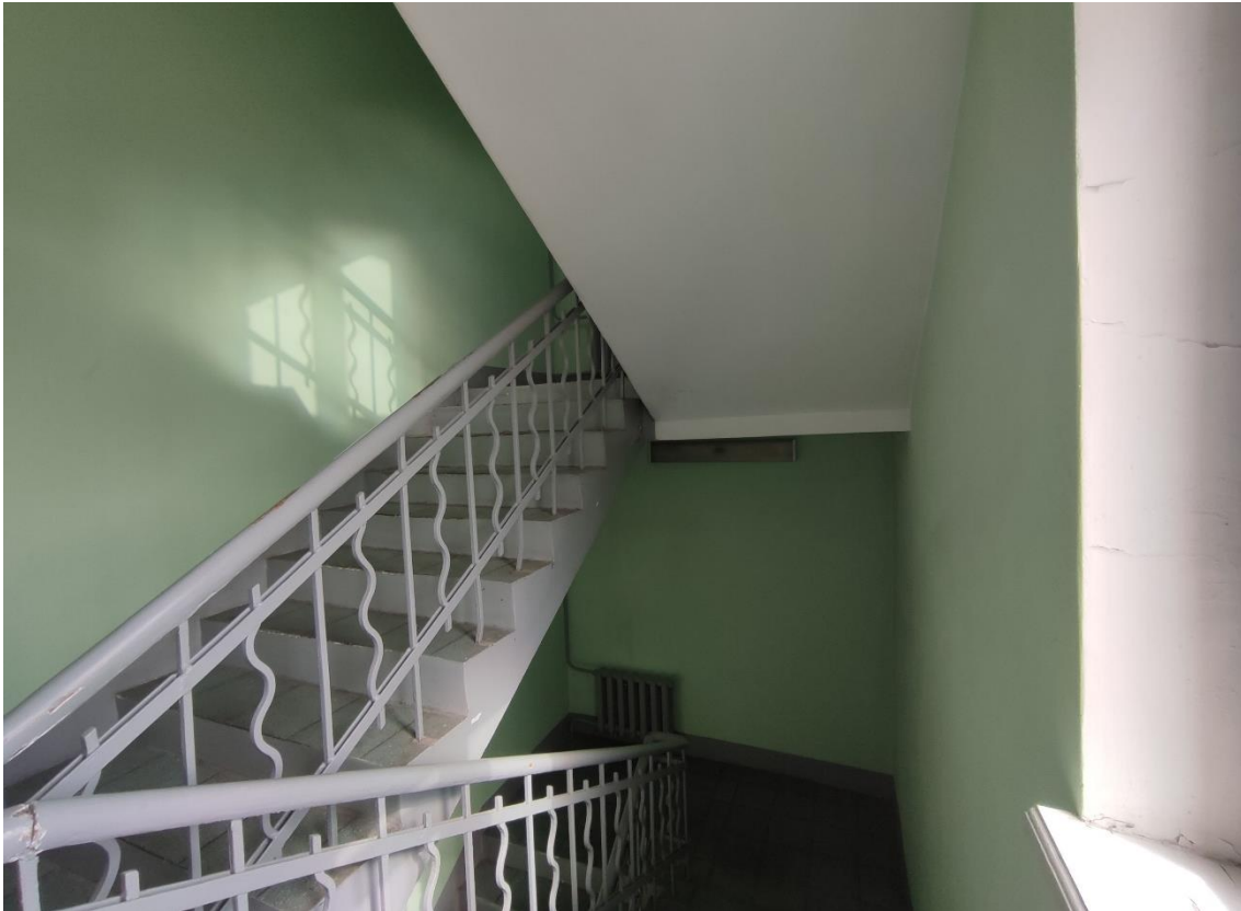
49. Выявленный объект культурного наследия «Здание общежития Транспортной Академии», по адресу: г. Санкт-Петербург, Малая Посадская ул., д. 22-24, лит. А. Общий вид лестничной клетки, расположенной по оси 3 пятиэтажного корпуса (пом. 102-С (262)) в уровне 3-го этажа.
