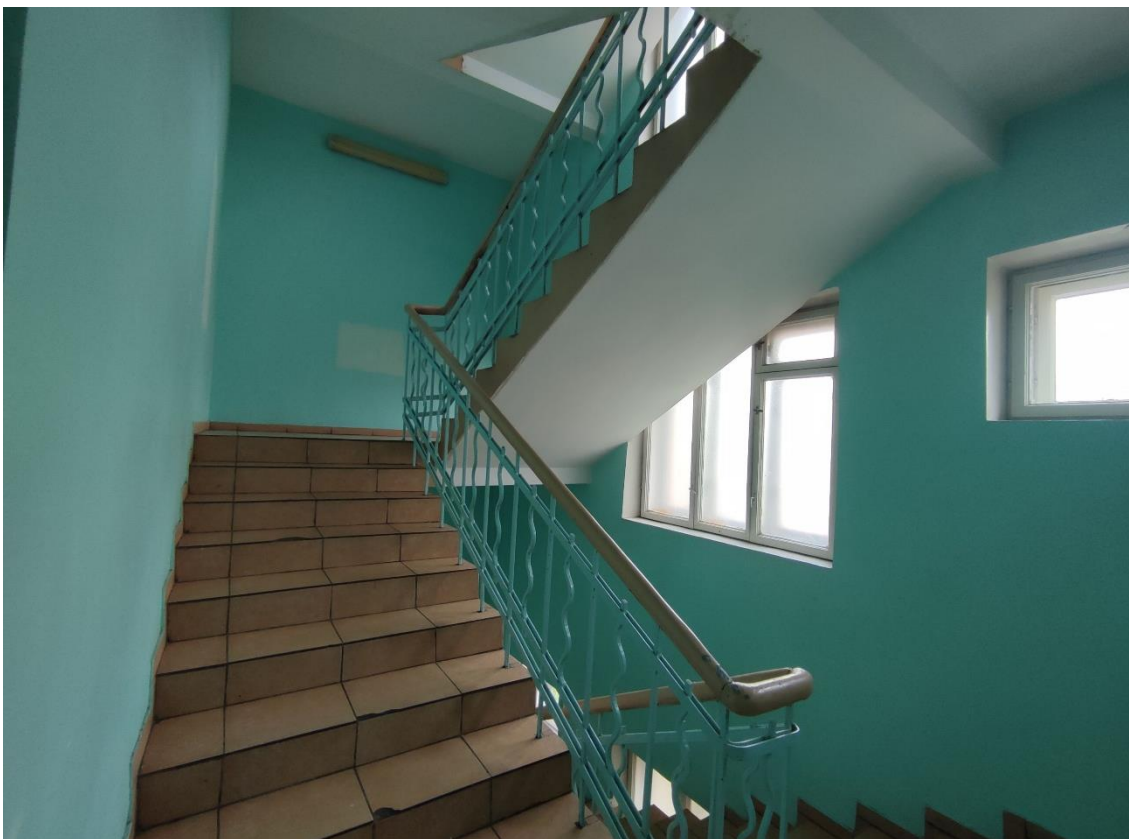
52. Выявленный объект культурного наследия «Здание общежития Транспортной Академии», по адресу: г. Санкт-Петербург, Малая Посадская ул., д. 22-24, лит. А. Общий вид лестничной клетки, расположенной в центральной части пятиэтажного корпуса (пом. 102-С (299)) в уровне 3-го этажа.
