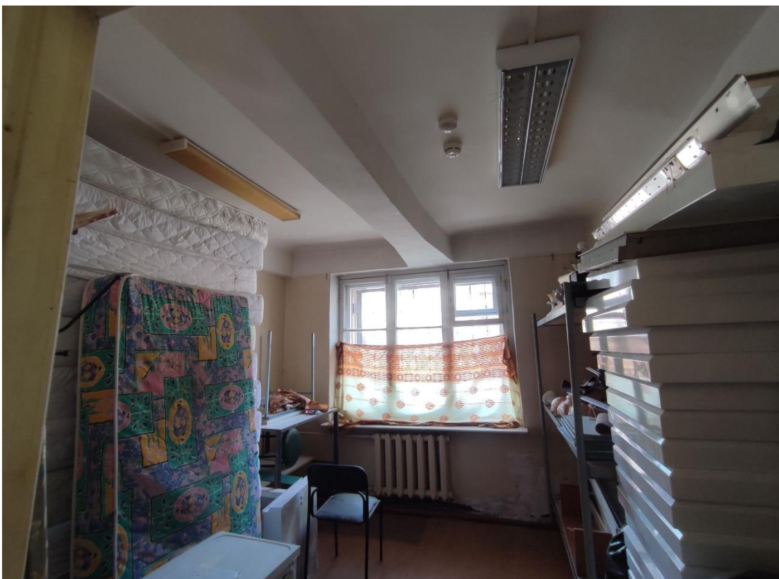
17. Выявленный объект культурного наследия «Здание общежития Транспортной Академии», по адресу: г. Санкт-Петербург, Малая Посадская ул., д. 22-24, лит. А. Общий вид пом. 102-С (101) в уровне 1-го этажа.
