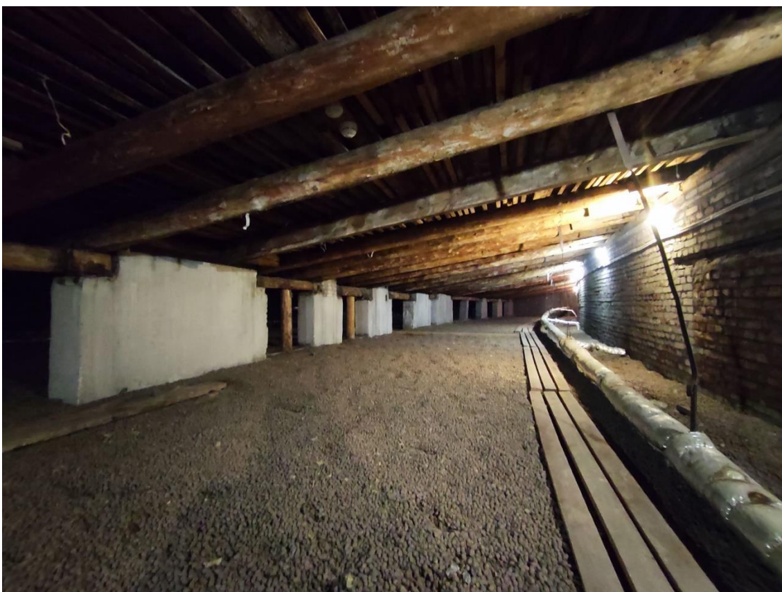
85. Выявленный объект культурного наследия «Здание общежития Транспортной Академии», по адресу: г. Санкт-Петербург, Малая Посадская ул., д. 22-24, лит. А. Общий вид стропильной системы крыши пятиэтажного корпуса в осях Е-Ж.
