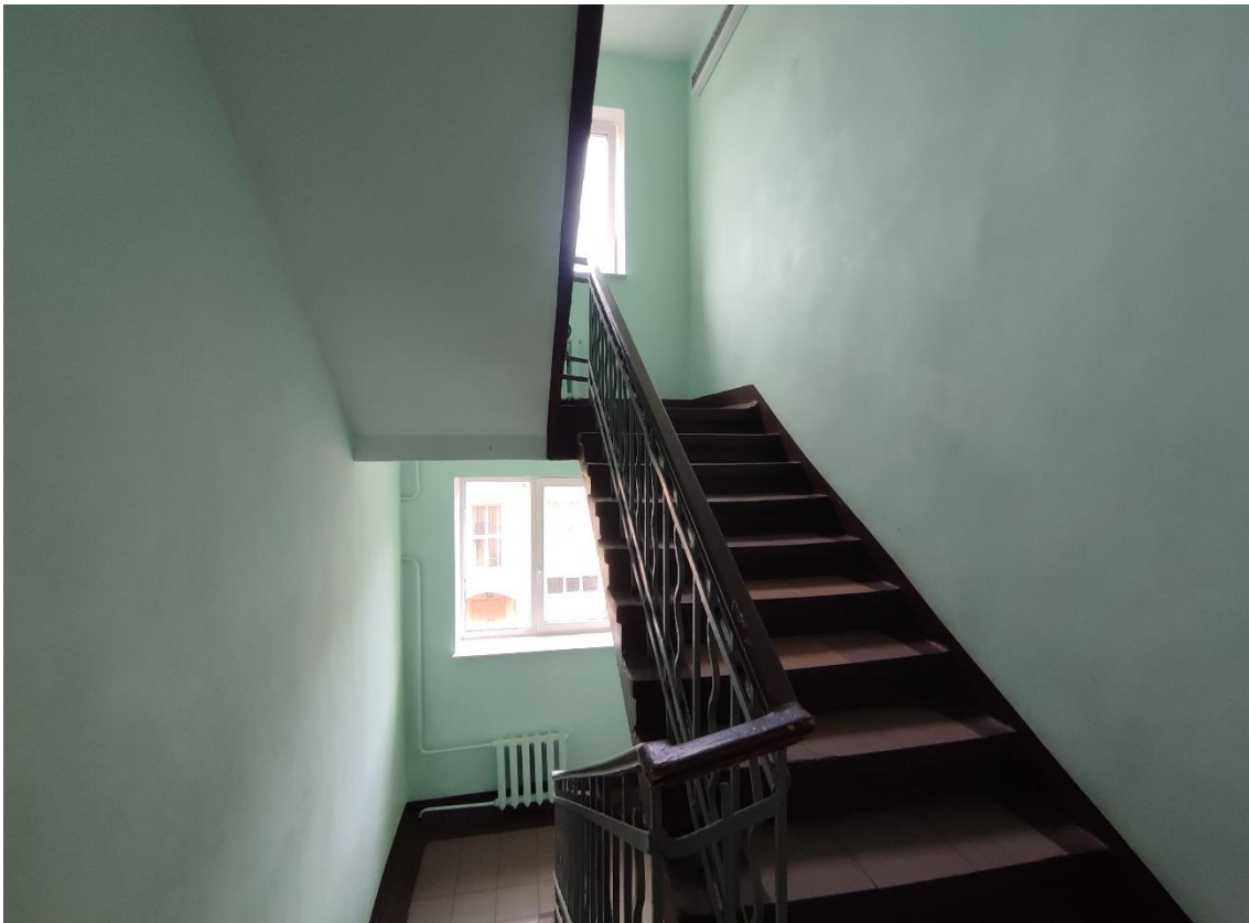
59. Выявленный объект культурного наследия «Здание общежития Транспортной Академии», по адресу: г. Санкт-Петербург, Малая Посадская ул., д. 22-24, лит. А. Общий вид лестничной клетки, расположенной в осях А-Б/2-3 (пом. 102-С (204)) в уровне 3-го этажа.
