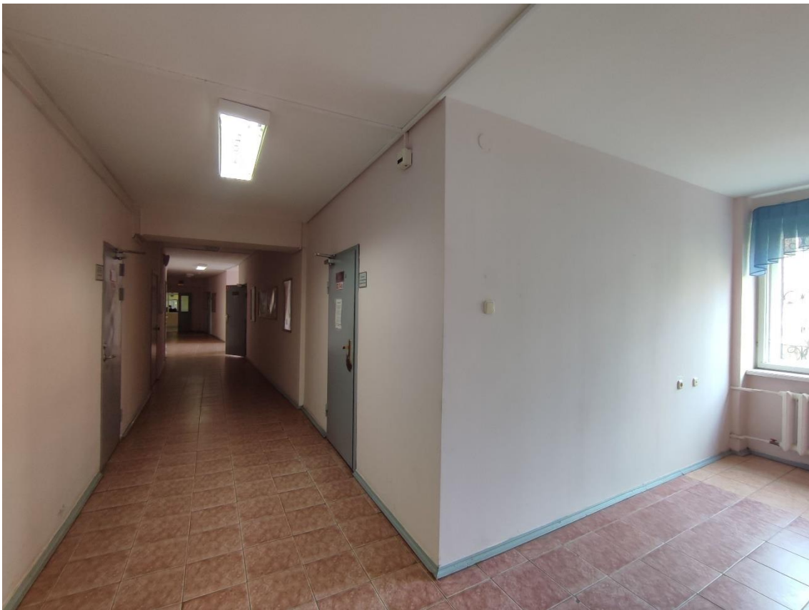
22. Выявленный объект культурного наследия «Здание общежития Транспортной Академии», по адресу: г. Санкт-Петербург, Малая Посадская ул., д. 22-24, лит. А. Общий вид пом. 102-С (23) в уровне 1-го этажа.
