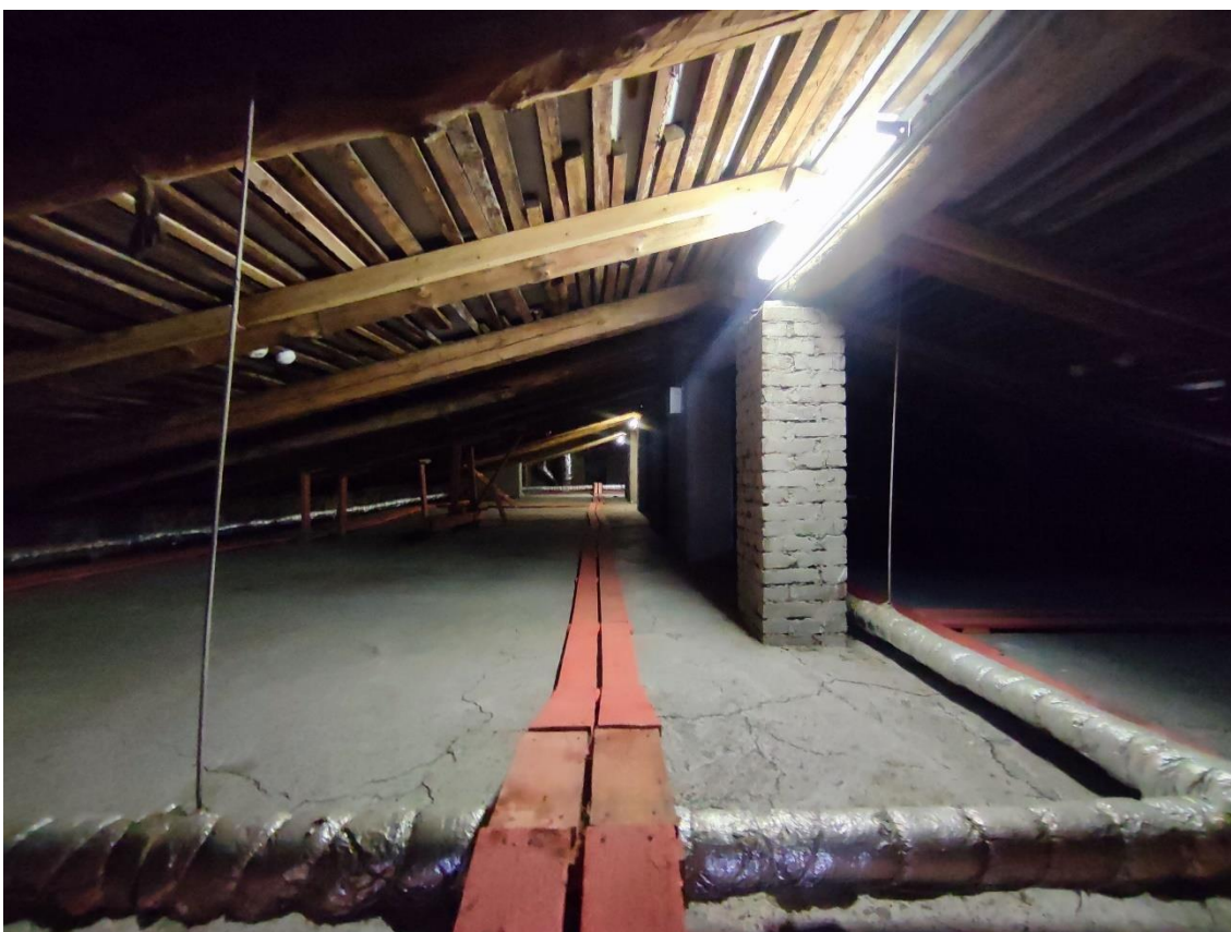
89. Выявленный объект культурного наследия «Здание общежития Транспортной Академии», по адресу: г. Санкт-Петербург, Малая Посадская ул., д. 22-24, лит. А. Общий вид стропильной системы крыши в осях А-Б/3-7.
