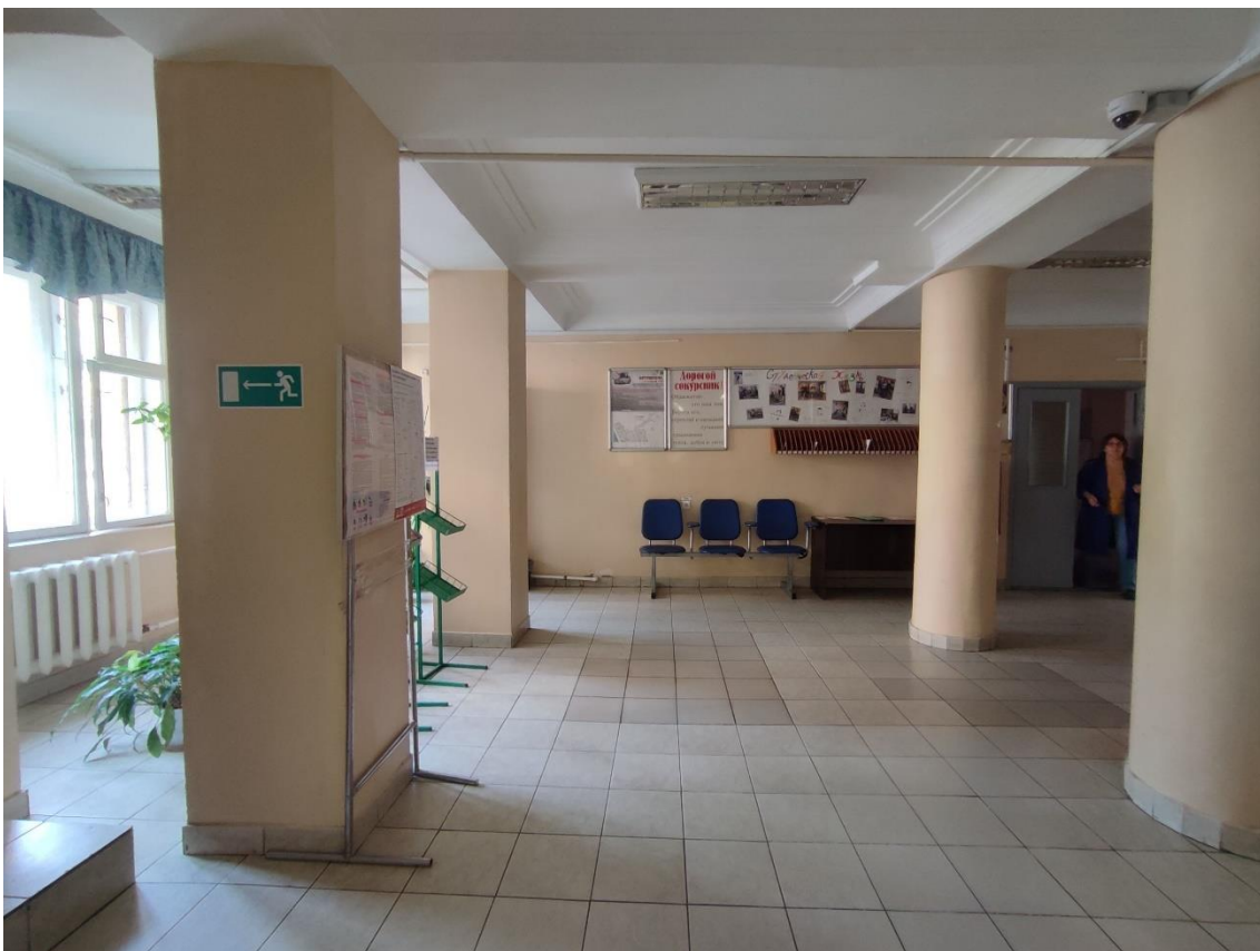
14. Выявленный объект культурного наследия «Здание общежития Транспортной Академии», по адресу: г. Санкт-Петербург, Малая Посадская ул., д. 22-24, лит. А. Общий вид пом. 102-С (19) в уровне 1-го этажа.
