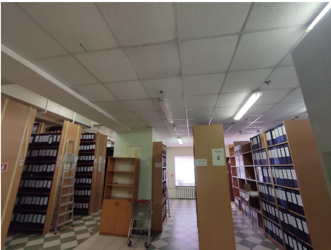
28. Выявленный объект культурного наследия «Здание общежития Транспортной Академии», по адресу: г. Санкт-Петербург, Малая Посадская ул., д. 22-24, лит. А. Фрагмент пом. 14-Н (3) в уровне 2-го этажа.
