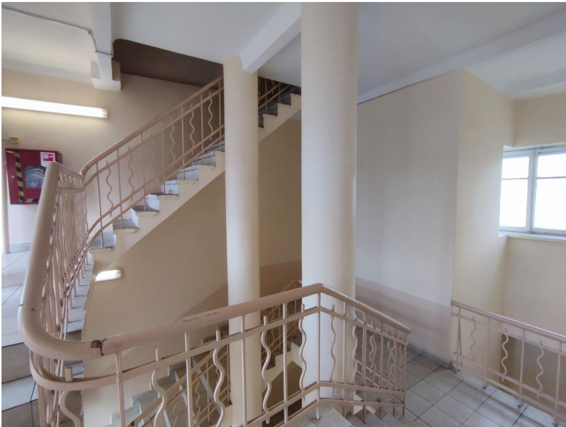
91. Выявленный объект культурного наследия «Здание общежития Транспортной Академии», по адресу: г. Санкт-Петербург, Малая Посадская ул., д. 22-24, лит. А. Общий вид пом. 102-С (513) в уровне 7-го этажа.
