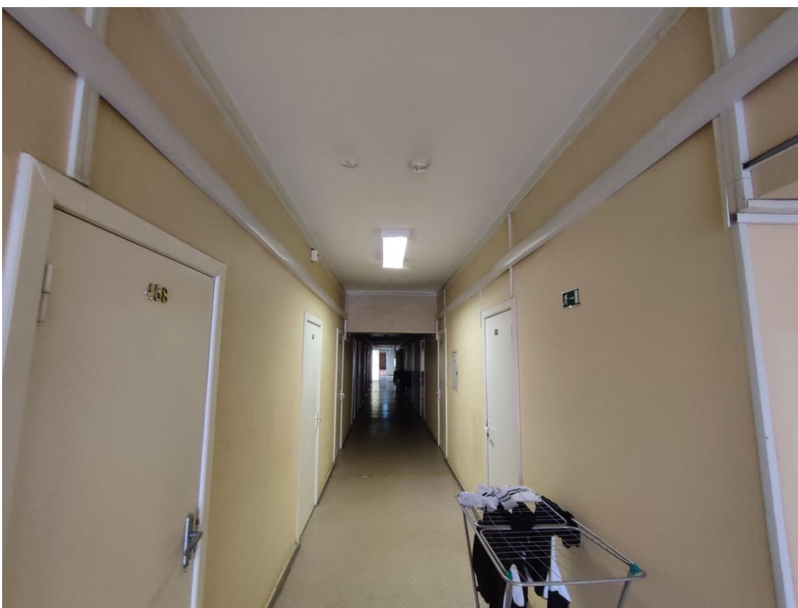
64. Выявленный объект культурного наследия «Здание общежития Транспортной Академии», по адресу: г. Санкт-Петербург, Малая Посадская ул., д. 22-24, лит. А. Общий вид пом. 102-С (336) в уровне 4-го этажа.
