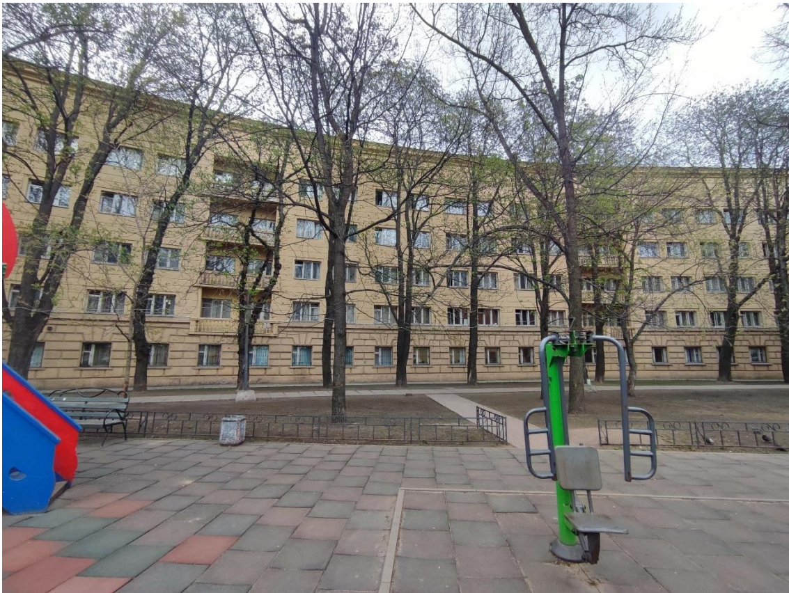
3. Выявленный объект культурного наследия «Здание общежития Транспортной Академии», по адресу: г. Санкт-Петербург, Малая Посадская ул., д. 22-24, лит. А. Фрагмент центральной части западного фасада пятиэтажного корпуса.
