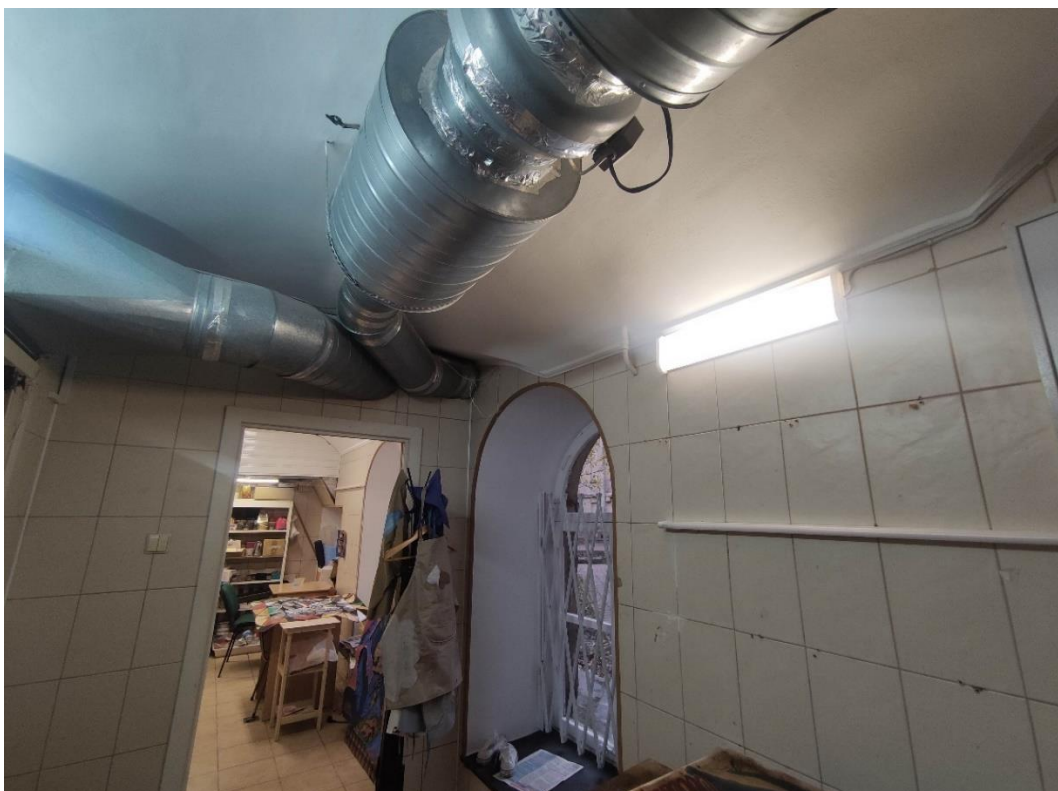
41. Объект культурного наследия регионального значения «Здание гимназии», расположенный по адресу: г. Санкт-Петербург, Василеостровский район, 6-я линия В.О., дом 15, литера А, входящий в состав объекта культурного наследия регионального значения «Ларинская гимназия». Фрагмент пом. № 1-Н(64).
