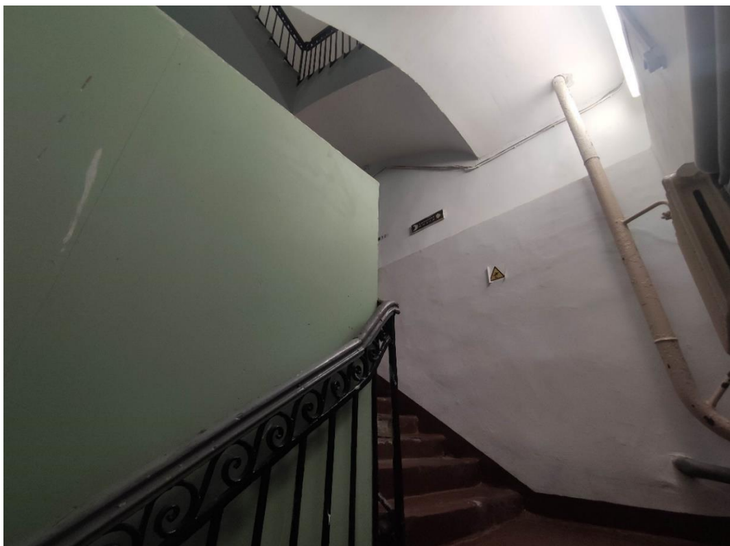
39. Объект культурного наследия регионального значения «Здание гимназии», расположенный по адресу: г. Санкт-Петербург, Василеостровский район, 6-я линия В.О., дом 15, литера А, входящий в состав объекта культурного наследия регионального значения «Ларинская гимназия». Фрагмент лестницы, расположенной в вид пом. № 1-Н(63).
