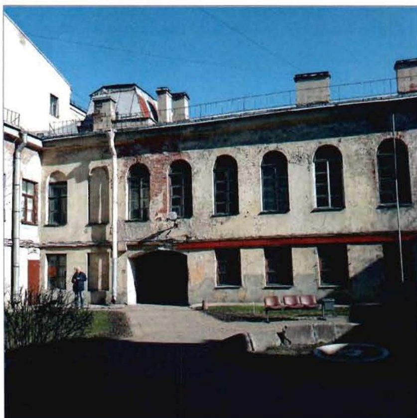
3. Флигель. Фрагмент дворового фасада.
