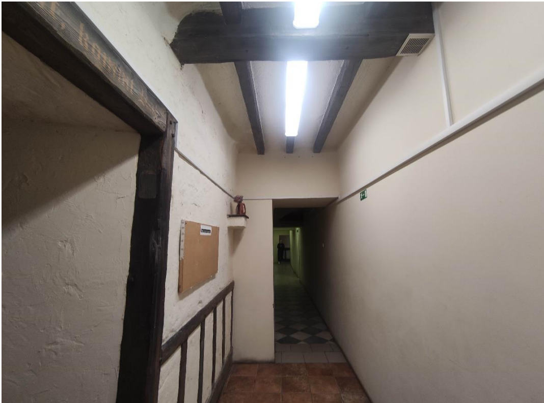
24. Объект культурного наследия регионального значения «Здание гимназии», расположенный по адресу: г. Санкт-Петербург, Василеостровский район, 6-я линия В.О., дом 15, литера А, входящий в состав объекта культурного наследия регионального значения «Ларинская гимназия». Общий вид пом. № 1-Н(8).
