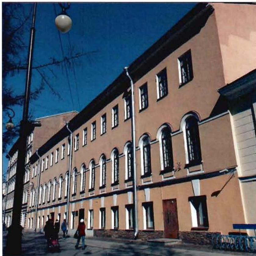
1. Лицевой фасад. Общий вид.
