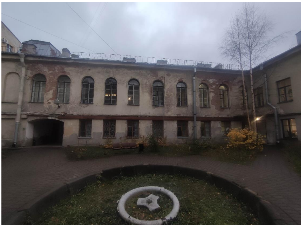
11. Объект культурного наследия регионального значения «Здание гимназии», расположенный по адресу: г. Санкт-Петербург, Василеостровский район, 6-я линия В.О., дом 15, литера А, входящий в состав объекта культурного наследия регионального значения «Ларинская гимназия». Общий вид северо-восточного, фрагмент юго-восточного дворовых фасадов дворового флигеля.
