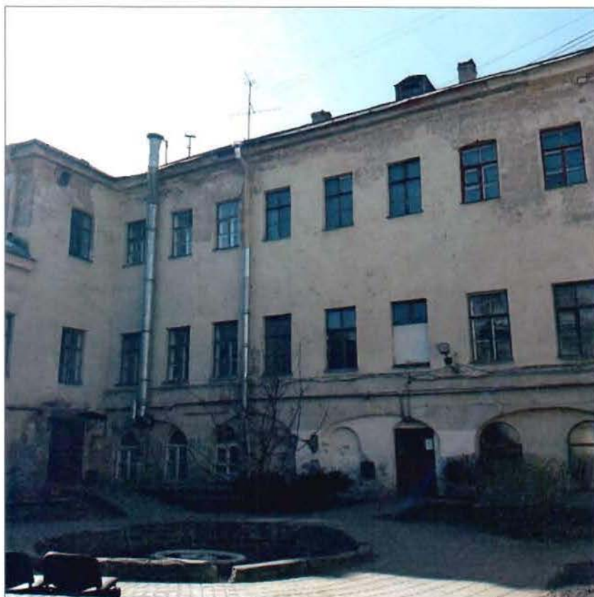
2. Лицевой корпус. Фрагмент дворового фасада.
