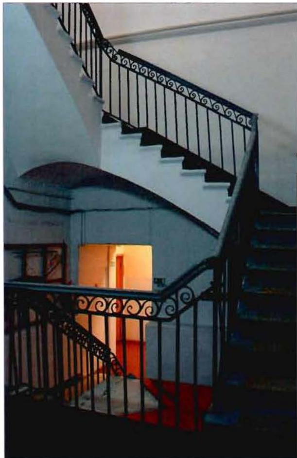
5. Лестница (пом. № 1-Н (63)). Фрагмент.
