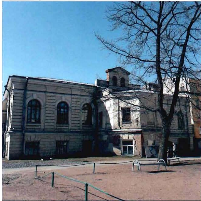
12. Лицевой фасад. Общий вид.
