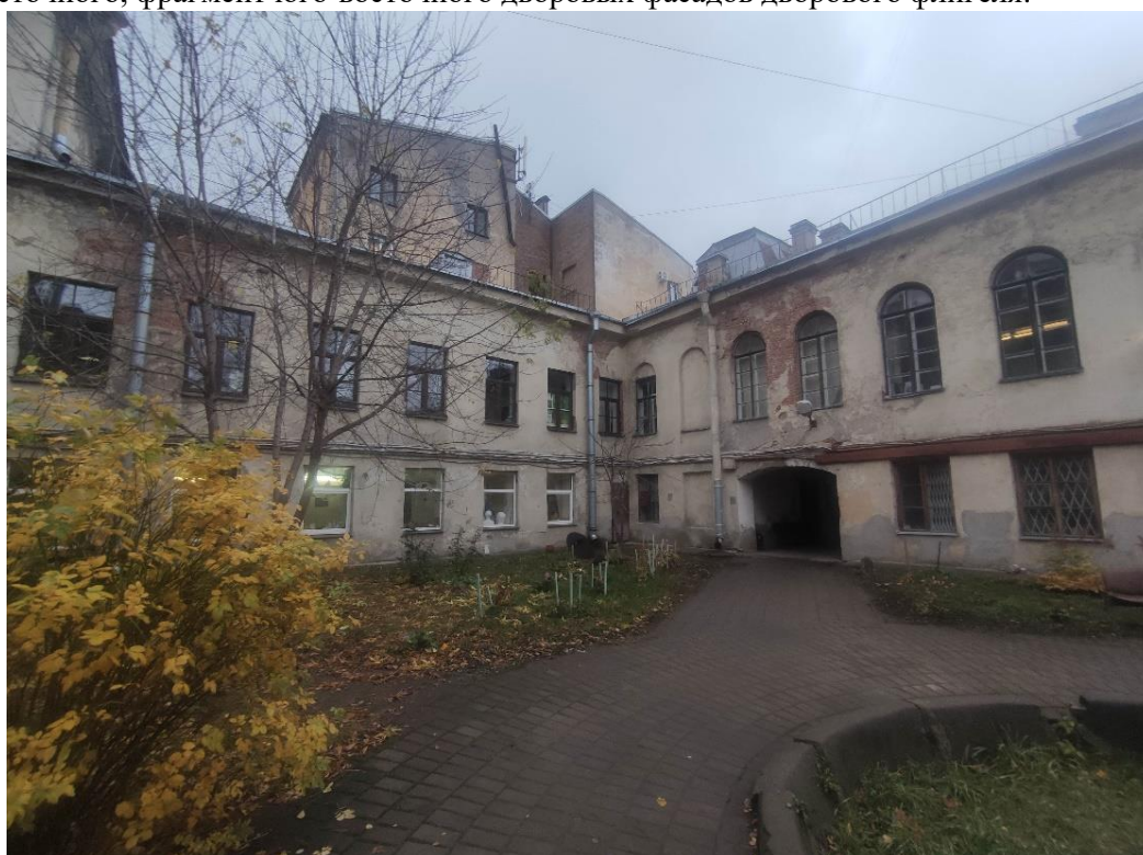
12. Объект культурного наследия регионального значения «Здание гимназии», расположенный по адресу: г. Санкт-Петербург, Василеостровский район, 6-я линия В.О., дом 15, литера А, входящий в состав объекта культурного наследия регионального значения «Ларинская гимназия». Фрагменты северо-западного и северо-восточного дворовых фасадов дворового флигеля.
