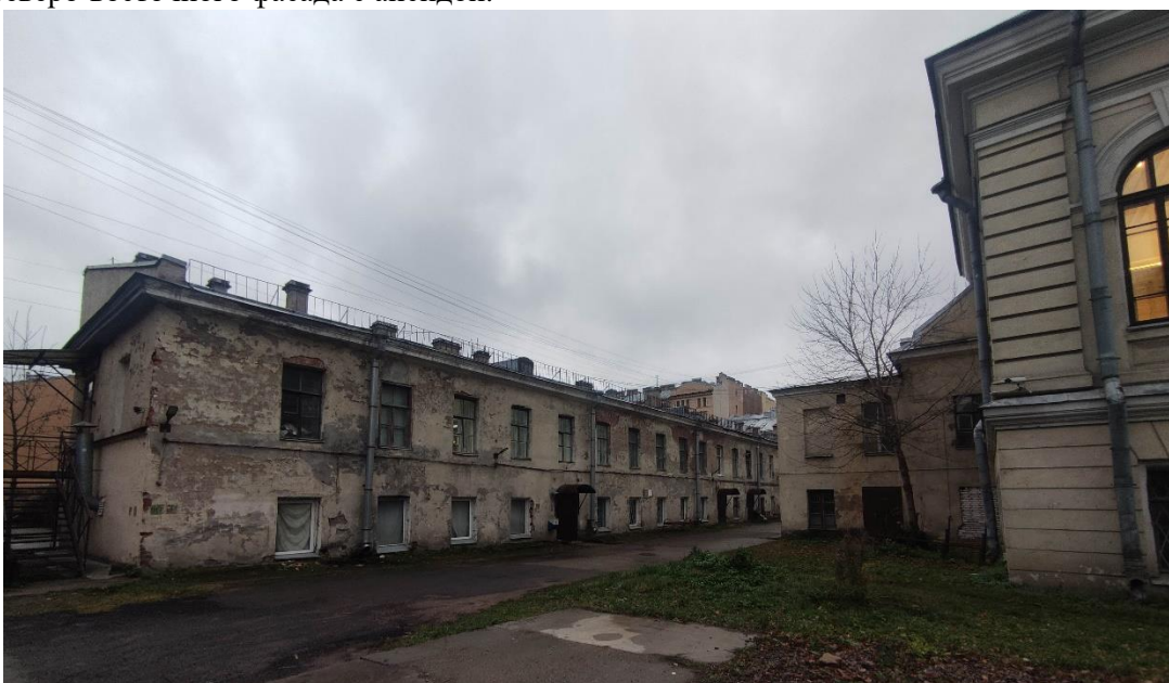
18. Объект культурного наследия регионального значения «Дом директора с флигелем», расположенный по адресу: г. Санкт-Петербург, Василеостровский район, 6-я линия В.О., дом 15, литера А, входящий в состав объекта культурного наследия регионального значения «Ларинская гимназия». Общий вид дворового северо-западного фасада дворового флигеля. Объект культурного наследия регионального значения «Флигель с домовою церковью св. Татьяны» расположенный по адресу: г. Санкт-Петербург, Василеостровский район, 6-я линия В.О., дом 15, литера А, входящий в состав объекта культурного наследия регионального значения «Ларинская гимназия». Фрагмент северо-восточного фасада.
