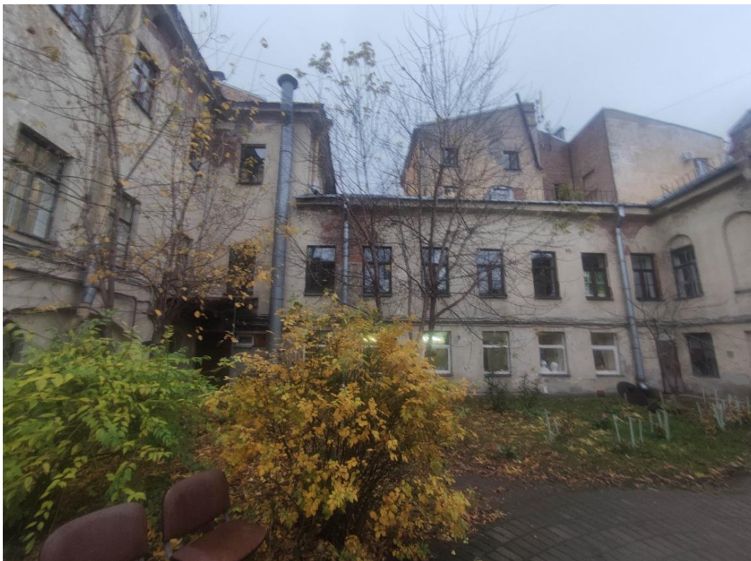
13. Объект культурного наследия регионального значения «Здание гимназии», расположенный по адресу: г. Санкт-Петербург, Василеостровский район, 6-я линия В.О., дом 15, литера А, входящий в состав объекта культурного наследия регионального значения «Ларинская гимназия». Общий северо-западного фасада дворового фасада лицевого корпуса и северо-западного дворового фасада дворового флигеля.
