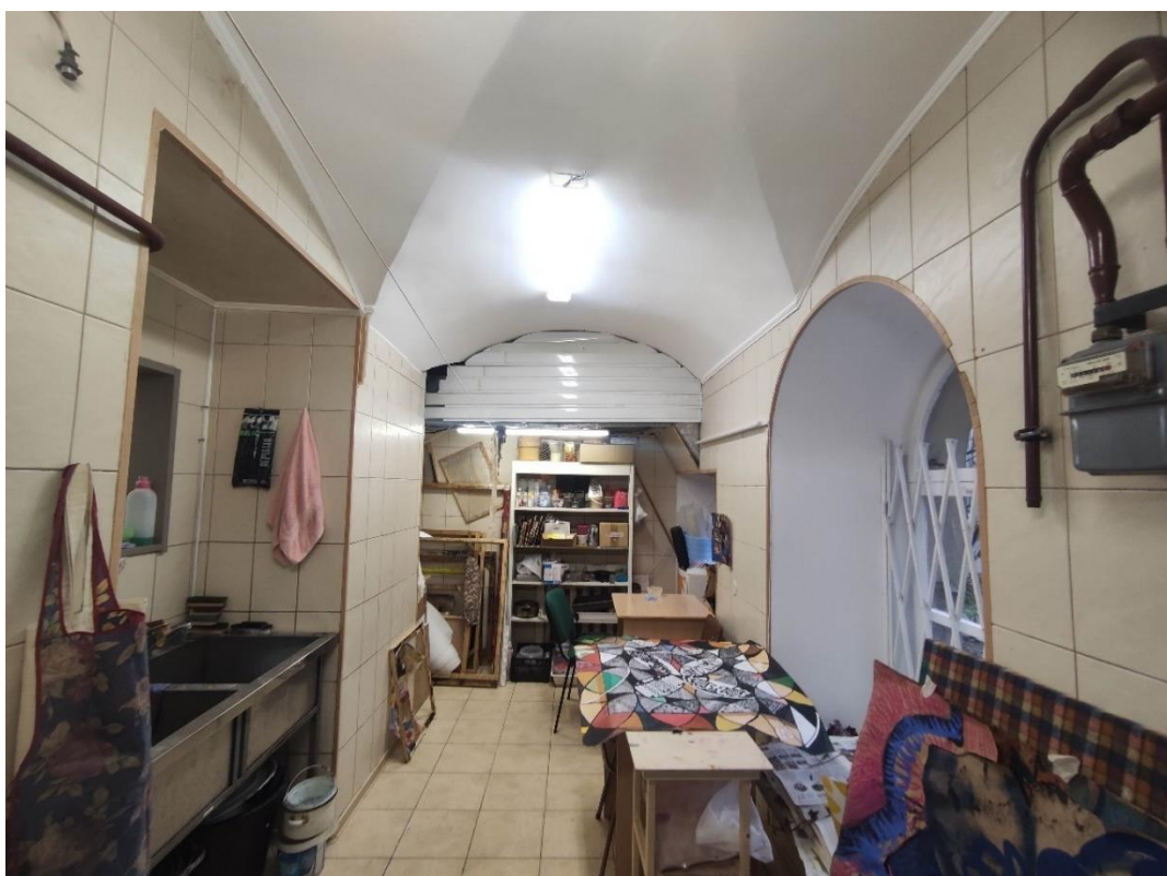
42. Объект культурного наследия регионального значения «Здание гимназии», расположенный по адресу: г. Санкт-Петербург, Василеостровский район, 6-я линия В.О., дом 15, литера А, входящий в состав объекта культурного наследия регионального значения «Ларинская гимназия». Фрагмент пом. № 1-Н(64).
