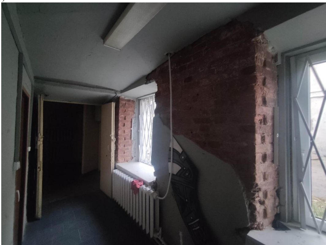
82. Объект культурного наследия регионального значения «Дом директора с флигелем», расположенный по адресу: г. Санкт-Петербург, Василеостровский район, 6-я линия В.О., дом 15, литера А, входящий в состав объекта культурного наследия регионального значения «Ларинская гимназия». Фрагмент пом. № 4-Н(2).
