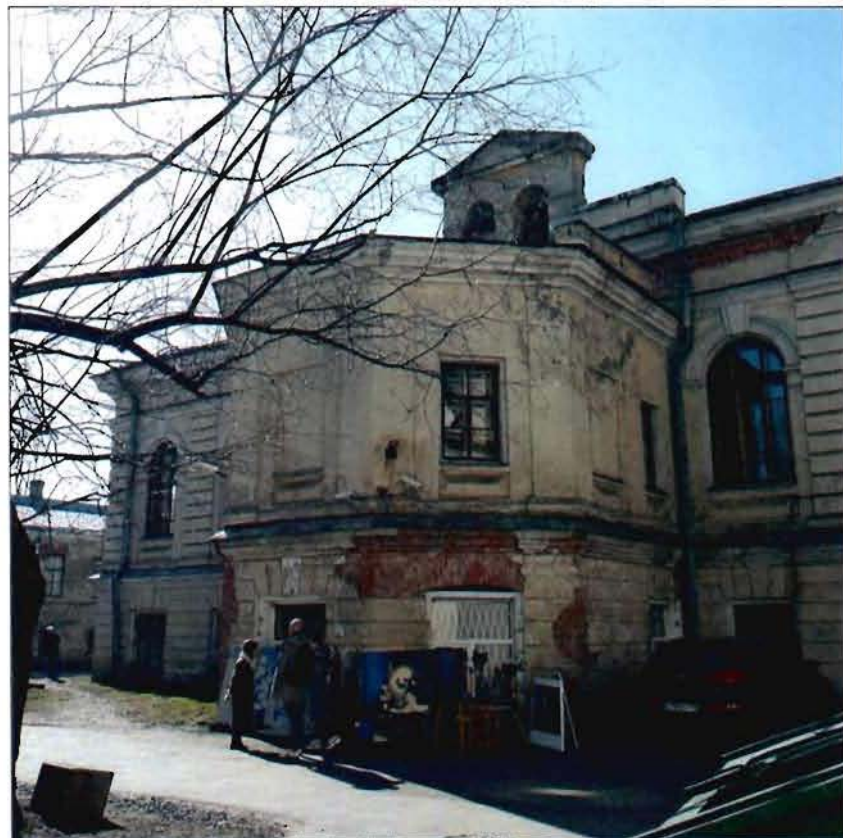
13. Лицевой фасад. Фрагмент. Апсида.
