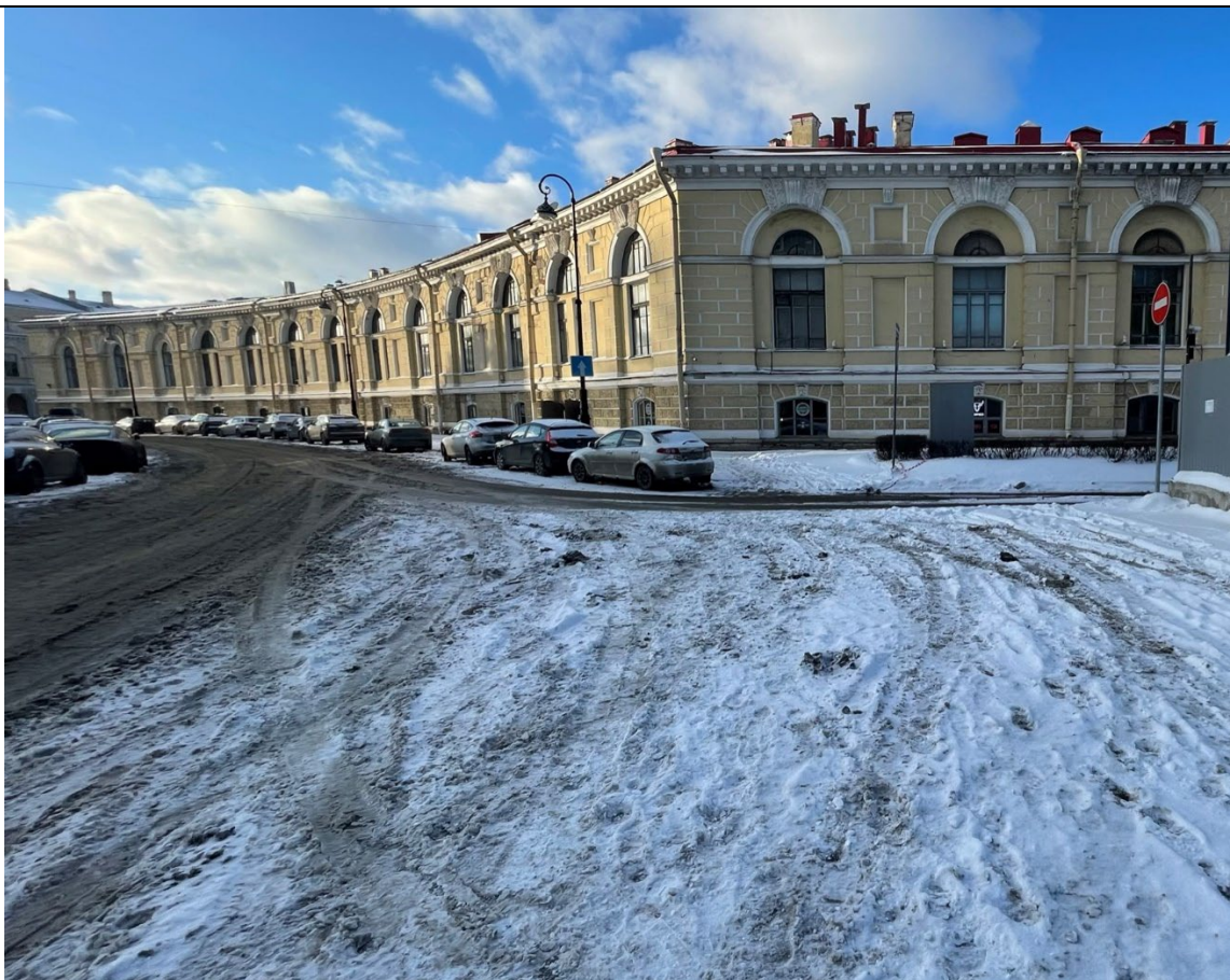
Фото 4. Вид на Северный пакгауз
