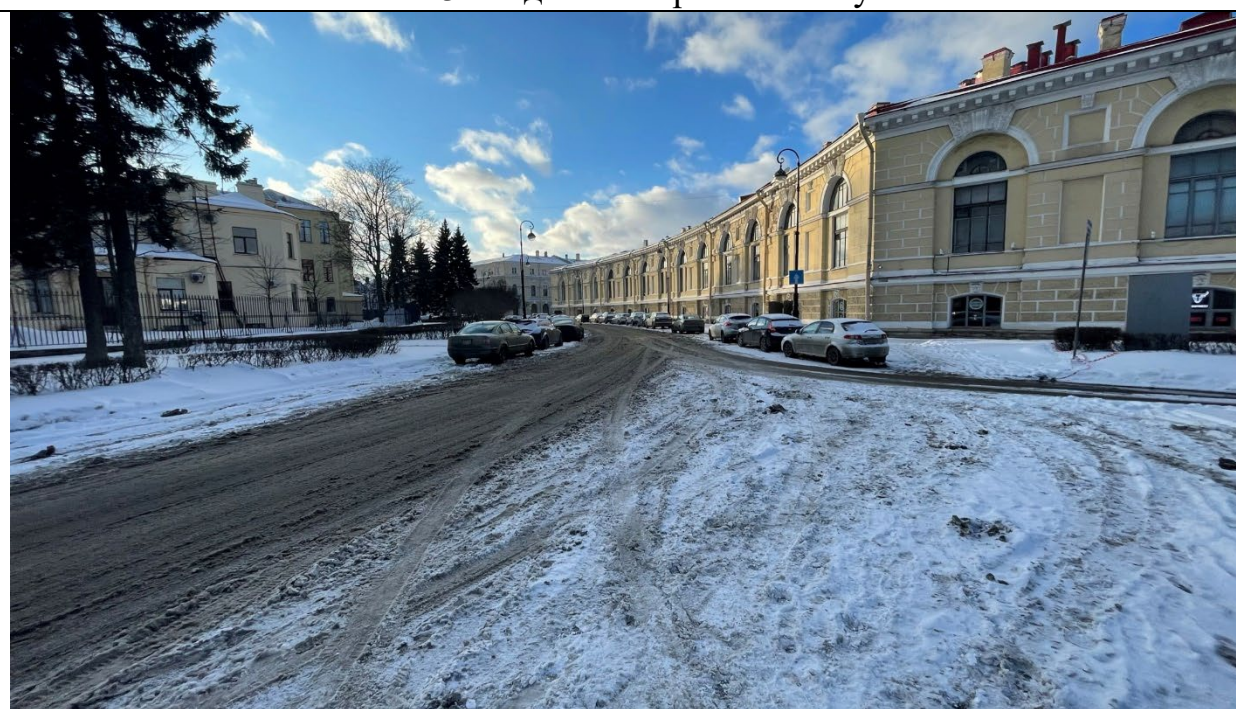
Фото 4. Вид на Северный пакгауз
