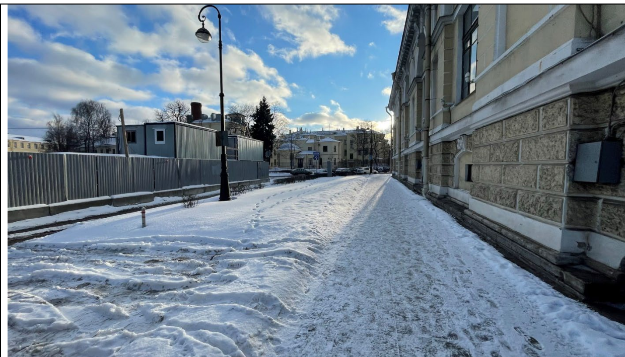
Фото 9. Вид на Северный пакгауз
