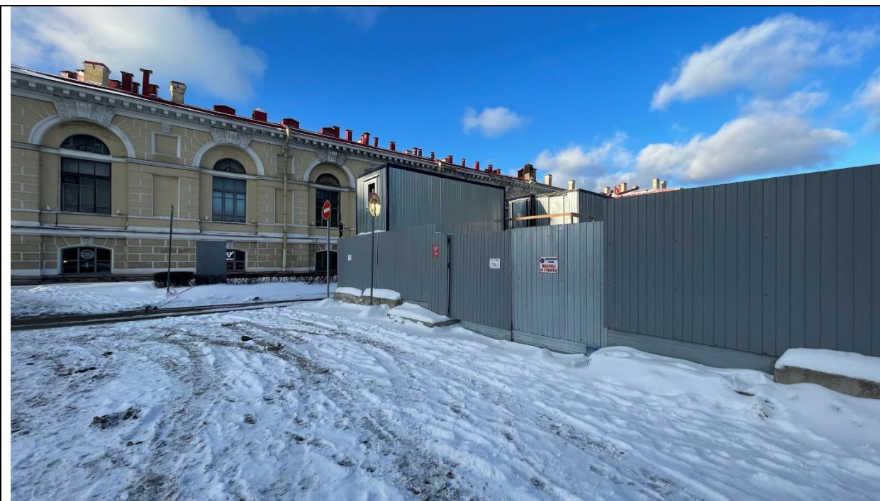
Фото 3. Вид на Северный пакгауз
