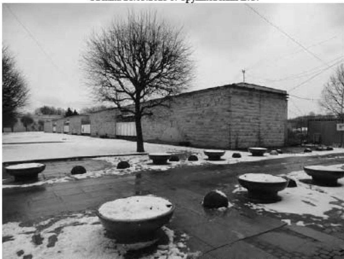
Фото 4. Территория объекта культурного наследия федерального значения «Дворец Таврический». Вид на юго-восток. Съемка 28.03.2023 г. Трушковский В.Э.
