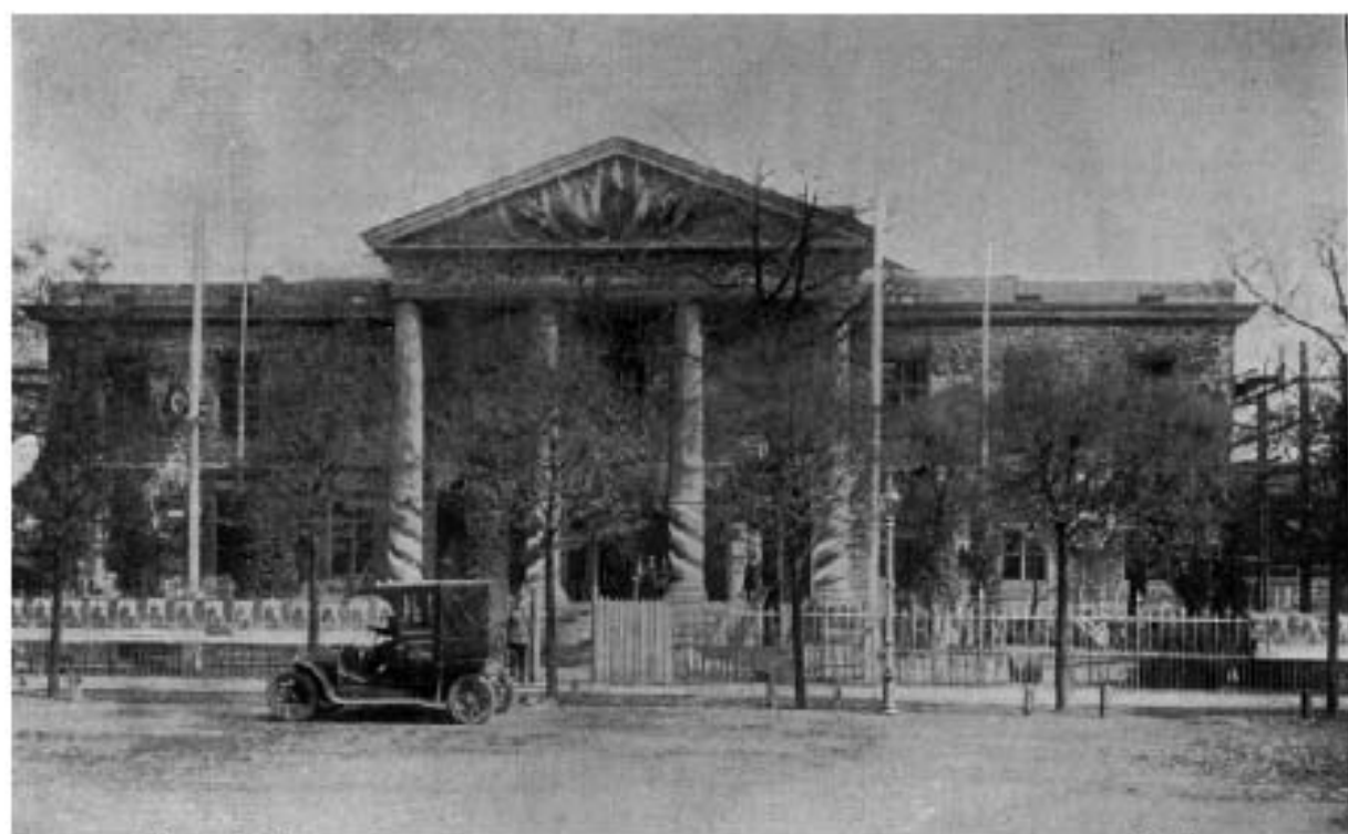
Илл. 22. Фасад нового выставочного здания накануне выставки. 1914 г.
