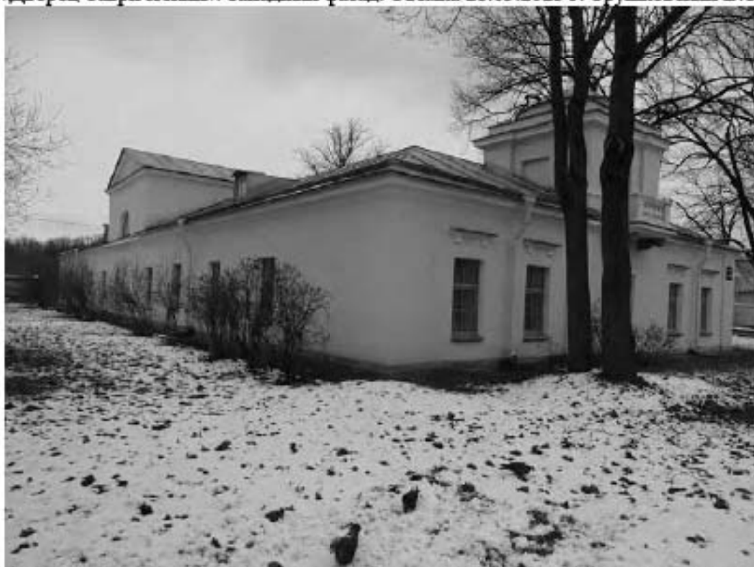
Фото 2. Объект культурного наследия федерального значения «Дом садовника с двумя флигелями», входящий в состав объекта культурного наследия федерального значения «Дворец Таврический». Северный флигель. Съемка 28.03.2023 г. Трушковский В.Э.
