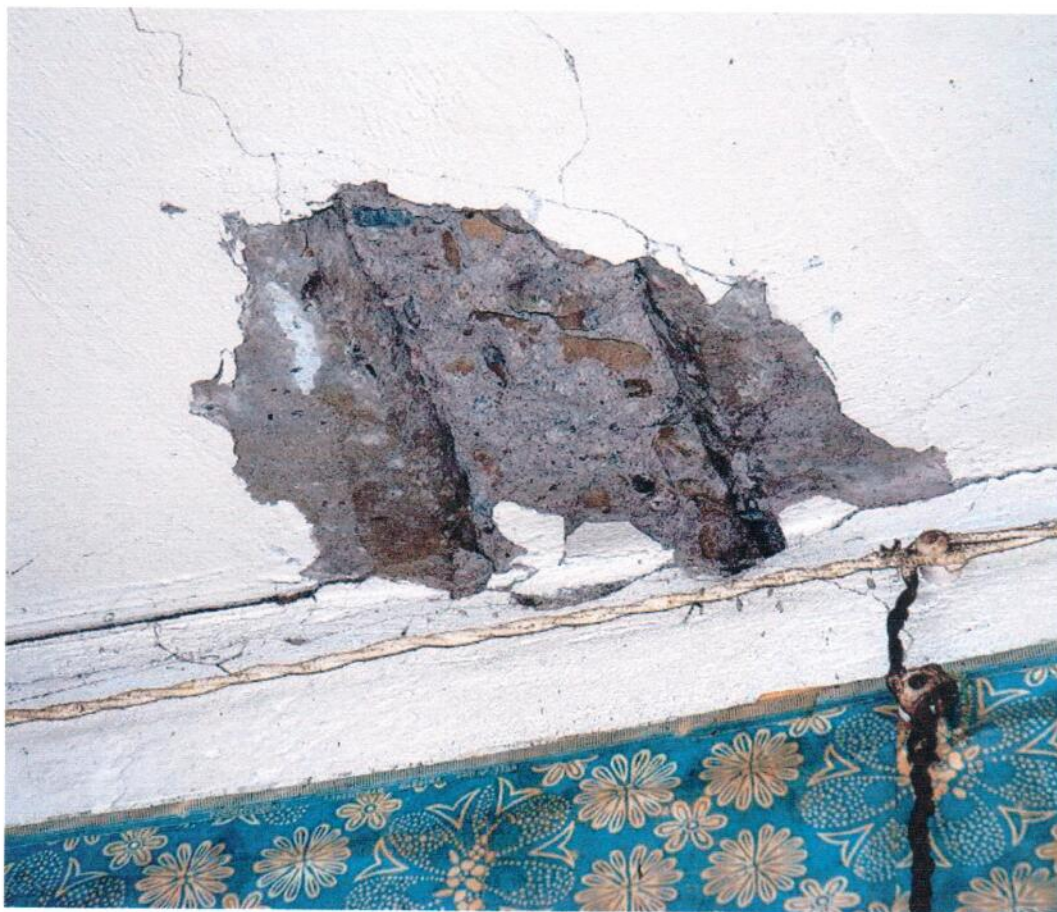
Фрагмент низа чердачного перекрытия
