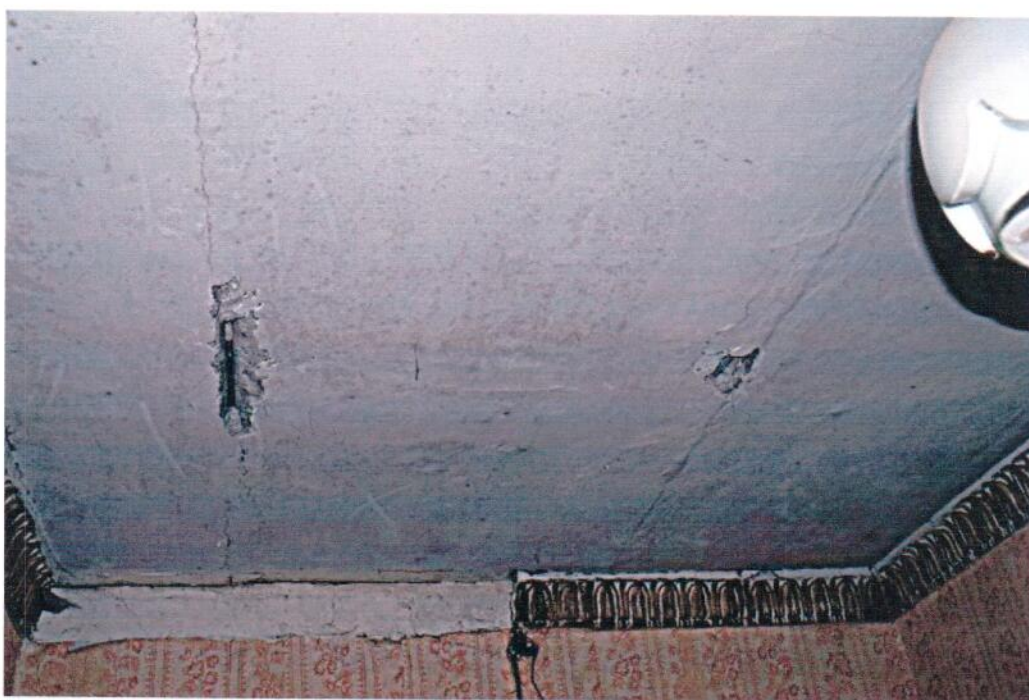
Фрагмент междуэтажного перекрытия
