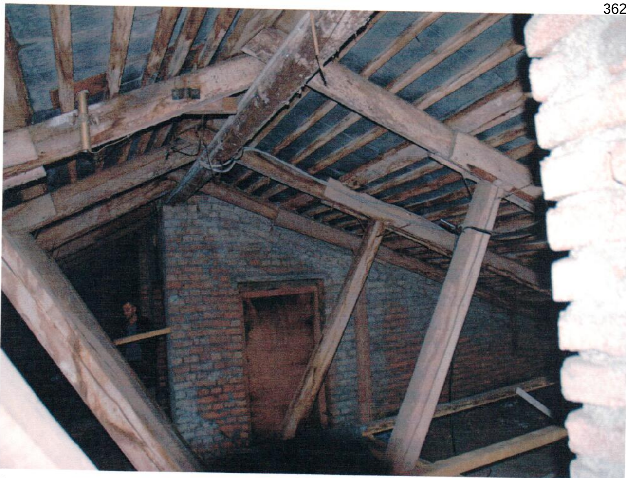
Фрагмент стропильной системы
