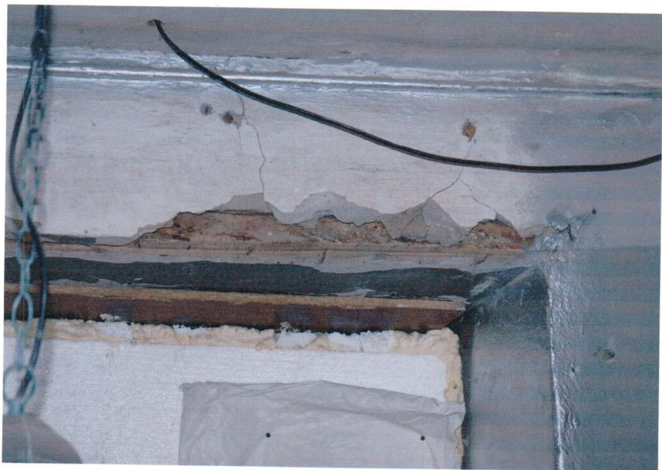
Фрагмент оконного заполнения
