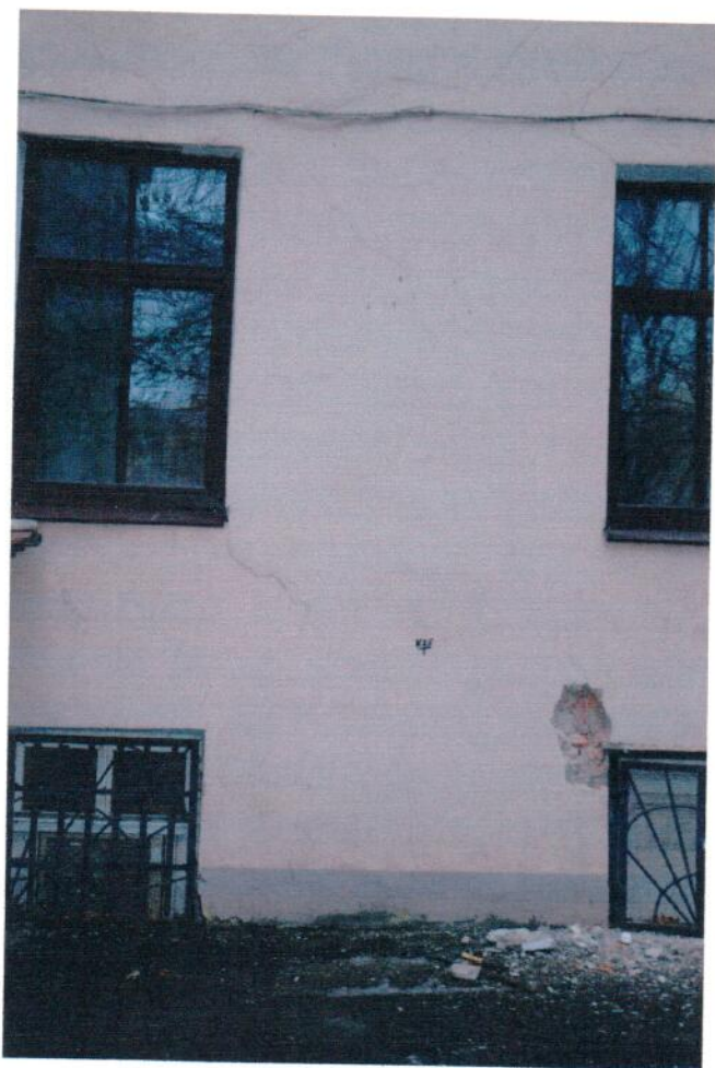
Фрагмент кирпичной кладки дворового фасада
