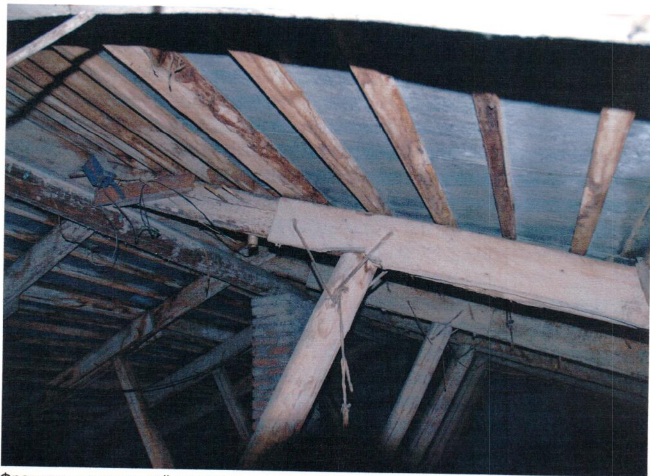
Фрагмент стропильной системы
