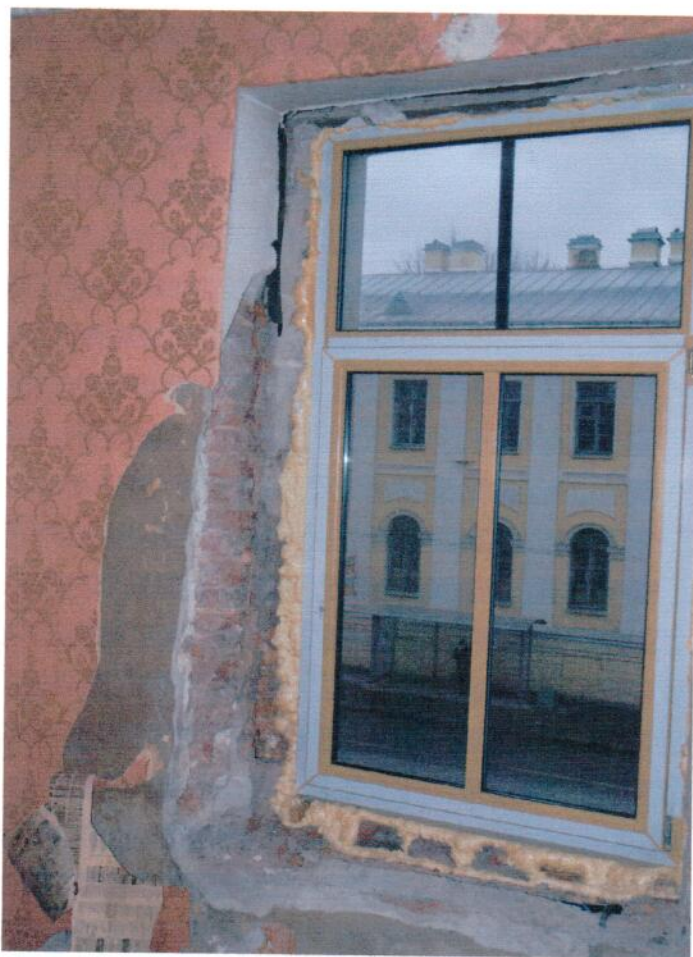
Оконные проемы второго этажа
