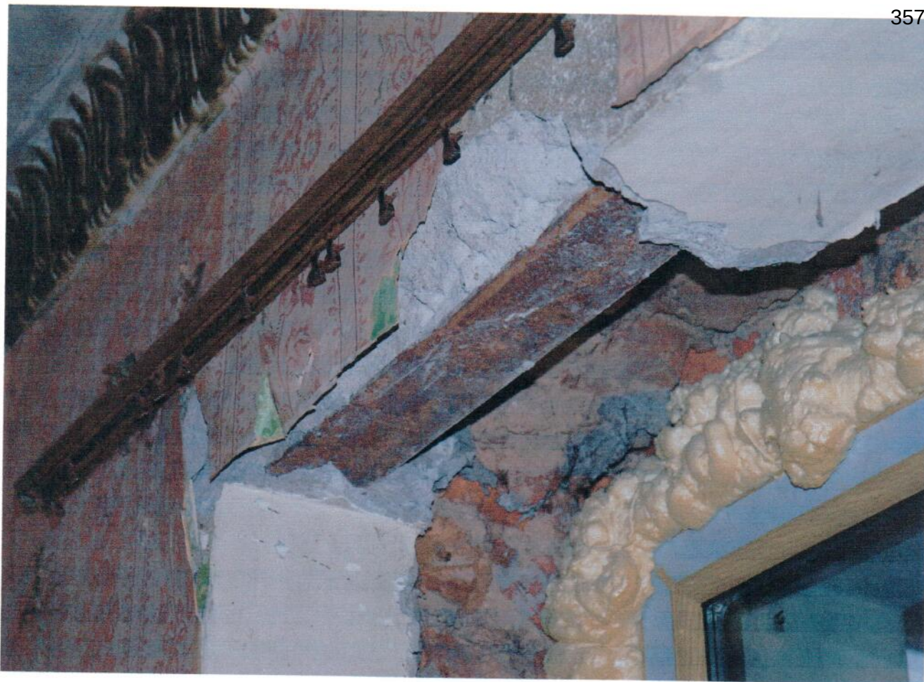
Фрагмент оконного заполнения
