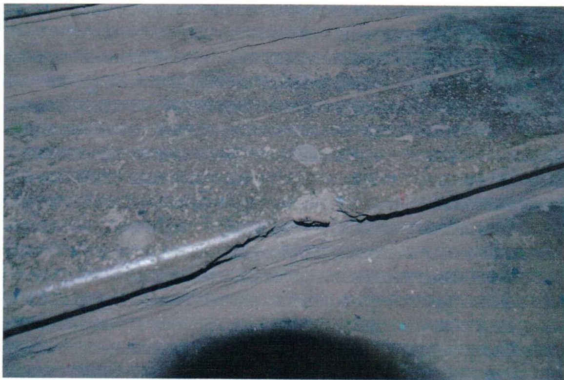
Деформация ступеней (фрагмент)
