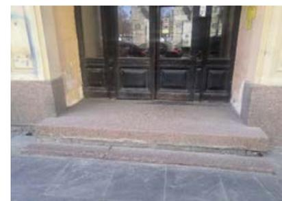
историческое дверное заполнение парадного входа – местоположение, материал (дерево), исполнение (двухстворчатое, с боковыми панелями, остекленными в верхней части и остекленной фрамугой прямоугольной формы на 3 стекла), оформление (профилированные филенки с резным орнаментом «бегущая волна»);
